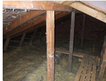
Kuvat 78 a...c. Yleiskuvia osan I ja osan II ullakkotiloista. Ullakkotilat ovat yhtenäisiä, avoimia tiloja. Vapaata tilaa on 200...3000 mm. Puhallusvillapinnat olivat paikoin talottuja, mutta muuten siistejä. Eristeissä ei havaittu viitteitä vesivuodoista.
