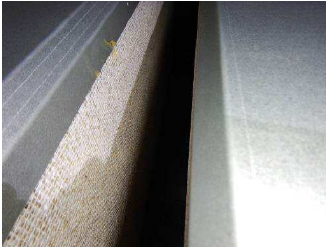
Kuva 38. Tulo- ja poistoilmakoneen äänenvaimentimien materiaalina on mineraalivilla, jonka päällä on kuitukangas. Äänenvaimentimen kuitukankaassa on merkkejä kankaan kulumisesta.
