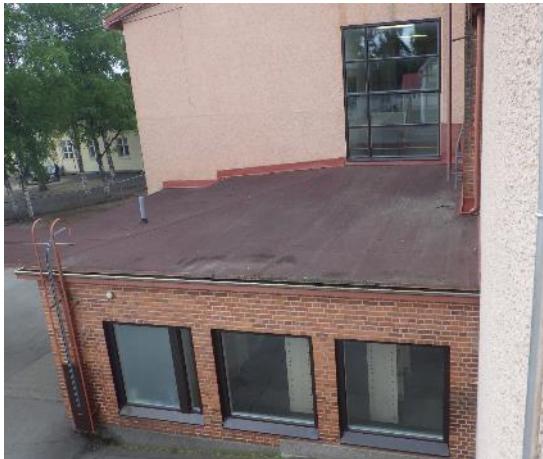
Kuvat 65 a ja b. Sisääntuloaulan kohdalla vesikatteena toimii bitumikermi. Sade- ja sulamisvedet ohjataan aulan vesikaton kallistuksilla sadevesikouruille ja edelleen syöksytorville. Vesikatteen seinällenostot on suojattu pellityksillä.
