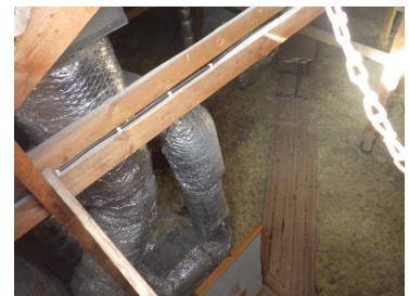
Kuvat 78 a...c. Yleiskuvia osan I ja osan II ullakkotiloista. Ullakkotilat ovat yhtenäisiä, avoimia tiloja. Vapaata tilaa on 200...3000 mm. Puhallusvillapinnat olivat paikoin talottuja, mutta muuten siistejä. Eristeissä ei havaittu viitteitä vesivuodoista.
