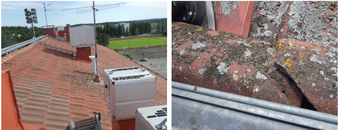
Kuvat 68 a ja b. Osan I vesikatolla havaittiin yksittäisiä haljonneita kattotiiliä, pääasiassa katon harjalla. Harjatiilet ovat siirtyneet linjastaan.
