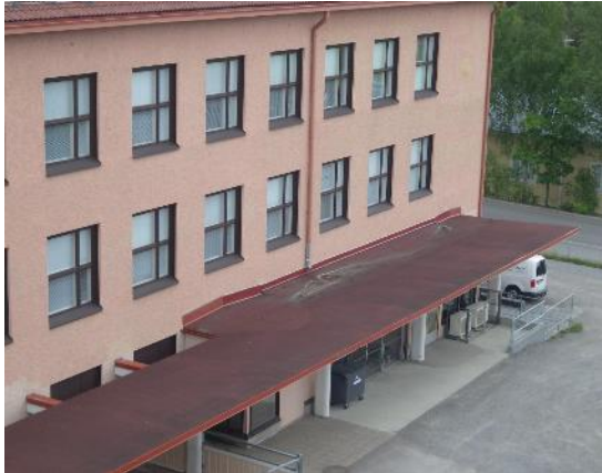
Kuva 64. Osan I vesikatolta sadevedet ohjataan syöksytorven kautta bitumikermikatteiselle katokselle. Katokselta vedet ohjataan sadevesikourujen avulla syöksytorville. Katoksella on lammikoitumiseen viittaavia jälkiä.
