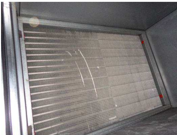
Kuva 27. Lämmityspatterit ovat likaiset ja siinä on hieman kolhuja.
