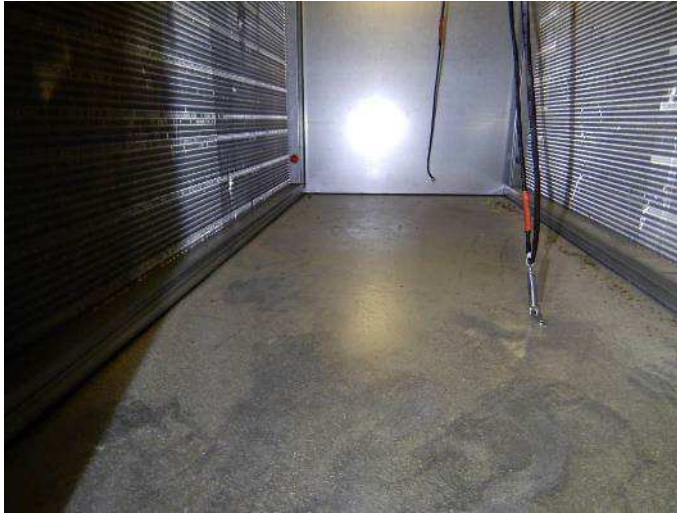
Kuva 19. LTO- patteri ja lämmityspatterit ovat pölyiset ja niiden välisessä kammiossa on paljon roskaa ja pölyä.
