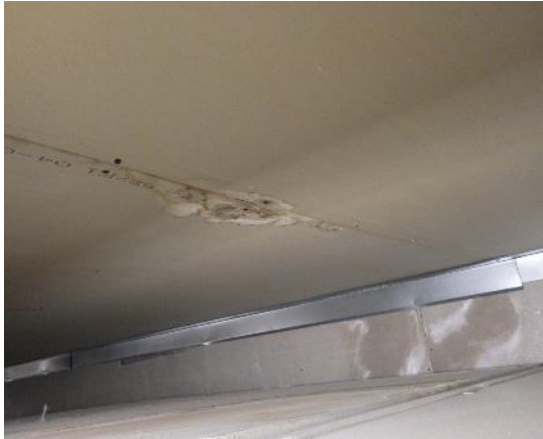
Kuvat 87 a ja b. Osan I iv-konehuoneen kattopinnassa on vesivuotojälkiä iv-koneen päällä ja läpiviennin ympärillä.
