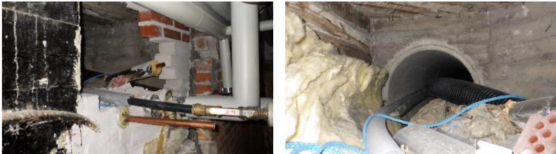
Kuvat 21 a...c. Vanhan painovoimaisen ilmanvaihdon kellaritilojen korvausilma-aukot sijaitsevat lähellä maanpinnan tasoa. Syöksytorven alapuolelle sijoitettu korvausilma-aukko on ympäriltään sammaloitunut.
