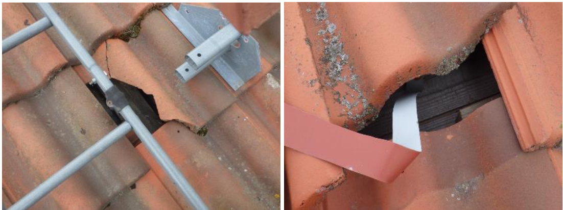
Kuvat 68 a ja b. Osan I vesikatolla havaittiin yksittäisiä haljonneita kattotiiliä, pääasiassa katon harjalla. Harjatiilet ovat siirtyneet linjastaan.
