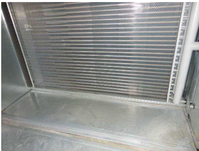
Kuva 9. Tuloilmakoneen lämmityspatteri on pölyinen.
