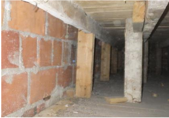
Kuvat 34 a...c. Näyttämön alusta tarkastettiin näyttämöllä olevan luukun kautta. Liikuntasalin lattia jatkuu myös näyttämön alla. Näyttämön alustatilassa on runsaasti rakennusjätettä ja muuta materiaalia luukun läheisyydessä, kauempana luukusta näyttämön alusta on pääosin tyhjä.
