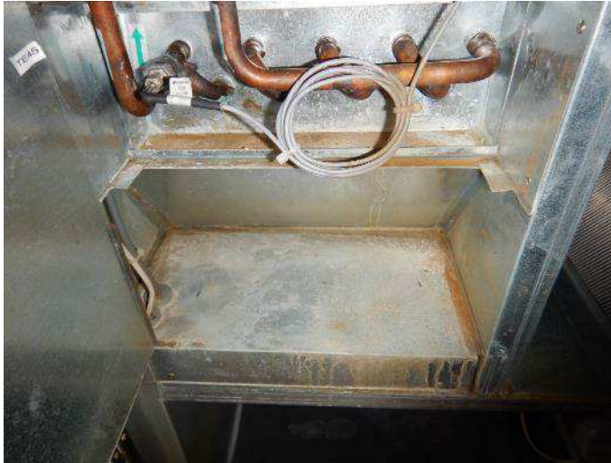
Kuva 45. Tuloilmakoneen lämmityspatterissa on vanhoja vuotojälkiä.
