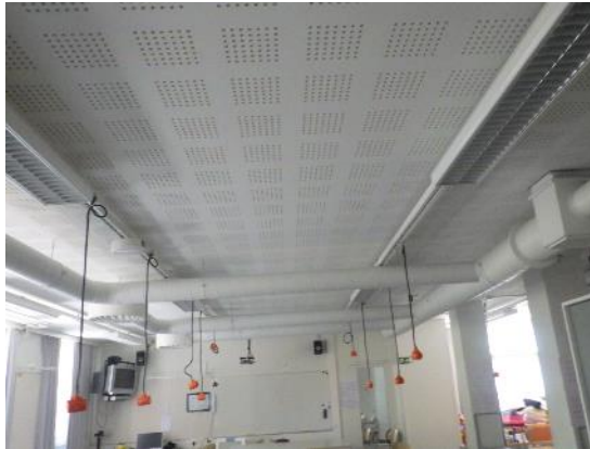
Kuvat 30 a ja b. Välipohjarakenteiden alapinnat ovat pääosin betonirakenteen alapintaan liimattuja akustolevyjä tai maalattuja betonipintoja. Avoimia mineraalivillapintoja ei havaittu.
