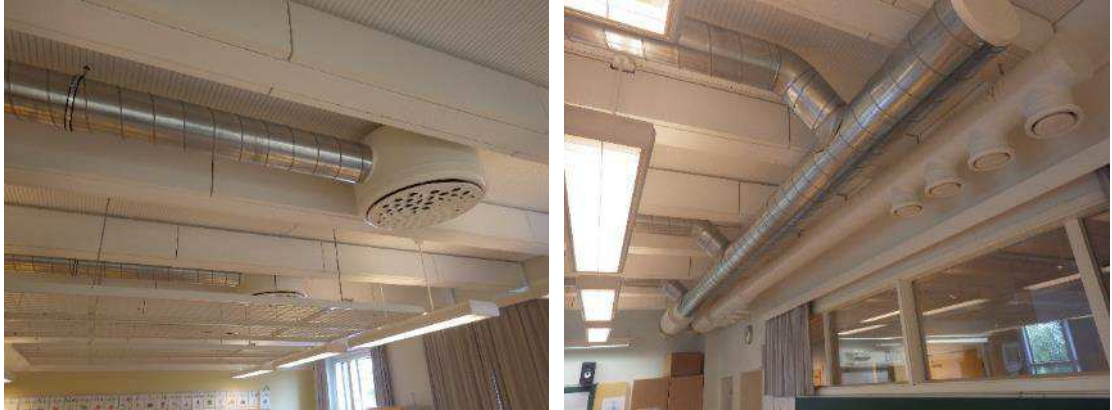
Kuva 47 a ja b. Tuloilman ilmanjakoon on tehty parannuksia 3. kerroksessa.
