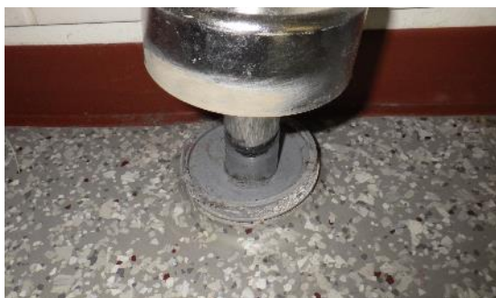
Kuva 43. Käsienpesualtaiden viemäriputkien läpiviennit on toteutettu läpivientimansettien avulla, eikä niiden tiiveydessä havaittu puutteita.
