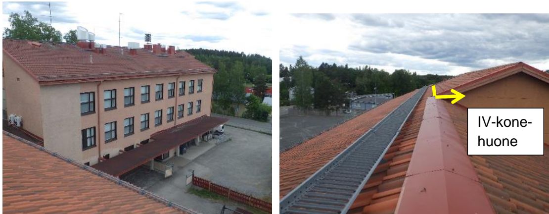
Kuvat 61 a ja b. Yleiskuvia osan I (kuva a) ja osan II (kuva b) vesikatoilta. Harjakattoiset vesikatot ovat tiilikatteisia, kattosillat ovat alumiinia. Osalla II rakennuksen harja on ullakkotilan kohdalla pellitetty uudestaan. Osan I katolla harjat ovat edelleen tiilikatteisia.
