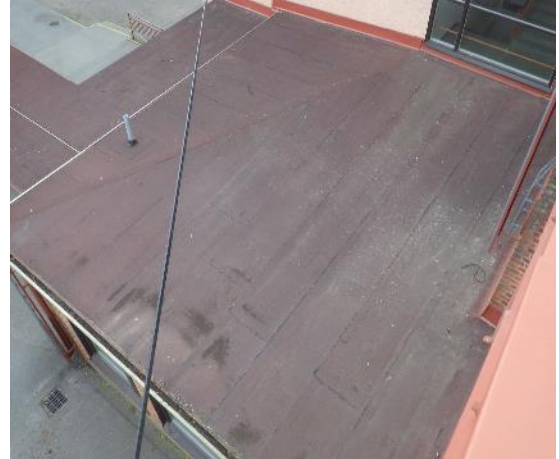
Kuvat 65 a ja b. Sisääntuloaulan kohdalla vesikatteena toimii bitumikermi. Sade- ja sulamisvedet ohjataan aulan vesikaton kallistuksilla sadevesikouruille ja edelleen syöksytorville. Vesikatteen seinällenostot on suojattu pellityksillä.
