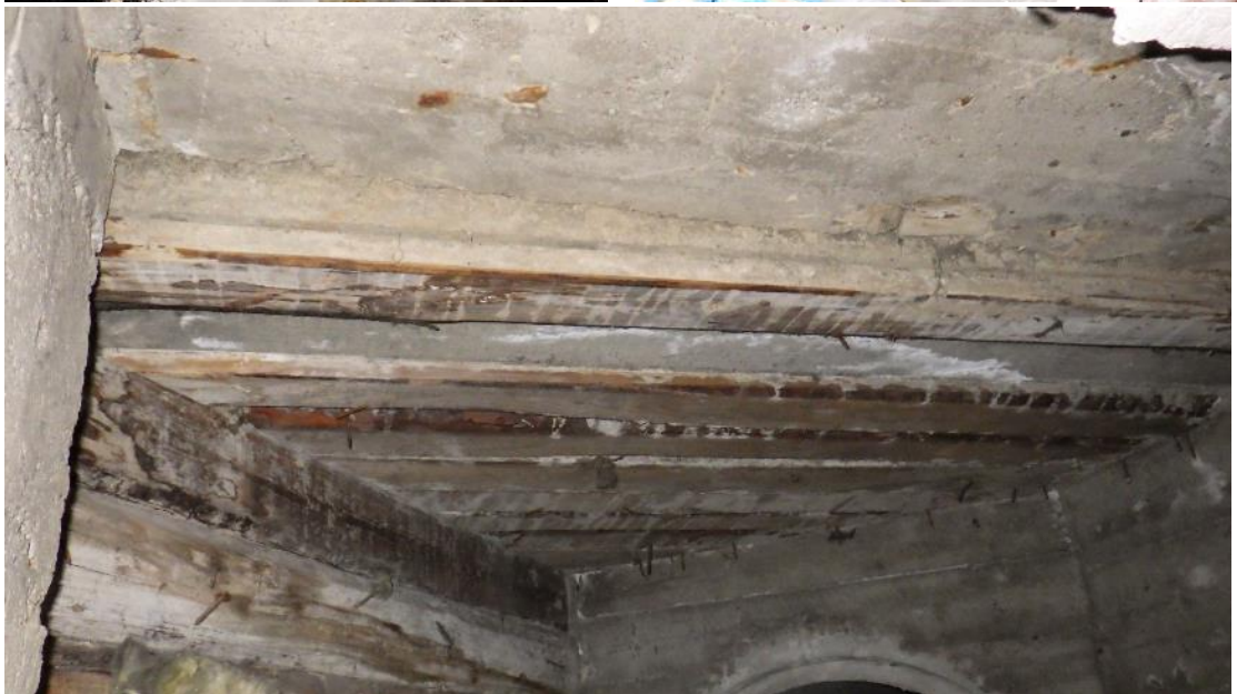
Kuvat 22 a...c. Kellarikerroksen tilan 024 maanvastaisessa seinässä on sisäilmaan avoin aukko rakennuksen ulkopuolelle johtavaan betonirakenteiseen putkikanavaan. Putkikanavassa on rakennusjätettä ja mahdollisesti asbestipitoisia putkieristeitä. Putkikanavan katossa ja seinillä on vanhoja kosteusvaurioituneita muottilautoja. Laudoituksen kosteuspitoisuudet eivät olleet koholla piikkimittarilla mitattuna (tulokset 10,0... 11,0 p-%).
