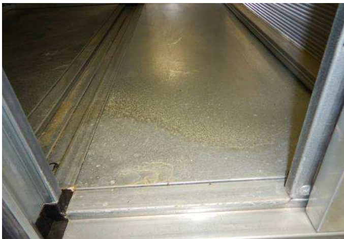
Kuva 20. Tuloilmakoneen puhallinkammiossa on kosteuden aiheuttamia jälkiä ja roskaa.
