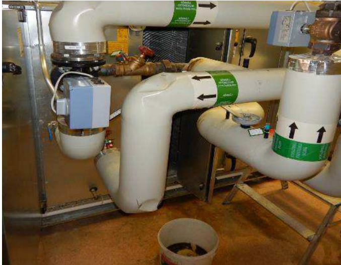
Kuva 13. Tuloilmakoneen LTO- piirin kiertovesipumpussa on vanhoja vuotojälkiä.
