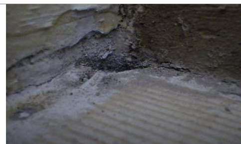
Kuvat 35 a ja b. Keittiötiloissa on massalattia. Lattiapinnassa on runsaasti leveitä halkeamia, joita on tiivistetty joustavalla massalla. Paikoin myös tiivistysmassauksissa on halkeamia.
