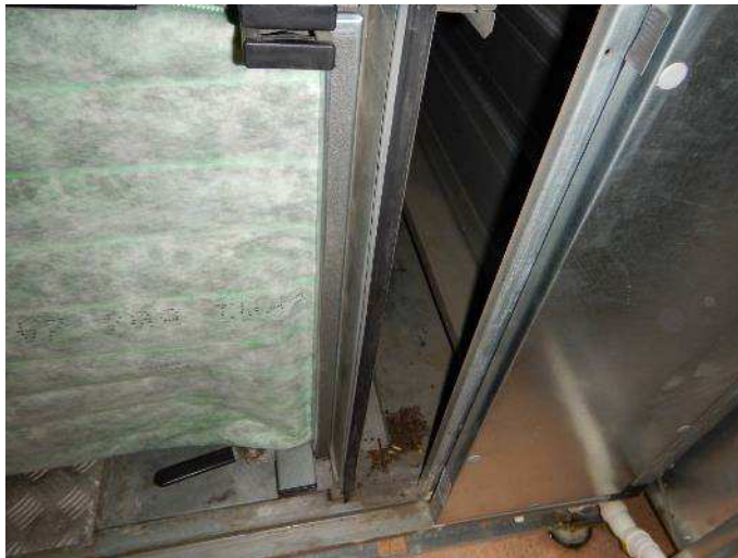
Kuva 5. Tuloilmakoneen suodattimien välissä on tiiviste, jonka johdosta suodattimen ns. otsapinnan tiivistyskohta ei osu oikealle kohdalle suodatinkehyksessä.
