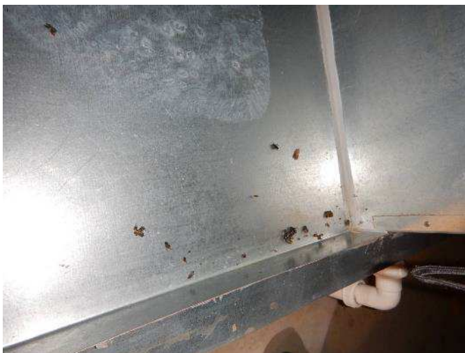
Kuva 44. Tuloilmakoneen tuloilmakammiossa on roskaa.
