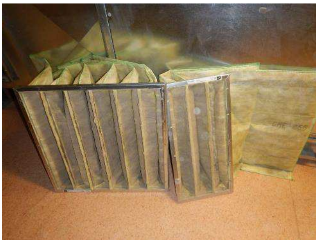
Kuva 40. Poistoilmakoneen suodattimet ovat hieman pölyiset. Poistoilmasuodattimien suodatusluokka on M5.
