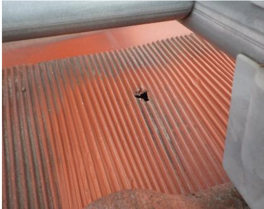
Kuvat 71 a...d. Pellitysten laadussa ja vesitiiveydessä havaittiin puutteita säännönmukaisesti.
