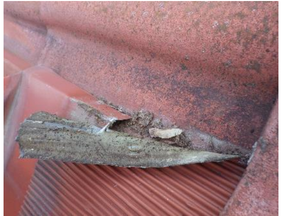
Kuvat 71 a...d. Pellitysten laadussa ja vesitiiveydessä havaittiin puutteita säännönmukaisesti.
