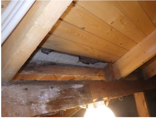
Kuva 81. Osan II vesikaton harjan aluslaudoitus on uusittu noin 2 metrin matkalta harjan molemmin puolin. Uusitus aluslaudoituksessa ei havaittu kosteusjälkiä.
