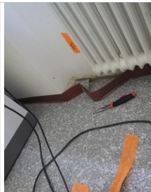
Kuvat 35 a ja b. Keittiötiloissa on massalattia. Lattiapinnassa on runsaasti leveitä halkeamia, joita on tiivistetty joustavalla massalla. Paikoin myös tiivistysmassauksissa on halkeamia.
