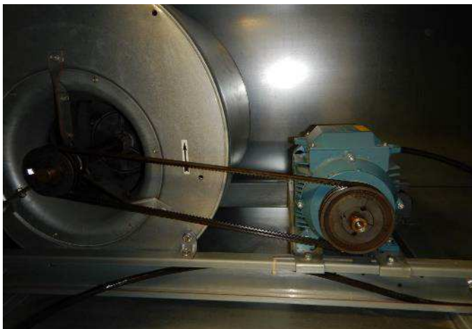
Kuva 21. Tulo- ja poistopuhaltimet ovat hieman pölyiset / nokiset.
