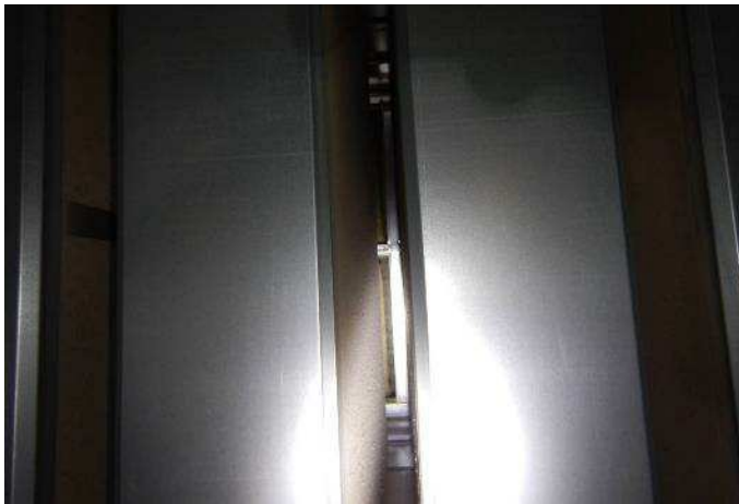
Kuva 11. Tulo- ja poistoilmakoneen äänenvaimentimien materiaalina on mineraalivilla, jonka päällä on kuitukangas. Äänenvaimentimen kuitukankaassa on merkkejä kankaan kulumisesta.
