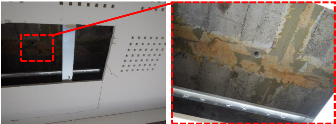
Kuva 82. Ulkoseinälinjalla ja iv-putkien läpivientien juurella havaittiin betonin kuivumis- kutistuman aiheuttamia halkeamia.
