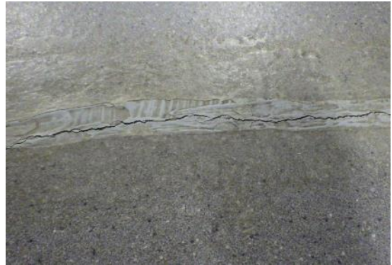
Kuvat 35 a ja b. Keittiötiloissa on massalattia. Lattiapinnassa on runsaasti leveitä halkeamia, joita on tiivistetty joustavalla massalla. Paikoin myös tiivistysmassauksissa on halkeamia.
