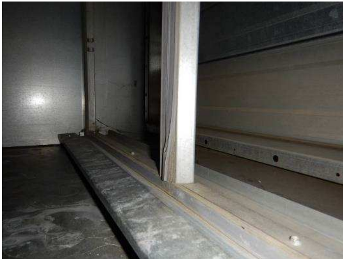
Kuva 17. Tuloilmakoneen suodatinkehysen tiivisteet ovat paikoin rikki.
