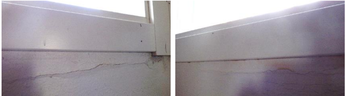
Kuvat 60 a ja b. Liikuntasalin varaston (tila 202) havaittiin halkeama ikkunan alapuolissa rappauksessa ja kosteusjälkiä listan alapuolella. Halkeama on osittain värjäytynyt.
