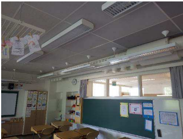
Kuva 48. 2. kerroksen ilmanjako on hoidettu suunnatulla suutinkanavalla.
