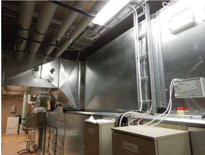
Kuva 22. Tuloilmakoneen äänenvaimenninta ei voida tarkastaa, koska kanavassa ei ole tarkastusluukkuja.
