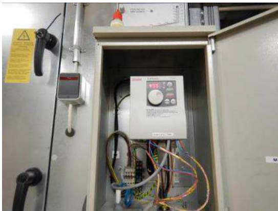
Kuva 23 a ja b. Tulo- ja poistoilmakone käynnistyvät eri tahdissa: Poistoilmakoneen käynnistysaika täydelle teholle on paljon lyhyempi kuin tuloilmakoneella.
