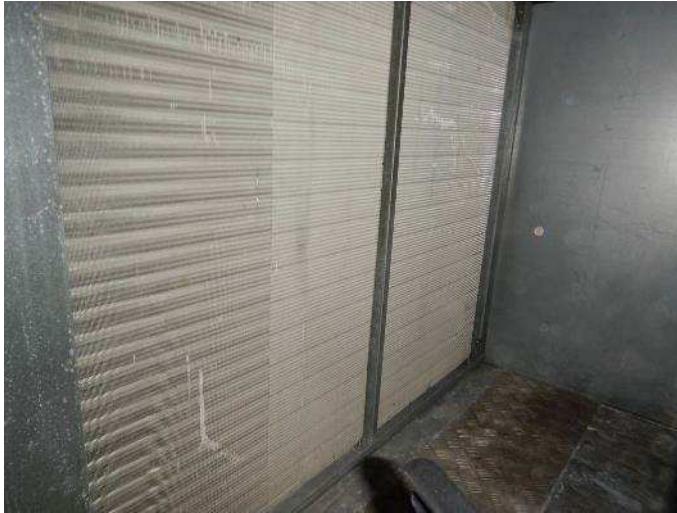
Kuva 7. Tuloilmakoneen LTO- patterissa roskaa.
