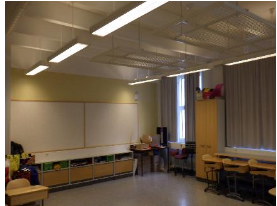
Kuvat 30 a ja b. Välipohjarakenteiden alapinnat ovat pääosin betonirakenteen alapintaan liimattuja akustolevyjä tai maalattuja betonipintoja. Avoimia mineraalivillapintoja ei havaittu.
