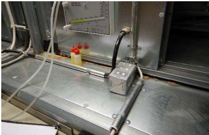
Kuva 14. Ilmanvaihtokoneiden välissä on vanhoja kosteuden aiheuttamia jälkiä.
