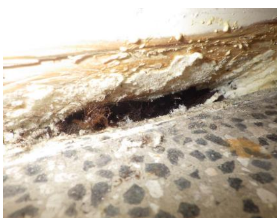
Kuvat 54 a ja b. Ikkunaliittymien ilmatiiveyttä tarkasteltiin rakenneavausten avulla irrottamalla ikkunoiden listoitukset alhaalta, sivuilta ja ylhäältä. Rakenneavaus RAUS12 tehtiin ruokasaliin (tila 137). Vanhat karmit ja tilkermateriaalit ovat paikoillaan. Uusien ja vanhojen karmien sekä ulkoseinien liittymiä on tiivistetty PUR-vaahdolla, vaahdotuksessa havaittiin vähäisiä tiiveyspuutteita merkkinavulla tarkasteltuna. Ikkunatilkkeestä havaittiin voimakas PAH-yhdisteisiin viittaava (tervan) haju. Tilkemateriaalista otettiin
