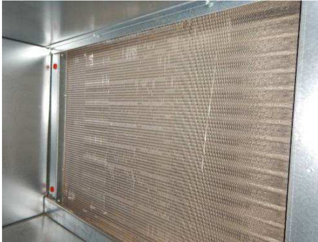
Kuva 41. Poistoilmakoneen LTO- patteri on pölyinen.
