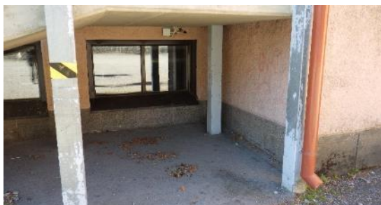
Kuva 48. Sokkelin alaosissa havaittiin monin paikoin sammalkasvustoa sekä suola- ja härmekertymää.
