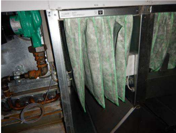
Kuva 42. Tulo- ja poistoilmakoneen suodatusluokka on F7.
