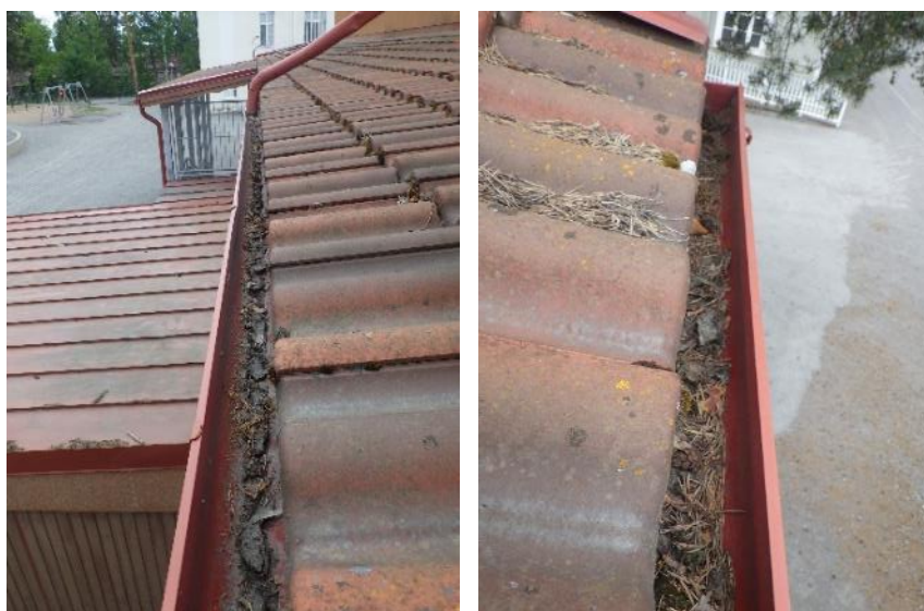
Kuvat 63 a ja b. Sadevesikourut sijaitsevat ulkoseinälinjan ulkopuolella. Sadevesikouruissa on paikoin paljon lehtiä, neulasia, sammalta ja muuta roskaa.
