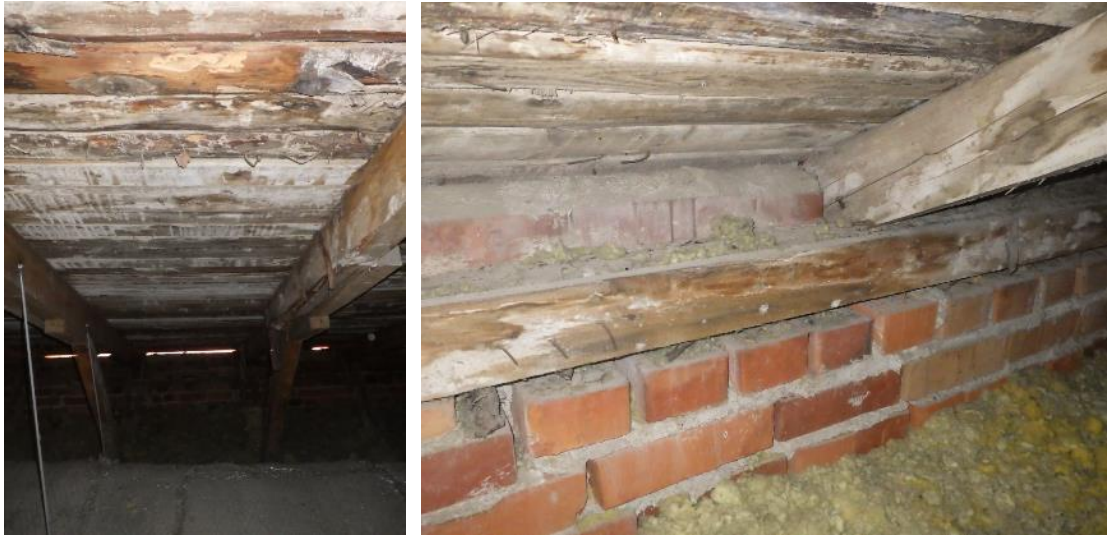
Kuvat 79 a ja b. Ullakkotiloissa havaittiin hieman ummehtunut haju. Tuuletusraot havaittiin räystäällä. Osan I ullakolla räystäään tuuletusraot on paikoin tukittu mineraalivillalla. Päädyissä ei havaittu tuuletusrakoja.
