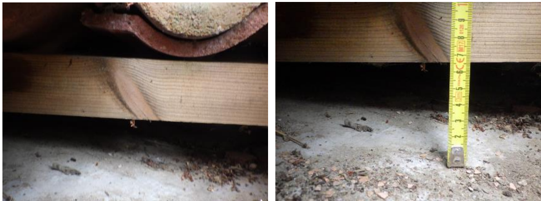
Kuvat 62 a ja b. Kattotiilien ja aluskatteen välinen tila tuulettuu vapaasti.
