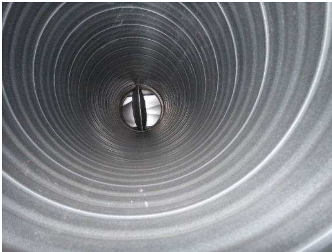
Kuva 29. Koneelta lähtevä tuloilmakanava on puhdas.
