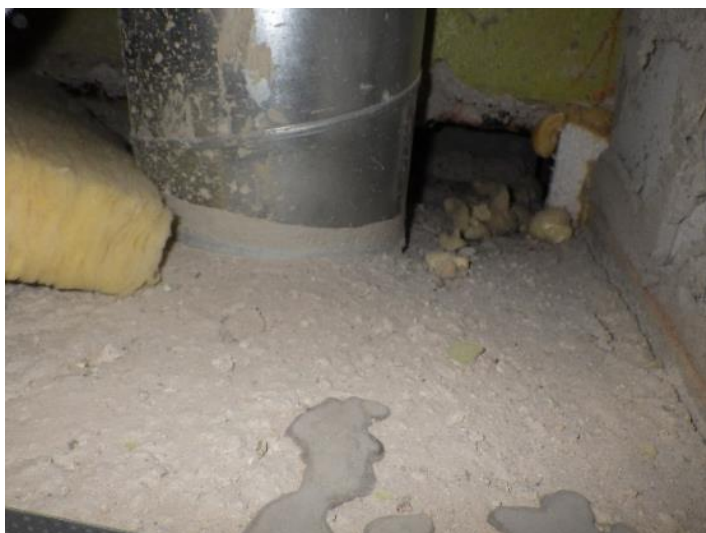
Kuvat 42 a ja b. Iv-putkien välipohjien läpivientien ilmatiiveyttä tarkasteltiin pystyrakenteisiin koteloihin tehtyjen rakenneavausten kautta. Betoni on valettu päin iv-putkea. Rakenneavauksen RAKO2 yhteydessä iv-putken juuressa havaittiin vähäinen betonin kuivumiskutistuman aiheuttama halkeama (merkitty punaisella kuvaan b). Läpivientien tiiveydessä ei havaittu merkittäviä ilmatiiveyspuutteita merkisavulla tarkasteltuna.
