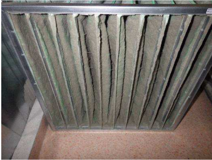
Kuva 25. Tuloilman suodatusluokka on F7. Suodattimet ovat likaiset.
