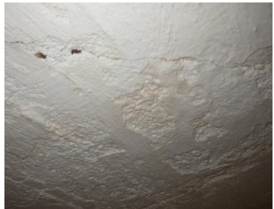
Kuvat 87 a ja b. Osan I iv-konehuoneen kattopinnassa on vesivuotojälkiä iv-koneen päällä ja läpiviennin ympärillä.
