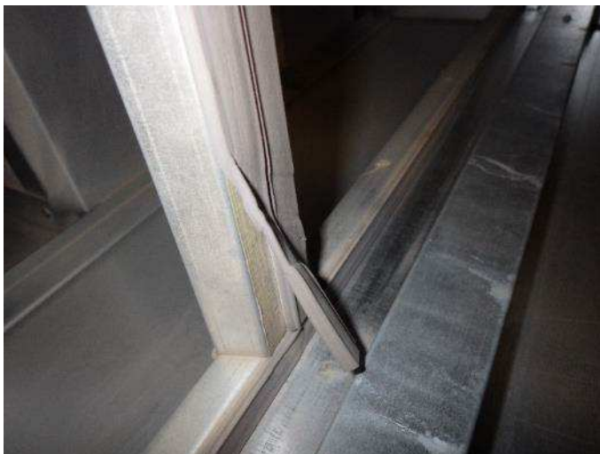
Kuva 30. Poistoilmasuodattimien suodatinkehikon tiiviste repsottaa.
