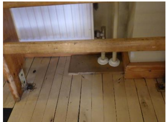
Kuvat 31 a ja b. Käyttäjiltä saatujen tietojen mukaan liikuntasalissa (tila 208) on koettu eniten sisäilman puutteisiin viittaavaa oireilua. Liikuntasalissa on pääosin siistikuntoinen parkettilattia. Puolapuiden takana patteriputkien läpiviennin kohta on paikattu vannerinpalalla (kuva b). Patteriläpiviennistä havaittiin selvä ilmavirta sisäilmaan päin merkkisavulla tarkastettuna.
