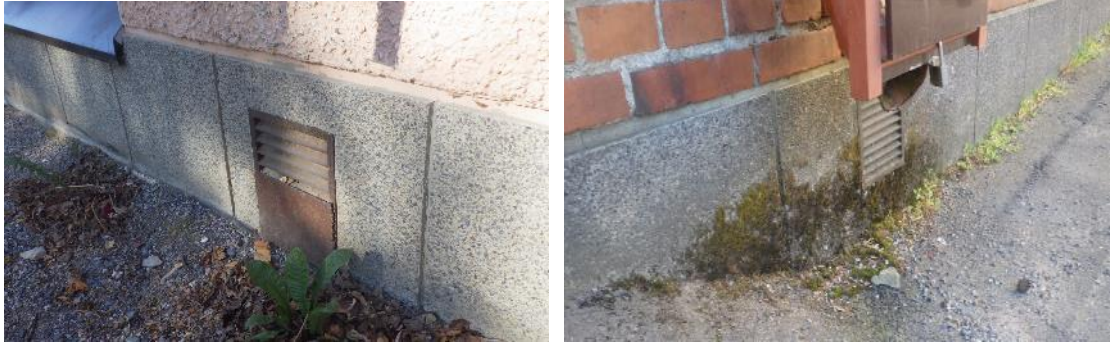
Kuvat 21 a...c. Vanhan painovoimaisen ilmanvaihdon kellaritilojen korvausilma-aukot sijaitsevat lähellä maanpinnan tasoa. Syöksytorven alapuolelle sijoitettu korvausilma-aukko on ympäriltään sammaloitunut.
