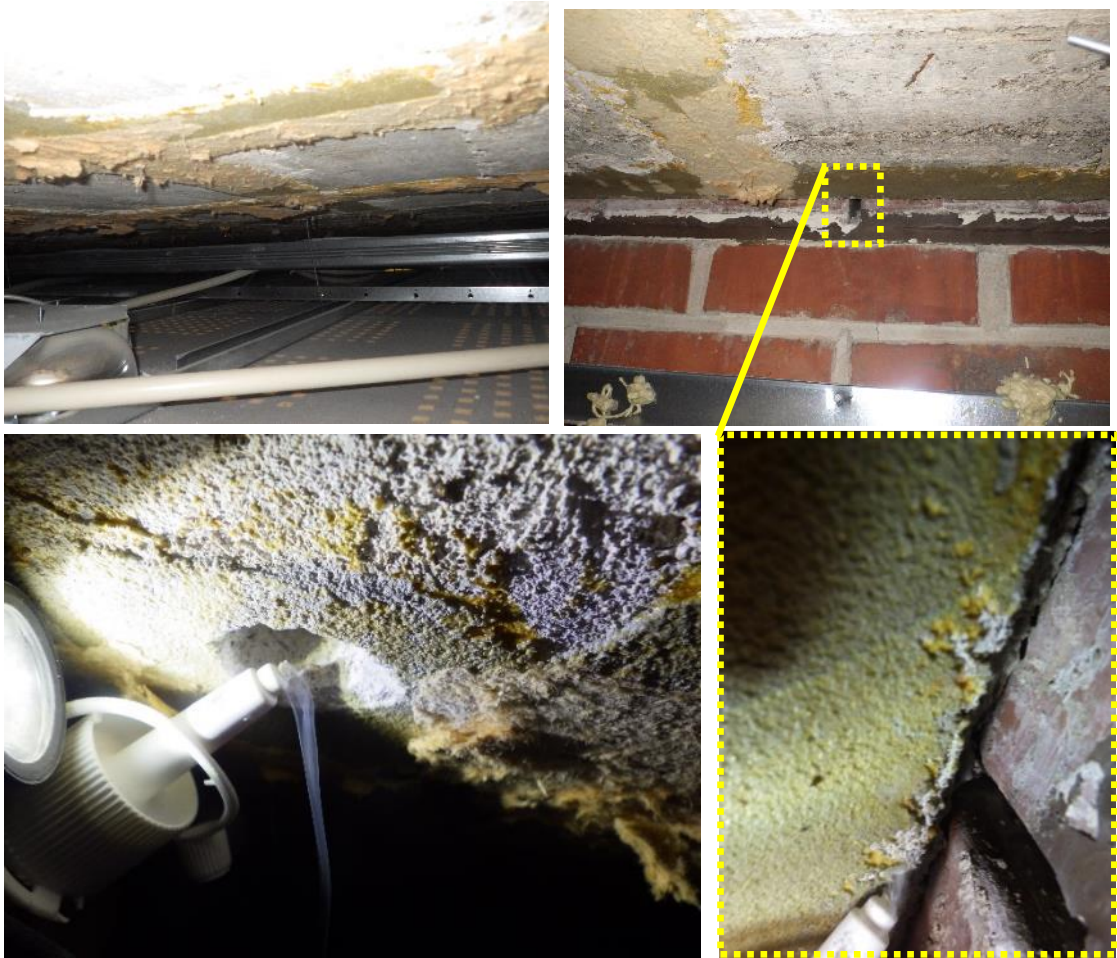
Kuvat 83 a...e. Rakennus RAYP1 tehtiin aulan 140 alakattoon lähelle vesikaton ja ulkoseinän liittymää. Betonilaatan alapinnassa on jäänteitä vanhoista alakattolevyistä, avoimia mineraalivillapintoja ei havaittu. Alakaton yläpuolinen tila on hyvin pölyinen. Betonilaatan läpiporauksesta sekä laatan ja seinän liittymästä havaittiin selvät ilmavirrat sisäilmaan päin merkisavun avulla tarkasteltuna (kuvat d ja e). Rakenteesta ei havaittu poikkeavia hajuja.
