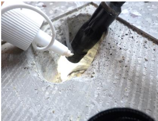
Kuva 28. Rakenneavauksesta RAVP11 havaittiin selvä ilmavirta sisäilmaan päin. Poikkeavia hajuja ei havaittu.
