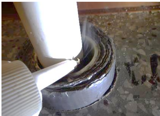
Kuva 41. Käytävätilassa 131 palopostin kohdalla sijaitsevasta putkiläpiviennistä puutuu läpivientimansetti. Läpiviennistä havaittiin selvä ilmavirtaus sisäilmaan päin merkisavulla tarkastettuna.
