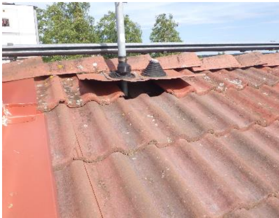
Kuva 72. Paikoin pellitykset ovat irti osan I vesikatolla.
