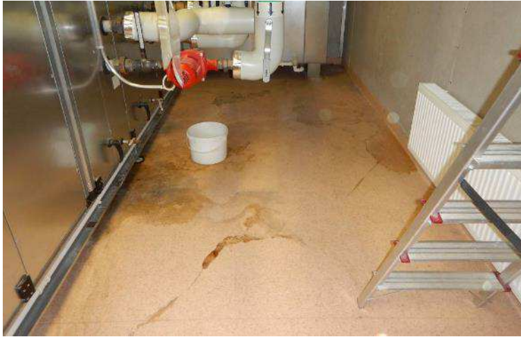
Kuva 1. Yleiskuva IV- konehuoneesta, jossa on kosteuden aiheuttamia jälkiä.
