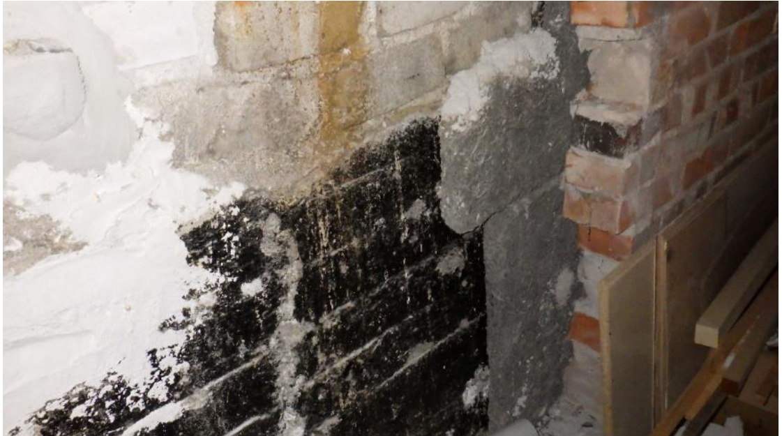
Kuva 17. Kellarikerroksen maanvastaiset seinät ovat pääosin verhomuurattuja betonirakenteita. Tiilimuurauksen takana on lämmöneristeenä sementtilastuvillalevytys ja vedeneristeenä bitumisively. Tiiliverhoilu ja sementtilastuvillalevy on purettu pois tiloista 006, 024 ja 025.
