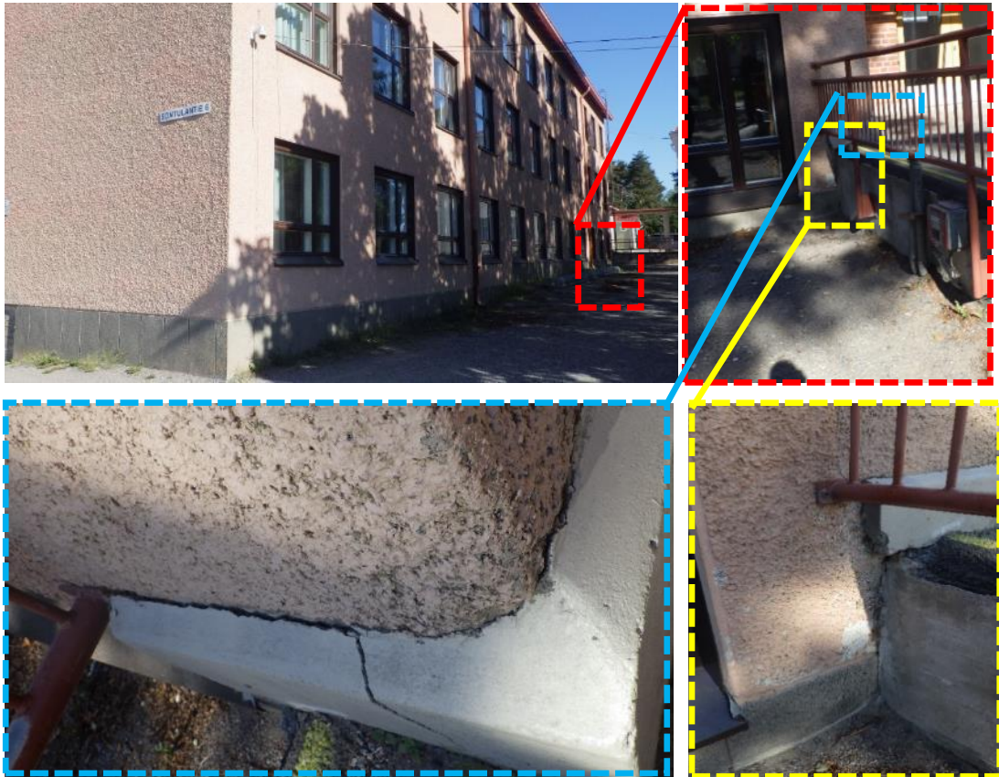
Kuvat 47 a...d. Rakennuksen ulkoseinät ovat pääosin rapattuja. Sisääntuloaulan pihakannen kohdalla ulkoseinän alaosan rappaus on lohkeillut ja halkeillut (kuva d). Ruokalan kulmassa rapatun ulkoseinän ja pihakansirakenteen liittymässä on rako ja halkeamia betonirakenteisessa kynnyksessä (kuvat c ja d).
