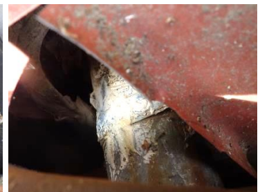
Kuvat 73 a...c. Pienempiä vesikaton läpivientejä on toteutettu kumitiivisteiden ja läpivientikappaleiden avulla. Läpivientien vesitiiveydessä havaittiin puutteita monin paikoin.
