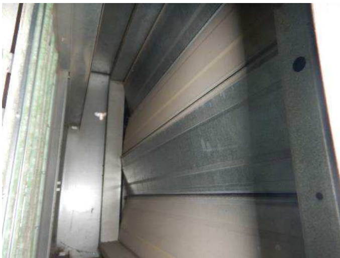
Kuva 18. Tuloilmakoneen raitisilmapelti ei sulkeudu täysin.
