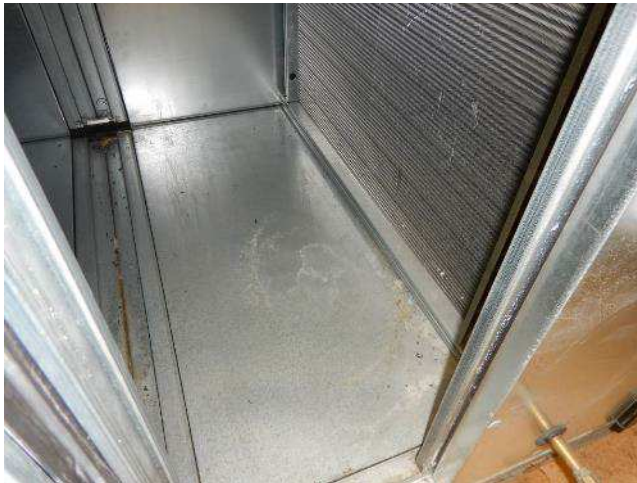
Kuva 36. Tuloilmakoneen puhallinkammiossa on pölyä, roskaa ja kosteuden aiheuttamia jälkiä.
