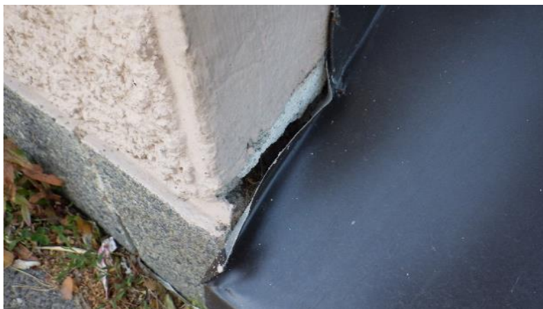
Kuvat 53 a ja b. Vesipeltien pystynostojen vesitiiveydessä havaittiin puutteita monin paikoin: seinälle nostoa tai pielipeltiä ei ole kitattu tai tiivistetty ja paikoitellen pellitykset ovat vääntyneet, jolloin pellin ja ulkoseinän väliin on muodostunut rako (kuva a). Myös pielipellit ovat paikoin vääntyneet (kuva b).
