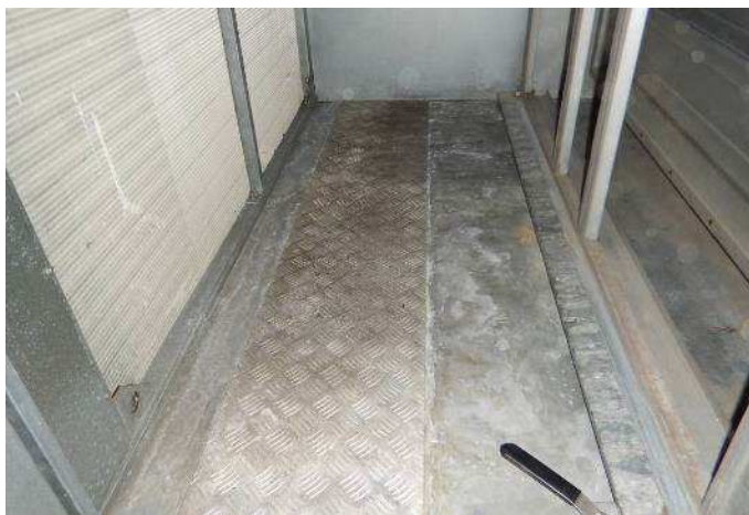
Kuva 6. Tuloilmakoneen suodatinkammiossa on kosteuden aiheuttamia jälkiä.
