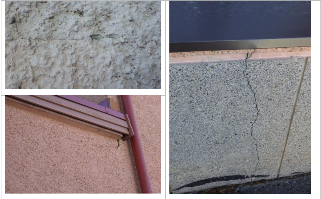
Kuvat 50 a...c. Seinissä ja sokkeleissa havaittiin halkeamia monin paikoin.
