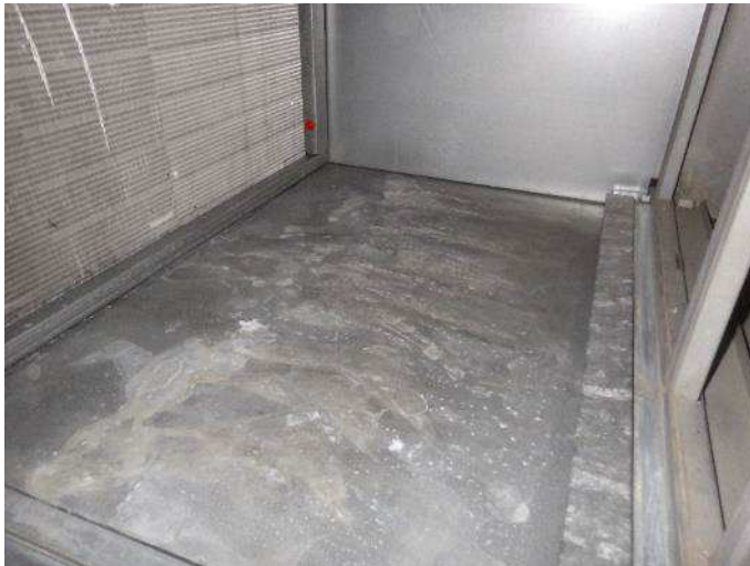
Kuva 26. Suodatinkammiossa on kosteusjälkiä.
