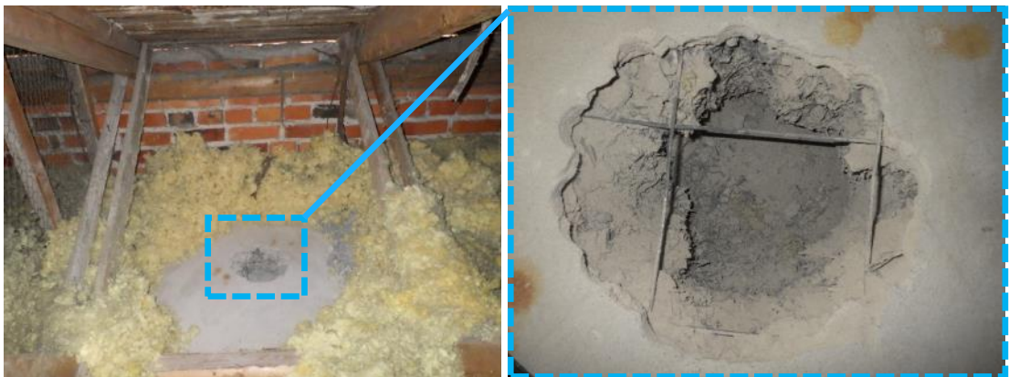
Kuvat 84 a ja b. Rakennus RAYP3 tehtiin osan I ullakotilasta käsin lähelle räystästä kohtaan, jossa yläpuolisessa aluslaudoituksessa on vanhoja kosteusjälkiä. Ma-
