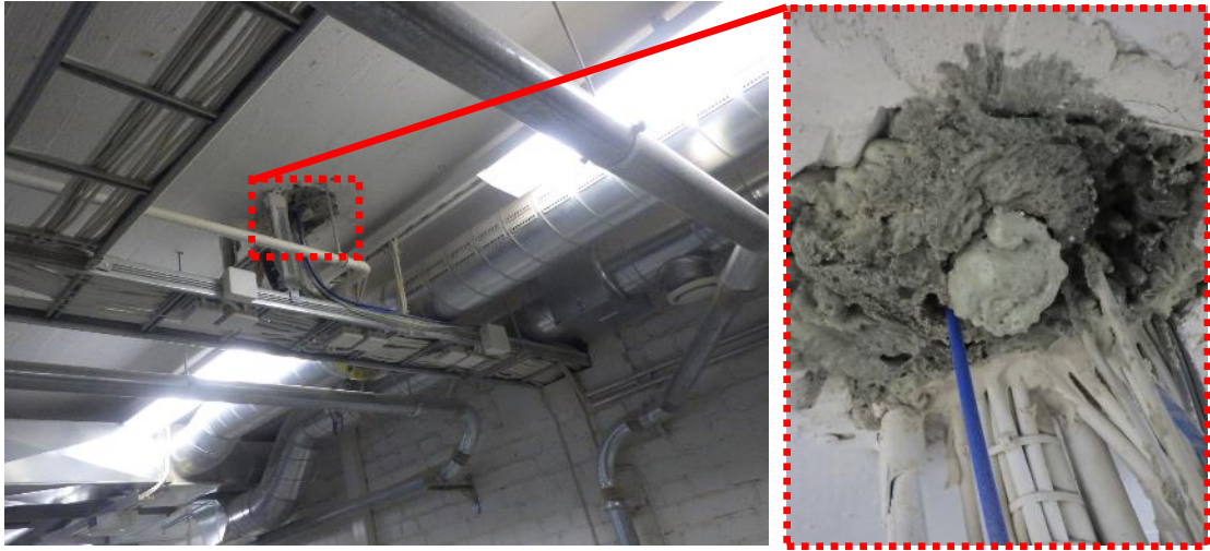
Kuvat 40 a ja b. Teknisen työn tilan 114 katossa on sähköjohtojen läpivienti, mitä on tiivistetty mm. PUR-vaahdolla. Vaahdotuksessa on puutteita, ja läpiviennistä havaittiin selvä ilmavirta sisäilmaan päin merkkinavulla tarkastettuna.
