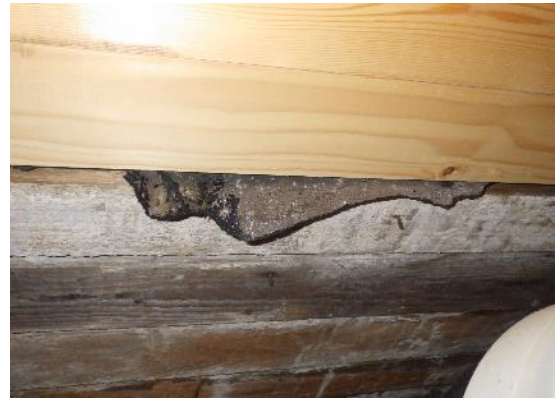
Kuvat 77 a ja b. Osan II vesikatteen aluskatteena havaittiin paikoin muovinen aluskate (yläpuolelta tarkasteltuna), osin bitumikermi ullakolta tarkasteltuna. Paikoin aluskatetta ei havaittu.
