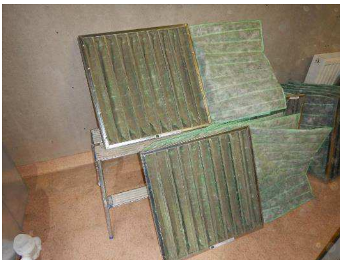
Kuva 15. Tuloilmakoneen suodattimet ovat likaiset. Tuloilmasuodattimien suodatusluokka on F7.
