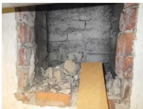
Kuvat 94 a...c. Lämmönjakohuoneen väliseinässä on tarkastusluukku käytöstä poistettuun tulisijan hormiin. Hormin pohjalla on tiili- ja laastimurskaa. Tarkastusluukusta havaittiin selvä ilmavirtaus hormiin päin merkkisavulla tarkastettuna.
