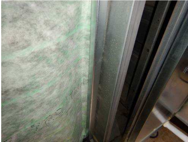
Kuva 32. Tuloilmakoneen suodattimien välissä on tiiviste, jonka johdosta suodattimien ns. otsapinnan tiivistyskohta ei osu oikealle kohdalle suodatinkehyksessä.
