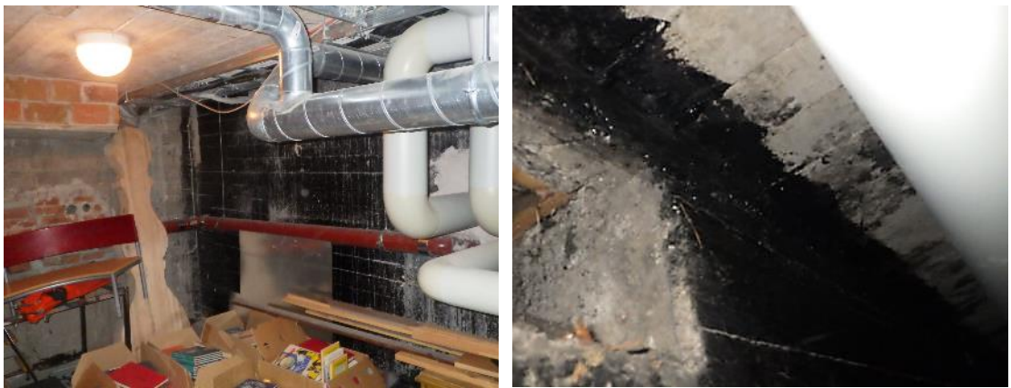
Kuvat 18 a ja b. Maanvastaisen seinän ja välipohjarakenteen liittymän tiiveyttä tarkasteltiin tilassa 024, josta sisäpuoliset rakenteet on purettu pois. Liittymän tiiveydessä ei havaittu puutteita. Maanvastaisen seinän ja välipohjan betonirakenteiden liittymässä ei havaittu rakoja. Tiloissa, jossa sisäpuoliset rakenteet on purettu pois, maanvastaisen seinän bitumisively on jatkettu liittymän yli välipohjalaatan alapintaan.
