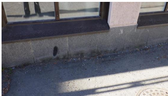
Kuva 48. Sokkelin alaosissa havaittiin monin paikoin sammalkasvustoa sekä suola- ja härmekertymää.
