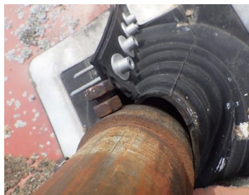
Kuvat 73 a...c. Pienempiä vesikaton läpivientejä on toteutettu kumitiivisteiden ja läpivientikappaleiden avulla. Läpivientien vesitiiveydessä havaittiin puutteita monin paikoin.
