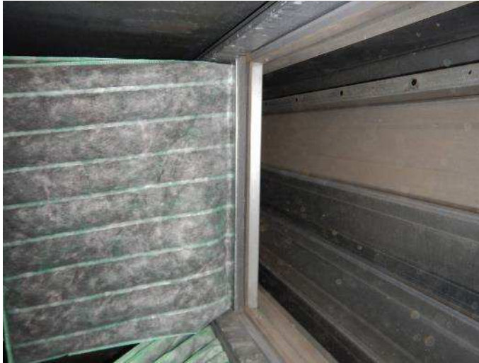
Kuva 16. Tuloilmakoneen suodattimien välissä on tiiviste, jonka johdosta suodattimen ns. otsapinnan tiivistyskohta ei osu oikealle kohdalle suodatinkehyksessä.
