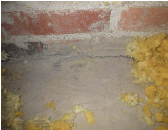
Kuva 82. Ulkoseinälinjalla ja iv-putkien läpivientien juurella havaittiin betonin kuivumis- kutistuman aiheuttamia halkeamia.
