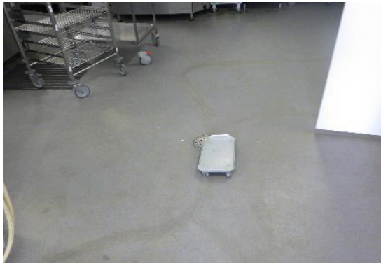
Kuvat 35 a ja b. Keittiötiloissa on massalattia. Lattiapinnassa on runsaasti leveitä halkeamia, joita on tiivistetty joustavalla massalla. Paikoin myös tiivistysmassauksissa on halkeamia.
