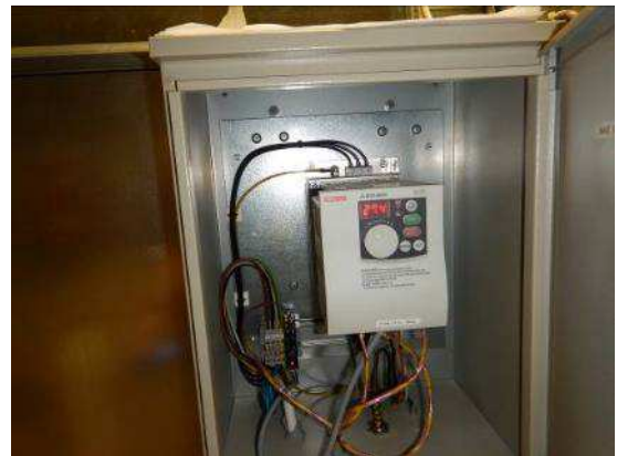
Kuva 23 a ja b. Tulo- ja poistoilmakone käynnistyvät eri tahdissa: Poistoilmakoneen käynnistysaika täydelle teholle on paljon lyhyempi kuin tuloilmakoneella.
