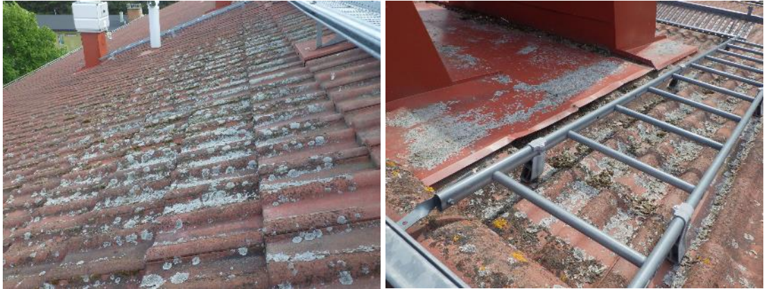
Kuvat 67 a ja b. Vesikatoilla on paikoitellen sammaloituneita alueita.
