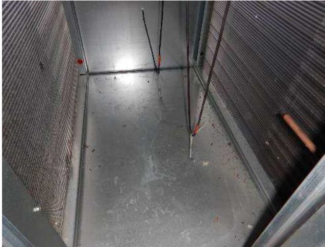
Kuva 35. LTO- patteri ja lämmityspatterit ovat pölyiset ja niiden välisessä kammiossa on roskaa ja pölyä.
