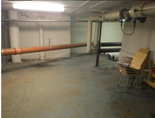
Kuvat 88 a ...d. Osan I tilojen 034 (kuvat a ja b) ja 035 (kuvat c ja d) yläpuolella on pihakansi. Molempien tilojen alakatoissa havaittiin kosteusjälkiä, samoin kuin tilan 035 maanvastaisissa seinissä. Pintakosteudenilmaisimen lukemat olivat selvästi koholla tilan 035 katossa.
