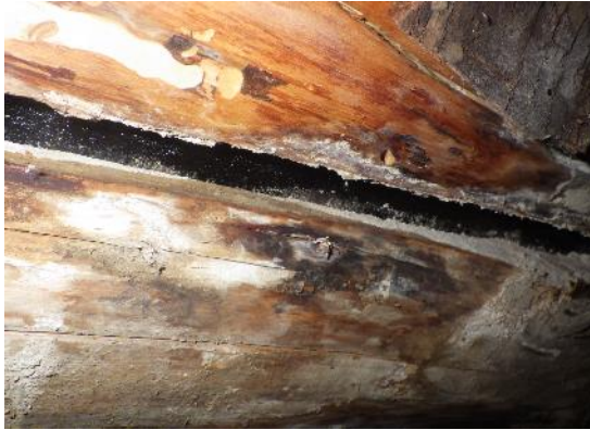
Kuva 76. Osan I vesikatteen aluskatteena on bitumikermi. Aluslaudoituksessa havaittiin runsaasti vanhoja kosteusjälkiä.
