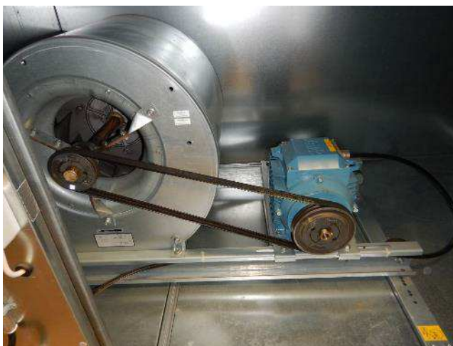
Kuva 37. Tulo- ja poistopuhaltimet ovat hieman pölyiset / nokiset.
