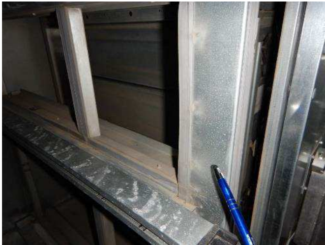
Kuva 33. Tuloilmakoneen suodatinkehysen tiivisteet ovat painuneet, jonka takia kehyksessä tapahtuu ohivirtausta.
