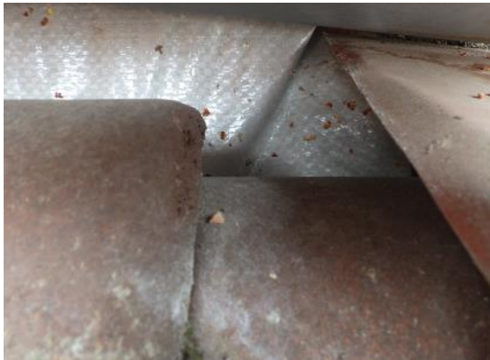
Kuvat 77 a ja b. Osan II vesikatteen aluskatteena havaittiin paikoin muovinen aluskate (yläpuolelta tarkasteltuna), osin bitumikermi ullakolta tarkasteltuna. Paikoin aluskatetta ei havaittu.
