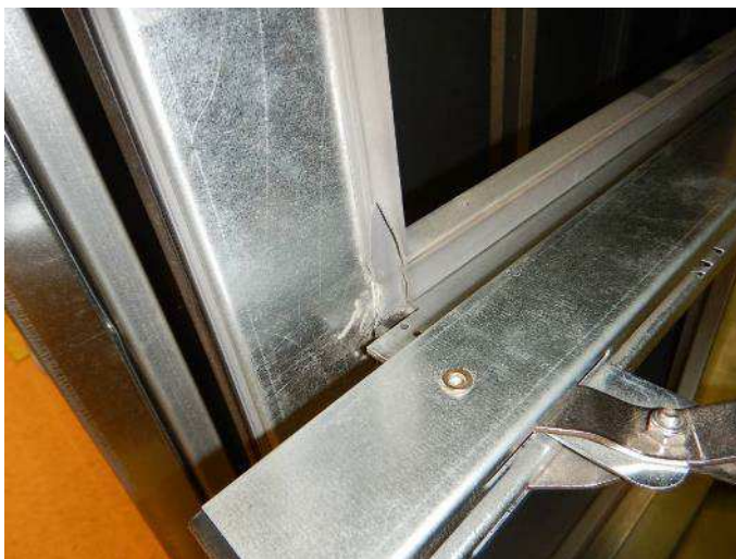
Kuva 12. Poistoilmakoneen suodatinkehysten tiivisteet ovat paikoin rikki.
