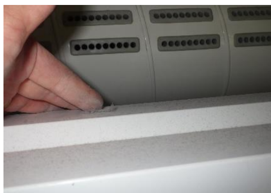
Kuvat 95 a ja b. Tutkimusten yhteydessä tasopinnoille havaittiin kertyneen tavanomainen määrä pölyä, mutta vaikeammin siivottavissa kohdissa (esim. valaisimien ja iv-putkien päällä) havaittiin runsas pölykertymä (kuva a). Yläpölyjen määrää tarkasteltiin pistokoeluentoisesti. Liikuntasalissa ja näyttämöllä on raskaat verhot (kuvassa b), joita ei käyttäjiltä saatujen tietojen perusteella ole puhdistettu kertaakaan.
