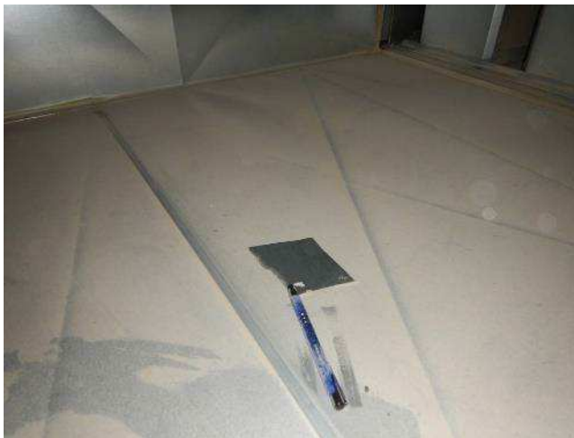
Kuva 39. Poistoilmakammio on pölyinen.
