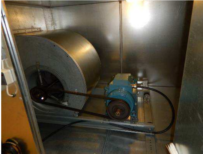
Kuva 10. Tulo- ja poistopuhaltimet ovat pölyiset / nokiset.
