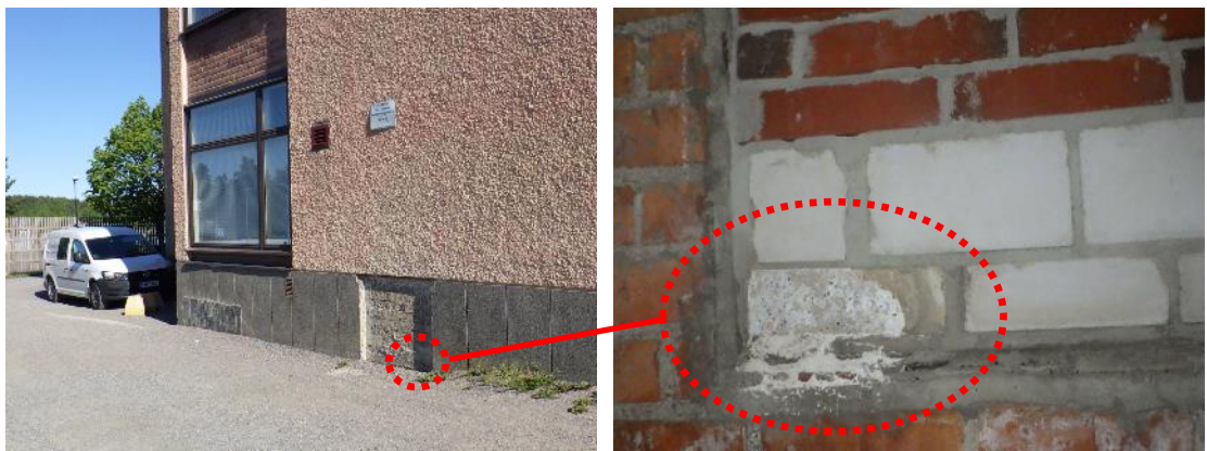
Kuvat 20 a ja b. Tilojen 005 ja 006 maanvastaisissa seinissä on ummistettuja luukkuja maanpinnan tason yläpuolella. Tilassa 006 luukun ummistukseen käytetty alakulman kahi-tiili on vaurioitunut, verhомуurauksessa on suola- ja härmekertymää ummistuksen alapuolella.
