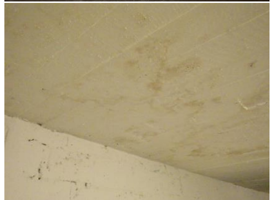
Kuvat 88 a ...d. Osan I tilojen 034 (kuvat a ja b) ja 035 (kuvat c ja d) yläpuolella on pihakansi. Molempien tilojen alakatoissa havaittiin kosteusjälkiä, samoin kuin tilan 035 maanvastaisissa seinissä. Pintakosteudenilmaisimen lukemat olivat selvästi koholla tilan 035 katossa.
