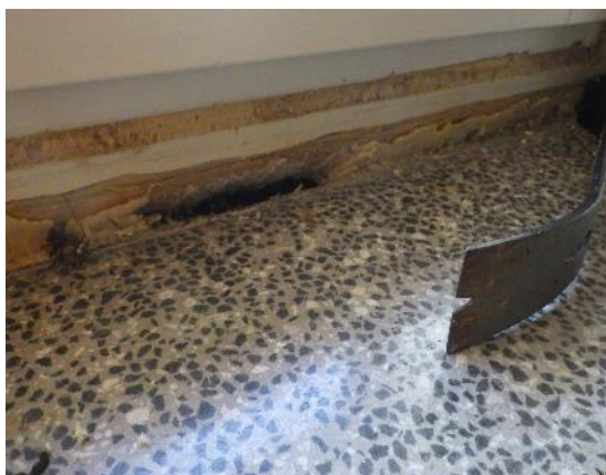
Kuvat 54 a ja b. Ikkunaliittymien ilmatiiveyttä tarkasteltiin rakenneavausten avulla irrottamalla ikkunoiden listoitukset alhaalta, sivuilta ja ylhäältä. Rakenneavaus RAUS12 tehtiin ruokasaliin (tila 137). Vanhat karmit ja tilkermateriaalit ovat paikoillaan. Uusien ja vanhojen karmien sekä ulkoseinien liittymiä on tiivistetty PUR-vaahdolla, vaahdotuksessa havaittiin vähäisiä tiiveyspuutteita merkkinavulla tarkasteltuna. Ikkunatilkkeestä havaittiin voimakas PAH-yhdisteisiin viittaava (tervan) haju. Tilkemateriaalista otettiin
