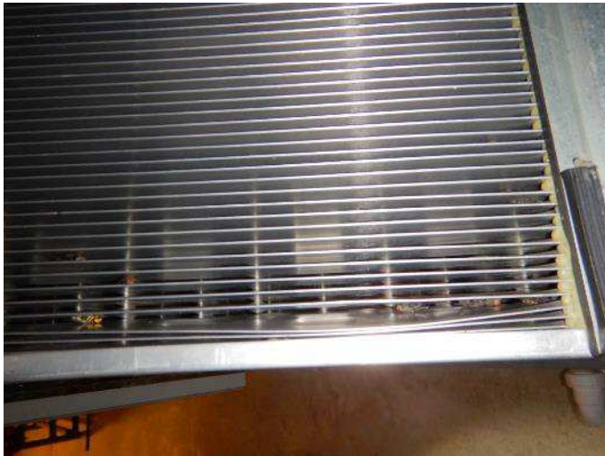
Kuva 43. Ilmanvaihtokoneen LTO- kuutiossa on roskaa.
