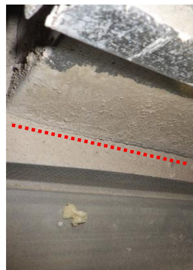
Kuvat 42 a ja b. Iv-putkien välipohjien läpivientien ilmatiiveyttä tarkasteltiin pystyrakenteisiin koteloihin tehtyjen rakenneavausten kautta. Betoni on valettu päin iv-putkea. Rakenneavauksen RAKO2 yhteydessä iv-putken juuressa havaittiin vähäinen betonin kuivumiskutistuman aiheuttama halkeama (merkitty punaisella kuvaan b). Läpivientien tiiveydessä ei havaittu merkittäviä ilmatiiveyspuutteita merkisavulla tarkasteltuna.
