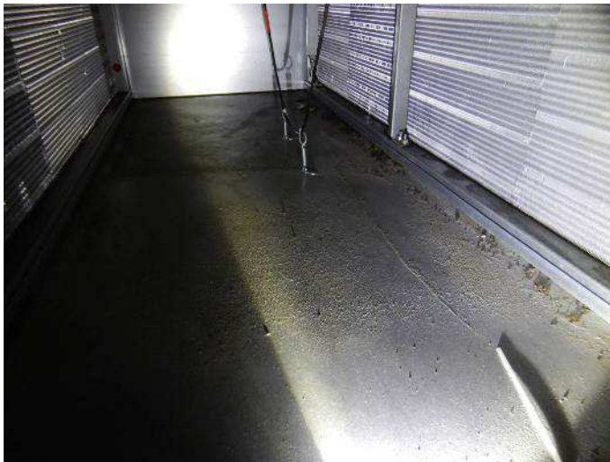
Kuva 8. LTO- patterin ja lämmityspatterin välisessä kammiossa on paljon roskaa ja pölyä.
