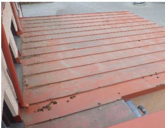
Kuva 66. Osan II varastotilan (tila 162) vesikatteena on konesaumattu rivipeltikate.
