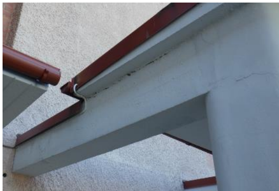
Kuva 51. Katoksissa ja muissa betonirakenteissa havaittiin halkeamia.
