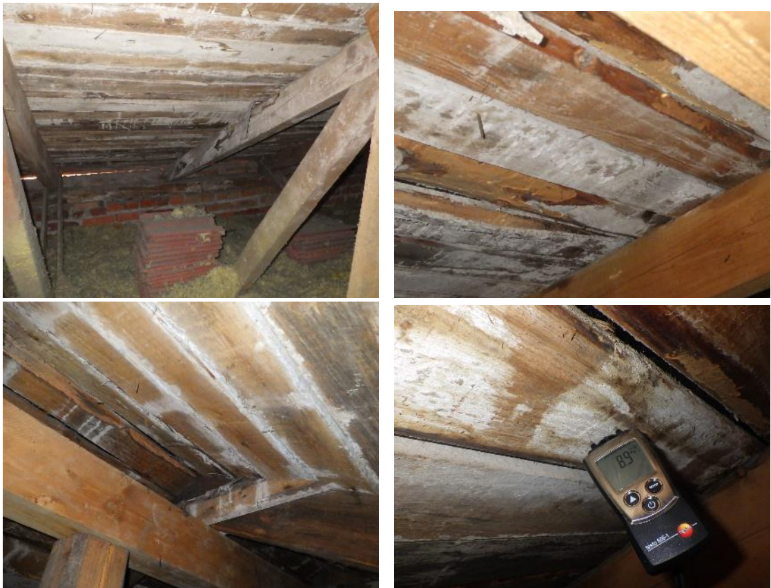
Kuvat 80 a...d. Molempien osin vesikaton aluslaudoituksessa ja tukirakenteissa havaittiin kosteusjälkiä. Puurakenteiden kosteuspitoisuuksia mitattiin pistokoeluentaisesti. Puurakenteet olivat tarkasteluhetkellä kuivia kosteuspitoisuuden ollessa 9,5...10,5 p-% piikkimittarilla mitattuna.
