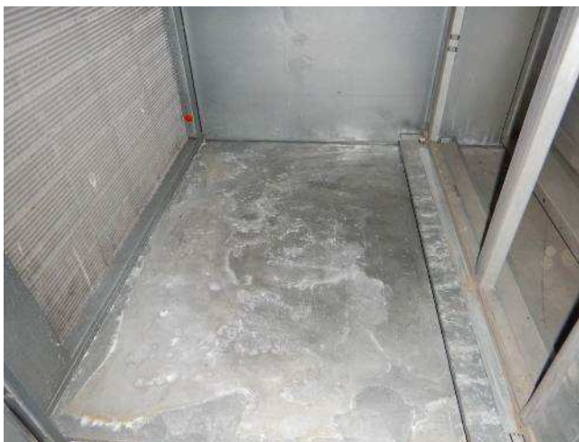
Kuva 34. Tuloilmakoneen suodatinkammiossa on kosteuden aiheuttamia jälkiä.
