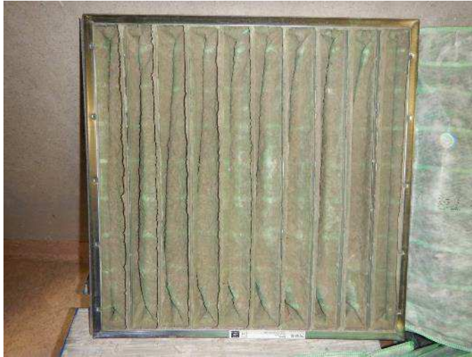
Kuva 4. Tuloilmakoneen suodattimet ovat likaiset. Suodattimien suodatusluokka F7.
