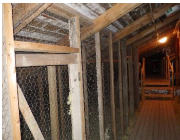
Kuvat 78 a...c. Yleiskuvia osan I ja osan II ullakkotiloista. Ullakkotilat ovat yhtenäisiä, avoimia tiloja. Vapaata tilaa on 200...3000 mm. Puhallusvillapinnat olivat paikoin talottuja, mutta muuten siistejä. Eristeissä ei havaittu viitteitä vesivuodoista.
