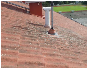
Kuvat 73 a...c. Pienempiä vesikaton läpivientejä on toteutettu kumitiivisteiden ja läpivientikappaleiden avulla. Läpivientien vesitiiveydessä havaittiin puutteita monin paikoin.
