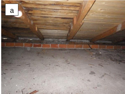
Kuvat 48a ja b. Vesikatteen aluslaudoitusta on paikoin uusittu. Vesikatteen alusrakenteena on aluskate + umpilaudoitus. Räystäiden kohdilla puurakenteissa on havaittavissa kosteuden aiheuttamia jälkiä.
