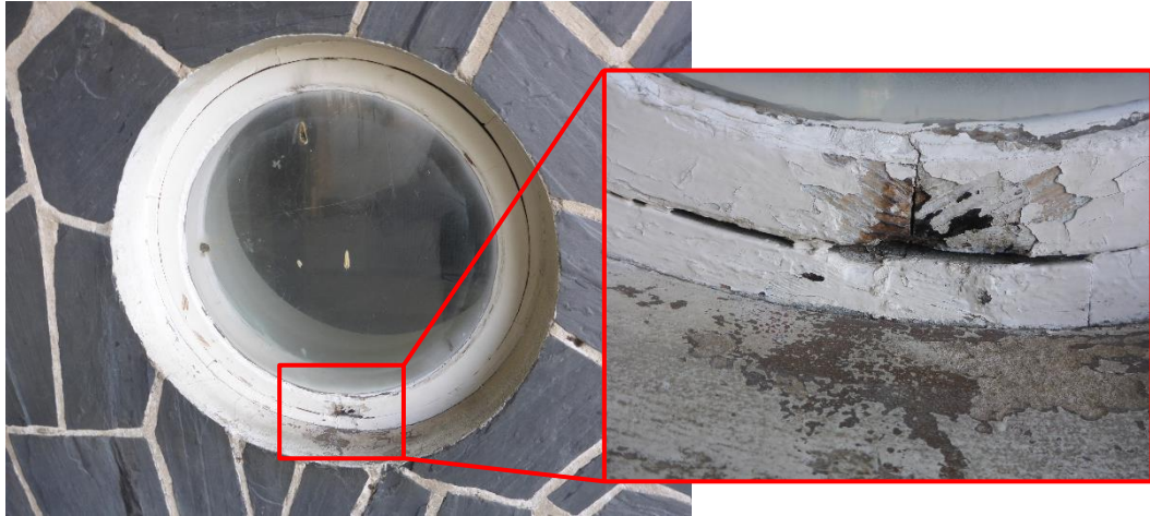
Kuva 43. Pääoven viereisen pyöreän ikkunan puitteissa todettiin maalipinnan hilseilyä. ikkunan alapuolella ei ole lainkaan pellitystä. Ikkuna sijaitsee katoksessa, joten siihen kohdistuva kosteusrasitus on vähäinen.
