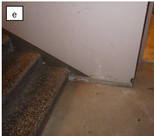
Kuvat 17 a...f. Kellarin portaikossa ja varastossa havaittiin pinnoitevaurioita ja kohonneita pintakosteuslukemia. Kuvassa f on havaittavissa maalipinnoitteen ja tasoitteen takana bitumisivelyvedeneriste. Bitumisively on paikoin irti alustastaan.
