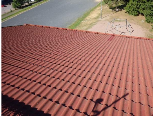
Kuva 59. Länsisivulla jäkälä- ja sammalkasvusto on vähäisempää.
