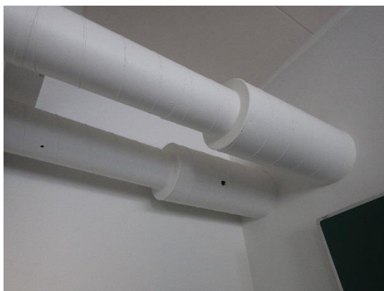
Kuva 92 a ja b. Äänenvaimentimeen tehtiin reikä luokassa 006. Vaimennusmateriaalina on mineraalivillaa, jonka reikäpellistä vastaan oleva pinta on suojattu harsokankaalla.
