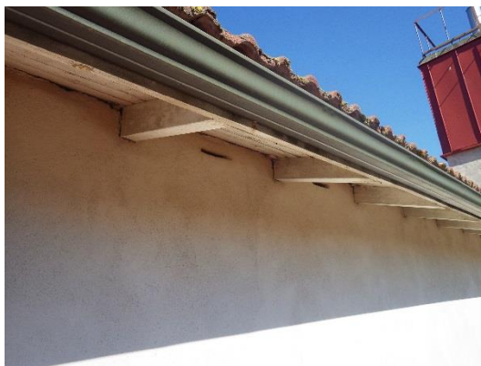
Kuva 63. Vesikaton tuuletus on järjestetty ulkoseinän yläosiin tehdyillä tuuletusaukoilla. Tuuletusaukkojen sisäpuolelle on asennettu pieneläinverkot.
