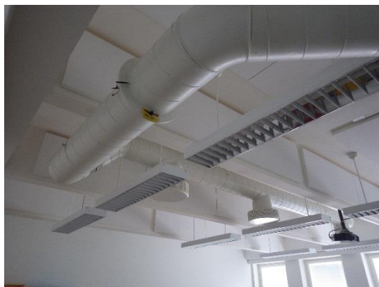
Kuva 91 a ja b. Luokkatilojen ilmanjako on toteutettu yleisimmin poistoilman osalta poistoilmasäleiköillä ja tuloilman osalta kattohajoittajilla.
