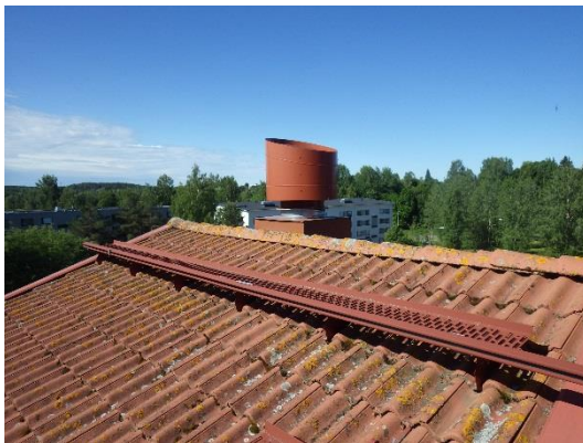
Kuva 58. Tiilikatteessa on hieman jäkälä- ja sammalkasvustoa. Vaurioituneita tiiliä ei havaittu.
