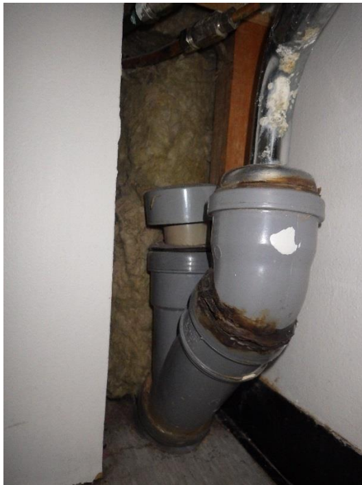
Kuva 39. Välipohjarakenteen läpiviennit olivat silmämääräisesti tarkasteltuna pääosin tiiviitä. Paikoin viemärikoteloissa havaittiin mineraalivillaa.
