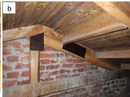
Kuvat 49a ja b. Luokkasiiven kantavia kattorakenteita on paikoin uusittu ja tuettu vanerilevyillä.
