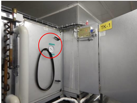
Kuva 69 a ja b. Tuloilmakoneen suodatinkammiossa on lämpömittari, joka rikkoo tuloilmasuodattimen, kun koneen luukku suljetaan.
