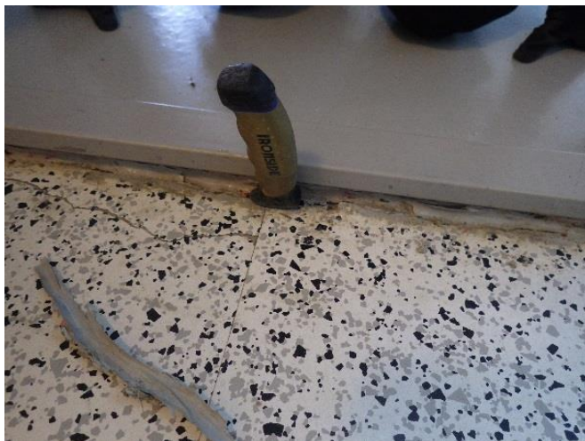
Kuva 27. Puutyöluokan alapohjarakenteen liittymä kynnyksen kohdalla. Pintalaatan ja kynnyksen (viereisen alapohjalaatan) väliin jää rako. Liittymää on tiivistetty elastisella massalla. Massan tartunta alustaansa on puutteellinen.
