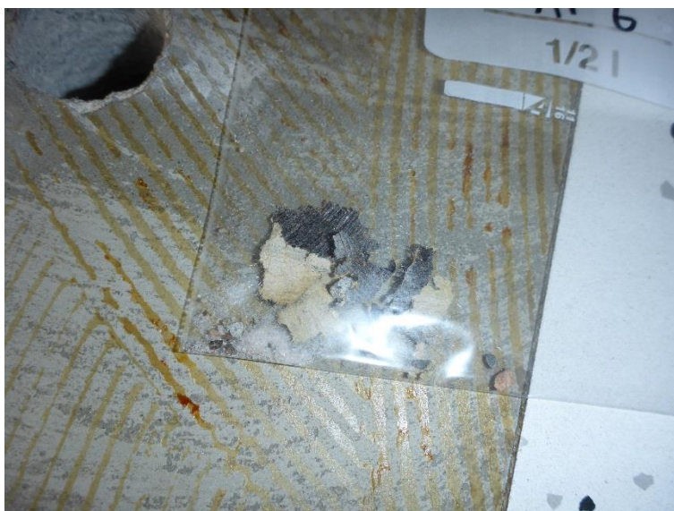
Kuva 37. Välipohjarakenteen pintalaatan alapuolella on askeläänieristeenä paperoitua mineraalivillaa.
