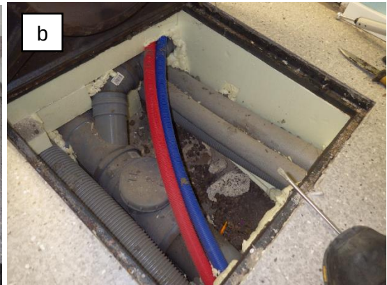
Kuvat 24 a...b. Liikuntasalin siivessä olevissa luukuissa havaittiin kevytsoraa, mursketta ja maa-ainesta. Molemmissa luukuissa ilmvirtaus oli luukkuun päin. Vanhoissa putkieristeissä havaittiin kosteuden aiheuttamia jälkiä. Tarkastusluukuissa ei ole tiivisteitä.
