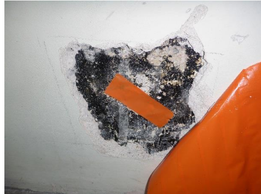
Kuva 9. Kellarikerroksen portaikon rakenneavaus RAK29.
