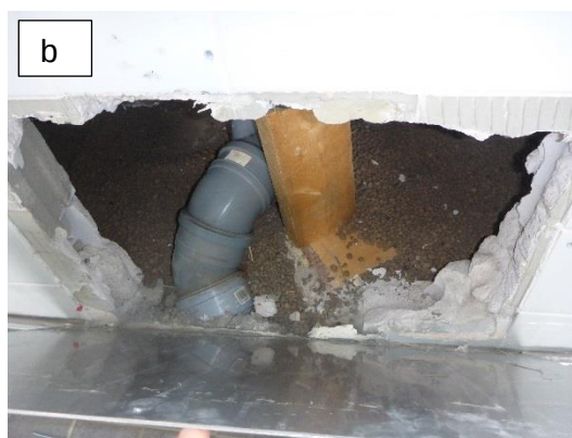
Kuva 27. Puutyöluokan alapohjarakenteen liittymä kynnyksen kohdalla. Pintalaatan ja kynnyksen (viereisen alapohjalaatan) väliin jää rako. Liittymää on tiivistetty elastisella massalla. Massan tartunta alustaansa on puutteellinen.
