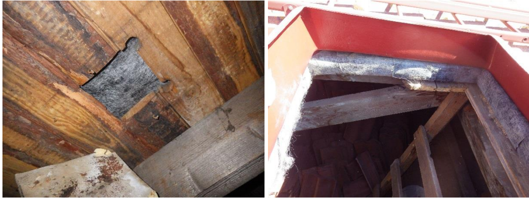
Kuva 54. Aluslaudoituksen päällä on aluskate ja liikuntasiiven kulkuluukun kohdalla aluskate on nostettu aluslaudoituksen päälle ja käännetty luukun kehysrakenteen alle.
