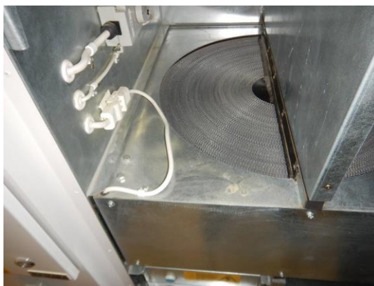
Kuva 89 a ja b. Tuloilmakammiossa ja äänenvaimentimessa on pölyä.
