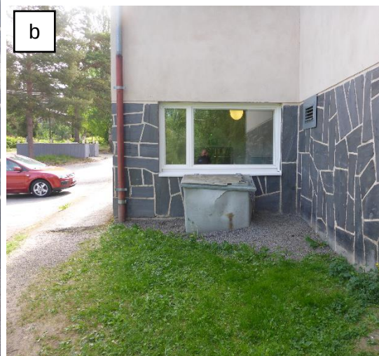
Kuvat 4 a...b. Sadevedet johdetaan vesikatolta syöksytorvilla sadevesiviemäriin. Erillisiä loiskekuppeja ei ole. Syöksytorvet on jatkettu maanpinnan alle ns. kiinteänä asennuksena.
