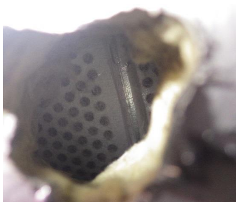
Kuva 92 a ja b. Äänenvaimentimeen tehtiin reikä luokassa 006. Vaimennusmateriaalina on mineraalivillaa, jonka reikäpellistä vastaan oleva pinta on suojattu harsokankaalla.
