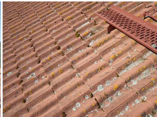
Kuva 58. Tiilikatteessa on hieman jäkälä- ja sammalkasvustoa. Vaurioituneita tiiliä ei havaittu.
