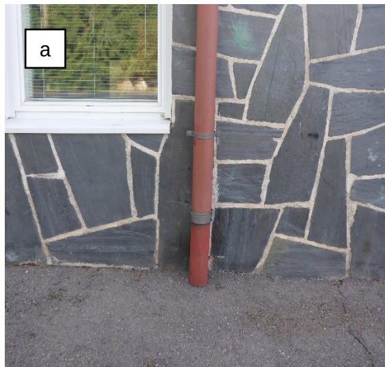
Kuvat 4 a...b. Sadevedet johdetaan vesikatolta syöksytorvilla sadevesiviemäriin. Erillisiä loiskekuppeja ei ole. Syöksytorvet on jatkettu maanpinnan alle ns. kiinteänä asennuksena.
