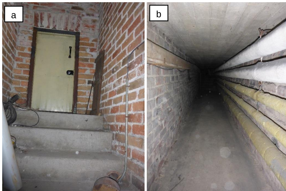
Kuvat 13 a...b. Yleiskuva polttoainevarastosta (a). Varastosta lähtee putkitunneli päiväkotirakennukseen. Varaston lattiassa esiintyy halkeilua. Varastossa aistittiin öljyn hajua. Huoltomieheltä saadun tiedon mukaan öljysäiliö on vuotanut öljyvuotokaukaloon ylitäytön vuoksi joitakin vuosia sitten.
