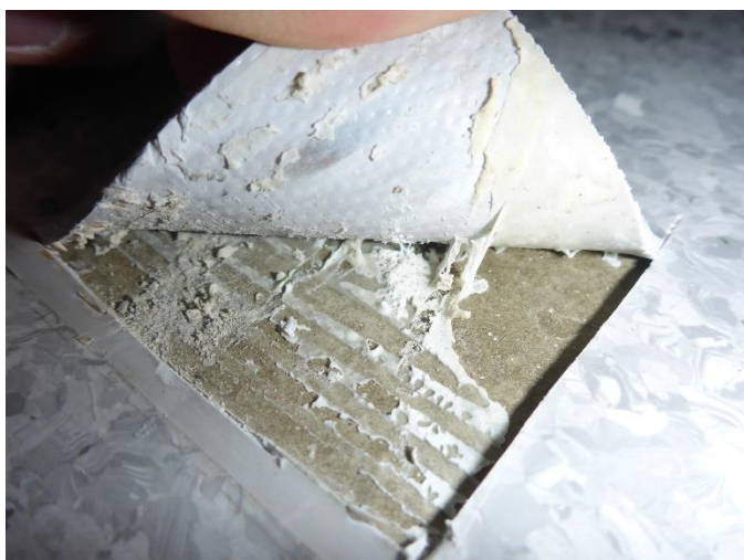
Kuva 33. V4, tila 012 Sos.tila/M, Viiltomittauksen tulos 51,9 %RH. Maton tartunta alustaansa tiukka, ei poikkeavaa hajua, murtopinta liimassa.
