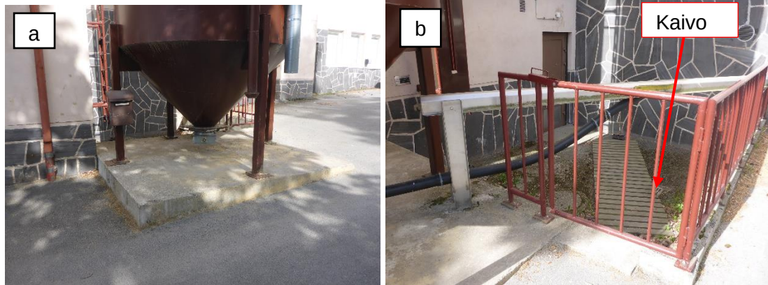
Kuvat 5 a...b. Rakennuksen pihalla on pellettisäiliö. Säiliön vieressä piha-alue on noin metrin muuta piha-aluetta matalammalla. Syvennyksessä on kaivo.
