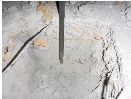
Kuva 46. Liikuntasiiven yläpohjarakenteen rakenneavaus RAK 26.
