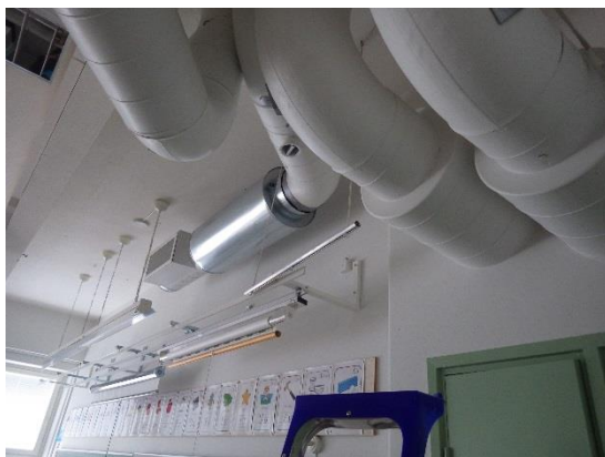
Kuva 91 a ja b. Luokkatilojen ilmanjako on toteutettu yleisimmin poistoilman osalta poistoilmasäleiköillä ja tuloilman osalta kattohajoittajilla.
