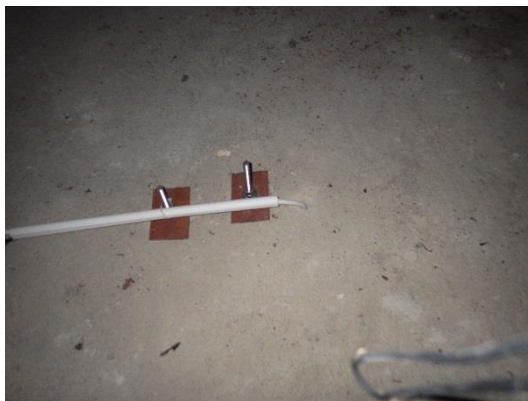
Kuva 53. Liikuntasalin tarvikkeita on pultattu yläpohjarakenteen läpi.
