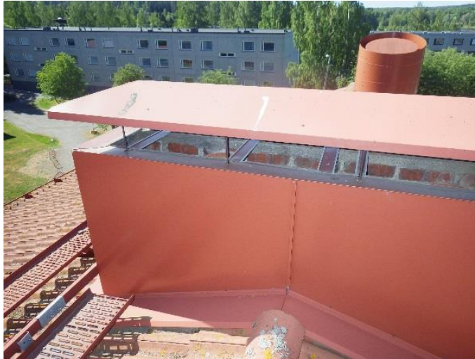
Kuva 61. Hormien pellityksissä ei havaittu puutteita.
