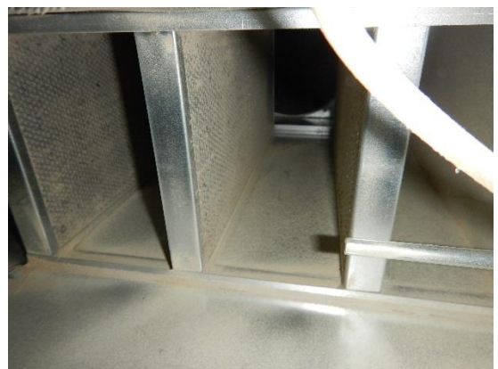
Kuva 89 a ja b. Tuloilmakammiossa ja äänenvaimentimessa on pölyä.
