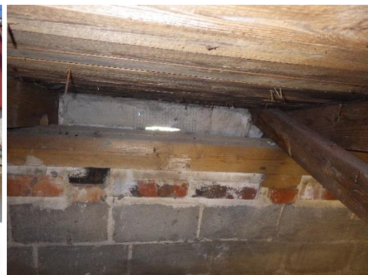
Kuva 63. Vesikaton tuuletus on järjestetty ulkoseinän yläosiin tehdyillä tuuletusaukoilla. Tuuletusaukkojen sisäpuolelle on asennettu pieneläinverkot.
