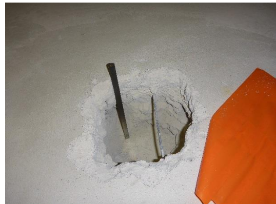
Kuva 45. Luokkasiiven yläpohjarakenteen rakenneavaus RAK 25.
