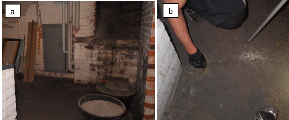
Kuvat 13 a...b. Yleiskuva polttoainevarastosta (a). Varastosta lähtee putkitunneli päiväkotirakennukseen. Varaston lattiassa esiintyy halkeilua. Varastossa aistittiin öljyn hajua. Huoltomieheltä saadun tiedon mukaan öljysäiliö on vuotanut öljyvuotokaukaloon ylitäytön vuoksi joitakin vuosia sitten.
