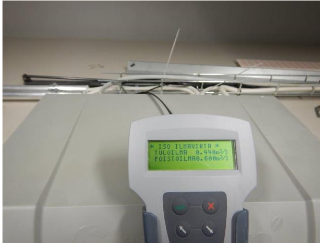
Kuva 83. Tulo- ja poistoilmakoneen käyttösäädin.
