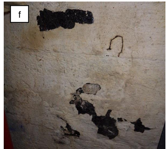
Kuvat 17 a...f. Kellarin portaikossa ja varastossa havaittiin pinnoitevaurioita ja kohonneita pintakosteuslukemia. Kuvassa f on havaittavissa maalipinnoitteen ja tasoitteen takana bitumisivelyvedeneriste. Bitumisively on paikoin irti alustastaan.
