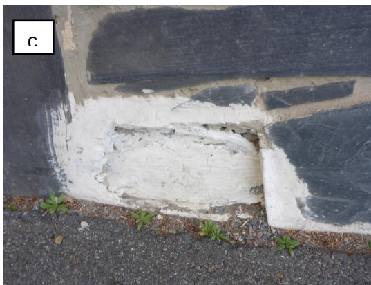
Kuvat 44 a...d. Rakennuksen sokkelissa havaittiin irronneita laattoja.
