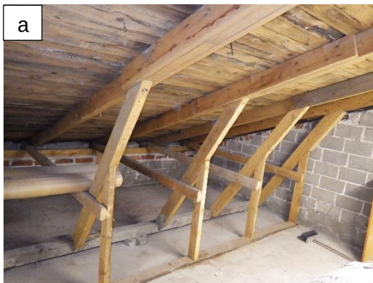
Kuvat 49a ja b. Luokkasiiven kantavia kattorakenteita on paikoin uusittu ja tuettu vanerilevyillä.
