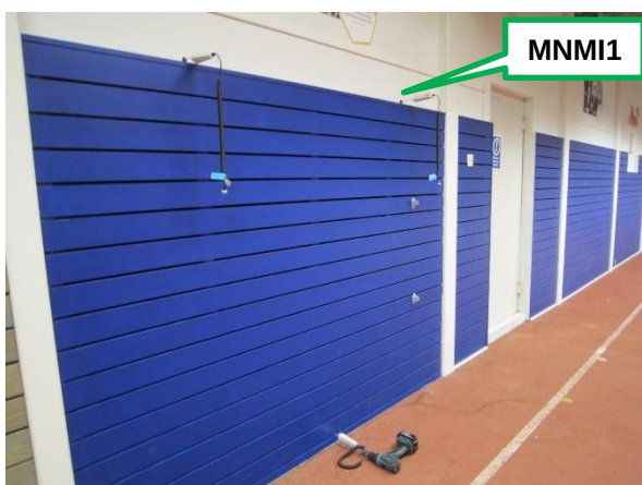
Kuva 11. Mittapistet 2, 3 ja 4 juoksusuoran ulkoseinässä n. 45 metrin kohdilla. Ovi johtaa IV-konehuoneeseen. Mikrobinäytteen MNMI1 ottokohta.
