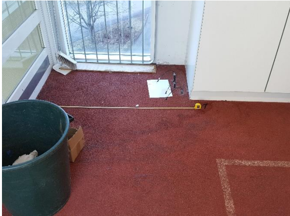
Kuva 15. Juoksusuoran välipohjarakenteen kosteusmittauspiste 14.
