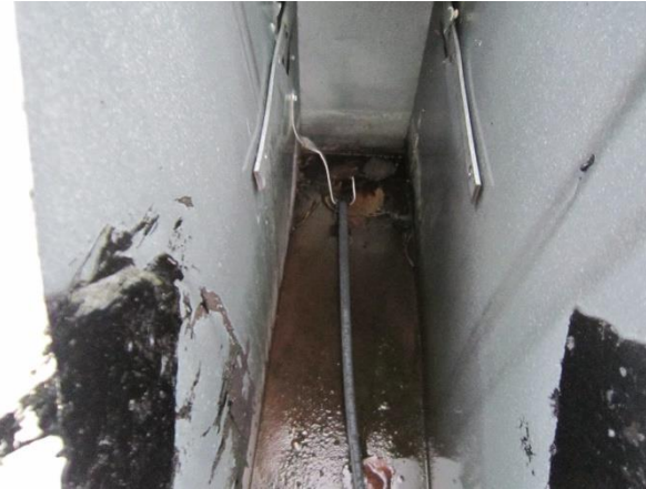
Kuva 17. Kitakaivot ovat huonokuntoisia. Niitä on yritetty korjata massaamalla.
