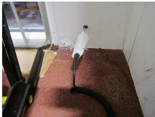
Kuva 10. Ikkunaseinän rakennekosteusmittaus juoksusuoralla.
