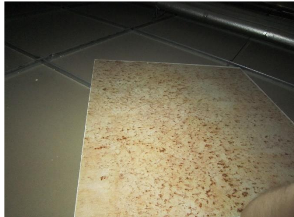
Kuva 6. Kosteusvaurioitunut alakattolevy.
