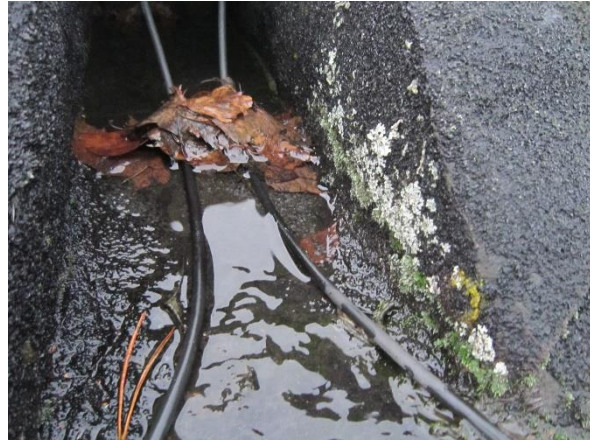
Kuva 18. Kaivoihin kertyy roskaa ja niiden puhdistaminen ja kunnossapito on vaikeaa.
