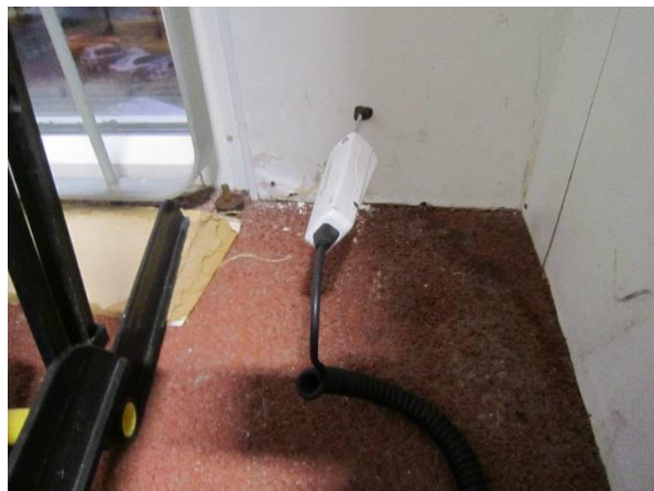
Kuva 4. Ulkoseinän rakennekosteuden mittaus juoksusuoran alkupäässä.
