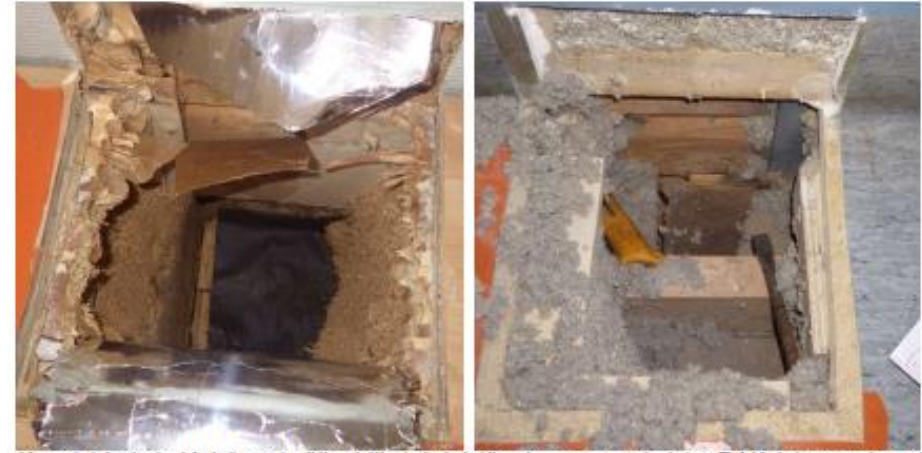
Kuvat 14a ja b. Valokuvat välipohjiin tehdyistä rakenneavauksista. RAK 1 (vasen kuva) tehtiin ylemmän välipohjaan tilan 205 lattiaan. Välipohjatäyttönä on sahanpurua ja kutterilastua. Avauksesta ei havaittu poikkeavaa hajua. Kutterilastusta otetussa materiaalinäytteessä havaittiin epäily mikrobikasvusta. RAK4 (oikea kuva) tehtiin alemmaan välipohjaan tilan 112 lattiaan. Tutkimushetkellä avauksesta kävi voimakas ilmavirtaus sisäilmaan päin. Avauksesta ei havaittu poikkeavaa hajua. Välipohjatäyttönä on puukuitueriste.
