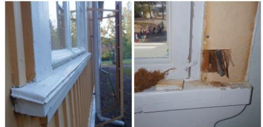
Kuvat 17a ja b. Ikkunat ja ikkunapellitykset ovat ulkopuolelta hyväkuntoiset. Sisäpuite on uusittu lämpölasilliseen. Ikkunakarmien ja apukarmien väli on tilkitty pellavaeristeellä. Tilkemateriaalissa havaittiin kyseiselle materiaalille ominainen haju/tuoksu. Tutkimus- hetkellä tilkeraosta ei havaittu merkittävää ilmavirtausta.
