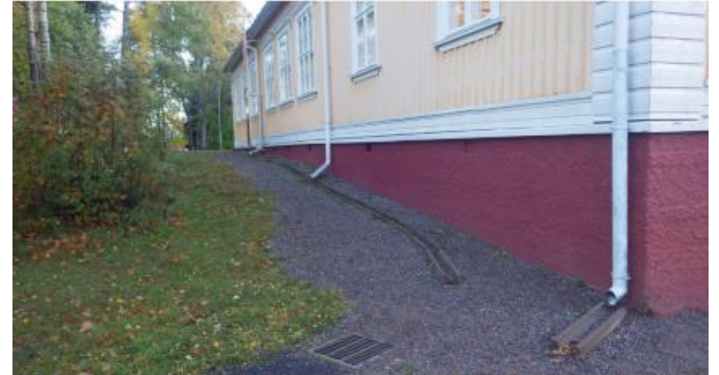
Kuva 3. Länsisivulla rakennuksen vierustalla pintakerroksena on hienoa soraa. Rakennuksen seinustalla on betonikouru, joka ohjaa kattovedet sadevesikaivon suuntaan.
