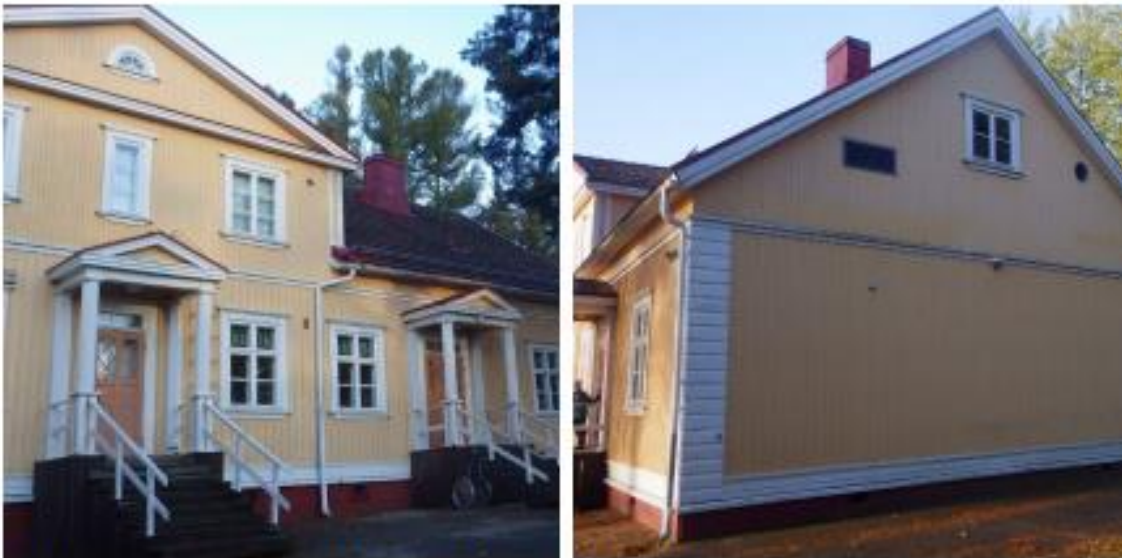
Kuvat 15a ja b. Julkisivut ovat yleisilmeeltään hyväkuntoisia.
