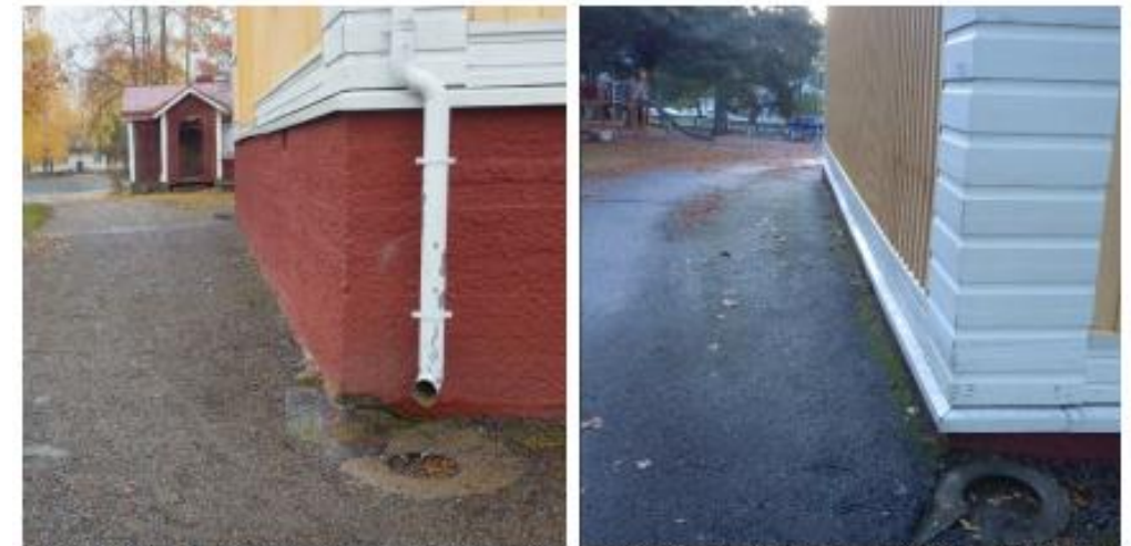
Kuvat 4a ja b. Rakennuksen pohjoispäässä sokkelin korkeus on noin 100...120 cm ja rakennuksen eteläpäässä noin 10...20 cm. Rakennuksen päissä maanpinta seinän vierustoilla on varsin tasainen.
