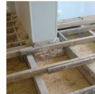
Kuvat 19a ja b. Tilaaajan toimittamia valokuvia välipohjan korjauksista vuodelta 2014. Kuvat ovat 2. kerroksesta. Kuvissa näkyvät palkit ovat puurakenteisia ja välipohjatyötä on asennettu puhallettu puukuitueriste. Vasemmassa kuvassa hyvin näkyvien korokerimien päälle on asennettu havuvaneri, tasoitekerros ja muovimatto.
