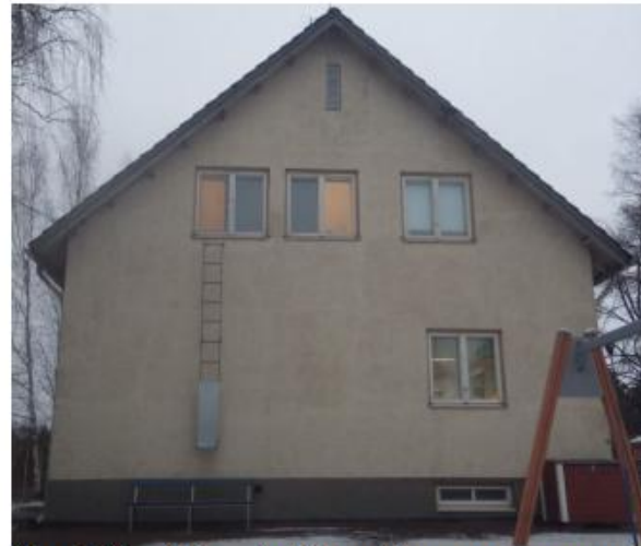
Kuvat 29a, b ja c. Julkisivupintana on rappaus, ja sokkeli on maalattua betonia. Julkisivut ja sokkeli ovat aistinvaraisesti arvioituna hyväkuntoisia eikä niissä havaittu sisäilman laadun kannalta merkittäviä kosteusteknisiä puutteita.
