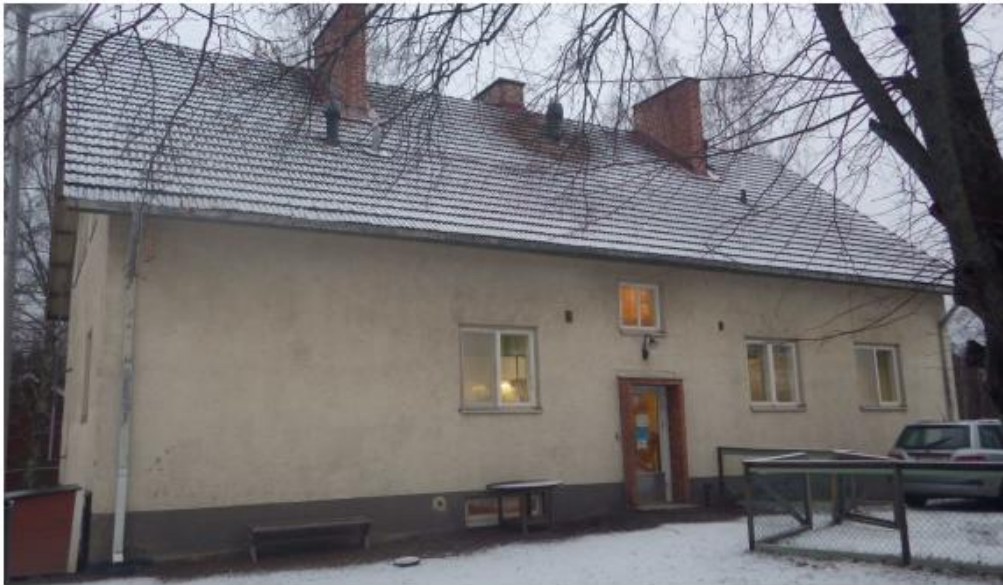
Kuvat 29a, b ja c. Julkisivupintana on rappaus, ja sokkeli on maalattua betonia. Julkisivut ja sokkeli ovat aistinvaraisesti arvioituna hyväkuntoisia eikä niissä havaittu sisäilman laadun kannalta merkittäviä kosteusteknisiä puutteita.
