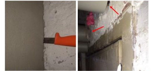
Kuvat 28a, b ja c. Yläkuvassa ja vasemmassa alakuvassa öljysäiliötilan ja viereisen varaston välinen seinä, jonka havaittiin olevan epätiivis erityisesti seinän liittymäkohdista. Oikeassa alakuvassa merkisavutarkastelua lämmönjakohuoneen oviraosta. Ilmavirtauksen suunta oli voimakkaasti likaisista tiloista muihin tiloihin päin. Lämmönjaksita epätiivitä läpivientejä viereisiin tiloihin
