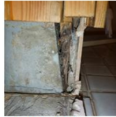
Kuvat 28a, b ja c. Yläkuvassa ja vasemmassa alakuvassa öljysäiliötilan ja viereisen varaston välinen seinä, jonka havaittiin olevan epätiivis erityisesti seinän liittymäkohdista. Oikeassa alakuvassa merkisavutarkastelua lämmönjakohuoneen oviraosta. Ilmavirtauksen suunta oli voimakkaasti likaisista tiloista muihin tiloihin päin. Lämmönjaksita epätiivitä läpivientejä viereisiin tiloihin
