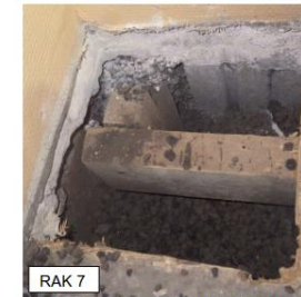
Kuvat 16a, b ja c. Valokuvia alemmaan välipohjaan tehdyistä rakennesaavauksista. Rakennesaavauksen tunnuksia on merkitty kuviin ja rakennesaavauksen sijainnit liitteen 1 pohjakuviin. Rakenteet vastasivat työmaa-aikaisia valokuvia. Rakennekerrokset on esitetty yksityiskohtaisesti aiemmassa kappaleessa. Rakennesaavauksista ei havaittu poikkeavia hajuja tai muita viitteitä vaurioista. Välipohjan yläpinnan pintarakenteet liittyvät epätiivisti ulko- ja väliseiniin.
