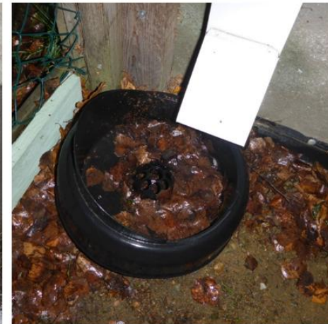
Kuvat 3a ja b. Kattovedet johdetaan rännikaivoihin. Rännikaivot on uusittu kaivotyy-pistä päätellen 2000-luvulla. Kaivot olivat osittain tukossa.
