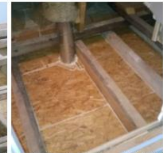
Kuvat 19a ja b. Tilaaajan toimittamia valokuvia välipohjan korjauksista vuodelta 2014. Kuvat ovat 2. kerroksesta. Kuvissa näkyvät palkit ovat puurakenteisia ja välipohjatyötä on asennettu puhallettu puukuitueriste. Vasemmassa kuvassa hyvin näkyvien korokerimien päälle on asennettu havuvaneri, tasoitekerros ja muovimatto.
