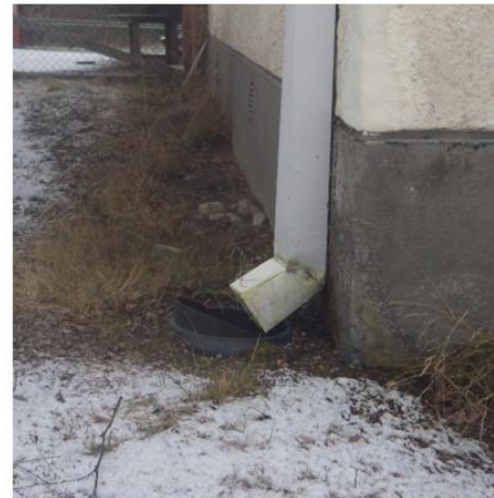
Kuvat 3a ja b. Kattovedet johdetaan rännikaivoihin. Rännikaivot on uusittu kaivotyy-pistä päätellen 2000-luvulla. Kaivot olivat osittain tukossa.
