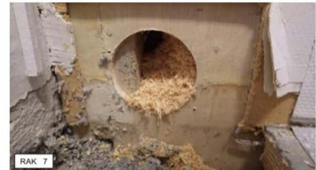
Kuva 31. Valokuva kylmään sivuvinttiin rajoittuvaan seinään tehdystä rakenneavauksesta RAK 7. Rakenneavauksesta ei havaittu poikkeavaa hajua tai muita viitteitä vaurioista. Ulkoseinärakenteessa ei ole erillistä höyryn- tai ilmansulkukerrosta.
