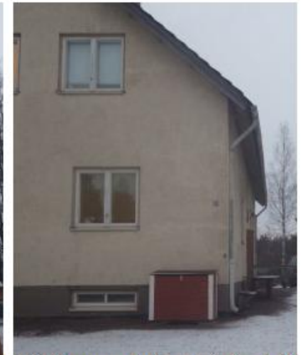
Kuvat 29a, b ja c. Julkisivupintana on rappaus, ja sokkeli on maalattua betonia. Julkisivut ja sokkeli ovat aistinvaraisesti arvioituna hyväkuntoisia eikä niissä havaittu sisäilman laadun kannalta merkittäviä kosteusteknisiä puutteita.
