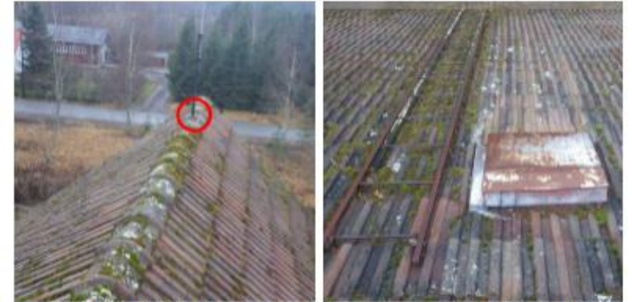
Kuvat 34 a ja b. Yleiskuvia vesikatolta. Kattomuotona on jyrkkä harjakatto. Vesikatteena oleva tiilikate on todennäköisesti alkuperäinen. Vesikatolla ei havaittu rikkoontuneita tiiliä. Kattotiilet ovat paikoin pahoin sammaloituneita. Vasempaan kuvaan on ympyröity antenniläpivienti, josta havaittiin aktiivinen vesivuoto ullakkotilaan.
