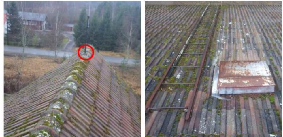
Kuvat 34 a ja b. Yleiskuvia vesikatolta. Kattomuotona on jyrkkä harjakatto. Vesikatteenä oleva tiilikate on todennäköisesti alkuperäinen. Vesikatolla ei havaittu rikkoontuneita tiiliä. Kattotiilet ovat paikoin pahoin sammaloituneita. Vasempaan kuvaan on ympyröity antenniläpivienti, josta havaittiin aktiivinen vesivuoto ullakkotilaan.
