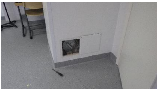
Kuva 52 a ja b. Luokkatilassa 203a kotelon sisällä oleva IV-kanavan läpivienti välipohjarakenteen läpi ei ole ilmatiivis. Välipohjan eriste on näkyvissä (merkitty kuvaan punaisella nuolella).
