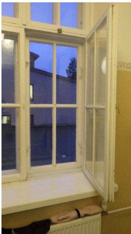
Kuva 28 a, b ja c. Esimerkkikuva vanhasta puuikkunasta ensimmäisen kerroksen aula-tilan (tila 102) kohdalla. Ikkunan sisäpuitteet ovat pääosin kohtalaisessa kunnossa.
