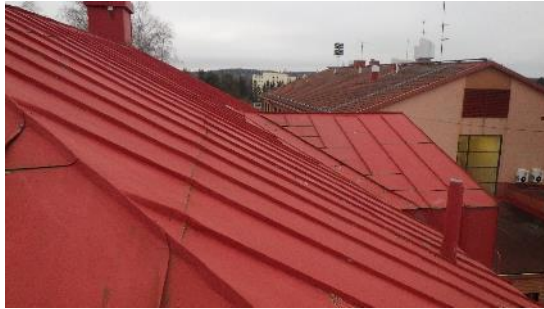
Kuva 55 a ja b. Vesikatteena on rivipeltikate, eli sileä saumattu peltikate. Peltikate on toteutettu palapelleistä, eli noin 2 metriä pitkistä paloista, jotka on saumattu pituus-suunnassa hakasaumalla. Peltikatteen maalipinta on pääosin ehjä, mutta monin paikoin maalipinta on irtoillut ja pelti on ruostunut.
