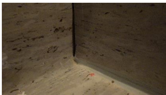
Kuva 21 a ja b. Inva-WC:n (tila 116) lattian muovimaton saumat ovat ylösnostojen kohdalla monin paikoin auki.
