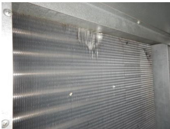
Kuva 79a ja b. Lämmityspatterissa on hieman kolhuja ja likaa. Kammiossa on irtoroskaa.
