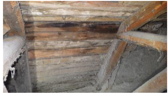
Kuva 59 a ja b. Vesikatteen aluslaudoituksessa ja puisissa runkorakenteissa on monin paikoin kosteusjälkiä ja puurakenteet ovat paikallisesti tummentuneet. Tummentuneet kohdat sijaitsevat pääosin peltikatteen sisä- ja ulkotaitteiden kohdilla, mutta paikallisesti tummentuneita kohtia on myös tasaisilla katto-osuuksilla.
