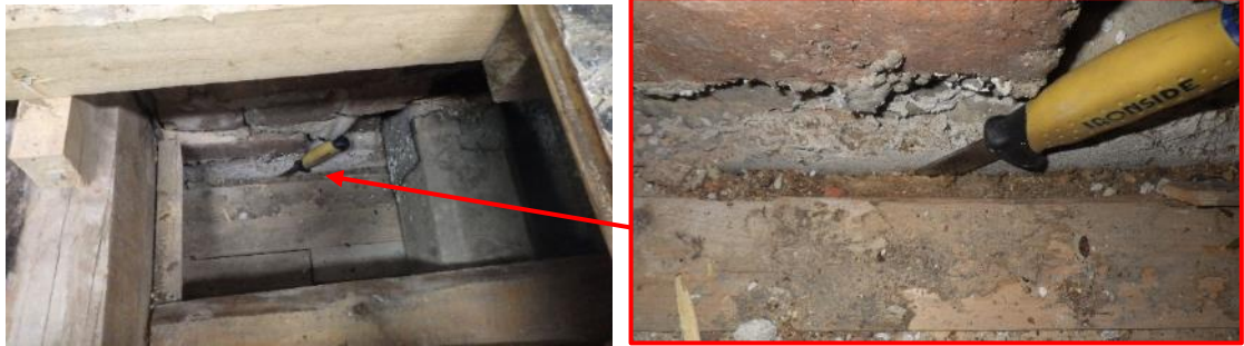
Kuva 45. Välipohjan alaosassa on sisäverhouspaneeli ja sen alla on huokoinen puukuitulevy. Paneelin ja ulkoseinän sekä puukuitulevyn ja seinän välissä on rako.
