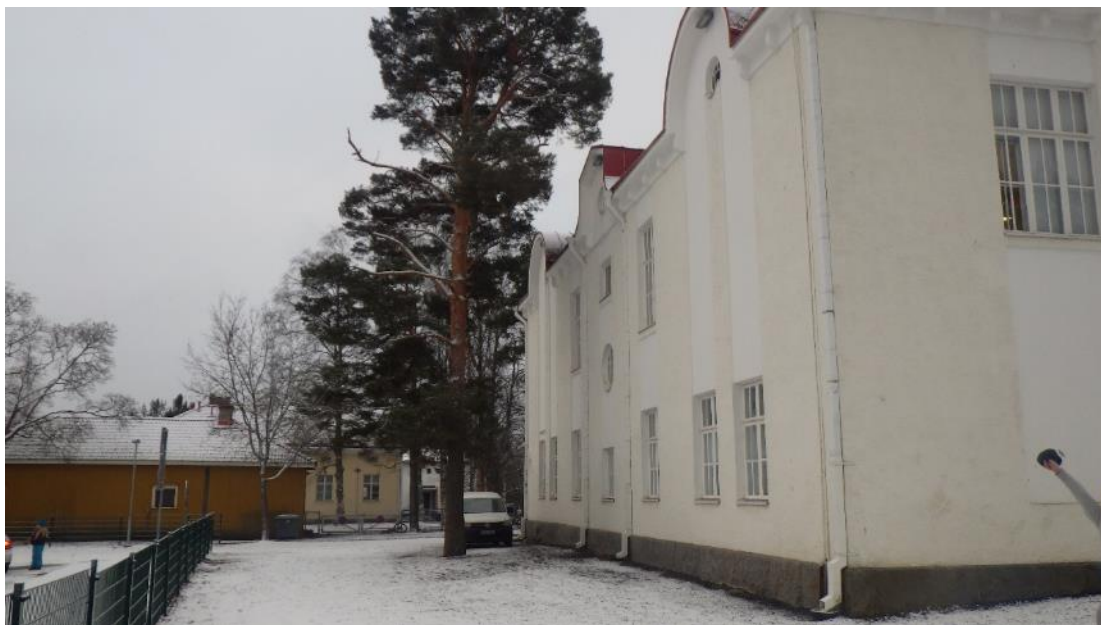
Kuva 3. Yleiskuva rakennuksen takapihan puolelta. Vesikaton sadevedet on ohjattu syöksytorvien ja rännikaivojen kautta sadevesien viemäröintijärjestelmään.
