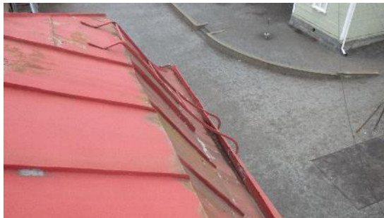
Kuva 57 a ja b. Kattotikkaat on jatkettu vesikatteen yläpuolelle. Tikkaat on kiinnitetty peltikatteen läpi. Kyseisellä kohdalla on aktiivinen vuotokohta (ks. Kuva 63 ja Kuva 64).
