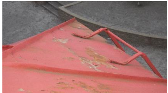
Kuva 57 a ja b. Kattotikkaat on jatkettu vesikatteen yläpuolelle. Tikkaat on kiinnitetty peltikatteen läpi. Kyseisellä kohdalla on aktiivinen vuotokohta (ks. Kuva 63 ja Kuva 64).
