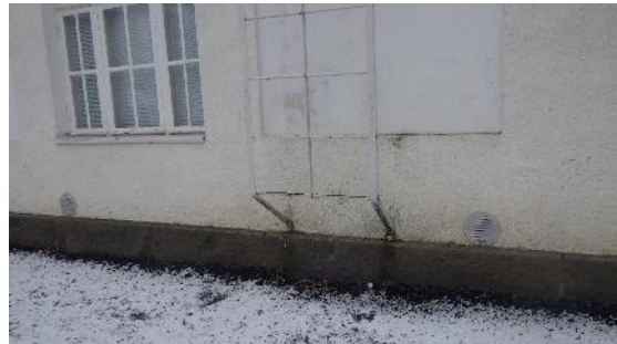
Kuva 12 a ja b. Alapohjan tuuletusputkien päässä olevat tuuletussäleiköt ulkoseinän pinnassa.
