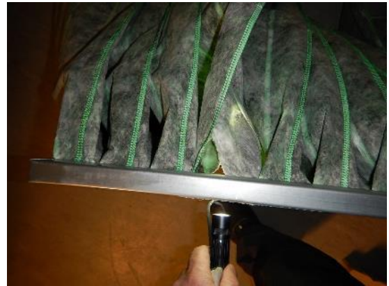
Kuva 74a ja b. Tuloilmasuodatin on melko likainen ja yksi pusseista on revennyt. Suodatusluokka on F7.
