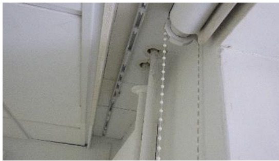
Kuva 46. Välipohjan alapuolella olevassa lääkärinhuoneessa (tila 113a) katon rajassa on verhokotelo.
