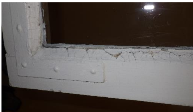
Kuva 28 a, b ja c. Esimerkkikuva vanhasta puuikkunasta ensimmäisen kerroksen aula-tilan (tila 102) kohdalla. Ikkunan sisäpuitteet ovat pääosin kohtalaisessa kunnossa.
