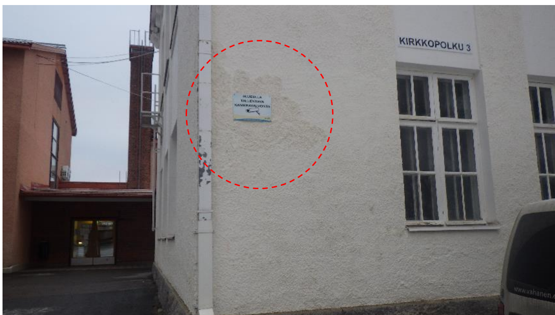
Kuva 36. Rakennuksen kaakon puoleisessa nurkassa rappaus on paikallisesti korjattu.
