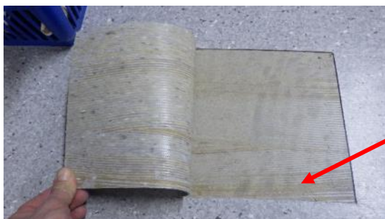
Kuva 14 a ja b. Musiikkiluokan (tila 103) lattian muovimattoon tehtiin 4 kpl noin 200 mm x 150 m kokoisia avauksia, joiden sijainnit on merkitty liitteenä olevaan pohjapiirustukseen merkinnällä MM1..MM4. a) Viiltomittauksen V5 kohdalle tehdyssä avauksessa MM1 muovimaton alta havaittiin poikkeava liimamainen haju. Mattoliima oli vaaleaa ja hieman tahmaista. Avauksen teon hetkellä viiltomittauksen kohdalta liima oli selvästi kuivunut / tummentunut (merkitty kuvaan). b) Muiden muovimaton avausten kohdalla haju oli vähäisempi. Esimerkkikuva avauksesta MM4, jossa ei havaittu
