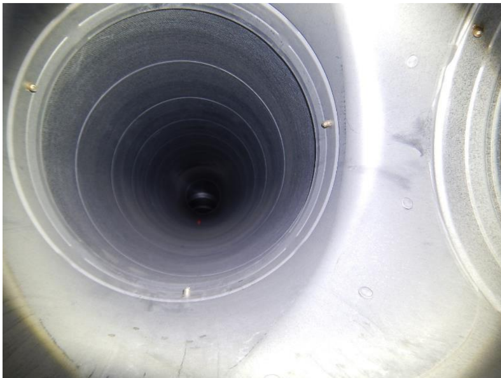
Kuva 96. Luokkatilan 103 tuloilmakanava on siisti, hieman pölyinen.
