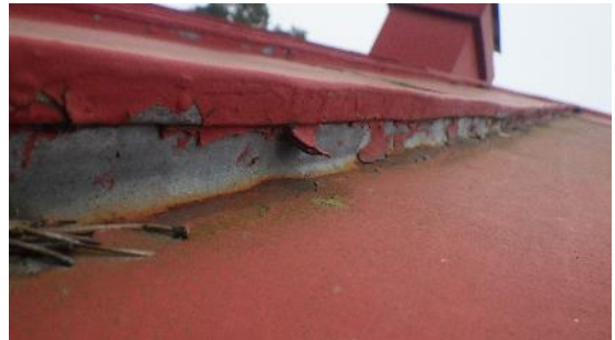
Kuva 56 a ja b. Peltikatteen hakasauma (kuva a) ja pystysauma (kuva b). Peltikatteen maalipinta on paikoin irtoillut ja peltikate on monin paikoin ruostunut.
