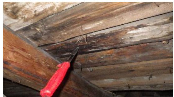
Kuva 60 a ja b. Pistokoeluontoisten kosteusmittausten perusteella osa tummentuneista kohdista on märkiä. Pääosin aluslaudoitus on aistinvaraisesti arvioiden lujaa. Yksittäisissä kohdissa havaittiin puurakenteissa pehmentymistä / lahoa.
