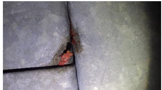
Kuva 61 a ja b. Peltikatteen saumojen kohdalla on kosteusjälkiä ja pellin pinta on paikallisesti märkä. Kuvan kohdassa on peltikatteessa reikä sauman kohdalla, josta näkyi läpi. Pääosin hakasaumat sijaitsevat aluslaudoituksen kohdalla.
