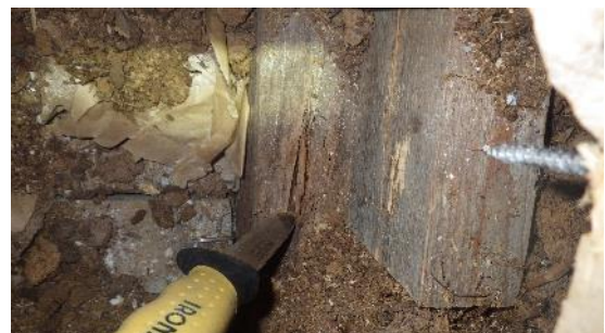
Kuva 48 a ja b. Varastotilaan 213 tehdyn rakenneavauksen RA2.1 kohdalla välipohjan kannatinpalkin yläpinnassa on lahoa. Kaikki rakenteet ovat aistinvaraisesti arvioiden
