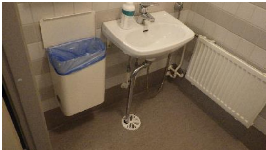
Kuva 20 a ja b. Esimerkkikuva WC-tilasta (aulan Wc-tila 118). WC-tilan vedeneristys on hyväkuntoinen. Vedeneristys ja muut pintarakenteet on asennettu rakennuksen peruskorjauksen yhteydessä vuonna 2000.
