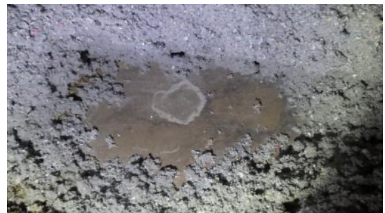
Kuva 62 a ja b. Puhallusvillan pinnassa on havaittavissa useissa kohdissa vesivuotojälkiä. Vesivuotojälkiä on pääosin puhallusvillakerroksessa sekä paikoin kovalevyn pinnassa. Alemmissa rakennekerroksissa (esim. laudoitus ja sahanpuru) vesivuotojälkiä
