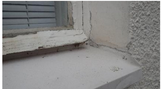
Kuva 38 a ja b. Vanhojen ikkunoiden sadevedentiiviys ja vedenohjaus ovat pääosin toimivia. Vanhojen ikkunoiden puisten ulko-osien kunto on pääosin tyydyttävä / välttävä. Puuosien maalipinnassa on laajasti halkeilua.
