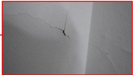
Kuva 26. Ulkoseinän sisäpinnassa halkeilua musiikkiluokan nurkassa (tila103). Pintakosteuskartoituksen mukaan seinäpinnassa ei havaittu poikkeavan korkeita pintakosteuslukemia.
