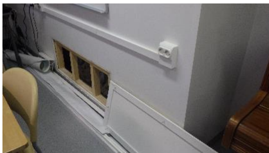
Kuva 53 a ja b. Luokkatilassa 203a kotelon sisällä olevat IV-kanavien läpiviennit on tiivistetty sementtipohjaisella massalla. Läpiviennit ovat aistinvaraisesti arvioiden tiiviit.
