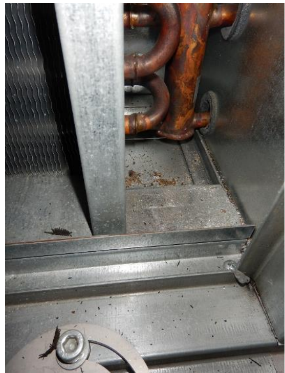
Kuva 79a ja b. Lämmityspatterissa on hieman kolhuja ja likaa. Kammiossa on irtoroskaa.
