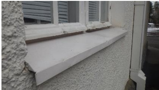
Kuva 38 a ja b. Vanhojen ikkunoiden sadevedentiiviys ja vedenohjaus ovat pääosin toimivia. Vanhojen ikkunoiden puisten ulko-osien kunto on pääosin tyydyttävä / välttävä. Puuosien maalipinnassa on laajasti halkeilua.
