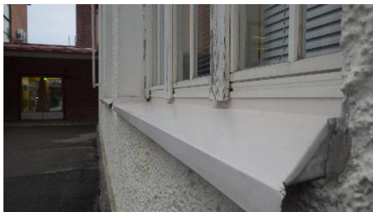
Kuva 40 a ja b. Etelän puolella olevan julkisivun uusittujen ikkunoiden ulkopuolen puuosien (esim. ikkunoiden välissä olevat puulistat) maalipinta on rapistunut ja kulunut. Ikkunan liitosten joustavalla massalla tehdyt tiivistykset ovat ikääntyneet. Joustava saumamassa on halkeillut ja irronnut paikoin vastepinnoistaan. Muilta osin uusittujen ikkunoiden vesitiiviydessä tai vedenpoistossa ei havaittu puutteita.
