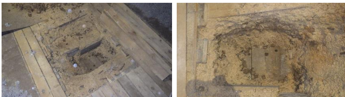
Kuva 67 a ja b. Rakenneavaus RA3.3 tehtiin kohtaan, jossa ei havaittu viitteitä vesivuodoista esim. vesivuotojälkiä puhallusvillan pinnassa (ns. vertailukohta). Rakenneavaus tehtiin vastaavalla tavalla kuin RA3.2 poistamalla puhallusvillaa ensin noin 6...8 m 2 kokoiselta alueelta. Rakenneavauksen kohdalla kaikki rakenteet kovalevyn alla ovat aistinvaraisesti arvioiden hyväkuntoisia ja kosteusmittausten mukaan kuivia (kosteus ≤10 paino-%), kuten rakenneavauksessa 3.2. Rakenneavauksesta otettiin materiaalinäyte turvekerroksen alapinnasta (MAT3.1) ja sahanpurukerroksen yläpinnasta (MAT3.2). Materiaalinäytteissä ei todettu mikrobikasvua.
