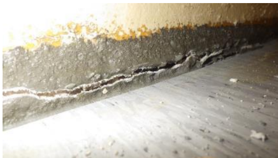
Kuva 11 a ja b. a) Muovisen jalkalistan takana lattia-seinäliittymässä on halkeama, josta on ilmayhteys maaperään. Liitoskohdan ilmatiiviyys on heikko / kohtalainen. b) Tilojen 113a ja 113b kohdalla alapohjassa on lähtötietojen mukaan painovoimaisesti toimiva tuuletus. Tuuletusputket nousevat alapohjasta ylös ulkoseinän vieressä ja menevät ulkoseinän läpi. Ulkoseinän ulkopuolella putkien kohdassa on tuuletussäleiköt (ks. Kuva 12). Läpiviennin kohdalla putket ovat joustavaa muoviputkea. Läpivienti ei ole ilmatiivis, vaan putken ja alapohjan betonilaatan sekä putken ja ulkoseinän tiilimuurauksen välissä on rako.
