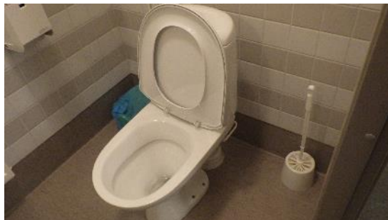
Kuva 20 a ja b. Esimerkkikuva WC-tilasta (aulan Wc-tila 118). WC-tilan vedeneristys on hyväkuntoinen. Vedeneristys ja muut pintarakenteet on asennettu rakennuksen peruskorjauksen yhteydessä vuonna 2000.
