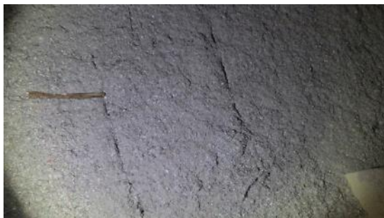
Kuva 62 a ja b. Puhallusvillan pinnassa on havaittavissa useissa kohdissa vesivuotojälkiä. Vesivuotojälkiä on pääosin puhallusvillakerroksessa sekä paikoin kovalevyn pinnassa. Alemmissa rakennekerroksissa (esim. laudoitus ja sahanpuru) vesivuotojälkiä
