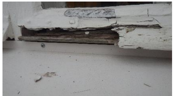
Kuva 39 a ja b. Paikoin vanhojen ikkunoiden ulkopuolen puuosissa on lahovaurioita.
