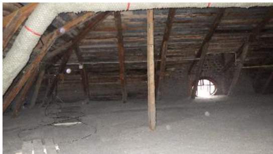
Kuva 58 a ja b. Yleiskuvat yläpohjan tuuletusvälistä. Tuuletusväli on avointa korkeaa tilaa. Yläpohjan tuuletus on järjestetty ikkunoiden kautta. Ikkunoiden laseista osa on korvattu verkoilla. Tuuletus on aistinvaraisesti arvioiden toimiva.
