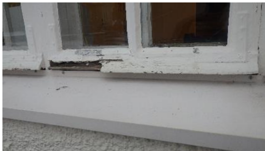
Kuva 39 a ja b. Paikoin vanhojen ikkunoiden ulkopuolen puuosissa on lahovaurioita.
