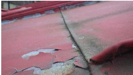
Kuva 56 a ja b. Peltikatteen hakasauma (kuva a) ja pystysauma (kuva b). Peltikatteen maalipinta on paikoin irtoillut ja peltikate on monin paikoin ruostunut.
