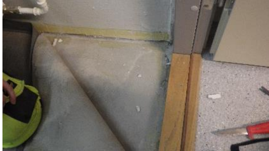
Kuva 9 a ja b. Rakenneavaus RA1.1 varastotilan 110 ja opettajien huoneen (tila 107) välisen oven kohdalla. Lattia-seinäliittymässä on merkittävän suuri rako (puukko työnnetty rakoon), josta on ilmayhteys maaperään.
