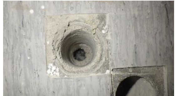
Kuva 10 a ja b. Yleiskuva rakenneavauksesta RA1.5 eteistilassa 113b. Alapohjan EPS-eristeen alla on noin 30 mm korkea ilmapäli. Rakenneavauksesta on voimakas ilmavirtaus sisätilaan päin. Rakenneavauksesta havaittiin vähäinen poikkeava maaperämäinen haju.
