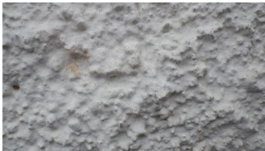
Kuva 33. Rappaus on pääosin ehjä ja rappauksen maalipinta on pääosin hyväkuntoinen.
