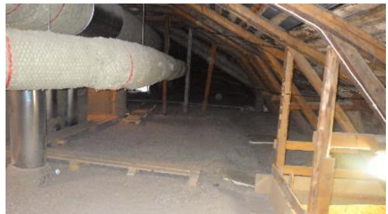
Kuva 58 a ja b. Yleiskuvat yläpohjan tuuletusvälistä. Tuuletusväli on avointa korkeaa tilaa. Yläpohjan tuuletus on järjestetty ikkunoiden kautta. Ikkunoiden laseista osa on korvattu verkoilla. Tuuletus on aistinvaraisesti arvioiden toimiva.
