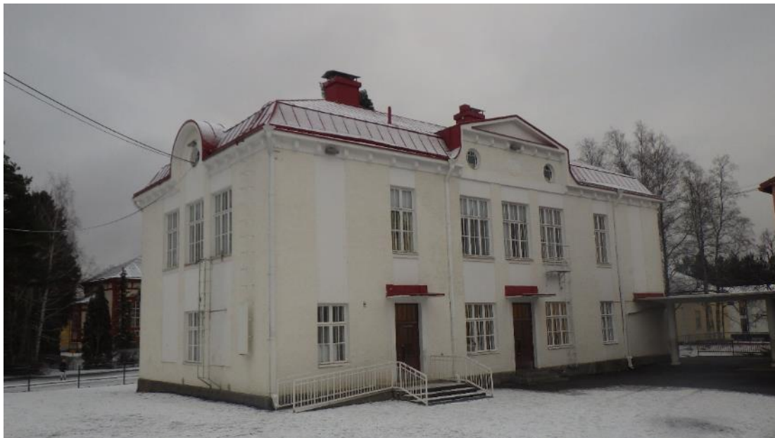
Kuva 2. Yleiskuva rakennuksesta etupihan puolelta. Rakennuksen vierellä pintavedenohjaus on toimiva, maanpinta kallistuu rakennuksesta poispäin kaikilla rakennuksen sivuilla. Etupihalla maanpinta on asfaltoitu. Muualla rakennuksen vieressä on sorapinta.
