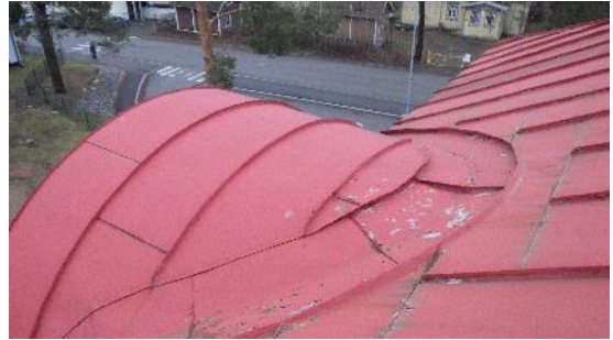
Kuva 55 a ja b. Vesikatteena on rivipeltikate, eli sileä saumattu peltikate. Peltikate on toteutettu palapelleistä, eli noin 2 metriä pitkistä paloista, jotka on saumattu pituus-suunnassa hakasaumalla. Peltikatteen maalipinta on pääosin ehjä, mutta monin paikoin maalipinta on irtoillut ja pelti on ruostunut.
