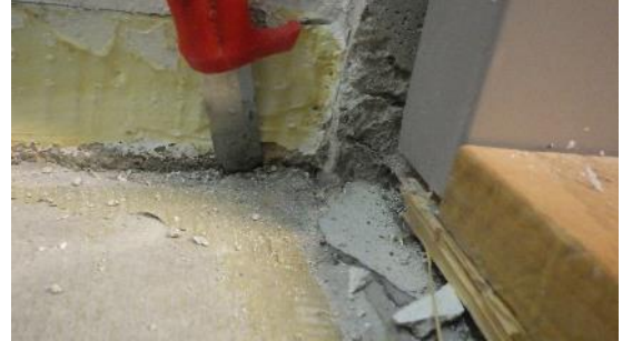
Kuva 9 a ja b. Rakenneavaus RA1.1 varastotilan 110 ja opettajien huoneen (tila 107) välisen oven kohdalla. Lattia-seinäliittymässä on merkittävän suuri rako (puukko työnnetty rakoon), josta on ilmayhteys maaperään.
