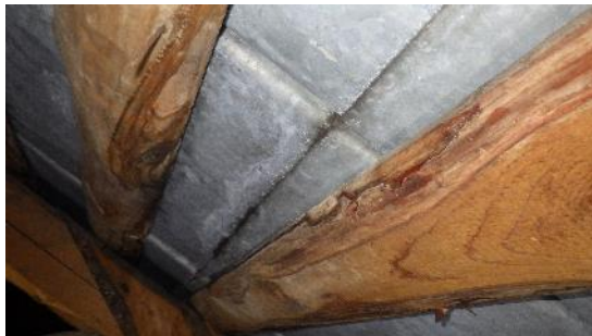
Kuva 61 a ja b. Peltikatteen saumojen kohdalla on kosteusjälkiä ja pellin pinta on paikallisesti märkä. Kuvan kohdassa on peltikatteessa reikä sauman kohdalla, josta näkyi läpi. Pääosin hakasaumat sijaitsevat aluslaudoituksen kohdalla.
