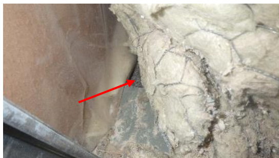
Kuva 52 a ja b. Luokkatilassa 203a kotelon sisällä oleva IV-kanavan läpivienti välipohjarakenteen läpi ei ole ilmatiivis. Välipohjan eriste on näkyvissä (merkitty kuvaan punaisella nuolella).
