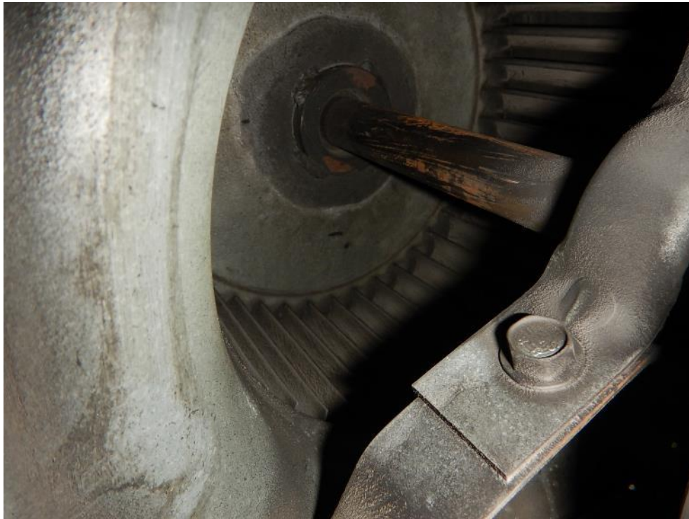
Kuva 90. Poistoilmapuhaltimessa on pinttynyttä pölyä.
