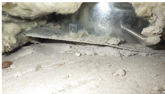
Kuva 53 a ja b. Luokkatilassa 203a kotelon sisällä olevat IV-kanavien läpiviennit on tiivistetty sementtipohjaisella massalla. Läpiviennit ovat aistinvaraisesti arvioiden tiiviit.
