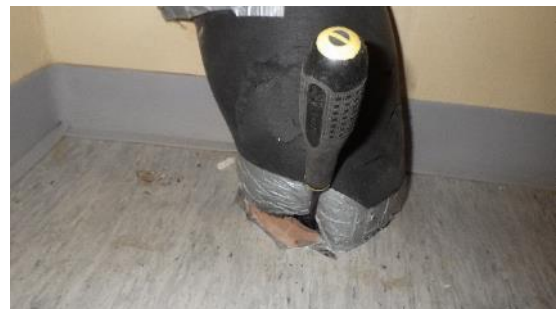
Kuva 11 a ja b. a) Muovisen jalkalistan takana lattia-seinäliittymässä on halkeama, josta on ilmayhteys maaperään. Liitoskohdan ilmatiiviyys on heikko / kohtalainen. b) Tilojen 113a ja 113b kohdalla alapohjassa on lähtötietojen mukaan painovoimaisesti toimiva tuuletus. Tuuletusputket nousevat alapohjasta ylös ulkoseinän vieressä ja menevät ulkoseinän läpi. Ulkoseinän ulkopuolella putkien kohdassa on tuuletussäleiköt (ks. Kuva 12). Läpiviennin kohdalla putket ovat joustavaa muoviputkea. Läpivienti ei ole ilmatiivis, vaan putken ja alapohjan betonilaatan sekä putken ja ulkoseinän tiilimuurauksen välissä on rako.
