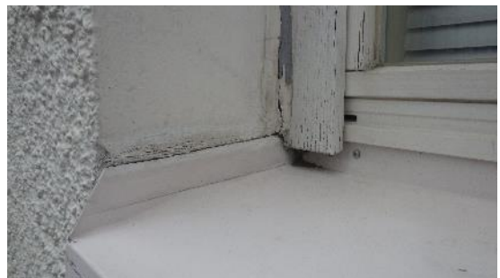
Kuva 40 a ja b. Etelän puolella olevan julkisivun uusittujen ikkunoiden ulkopuolen puuosien (esim. ikkunoiden välissä olevat puulistat) maalipinta on rapistunut ja kulunut. Ikkunan liitosten joustavalla massalla tehdyt tiivistykset ovat ikääntyneet. Joustava saumamassa on halkeillut ja irronnut paikoin vastepinnoistaan. Muilta osin uusittujen ikkunoiden vesitiiviydessä tai vedenpoistossa ei havaittu puutteita.
