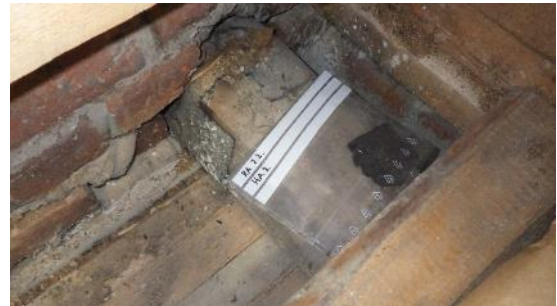
Kuva 47 a ja b. Välipohjan rakenneavauksesta RA2.2 otettiin kaksi materiaalinäytettä haitta-aine-analyysijä varten; lastulevyn alla oleva vinyylilaatta (sijainti on merkitty kuvaan punaisella nuolella) ja vinyylilaatan musta liima (yhdistelmänäyte HA1) sekä palkin päässä oleva bitumikermi (HA2). Analyysitulosten mukaan vinyylilaatta ja laatan musta liima sisältävät asbestia . Palkin päässä oleva bitumikermi ei sisällä asbestia, mutta bitumikermi sisältää runsaasti PAH-yhdisteitä . Laboratorion haitta-aineiden tutkimusseloste on liitteenä (liite 1).
