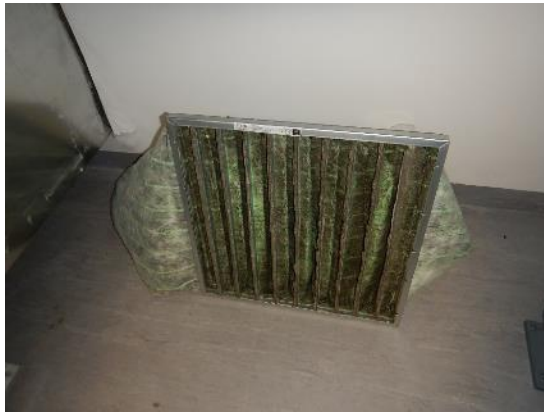
Kuva 74a ja b. Tuloilmasuodatin on melko likainen ja yksi pusseista on revennyt. Suodatusluokka on F7.
