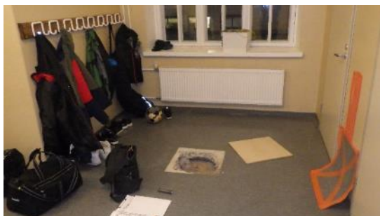
Kuva 5 a ja b. Rakenneavaus RA1.6 aulatilassa (tila 102). Rakenneavauksesta havaittiin voimakas maakellarimainen haju. Maa-aines on aistinvaraisesti arvioiden kuivaa (pölyävää) hienoa hiekkaa / silttiä.
