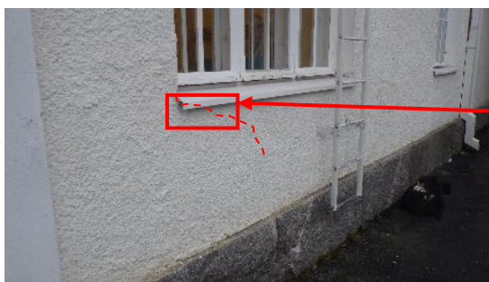
Kuva 34. Rappauksessa on paikoin halkeamia. Halkeamat sijaitsevat pääosin ikkunoiden kohdalla. Halkeamia havaittiin tarkastuksessa noin joka toisen ikkunan kohdalla.
