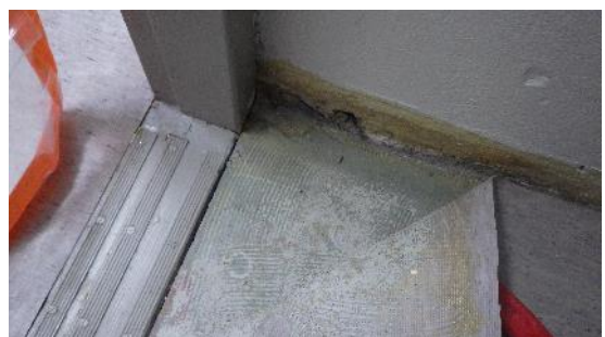
Kuva 41. Luokkatilaan 202 on rakennettu varastokomero vanhaan hormiin. Varastokomeroista havaittiin voimakas ilmavirtaus luokkatilaan päin ja poikkeava hieman nokiainen haju. Varastokomeron lattiarakenne ei ole ilmatiivis.
