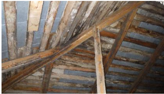
Kuva 59 a ja b. Vesikatteen aluslaudoituksessa ja puisissa runkorakenteissa on monin paikoin kosteusjälkiä ja puurakenteet ovat paikallisesti tummentuneet. Tummentuneet kohdat sijaitsevat pääosin peltikatteen sisä- ja ulkotaitteiden kohdilla, mutta paikallisesti tummentuneita kohtia on myös tasaisilla katto-osuuksilla.
