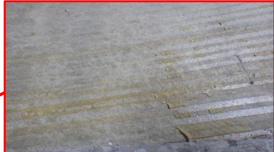
Kuva 14 a ja b. Musiikkiluokan (tila 103) lattian muovimattoon tehtiin 4 kpl noin 200 mm x 150 m kokoisia avauksia, joiden sijainnit on merkitty liitteenä olevaan pohjapiirustukseen merkinnällä MM1..MM4. a) Viiltomittauksen V5 kohdalle tehdyssä avauksessa MM1 muovimaton alta havaittiin poikkeava liimamainen haju. Mattoliima oli vaaleaa ja hieman tahmaista. Avauksen teon hetkellä viiltomittauksen kohdalta liima oli selvästi kuivunut / tummentunut (merkitty kuvaan). b) Muiden muovimaton avausten kohdalla haju oli vähäisempi. Esimerkkikuva avauksesta MM4, jossa ei havaittu
