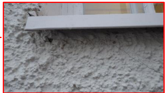
Kuva 34. Rappauksessa on paikoin halkeamia. Halkeamat sijaitsevat pääosin ikkunoiden kohdalla. Halkeamia havaittiin tarkastuksessa noin joka toisen ikkunan kohdalla.
