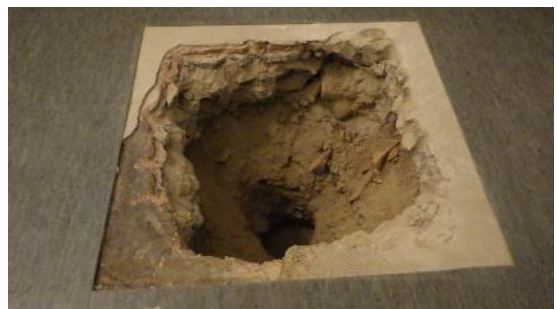
Kuva 5 a ja b. Rakenneavaus RA1.6 aulatilassa (tila 102). Rakenneavauksesta havaittiin voimakas maakellarimainen haju. Maa-aines on aistinvaraisesti arvioiden kuivaa (pölyävää) hienoa hiekkaa / silttiä.
