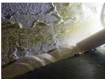
Kuvat 30 a....c. Alapohja-väliseinäliittymä on tiivistetty joustavalla massalla eteisaulan ja wc-tilojen 113 ja 114 välisen väliseinän kohdalla. Massaus on irronnut vastepinnastaan. Alapohja-väliseinäliittymästä havaittiin selvä ilmavirtaus sisäilmaan päin merkkisavun avulla tarkasteltuna.
