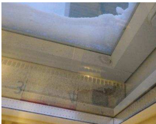
Kuvat 54 a ja b. Ensimmäisen kerroksen ikkunat ovat kolmilasisia, kaksipuitteisia puu-MSE-ikkunoita. Paikoin ikkunapuitteiden välissä havaittiin kosteusjälkiä (kuva a), ja paikoin ulomman lasin sisäpinnalla havaittiin tiivistynyttä kosteutta (kuva b).
