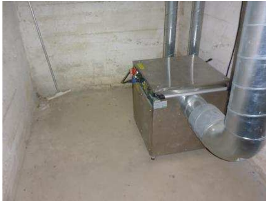
Kuvat 11 a ja b. Ryömintätilan kuivatus on järjestetty koneellisen kuivatusjärjestelmän avulla.
