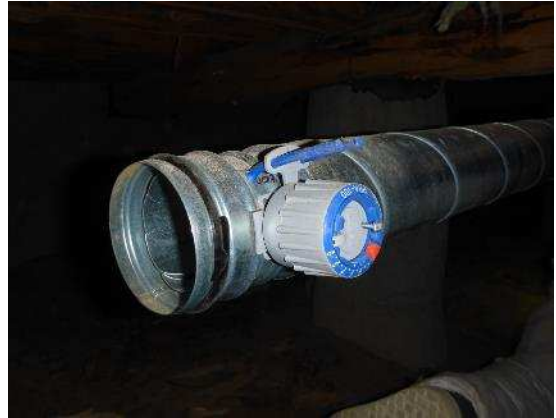
Kuvat 11 a ja b. Ryömintätilan kuivatus on järjestetty koneellisen kuivatusjärjestelmän avulla.
