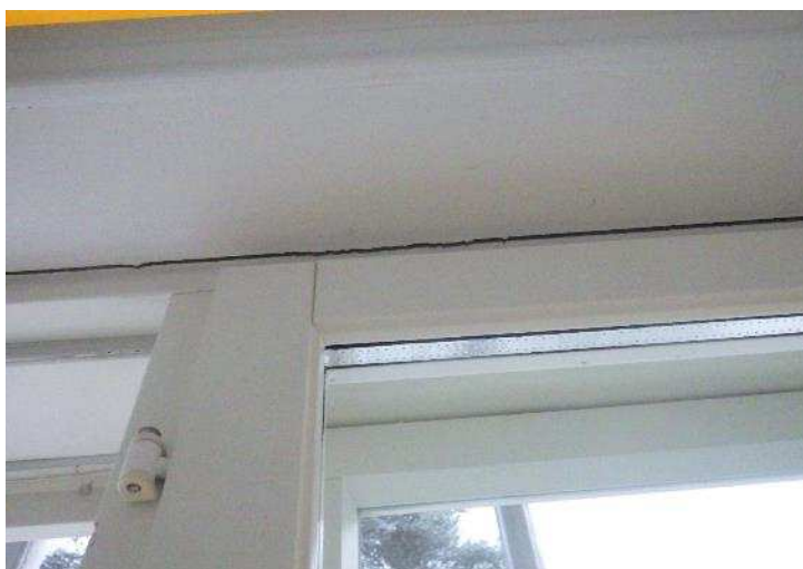
Kuvat 55 a ja b. Karmi-ulkoseinä-liittymässä havaittiin selviä rakoja. Raoista havaittiin ilmavirtauksia sisäilmaan päin merkkisavulla tarkasteltuna.
