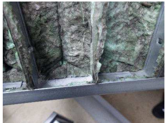
Kuva 78 a ja b. Tuloilmasuodatin on kohtalaisen likainen ja siellä on lunta. Suodatusluokka on F7.
