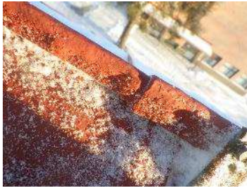
Kuvat 61 a ja b. Vesikatteessa on kaksinkertainen pystysauma, mutta ei tiivistysmassaa.
