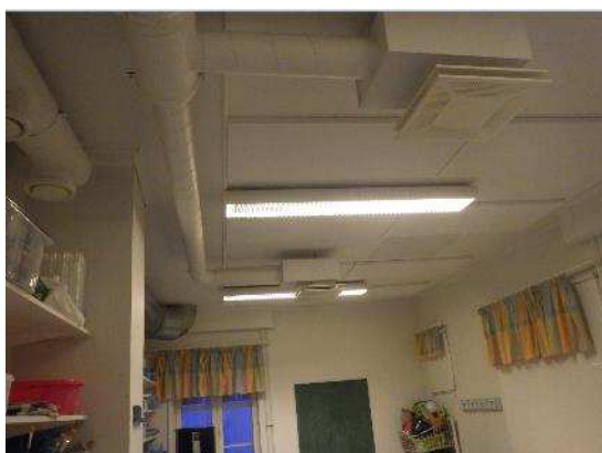
Kuvat 44 a ja b. Ensimmäisen ja toisen kerroksen välisen välipohjan alapinnassa on pääosin kipsilevytyt (kuva a), käytävätilassa on alaslaskettu katto (kuva b). Käyttötilojen kattopinnat ovat siistikuntoisia.
