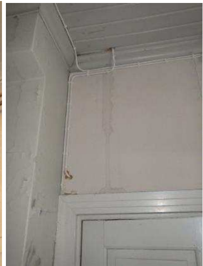
Kuvat 69 a...e. Rakennuksen matalampien osien päädyissä on mm. varastokäytössä olleita kylmiä tiloja. Kuvat ovat tilasta 217. Tiloissa on runsaasti rakennus- ja muuta jätettä sekä sekalaista tavaraa. Pinnoilla on laaja-alaisesti kosteusjälkiä. Matalampien osien vesikaton alapuolinen tila/ullakkotila tuulettuu räystäältä.
