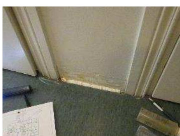
Kuvat 30 a....c. Alapohja-väliseinäliittymä on tiivistetty joustavalla massalla eteisaulan ja wc-tilojen 113 ja 114 välisen väliseinän kohdalla. Massaus on irronnut vastepinnastaan. Alapohja-väliseinäliittymästä havaittiin selvä ilmavirtaus sisäilmaan päin merkkisavun avulla tarkasteltuna.
