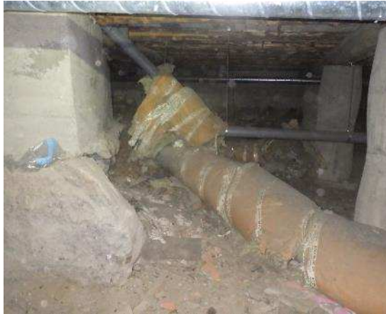
Kuvat 17 a ja b. Viemäriputkien läpiviennit on tiivistetty mineraalivillalla ryömintätilasta käsin, tiivistysten ilmatiiveydessä on puutteita. Viemäriputkia ei ole lämmöneristetty.
