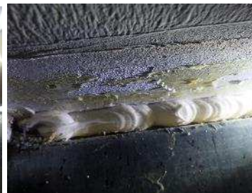
Kuvat 30 a....c. Alapohja-väliseinäliittymä on tiivistetty joustavalla massalla eteisaulan ja wc-tilojen 113 ja 114 välisen väliseinän kohdalla. Massaus on irronnut vastepinnastaan. Alapohja-väliseinäliittymästä havaittiin selvä ilmavirtaus sisäilmaan päin merkkisavun avulla tarkasteltuna.
