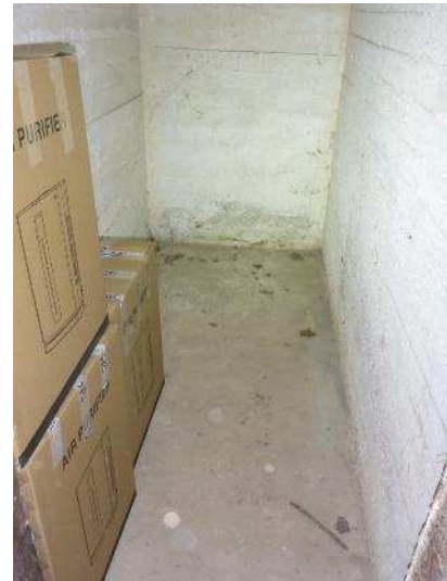
Kuvat 18 a ja b. Kellarin lattia on maanvastainen betonilaatta, lattiapintana on paljas betonipinta. Kellaritilat ovat tyhjiillään, isoimmassa kellaritilassa sijaitsee ryömintätilan kuivainlaitteisto.
