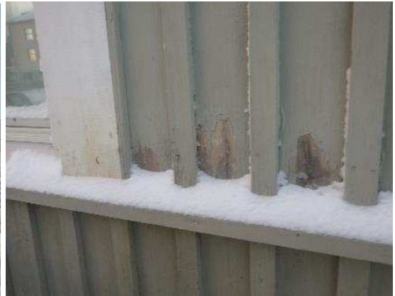
Kuvat 47 a...c. Julkisivulaudoituksen maalipinta on pääosin tyydyttävässä kunnossa. Paikoin maalipinta hilseilee ja lohkeilee voimakkaasti.
