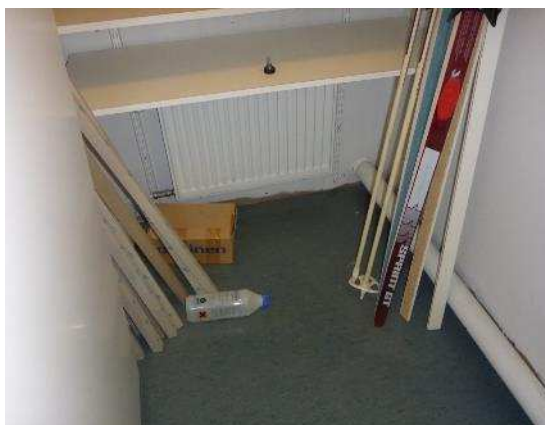
Kuvat 28 a ja b. Sähköpääkeskuksessa (pohjakuvassa osa tilasta 102) alapohja-väliseinäliittymää ei ole tiivistetty kauttaaltaan.
