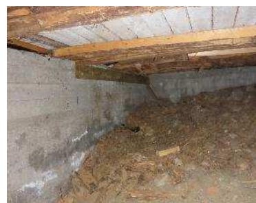
Kuvat 10 a...a. Yleiskuvia ryömintätilasta. Ryömintätilan korkeus vaihteli ~300mm ...~1500 mm, matalimmillaan ryömintätila on Meijerintien puoleisella seinustalla, kellaritilan molemmin puolin. Ryömintätilan pohjan hiekka oli pintaosistaan aistinvaraisesti arvioituna kuivaa. Ryömintätilan ilma oli aistinvaraisesti arvioituna (ryömintätilan il-maksi) hyvälaatuista: Ilma oli pölyistä, mutta poikkeavaa (kostea, tunkkaista, mikrobi-peräistä) hajua ei havaittu.
