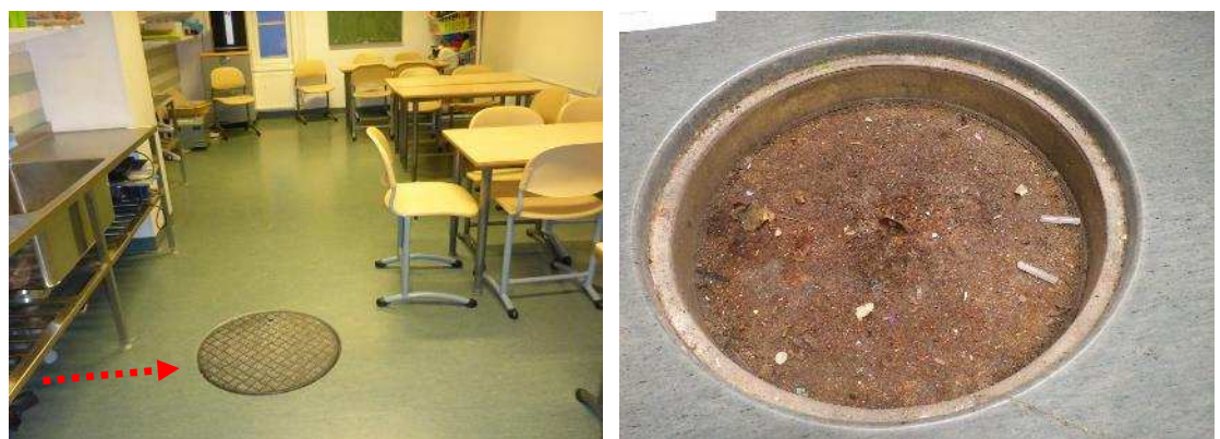
Kuvat 20 a...c. Wc-tiloissa sekä tilassa 111 muovimatot on nostettu seinälinjoille ~100 mm korkeudelle. Kynnysten kohdalla pystypinnalle nostoa ei ole. Muovimatto on kiristetty lattiakaivojen kiristysrenkaan väliin. Käsienpesualtaan viemäriputki on johdettu lattiakaivoon.
