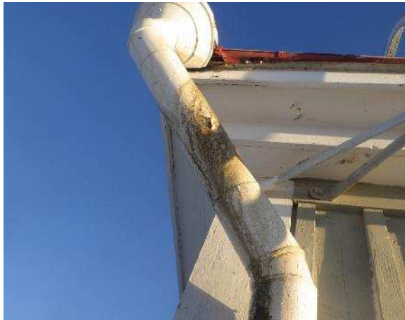
Kuvat 60 a ja b. Syöksytorvissa on korroosiovaurioita.
