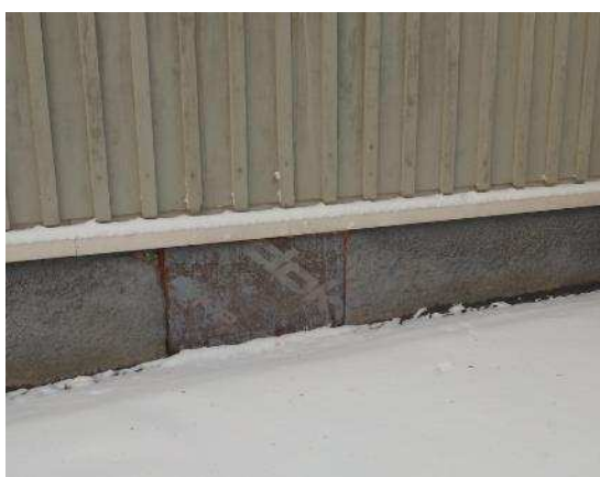
Kuvat 9 a...d. Sokkelin tuuletus- ja muita aukkoja on ummistettu mm. polyuretaanivaahdolla sekä levytyksellä ryömintätilan kuivainjärjestelmän asennuksen yhteydessä.
