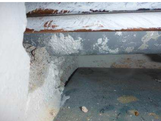
Kuvat 29 a ja b. Käsiinpesualtaan alapuolella oleva levyrakenne aukaistiin. Alapohja-väliseinäliittymää ei ole tiivistetty kotelon kohdalta.
