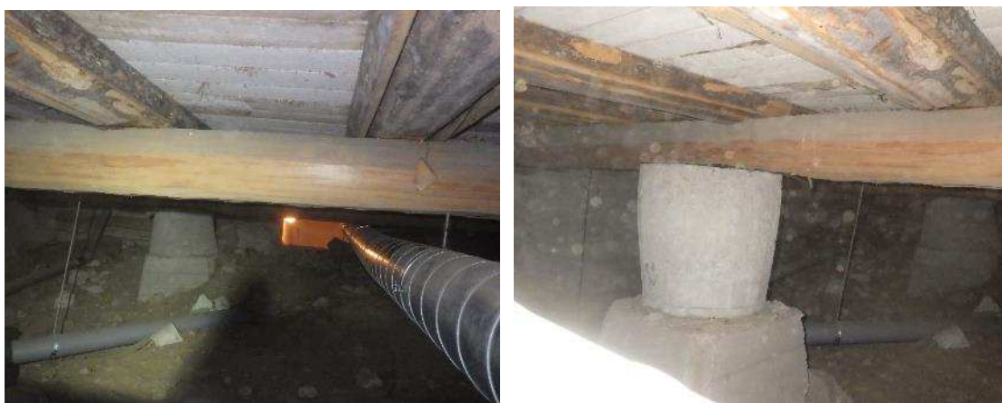
Kuvat 15 a ja b. Alapohjan kantavat rakenteet ja aluslaudoitus ovat kaikkialla siistikuntoisia. Viitteitä kosteusvaurioitumisesta (taipumia, pehmenemää, värimuutoksia) ei havaittu.
