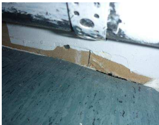
Kuvat 28 a ja b. Sähköpääkeskuksessa (pohjakuvassa osa tilasta 102) alapohja-väliseinäliittymää ei ole tiivistetty kauttaaltaan.
