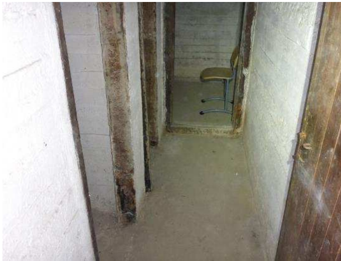
Kuvat 18 a ja b. Kellarin lattia on maanvastainen betonilaatta, lattiapintana on paljas betonipinta. Kellaritilat ovat tyhjiillään, isoimmassa kellaritilassa sijaitsee ryömintätilan kuivainlaitteisto.
