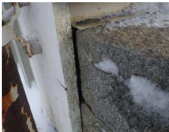
Kuvat 49 a ja b. Graniittiportaан ja seinän välisen liittymän vesitiiveys on puutteellinen.
