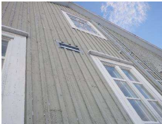
Kuvat 47 a...c. Julkisivulaudoituksen maalipinta on pääosin tyydyttävässä kunnossa. Paikoin maalipinta hilseilee ja lohkeilee voimakkaasti.
