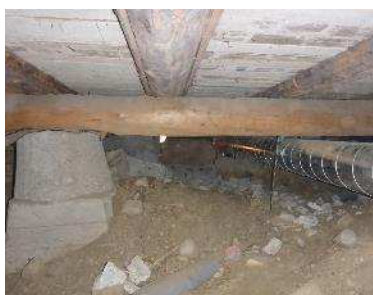
Kuvat 10 a...a. Yleiskuvia ryömintätilasta. Ryömintätilan korkeus vaihteli ~300mm ...~1500 mm, matalimmillaan ryömintätila on Meijerintien puoleisella seinustalla, kellaritilan molemmin puolin. Ryömintätilan pohjan hiekka oli pintaosistaan aistinvaraisesti arvioituna kuivaa. Ryömintätilan ilma oli aistinvaraisesti arvioituna (ryömintätilan il-maksi) hyvälaatuista: Ilma oli pölyistä, mutta poikkeavaa (kostea, tunkkaista, mikrobi-peräistä) hajua ei havaittu.
