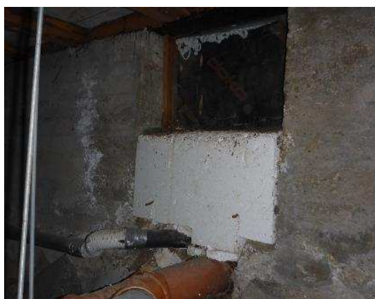
Kuvat 9 a...d. Sokkelin tuuletus- ja muita aukkoja on ummistettu mm. polyuretaanivaahdolla sekä levytyksellä ryömintätilan kuivainjärjestelmän asennuksen yhteydessä.
