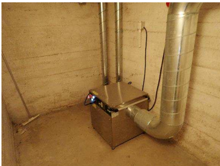
Kuva 86. DST sorptiokuivain kellaritilassa.
