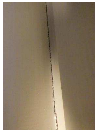
Kuvat 55 a ja b. Karmi-ulkoseinä-liittymässä havaittiin selviä rakoja. Raoista havaittiin ilmavirtauksia sisäilmaan päin merkkisavulla tarkasteltuna.
