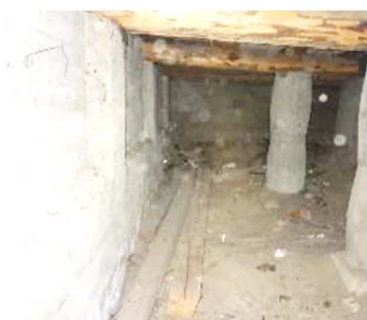
Kuvat 10 a...a. Yleiskuvia ryömintätilasta. Ryömintätilan korkeus vaihteli ~300mm ...~1500 mm, matalimmillaan ryömintätila on Meijerintien puoleisella seinustalla, kellaritilan molemmin puolin. Ryömintätilan pohjan hiekka oli pintaosistaan aistinvaraisesti arvioituna kuivaa. Ryömintätilan ilma oli aistinvaraisesti arvioituna (ryömintätilan il-maksi) hyvälaatuista: Ilma oli pölyistä, mutta poikkeavaa (kostea, tunkkaista, mikrobi-peräistä) hajua ei havaittu.
