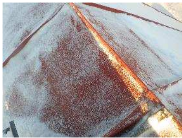
Kuvat 61 a ja b. Vesikatteessa on kaksinkertainen pystysauma, mutta ei tiivistysmassaa.
