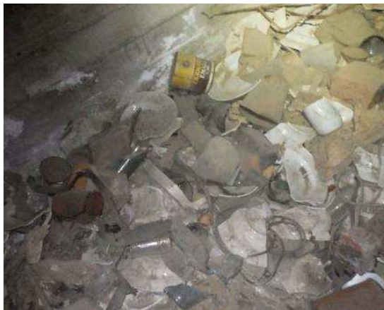
Kuvat 13 a ja b. Pääosin ryömintätila oli siisti. Ryömintätilassa on paikoitellen ylimääräistä materiaalia, mm. puumateriaalia sekä rikkiäisiä lasi- ja posliiniastioita.
