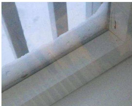
Kuvat 54 a ja b. Ensimmäisen kerroksen ikkunat ovat kolmilasisia, kaksipuitteisia puu-MSE-ikkunoita. Paikoin ikkunapuitteiden välissä havaittiin kosteusjälkiä (kuva a), ja paikoin ulomman lasin sisäpinnalla havaittiin tiivistynyttä kosteutta (kuva b).
