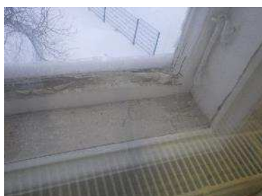
Kuvat 56 a...c. Toisen kerroksen ikkunat ovat pääosin alkuperäisiä. Alkuperäisten ikkunoiden karmirakenteet ja puitteet ovat huonokuntoiset. Yhden ikkunalasien havaittiin olevan rikki.
