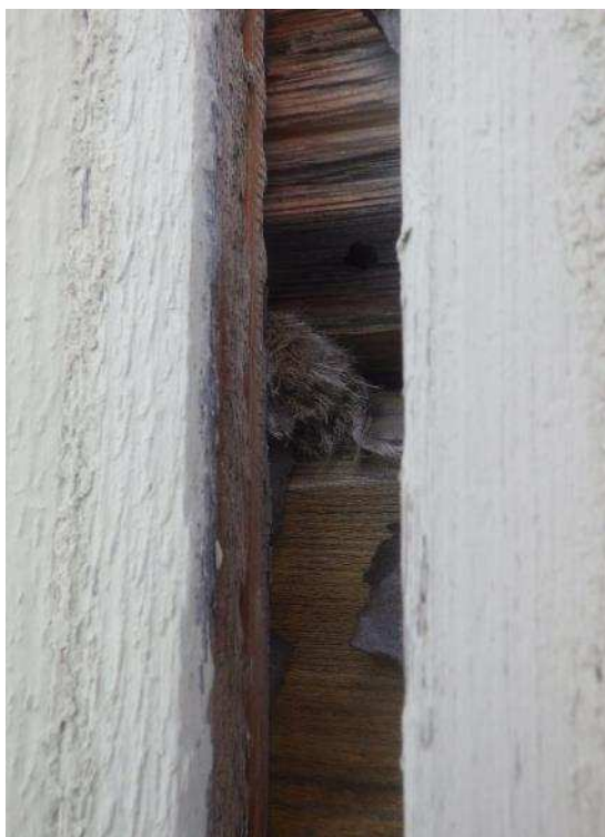
Kuva 48. Julkisivun rakenne tarkastettiin eteläpuoleisen päädyn julkisivulaudoituksessa olevan raon kautta. Julkisivulaudoitus on tiiviisti ulkoseinän hirsirunkoa vasten, välissä on tervapaperi. Hirsitilkkeenä on käytetty pellavarivettä.
