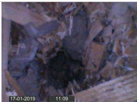
Kuva 36. Endoskooppikuva kellarin ja ensimmäisen kerroksen välipohjaan poratusta reiästä (RAVP3). Täyttökerroksen pinnassa on kerros lastua/haketta (40...50 mm), minkä jälkeen on soraa/koksikuonaa. Rakenteavauksesta havaittiin
