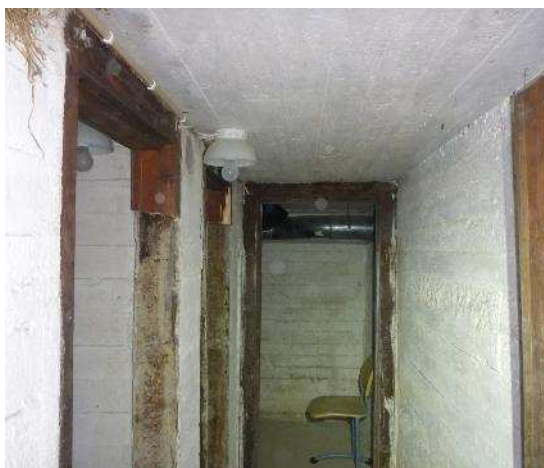
Kuva 39. Kellarin ja ensimmäisen kerroksen välipohjan alapinta on maalattua betonia.
