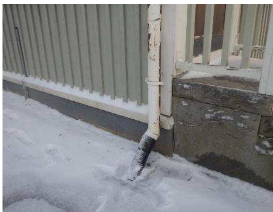
Kuvat 49 a ja b. Graniittiportaан ja seinän välisen liittymän vesitiiveys on puutteellinen.
