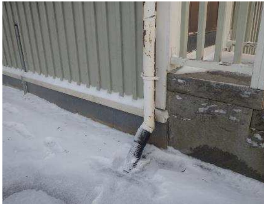
Kuva 3. Kattovedet ohjataan jatketuilla syöksytorvilla maanpinnan alapuolelle, todennäköisesti sadevesiviemäriin. Piha-alueilla ei havaittu sadevesi- tai salaojakaivoja.
