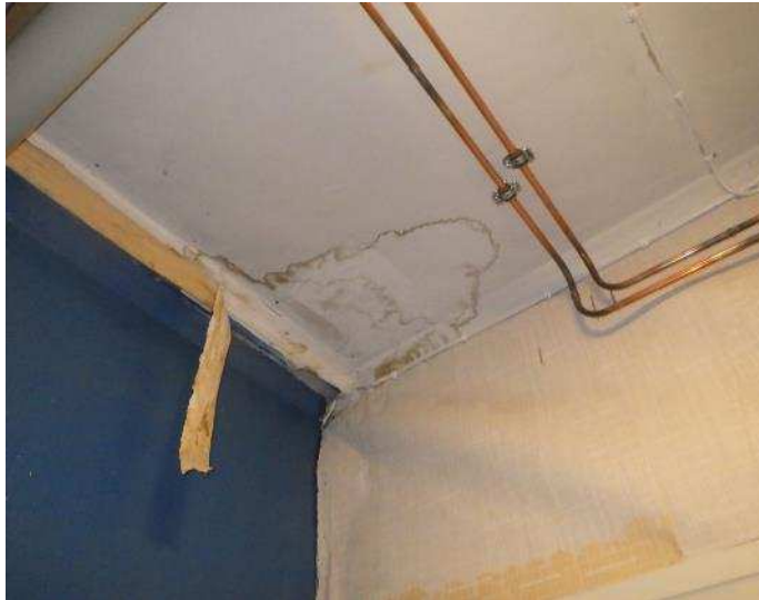
Kuvat 69 a...e. Rakennuksen matalampien osien päädyissä on mm. varastokäytössä olleita kylmiä tiloja. Kuvat ovat tilasta 217. Tiloissa on runsaasti rakennus- ja muuta jätettä sekä sekalaista tavaraa. Pinnoilla on laaja-alaisesti kosteusjälkiä. Matalampien osien vesikaton alapuolinen tila/ullakkotila tuulettuu räystäältä.
