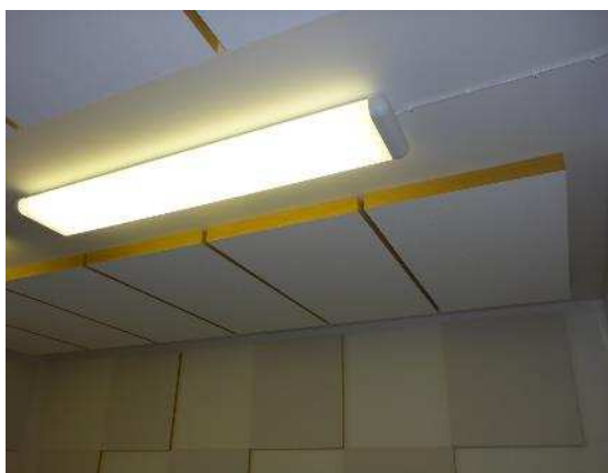
Kuvat 72 a ja b. Äänitysstudion tiloissa (pohjapiirustuksessa tilat 206 ja 207) havaittiin runsaasti avoimia mineraalivillapintoja yläpohjan ja seinien akustolevyjen sivupinnoilla sekä väliseinässä olevassa aukossa.
