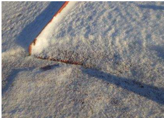
Kuvat 61 a ja b. Vesikatteessa on kaksinkertainen pystysauma, mutta ei tiivistysmassaa.
