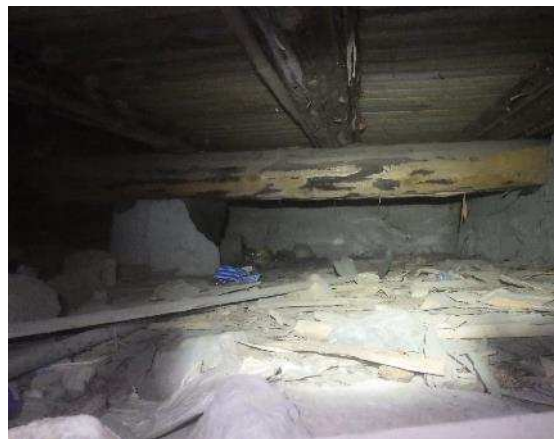
Kuvat 13 a ja b. Pääosin ryömintätila oli siisti. Ryömintätilassa on paikoitellen ylimääräistä materiaalia, mm. puumateriaalia sekä rikkiäisiä lasi- ja posliiniastioita.
