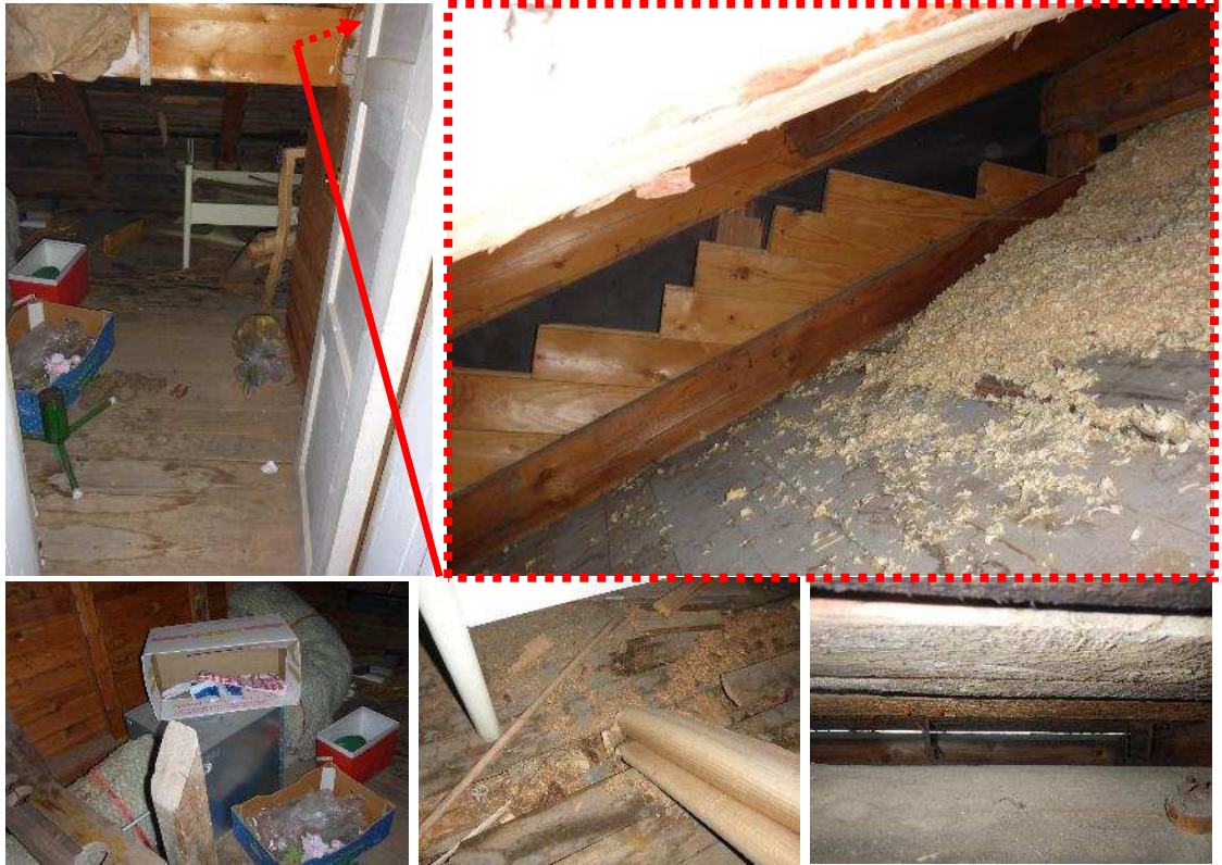
Kuvat 69 a...e. Rakennuksen matalampien osien päädyissä on mm. varastokäytössä olleita kylmiä tiloja. Kuvat ovat tilasta 217. Tiloissa on runsaasti rakennus- ja muuta jätettä sekä sekalaista tavaraa. Pinnoilla on laaja-alaisesti kosteusjälkiä. Matalampien osien vesikaton alapuolinen tila/ullakkotila tuulettuu räystäältä.
