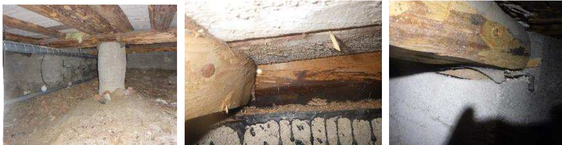
Kuvat 14 a...c. Perusmuurin/betonipilareiden ja alapohjan puurakenteiden liittymässä on käytetty erilaisia kosteuden nousun estäviä materiaaleja, mm. bitumikermiä (kuva a), bitumisivelyä (kuva b) ja tervapahvia (kuva c).
