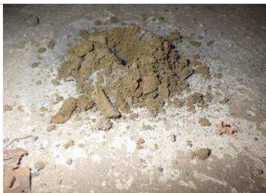
Kuva 5. Rakenneavaus RAAP3 kellaritilan alapohjaan. Maanvastaisen betonilaatan alapuolella on hienoa, tiiviisti pakkautu-nutta hiekkaa. Hiekkatäyttö oli aistinvarai-sesti arvioituna kosteaa.
