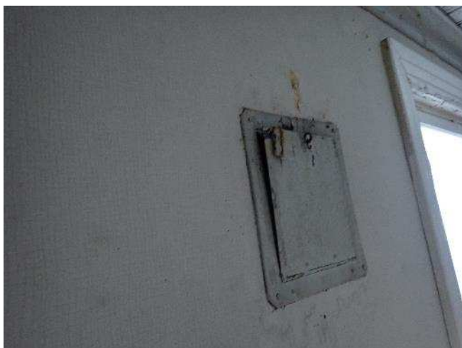
Kuva 91. Korvausilmaluukku 2. kerroksessa.
