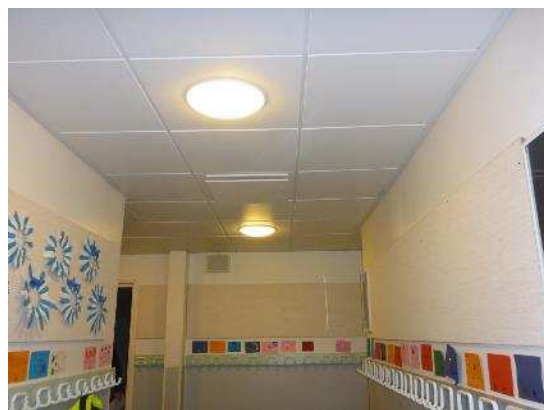
Kuvat 44 a ja b. Ensimmäisen ja toisen kerroksen välisen välipohjan alapinnassa on pääosin kipsilevytyt (kuva a), käytävätilassa on alaslaskettu katto (kuva b). Käyttötilojen kattopinnat ovat siistikuntoisia.
