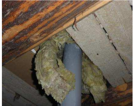
Kuvat 17 a ja b. Viemäriputkien läpiviennit on tiivistetty mineraalivillalla ryömintätilasta käsin, tiivistysten ilmatiiveydessä on puutteita. Viemäriputkia ei ole lämmöneristetty.
