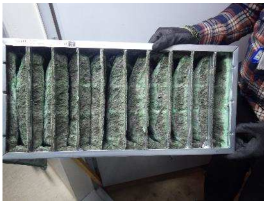
Kuva 78 a ja b. Tuloilmasuodatin on kohtalaisen likainen ja siellä on lunta. Suodatusluokka on F7.
