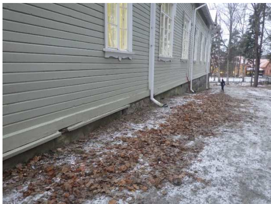
Kuvat 4 a ja b. Kattovedet ohjataan syöksytorvilla sadevesikaivoihin. Salaojakaivoja ei havaittu.
