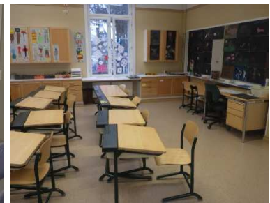
Kuvat 23 a...c. Yleiskuvia tiloista. Ala- ja välipohjarakenteen lattiapäällysteenä on käytetty kaikkialla muovimattoa. Lattiapäällysteet ovat hyväkuntoisia.
