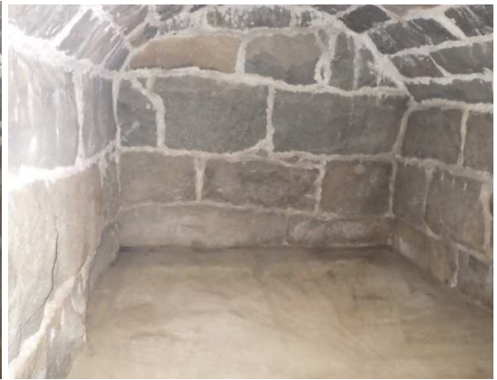
Kuvat 21 a ja b. Kellarilohko B:n alapohja on betonirakenteinen, ja seinä- ja kattorakenteet ovat luonnonkivistä muurattuja. Pintakosteudenilmaisimen lukemat olivat kellarin lattiassa 100...120 ja kellarin katossa 40...60.
