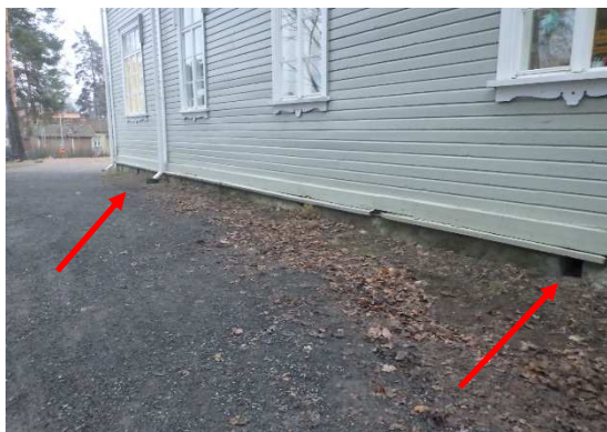
Kuva 6. Ryömintätila tuulettuu noin 5 merin välein sijoitetuilla ~200x200 mm tuuletusaukoilla. Tuuletusaukoista ei havaittu selvää poikkeavaa hajua.
