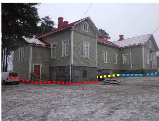
Kuvat 7 a ja b. Rakennuksen itäpäädyssä on maapohjainen kellaritila (merkitty punaisella kuvaan a). Rakennuksen keskivaiheilla on kaksi kiviainesrakenteista kellaritilaa (merkitty keltaisella kuvaan a). Sinisellä katkoviivalla on merkitty rakennuksen ryömintätilallinen osa.
