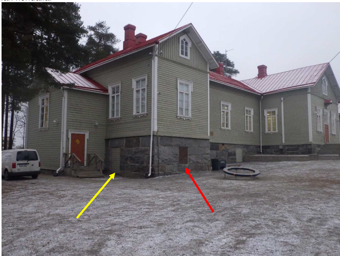
Kuva 12. Maapohjainen kellaritila on yhtenäistä tilaa, ja se tarkastettiin kauttaaltaan kuvaan punaisella nuolella merkityn luukun kautta. Kellaritilaan on lisäksi kaksi lukittua ovea ja kaksi ummistettua luukkua (yksi merkitty kuvaan keltaisella nuolella, muut sijaitsevat takapihan puolella), joita ei avattu.
