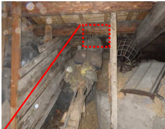
Kuvat 13 a ja b. Yleiskuvia maapohjaisesta kellarista. Kellaritilan korkeus on 2000...3000 mm. Kellaritilassa havaittiin mikrobiperäinen haju. Tuuletusaukkoja ei ole sokkelin epätiivelyskohtia lukuun ottamatta. Kellaritilassa ei havaittu ilmavirtauksia kenttätutkimusten yhteydessä.
