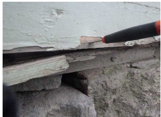
Kuvat 33 a...c. Rakennuksen päätyosien (länsipäädyssä tilojen 1, 2 ja 4 kohdalla ja itäpäädyssä tilojen 26 ja 27 kohdalla) sokkeli on matala (merkitty kuvaan a). Rakennuksen itäpäädyssä ja takapihan puolella julkisivulaudoituksen alaosissa on laho- vaurioita. Julkisivulaudoituksen ja hirsiseinän välissä on tervapaperi. Tuuletusväliä ei ole.
