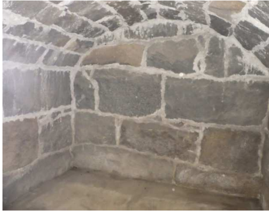
Kuvat 21 a ja b. Kellarilohko B:n alapohja on betonirakenteinen, ja seinä- ja kattorakenteet ovat luonnonkivistä muurattuja. Pintakosteudenilmaisimen lukemat olivat kellarin lattiassa 100...120 ja kellarin katossa 40...60.
