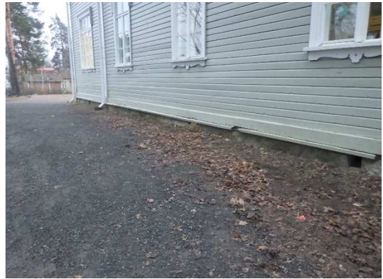
Kuvat 3 a ja b. Rakennuksen itäpäädyssä sokkeli on matala ja sokkelissa olevat tarkastusluukut sijaitsevat lähellä maanpintaa. Maanpinta viettää loivasti rakennuksesta pois päin.
