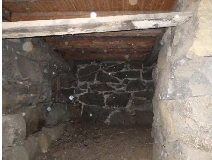
Kuvat 13 a ja b. Yleiskuvia maapohjaisesta kellarista. Kellaritilan korkeus on 2000...3000 mm. Kellaritilassa havaittiin mikrobiperäinen haju. Tuuletusaukkoja ei ole sokkelin epätiivelyskohtia lukuun ottamatta. Kellaritilassa ei havaittu ilmavirtauksia kenttätutkimusten yhteydessä.
