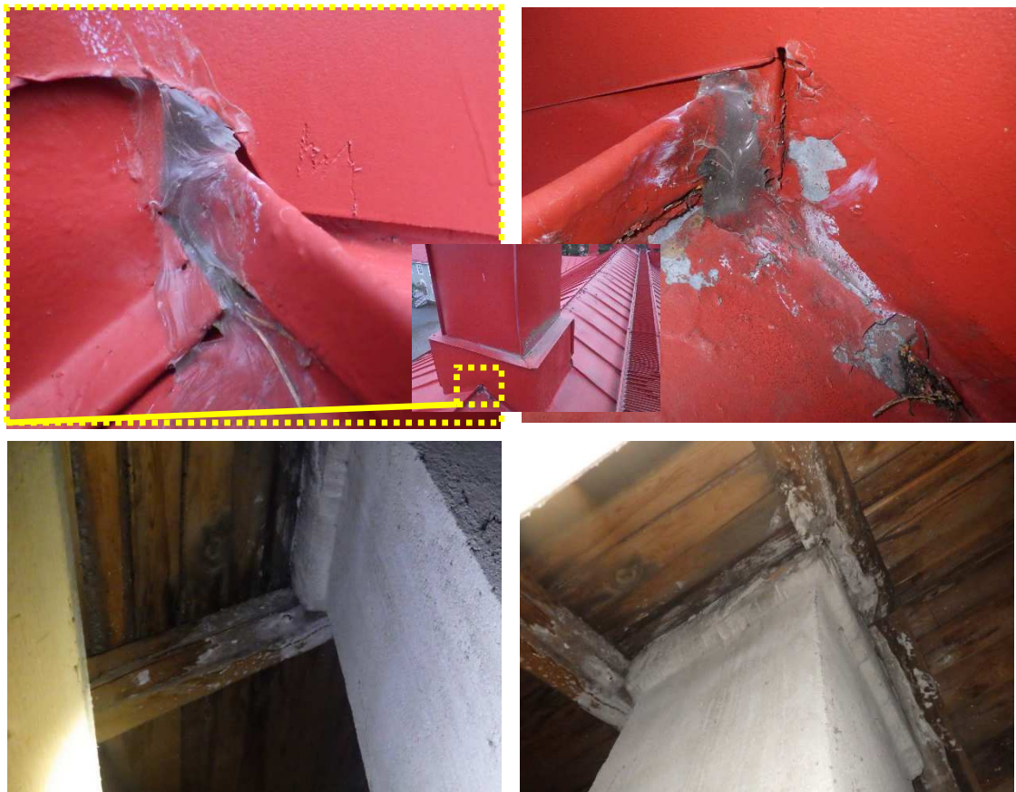
Kuvat 43 a...d. Vesikatteen harjan ja hormien pellitysten liittymiä on tiivistetty silikonilla. Liittymien vesitiiveydessä on puutteita. Vesikaton rakenteissa ja aluslaudoituksessa on kosteusjälkiä.
