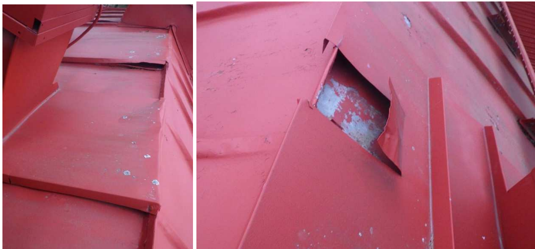
Kuvat 43 a...d. Vesikatteen harjan ja hormien pellitysten liittymiä on tiivistetty silikonilla. Liittymien vesitiiveydessä on puutteita. Vesikaton rakenteissa ja aluslaudoituksessa on kosteusjälkiä.
