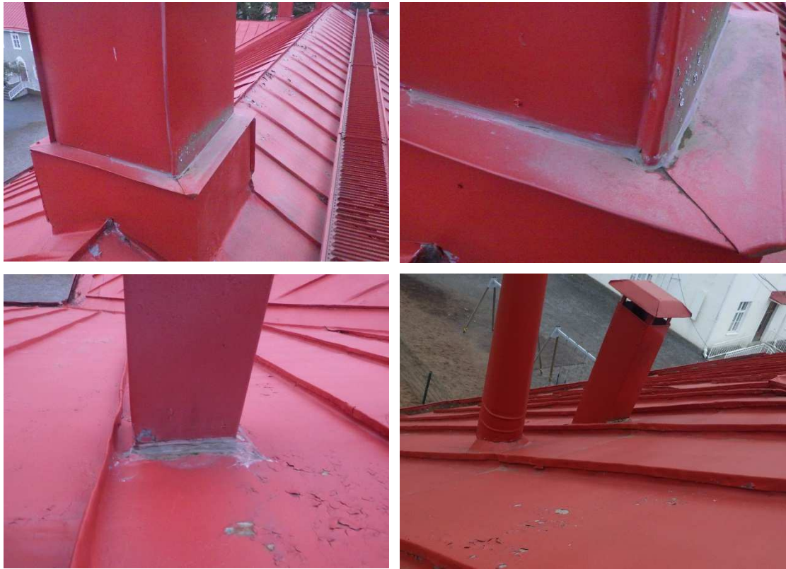
Kuvat 42 a...d. Hormistot sekä vesikaton lävistävät LVI-laitteiden jalustakotelot on pelitetty kokonaan. Pienempien läpivientien ympärillä on vesikatteeseen saumattu tyvikartio (kuva d). Iv-laitteiden jalustakoteloiden taitteissa havaittiin paikoin massa- tai silikonitiivistystä (kuvat a ja b). Koteloiden sisätaitteissa ei ole vastakallistuksia ja sisätaitteita on paikoitellen kitattu tai tiivistetty massaa käyttäen (kuva c).
