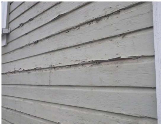
Kuvat 32 a...d. Rakennuksen molempien päätyosien maalipinta hilseilee, mutta julkisivulaudoituksen maalipinta on pääosin kohtuullisessa kunnossa.
