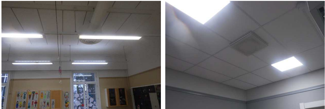
Kuvat 48 a ja b. Yläpohjan alapintana on pääosin kipsilevytys, jonka alapintaan on kiinnitetty akustolevyjä (kuva a). Osittain, mm. käytävä- ja aulatiloissa on alaslaskettu katto (kuva b).
