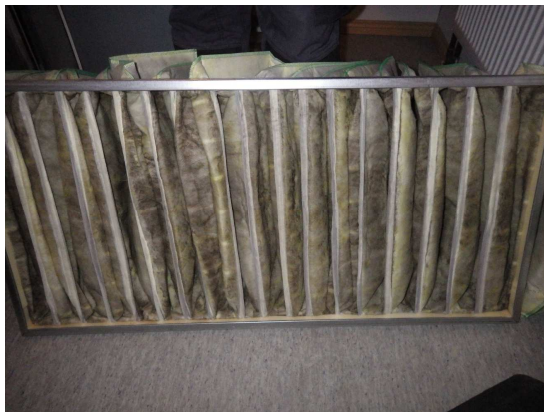
Kuva 53. Tuloilmasuodatin. Suodatusluokka on M6.
