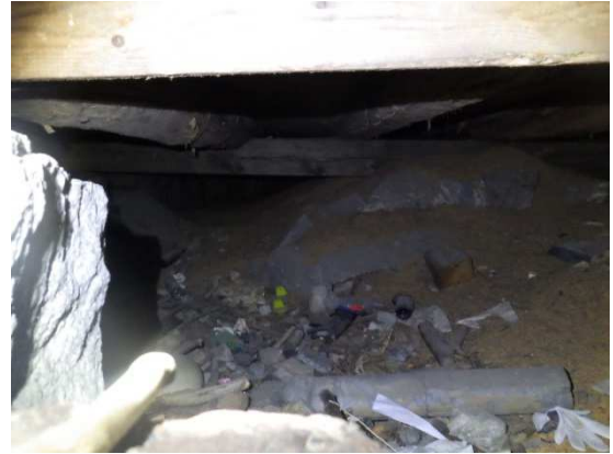
Kuvat 22 a ja b. Kellarilohko B:n katon yläpuolinen tila tarkastettiin sokkelissa olevan tuuletusluukun kautta. Kellarin katon päällä on hiekkaa ja vähäisessä määrin sekalaista jätettä. Vapaata ilmväliä on ~300 mm.
