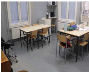
Kuvat 23 a...c. Yleiskuvia tiloista. Ala- ja välipohjarakenteen lattiapäällysteenä on käytetty kaikkialla muovimattoa. Lattiapäällysteet ovat hyväkuntoisia.
