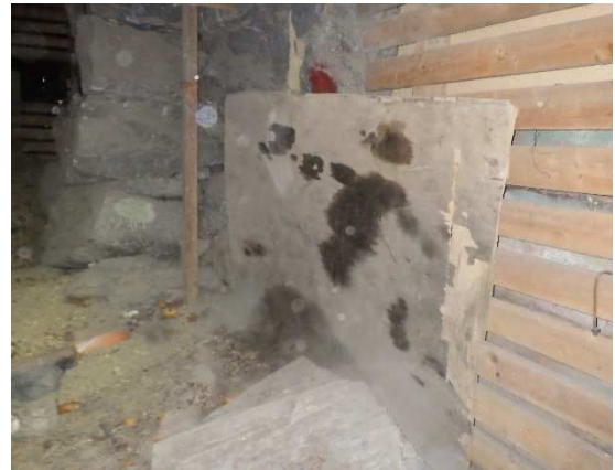
Kuvat 13 a ja b. Yleiskuvia maapohjaisesta kellarista. Kellaritilan korkeus on 2000...3000 mm. Kellaritilassa havaittiin mikrobiperäinen haju. Tuuletusaukkoja ei ole sokkelin epätiivelyskohtia lukuun ottamatta. Kellaritilassa ei havaittu ilmavirtauksia kenttätutkimusten yhteydessä.
