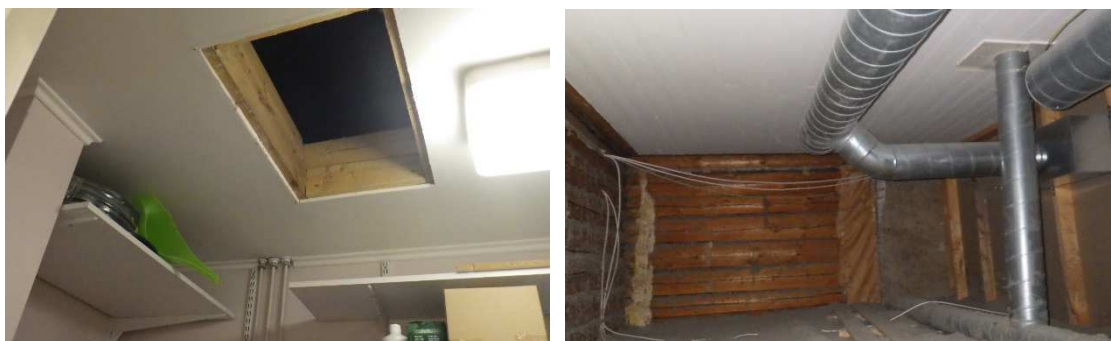
Kuvat 48 a ja b. Yläpohjan alapintana on pääosin kipsilevytys, jonka alapintaan on kiinnitetty akustolevyjä (kuva a). Osittain, mm. käytävä- ja aulatiloissa on alaslaskettu katto (kuva b).
