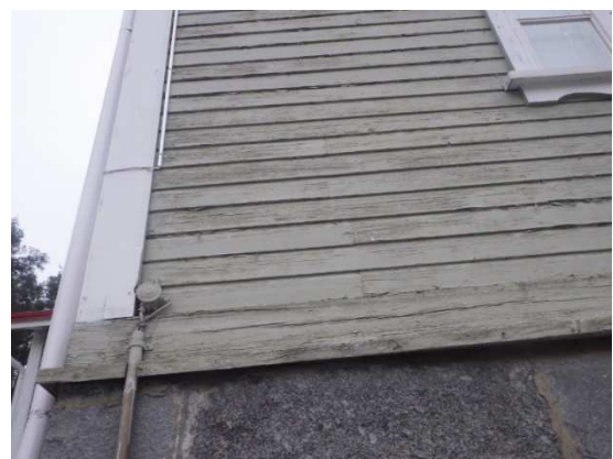
Kuvat 32 a...d. Rakennuksen molempien päätyosien maalipinta hilseilee, mutta julkisivulaudoituksen maalipinta on pääosin kohtuullisessa kunnossa.
