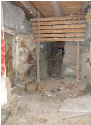
Kuvat 13 a ja b. Yleiskuvia maapohjaisesta kellarista. Kellaritilan korkeus on 2000...3000 mm. Kellaritilassa havaittiin mikrobiperäinen haju. Tuuletusaukkoja ei ole sokkelin epätiivelyskohtia lukuun ottamatta. Kellaritilassa ei havaittu ilmavirtauksia kenttätutkimusten yhteydessä.
