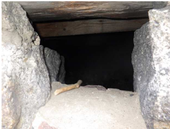
Kuvat 22 a ja b. Kellarilohko B:n katon yläpuolinen tila tarkastettiin sokkelissa olevan tuuletusluukun kautta. Kellarin katon päällä on hiekkaa ja vähäisessä määrin sekalaista jätettä. Vapaata ilmväliä on ~300 mm.
