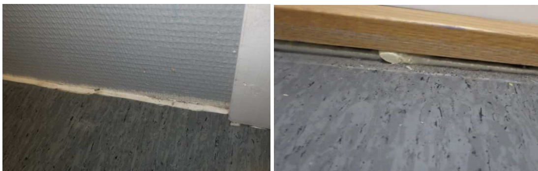
Kuva 24. Jalkalistoja avattiin pistokoeluontoisesti ulko- ja väliseiniltä. Alapohjan ja ulko- / väliseinien liittymiä on tiivistetty liimamassalla ja/tai polyuretaanivaahdolla. Liittymistä ei havaittu merkittäviä ilmavirtauksia merkkisavulla tarkasteltuna.
