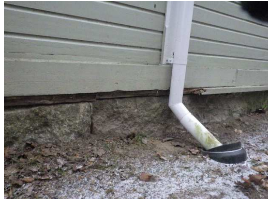
Kuvat 4 a ja b. Kattovedet ohjataan syöksytorvilla sadevesikaivoihin. Salaojakaivoja ei havaittu.
