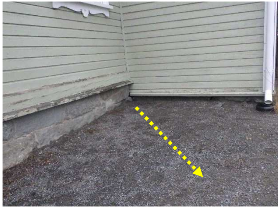
Kuvat 3 a ja b. Rakennuksen itäpäädyssä sokkeli on matala ja sokkelissa olevat tarkastusluukut sijaitsevat lähellä maanpintaa. Maanpinta viettää loivasti rakennuksesta pois päin.
