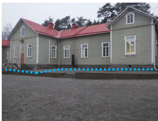
Kuvat 7 a ja b. Rakennuksen itäpäädyssä on maapohjainen kellaritila (merkitty punaisella kuvaan a). Rakennuksen keskivaiheilla on kaksi kiviainesrakenteista kellaritilaa (merkitty keltaisella kuvaan a). Sinisellä katkoviivalla on merkitty rakennuksen ryömintätilallinen osa.
