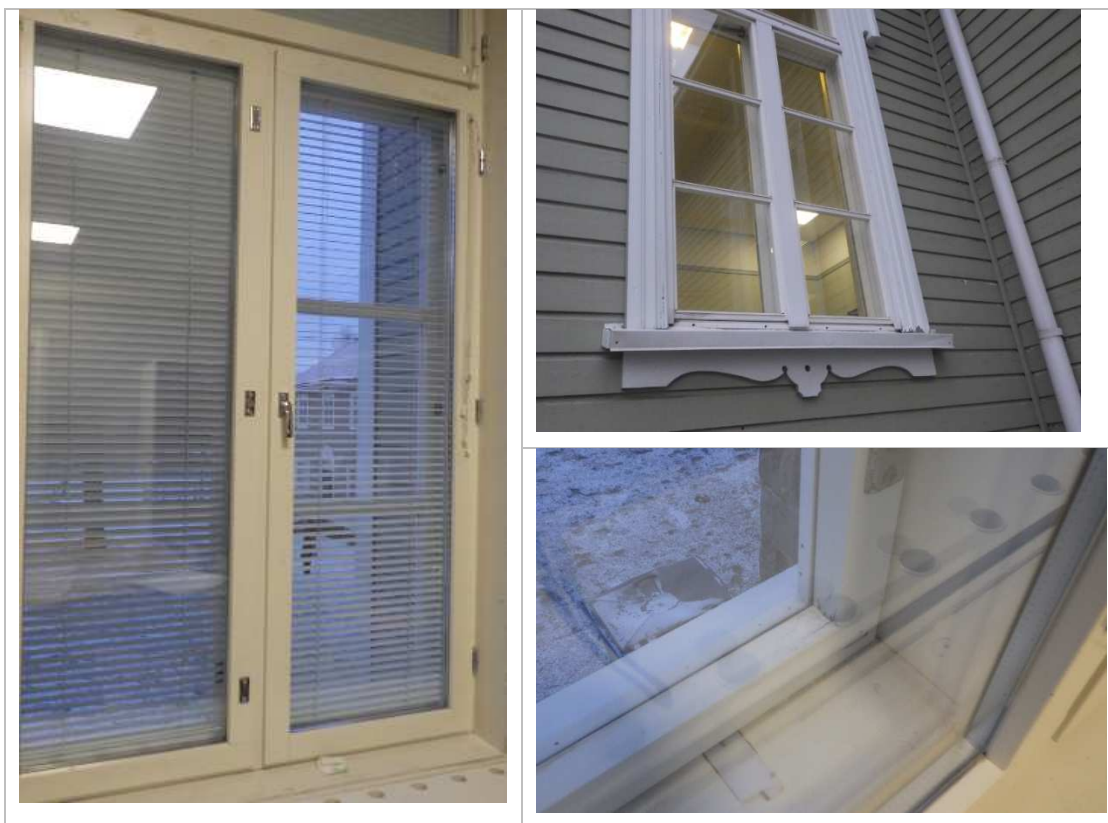
Kuvat 34 a...c. Käyttökerroksen ikkunat on uusittu peruskorjauksen yhteydessä ja ne ovat hyväkuntoiset. Ikkunat ovat kaksipuitteisia, kolmilasisia puuikkunoita. Ikkunoiden ulkopuolisessa sadevedentiiveydessä ei havaittu merkittäviä puutteita.
