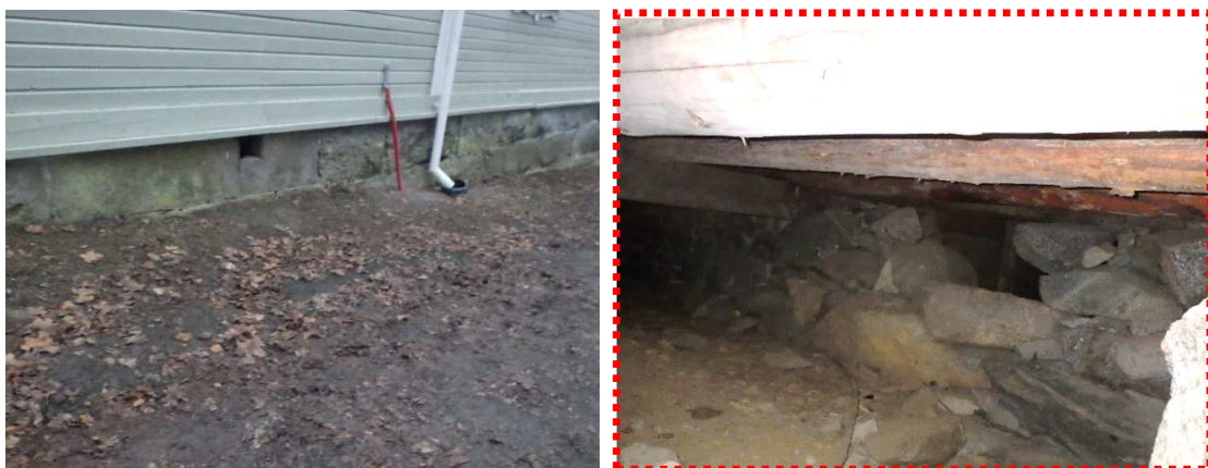
Kuvat 10 a ja b. Ryömintätilan korkeus rakennuksen keskivaiheilla on ~700 mm, takapihan puolelta tarkastellessa. Luonnonkivimuureissa havaittiin tuuletusaukkoja.
