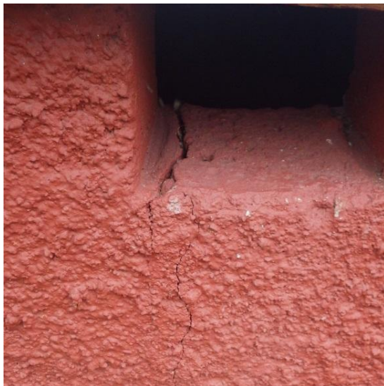
Kuvat 16a ja b. Sokkeleissa havaittiin runsaasti halkeamia. Pääosa halkeamista on tuuletusaukkojen kohdalla (a), mutta yksittäisiä halkeamia havaittiin myös muualla (b).
