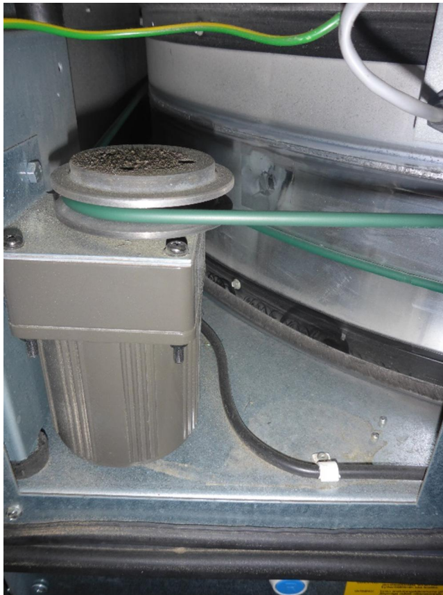
Kuva 35. LTO-kennon moottorin päällä on paljon pölyä ym. likaa.
