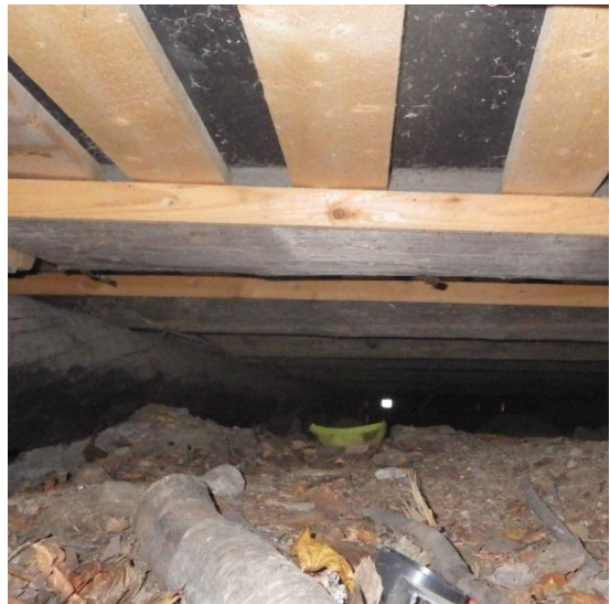
Kuvat 6a ja b. Rakennuksen pohjoispäässä alapohjarakenne on uusittu kokonaan (sekä kantavat rakenteet, että alapohjatyttö on uusittu). Uudet alapohjakannattajat on tehty kyllästetyistä vanhoista puhelinpylväistä. Uusitut rakenteet ovat aistinvaraisesti arvioituna hyväkuntoisia. Pohjoispäässä ryömintätila on matala ja ryömintätilan pohjalla on lehtiä ja muuta orgaanista jätettä.
