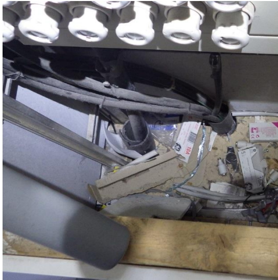
Kuva 11. Alapohjassa havaittiin talotekniikan läpivientejä. Aulatilassa 109 sijaitsevat sähköläpivientien (vasen kuva) ilmatiiveys on erittäin heikko. Viemäri­läpivientien il­ma­tiiveys on kohtalainen.
