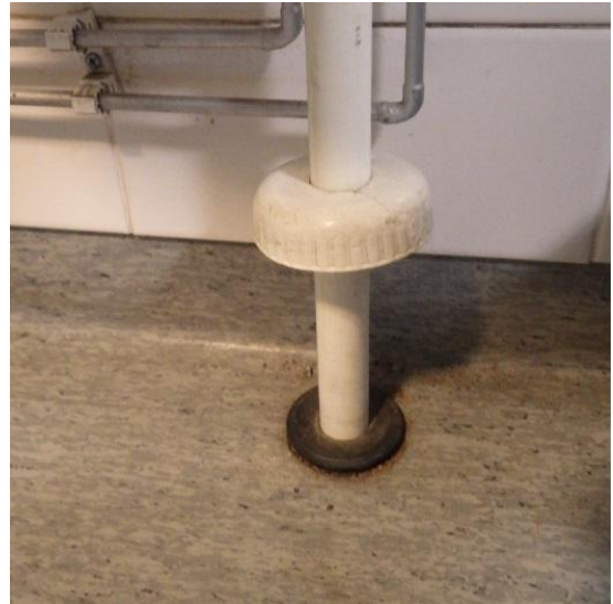
Kuva 11. Alapohjassa havaittiin talotekniikan läpivientejä. Aulatilassa 109 sijaitsevat sähköläpivientien (vasen kuva) ilmatiiveys on erittäin heikko. Viemäri­läpivientien il­ma­tiiveys on kohtalainen.
