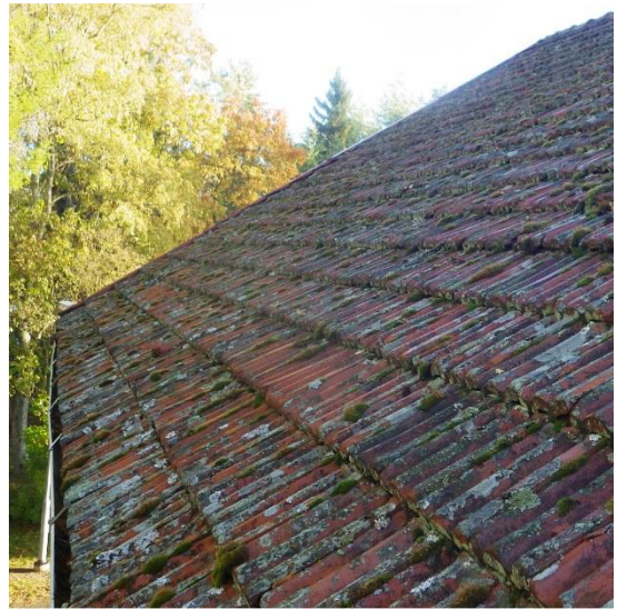
Kuvat 19a ja b. Vesikate on voimakkaasti sammaloitunut (molemmat kuvat).
