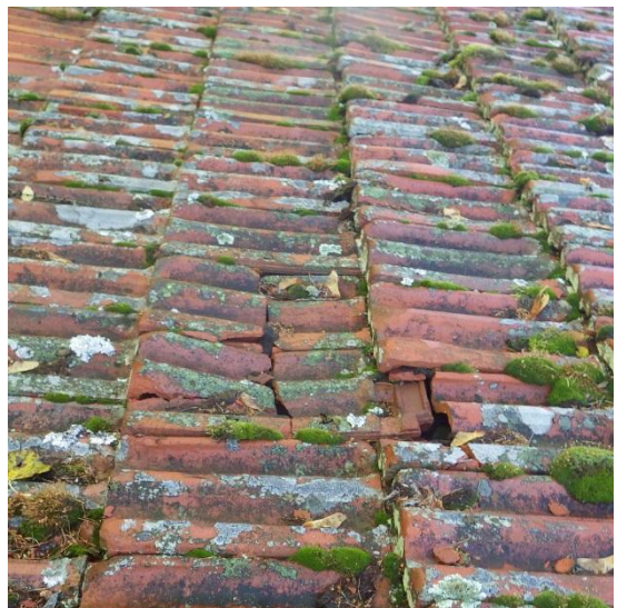
Kuvat 20a ja b. Kattotiiliä on monin paikoin särkynyt, erityisesti alueilta, joita on käytetty kulkemiseen. Vesikatolle ei ole kulkusiltoja, lapetikkaita lukuun ottamatta.
