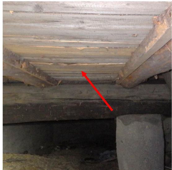
Kuvat 8a ja b. Paikoin aluslaudoitus on pehmennyt yläpinnastaan ja taipunut alapohjätätön painosta.
