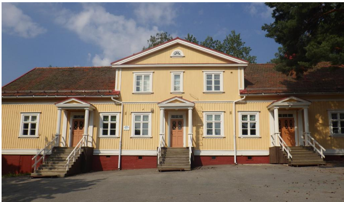
Kuva 2. Rakennus sijaitsee etelään viettävässä rinteessä. Piha-alueen päällysteenä rakennuksen seinustoilla on pääosin asfalttia.
