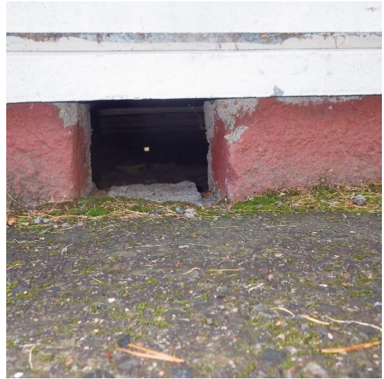
Kuvat 9a ja b. Rakennuksen pohjoispäässä ja luoteiskulmalla tuuletusaukot ovat maanpinnan tasolla. Osa rakennuksen tuuletusaukoista on peitetty puisilla luukuilla. (ei kuvassa)
