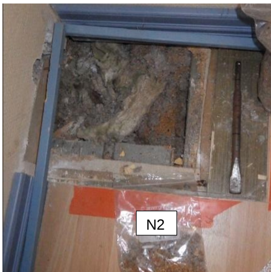
Kuva 13. Alapohjaan tehdyistä molemmista rakenneavauksista otettiin myös materiaalinäyte. Näyte N2 (sahanpuru ja puukuitueriste) otettiin rakenneavauksesta RAK2. Näytteenottokohdalla painunutta eristettä oli täydennetty puukuitueristeellä. Näytteessä N2 on analyysiraportin mukaan epäily mikrobikasvusta. Näyte N7 (puukuitueriste) otettiin rakenneavauksesta RAK3 alueelta, jossa alapohjarakenne on uusittu kokonaan. Näytteessä N7 ei havaittu mikrobikasvua. Alapohjan ilmatiiveys on aistinvaraisten havaintojen perusteella heikko reuna-alueilta. Rakenneavauksista aistittiin lievästi ummehtunut haju.
