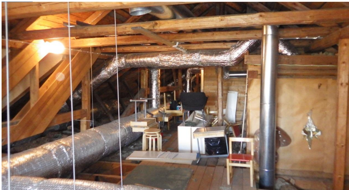
Kuva 23. Ullakko- /tuuletustila on tilava. Tilaan on varastoitu irtaimistoa. Ullakkotilassa havaittiin lievästi ummehtunut haju.
