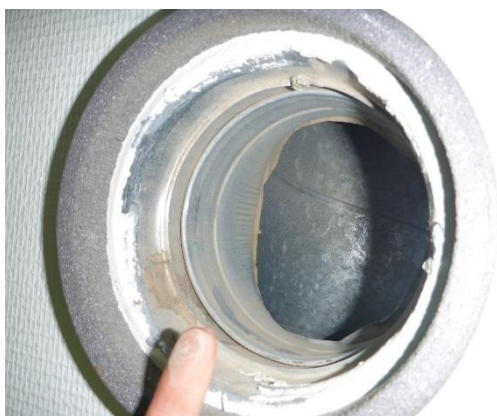
Kuva 43 a ja b. Poistoilmakanava oli pölyinen. Tuloilmakanavassa oli hieman pölyä.
