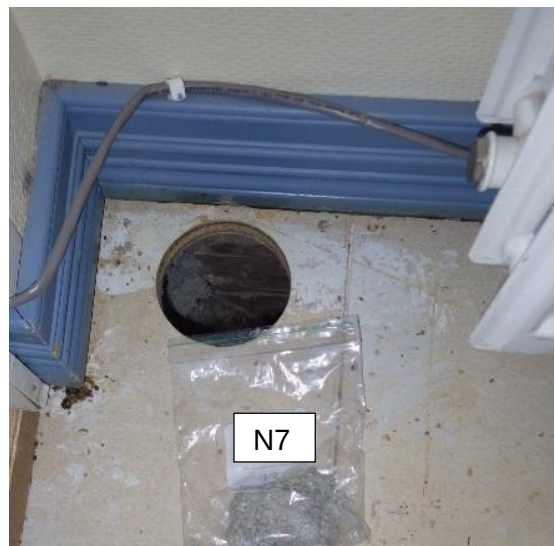
Kuva 13. Alapohjaan tehdyistä molemmista rakenneavauksista otettiin myös materiaalinäyte. Näyte N2 (sahanpuru ja puukuitueriste) otettiin rakenneavauksesta RAK2. Näytteenottokohdalla painunutta eristettä oli täydennetty puukuitueristeellä. Näytteessä N2 on analyysiraportin mukaan epäily mikrobikasvusta. Näyte N7 (puukuitueriste) otettiin rakenneavauksesta RAK3 alueelta, jossa alapohjarakenne on uusittu kokonaan. Näytteessä N7 ei havaittu mikrobikasvua. Alapohjan ilmatiiveys on aistinvaraisten havaintojen perusteella heikko reuna-alueilta. Rakenneavauksista aistittiin lievästi ummehtunut haju.
