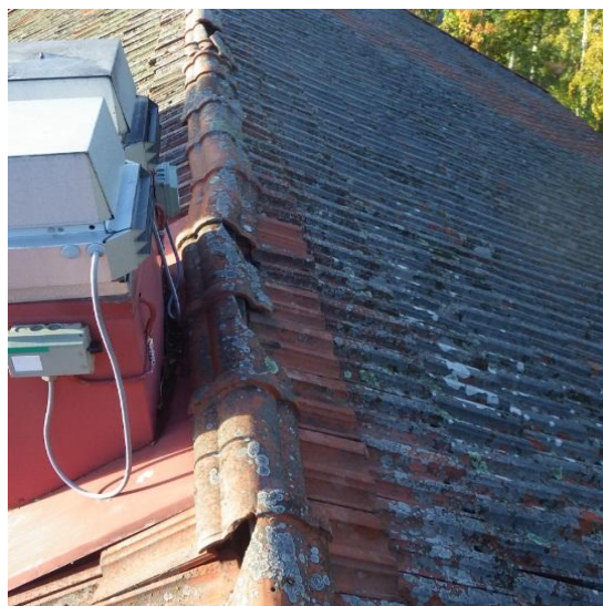
Kuvat 20a ja b. Kattotiiliä on monin paikoin särkynyt, erityisesti alueilta, joita on käytetty kulkemiseen. Vesikatolle ei ole kulkusiltoja, lapetikkaita lukuun ottamatta.
