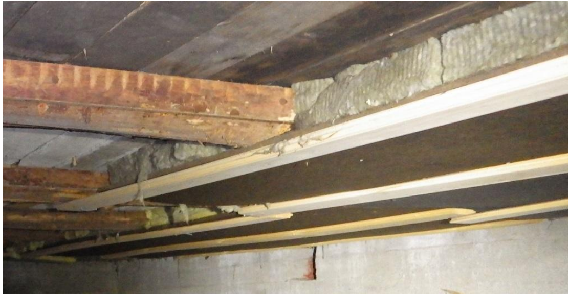
Kuva 7. Rakennuksen eteläpäässä ja osittain länsisivulla alapohjarakennetta on lisäeristetty alapuolelta seinän vierustoilta.
