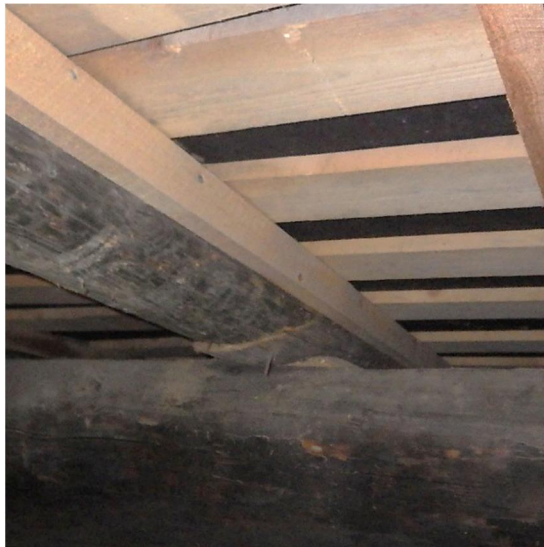
Kuvat 6a ja b. Rakennuksen pohjoispäässä alapohjarakenne on uusittu kokonaan (sekä kantavat rakenteet, että alapohjatyttö on uusittu). Uudet alapohjakannattajat on tehty kyllästetyistä vanhoista puhelinpylväistä. Uusitut rakenteet ovat aistinvaraisesti arvioituna hyväkuntoisia. Pohjoispäässä ryömintätila on matala ja ryömintätilan pohjalla on lehtiä ja muuta orgaanista jätettä.
