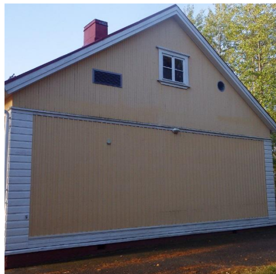
Kuvat 24a ja b. Ullakkotilaa ei ole tuuletettu räystäältä (vasen kuva), päätykolmiosta (oikea kuva) tai harjalta (ei kuvaa). Päätykolmiossa näkyvät säleiköt ovat ilmanvaihdon raitis- ja jäteilmasäleikköjä.
