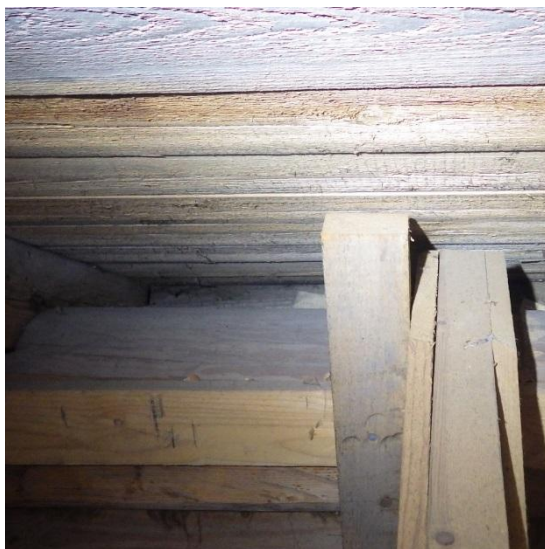
Kuvat 24a ja b. Ullakkotilaa ei ole tuuletettu räystäältä (vasen kuva), päätykolmiosta (oikea kuva) tai harjalta (ei kuvaa). Päätykolmiossa näkyvät säleiköt ovat ilmanvaihdon raitis- ja jäteilmasäleikköjä.
