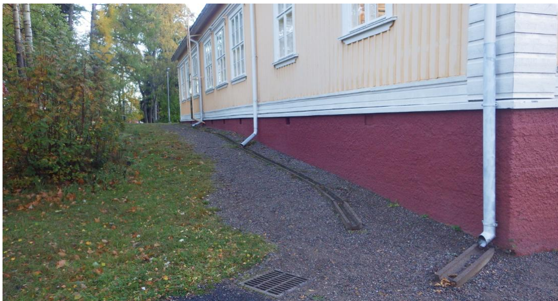
Kuva 3. Länsisivulla rakennuksen vierustalla pintakerroksena on hienoa soraa. Rakennuksen seinustalla on betonikouru, joka ohjaa kattovedet sadevesikaivon suuntaan.
