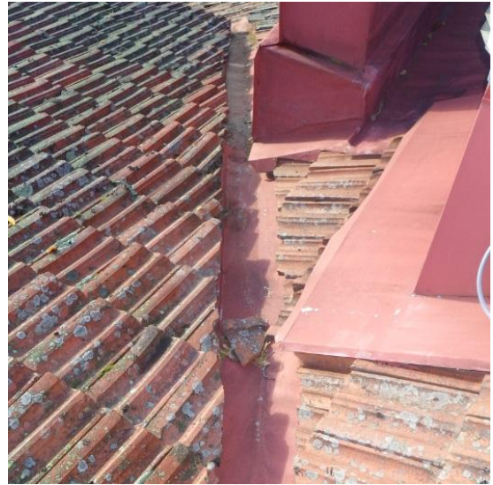
Kuva 21. Jäipellityksissä on paikoin puutteita ja harjalta puuttui tiiliä. Jäirikouruissa oli tutkimushetkellä tiilenpalasia.
