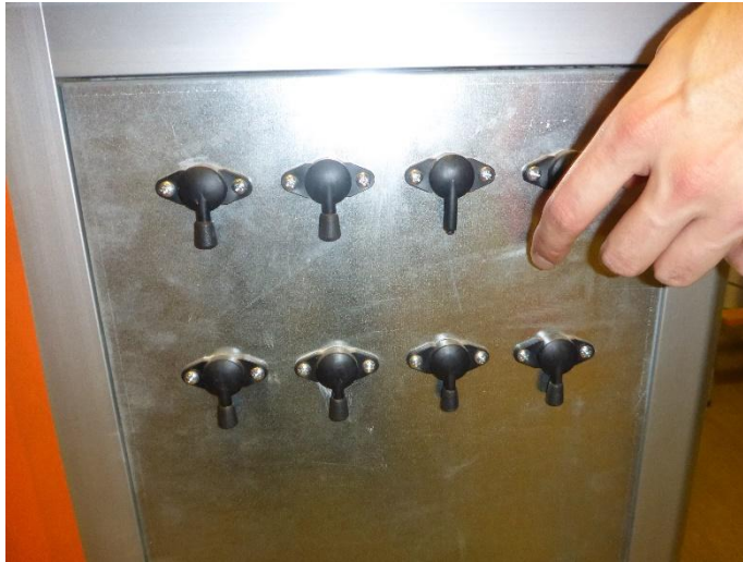
Kuva 39. Mittausyhteitä, jotka eivät ole käytöstä. Kahdesta yhteestä puuttuu tulppa.
