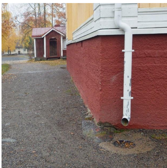
Kuvat 4a ja b. Rakennuksen pohjoispäässä sokkelin korkeus on noin 100...120 cm ja rakennuksen eteläpäässä noin 10...20 cm. Rakennuksen päissä maanpinta seinän vierustoilla on varsin tasainen.
