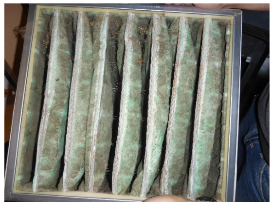
Kuva 32 a ja b. Tulo- ja poistoilmasuodattimet ovat luokkaa EU7.
