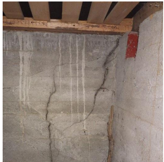
Kuvat 16a ja b. Sokkeleissa havaittiin runsaasti halkeamia. Pääosa halkeamista on tuuletusaukkojen kohdalla (a), mutta yksittäisiä halkeamia havaittiin myös muualla (b).
