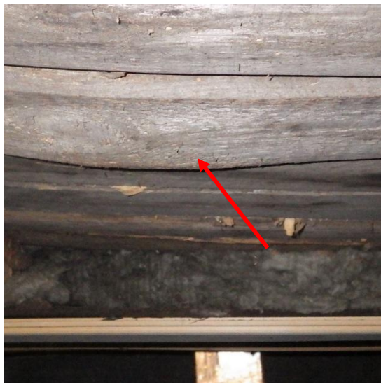
Kuvat 8a ja b. Paikoin aluslaudoitus on pehmennyt yläpinnastaan ja taipunut alapohjätätön painosta.
