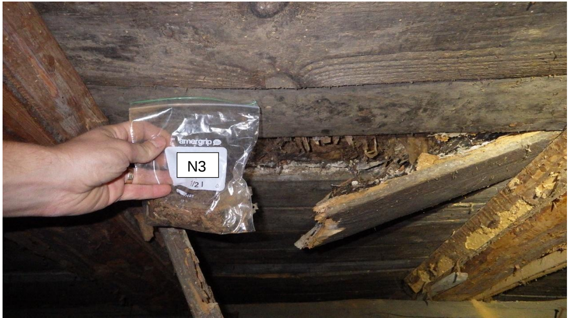
Kuva 12. Ryömintätilan kautta otettiin näytteet N3 (RAK6) ja N4 (RAK7). Molemmat näytteet otettiin aluslaudoituksen ja tervapaperin yläpuolelta alapohjan eristekerroksen alaosaan. Näytteestä N4 ei ole valokuvaa. Analyysiraportin mukaan molemmissa näytteissä havaittiin epäily mikrobikasvusta.
