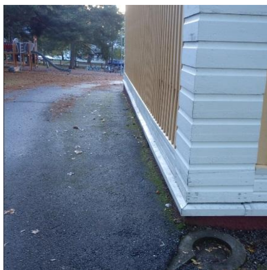
Kuvat 4a ja b. Rakennuksen pohjoispäässä sokkelin korkeus on noin 100...120 cm ja rakennuksen eteläpäässä noin 10...20 cm. Rakennuksen päissä maanpinta seinän vierustoilla on varsin tasainen.
