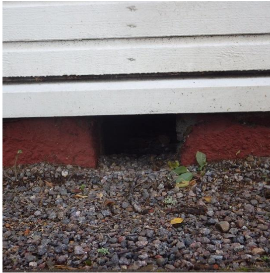
Kuvat 9a ja b. Rakennuksen pohjoispäässä ja luoteiskulmalla tuuletusaukot ovat maanpinnan tasolla. Osa rakennuksen tuuletusaukoista on peitetty puisilla luukuilla. (ei kuvassa)
