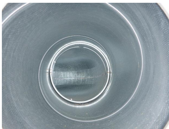
Kuva 43 a ja b. Poistoilmakanava oli pölyinen. Tuloilmakanavassa oli hieman pölyä.
