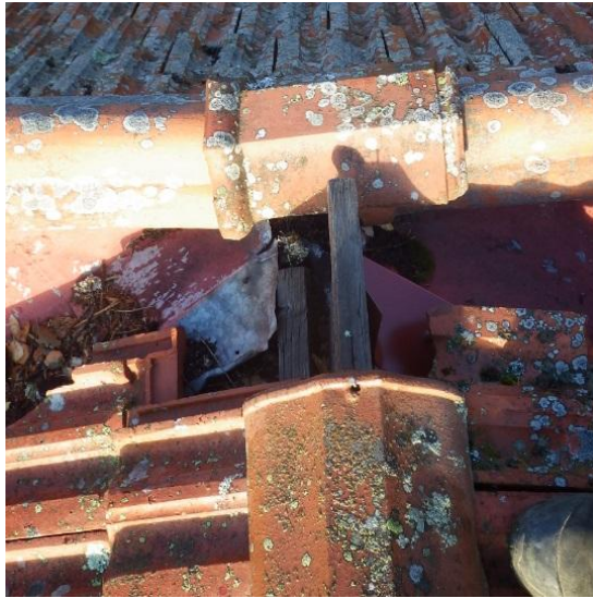
Kuva 21. Jäipellityksissä on paikoin puutteita ja harjalta puuttui tiiliä. Jäirikouruissa oli tutkimushetkellä tiilenpalasia.
