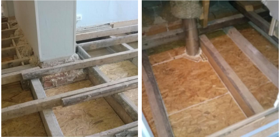
Kuvat 19a ja b. Tilaajan toimittamia valokuvia välipohjan korjauksista vuodelta 2014. Kuvat ovat 2. kerroksesta. Kuvissa näkyvät palkit ovat puurakenteisia ja välipohjätäytöksi on asennettu puhallettu puukuitueriste. Vasemmassa kuvassa hyvin näkyvien korokerimojen päälle on asennettu havuvaneri, tasoitekerros ja muovimatto.
