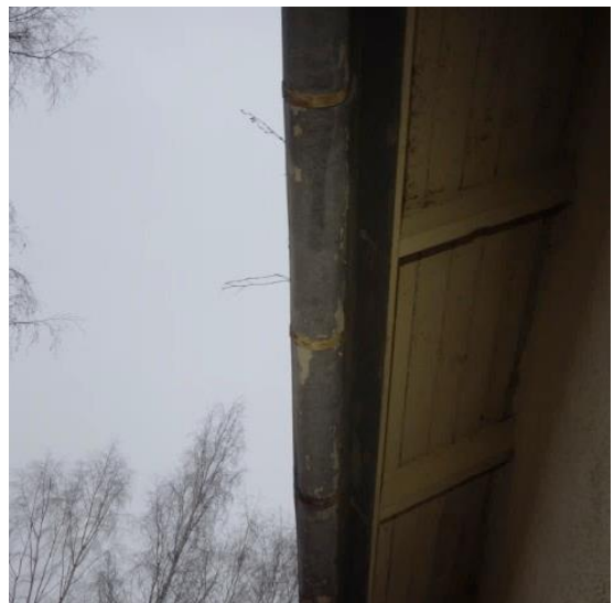
Kuvat 36 a ja b. Räystäskouruissa oli tutkimushetkellä runsaasti lehtiä ja muuta roskaa. Räystäskourut ovat ikääntyneitä (oikea kuva)
