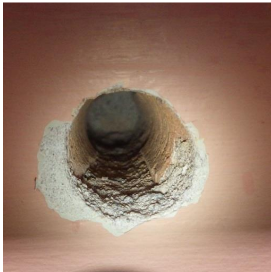
Kuva 32. Kivirakenteisten ulkoseinien rakennekerrokset varmistettiin sisäpuolelta poratuista 25 mm porareijistä. Reiät porattiin sekä ensimmäiseen että toiseen kerrokseen ja rakenne varmistettiin erikseen ikkunan alta ja ikkunan vierestä. Porareikien perusteella ulkoseinät ovat massiivitiiltä ja rakenne on sama molemmissa kerroksissa eikä ikkunoiden alapuolinen rakenne poikkea muusta rakenteesta.
