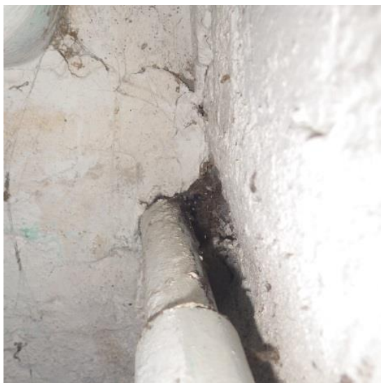
Kuvat 17a ja b. Alemmassa välipohjassa havaittiin epätiivitä välipohjan lävistäviä putkiläpivientejä. Osasta läpivienneistä havaittiin tutkimushetkellä selkeää ilmavirtausta yläpuoliseen huonetilaan päin.
