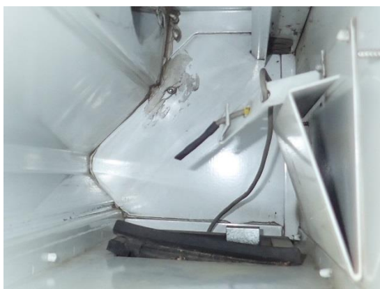
Kuva 49 a ja b. Puhaltimien kumityyny/-tiivisteet ovat osin pois paikaltaan ja halkeilleet.
