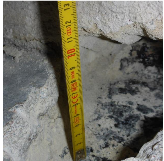
Kuva 12. Valokuvia tilaan 009 tehdystä rakenneavauksesta RAK3 . Avauksesta tarkasteltiin lattia-seinäliittymän toteutusta. Avauksesta havaittiin, että maanvastaisen ulkoseinän kevytbetoninen sisäkuori lähtee pohjalaatan päältä ja alapohjan ja maanvastaisen seinän bitumisively liittyvät avauksen kohdalla toisiinsa. Bitumisivelystä otettiin materiaalinäyte asbesti- ja PAH-yhdisteanalyysiä varten. Bitumisively ei sisällä asbestia eikä PAH-yhdisteiden kokonaispitoisuudet ylitä vaarallisen jätteen raja-arvoa. Laboratorion analyysivastaus on esitetty kokonaisuudessaan liitteessä 2.
