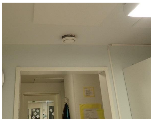
Kuva 56 a ja b. Poistoilmaventtiilit ovat molemmissa kerroksissa kartioventtiilejä. 2. kerroksen tilassa 203 iv-kanava on pudonnut alaspäin ja venttiiliin sekä alakaton välille on jäänyt tyhjää tilaa.
