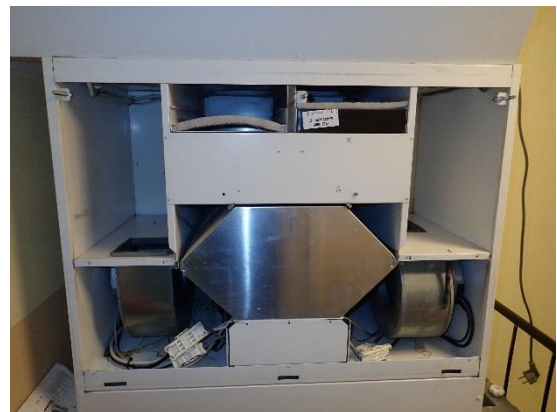
Kuva 50 a ja b. 2. kerrosta palveleva ilmanvaihtokone Iloxair 199.
