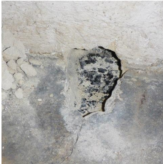
Kuva 12. Valokuvia tilaan 009 tehdystä rakenneavauksesta RAK3 . Avauksesta tarkasteltiin lattia-seinäliittymän toteutusta. Avauksesta havaittiin, että maanvastaisen ulkoseinän kevytbetoninen sisäkuori lähtee pohjalaatan päältä ja alapohjan ja maanvastaisen seinän bitumisively liittyvät avauksen kohdalla toisiinsa. Bitumisivelystä otettiin materiaalinäyte asbesti- ja PAH-yhdisteanalyysiä varten. Bitumisively ei sisällä asbestia eikä PAH-yhdisteiden kokonaispitoisuudet ylitä vaarallisen jätteen raja-arvoa. Laboratorion analyysivastaus on esitetty kokonaisuudessaan liitteessä 2.
