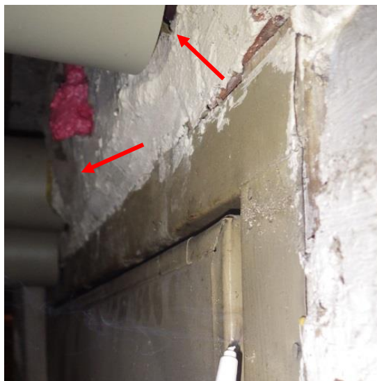
Kuvat 28a, b ja c. Yläkuvassa ja vasemmassa alakuvassa öljysäiliötilan ja viereisen varaston välinen seinä, jonka havaittiin olevan epätiivis erityisesti seinän liittymäkohdista. Oikeassa alakuvassa merkkisavutarkastelua lämmönjakohuoneen oviraosta. Ilmavirtauksen suunta oli voimakkaasti likaisista tiloista muihin tiloihin päin. Lämmönjakohuoneesta ja öljysäiliötilasta on myös useita epätiivitä läpivientejä viereisiin tiloihin (korostettu valokuvuihin punaisilla nuolilla).
