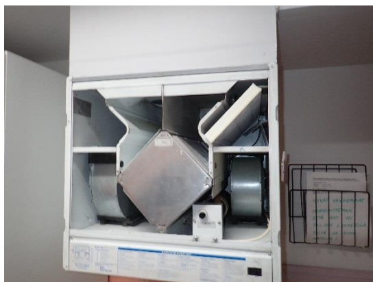
Kuva 43 a ja b. Yleiskuva työtilaan 106 sijoitetusta iv-koneesta Vallox Digit SE. Koneessa ei ole paikallaan siihen kuuluvia karkeasuodattimia.
