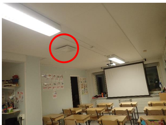
Kuva 55 a ja b. 1. kerroksen tuloilmalaite (vasen kuva) ja 2. kerroksen tuloilmalaite (oikea kuva).
