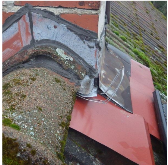
Kuvat 35 a ja b. Kattoturvatuotteet on osin uusittu. Vesikatteen läpivientien pellityksiä on korjailtu jälkikäteen. Pellitysten toteutus on vaihtelevaa (oikea kuva).
