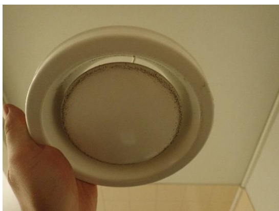
Kuva 56 a ja b. Poistoilmaventtiilit ovat molemmissa kerroksissa kartioventtiilejä. 2. kerroksen tilassa 203 iv-kanava on pudonnut alaspäin ja venttiiliin sekä alakaton välille on jäänyt tyhjää tilaa.
