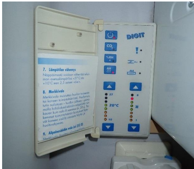
Kuva 44. Koneita ohjataan paikallissäätimen avulla. Koneen sammuttaessa ja käynnistäessä uudelleen, asetukset palautuu 1/8 teholle.
