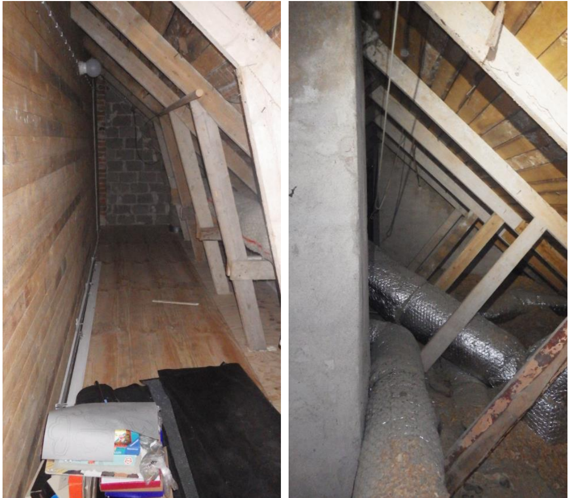
Kuvat 37 a ja b. Yleiskuvia ullakkotiloista. Vasen kuva sivuvintiltä ja oikea kuva harjaulakolta.
