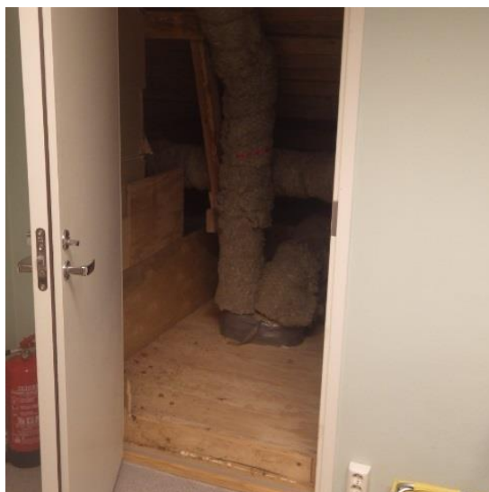
Kuva 33. Väliovet 2. kerroksesta ullakkotilaan. Rakennuksen itäsisivulla ullakkotilaan johtavat ovet ovat alkuperäisiä tiivistämättömiä vanhoja tuplaovia (vasen kuva). Rakennuksen länsisivulla ullakkotilaan johtavat ovet on uusittu ja ne ovat tiivistäviä. Merkkisavulla tarkasteltuna ullakkotilan ja huonetilan välillä ei havaittu merkittävää ilmavirtausta oviraoista.
