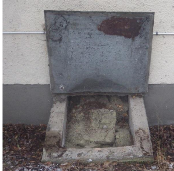
Kuvat 6a ja b. Lastausluukun alapuolella havaittiin valumajälkiä. Lastausluukku ei ole vesitiivis ulkopuolelta.
