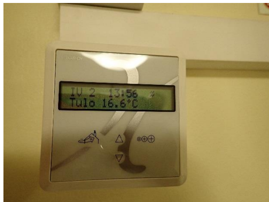
Kuva 51 a ja b. Koneen ohjauspaneeli ja kellokytkin, joka ei ole enää käytössä.
