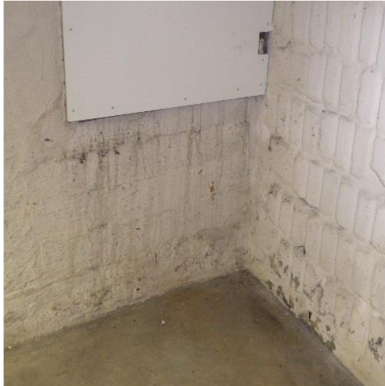
Kuvat 6a ja b. Lastausluukun alapuolella havaittiin valumajälkiä. Lastausluukku ei ole vesitiivis ulkopuolelta.
