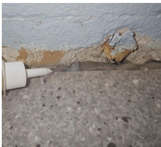
Kuvat 18a, b, c, ja d. Alemmassa välipohjassa havaittiin selkeitä rakoja lattia-seinäliittymässä irrotetun jalkalistan alta. Merkkisavulla tarkasteltuna raosta ei havaittu merkittävää ilmavirtausta kumpaankaan suuntaan.
