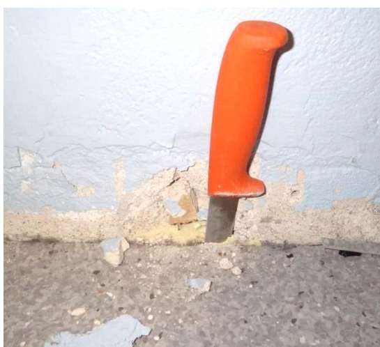
Kuvat 18a, b, c, ja d. Alemmassa välipohjassa havaittiin selkeitä rakoja lattia-seinäliittymässä irrotetun jalkalistan alta. Merkkisavulla tarkasteltuna raosta ei havaittu merkittävää ilmavirtausta kumpaankaan suuntaan.
