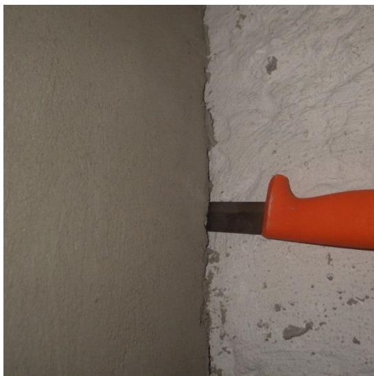
Kuvat 28a, b ja c. Yläkuvassa ja vasemmassa alakuvassa öljysäiliötilan ja viereisen varaston välinen seinä, jonka havaittiin olevan epätiivis erityisesti seinän liittymäkohdista. Oikeassa alakuvassa merkkisavutarkastelua lämmönjakohuoneen oviraosta. Ilmavirtauksen suunta oli voimakkaasti likaisista tiloista muihin tiloihin päin. Lämmönjakohuoneesta ja öljysäiliötilasta on myös useita epätiivitä läpivientejä viereisiin tiloihin (korostettu valokuvuihin punaisilla nuolilla).
