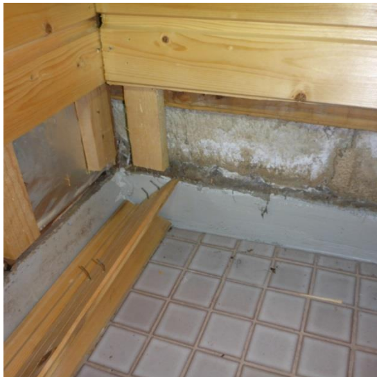
Kuvat 13a ja b. Saunaan tehtiin rakenneavaus RAK4 , jossa saunan ulkoseinästä ja saunan ja pesutilojen välisestä seinästä irrotettiin puupaneeleita. Paneelin alla maanvastaisessa seinässä havaittiin jonkin verran kalkkihärmää (vasen kuva). Paneloinnin puukoolauksia varten muuraussaumoihin on upotettu puulistat, joihin koolauspuut on kiinnitetty (oikea kuva punainen nuoli). Rakenneavauksen kohdalla puukoolauksessa ei havaittu vaurioita.
