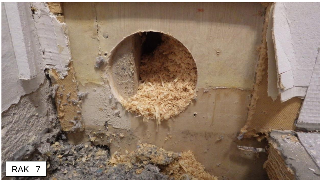
Kuva 31. Valokuva kylmään sivuvinttiin rajoittuvaan seinään tehdystä rakenneavauksesta RAK 7 . Rakenneavauksesta ei havaittu poikkeavaa hajua tai muita viitteitä vaurioista. Ulkoseinärakenteessa ei ole erillistä höyryn- tai ilmansulkukerrosta.
