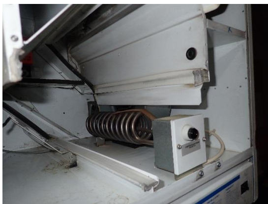
Kuva 48 a ja b. Kone on sisäosiltaan likaantunut, etenkin poistoilmapuolelta.
