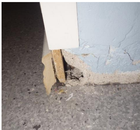
Kuvat 17a ja b. Alemmassa välipohjassa havaittiin epätiivitä välipohjan lävistäviä putkiläpivientejä. Osasta läpivienneistä havaittiin tutkimushetkellä selkeää ilmavirtausta yläpuoliseen huonetilaan päin.
