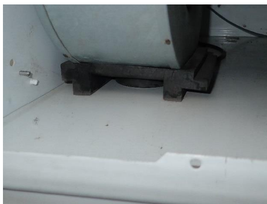
Kuva 49 a ja b. Puhaltimien kumityyny/-tiivisteet ovat osin pois paikaltaan ja halkeilleet.
