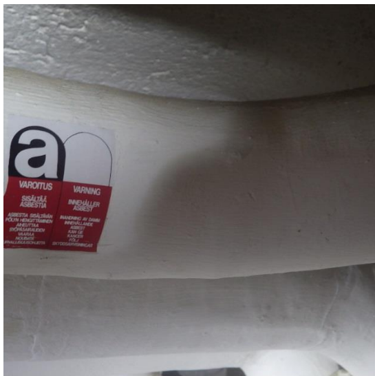
Kuva 42. Kellarikerroksessa on asbestieristeisiä putkia. Putket on merkitty pääosin kuvissa näkyvillä tarroilla. Osa putkieristeistä on rikkoontuneita ja asbestikuitujen kulkeutuminen sisäilmaan on mahdollista.
