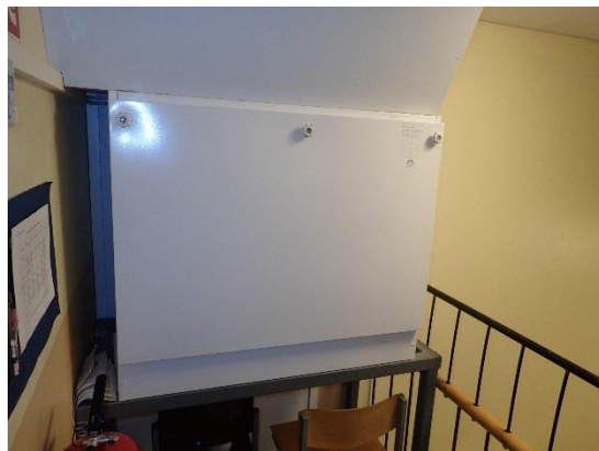
Kuva 50 a ja b. 2. kerrosta palveleva ilmanvaihtokone Iloxair 199.
