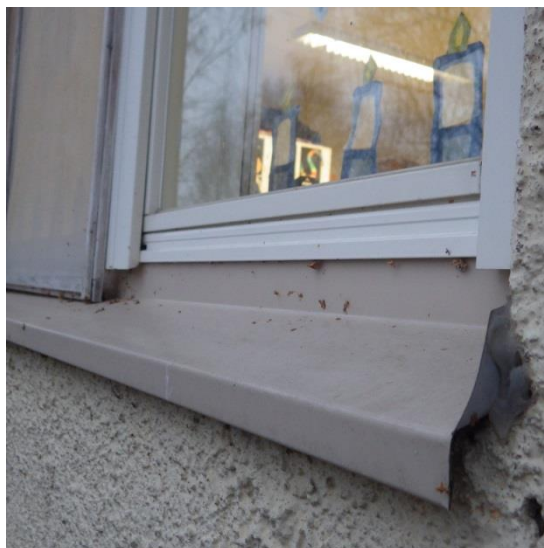
Kuvat 30a ja b. Molempien kerrosten ikkunat ja ikkunapellitykset on uusittu. Ikkunoiden vesitiiveydessä ei havaittu puutteita.
