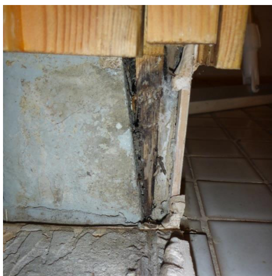
Kuvat 11 a ja b. Pesutilojen lattiakaivon vesilukko oli tutkimushetkellä kuiva ja pesutiloissa oli voimakas viemäriperäinen haju. Haju poistui kaivon hajulukon kastelun jälkeen. Saunan ja pesutilojen välisen seinän alaosan puuosissa havaittiin paikallisia kosteusvaurioita. Oikeanpuoleinen kuva on otettu saunan ja pesuhuoneen välisen oviaukon reunasta.
