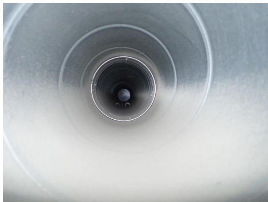
Kuva 57 a ja b. Poistoilmakanavat olivat pistokoeluontoisesti tarkasteltuna pölyisiä.
