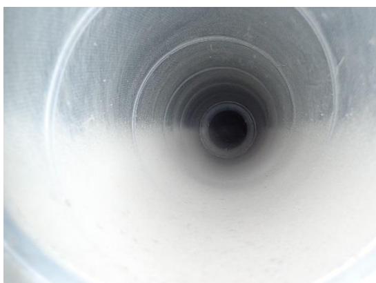
Kuva 57 a ja b. Poistoilmakanavat olivat pistokoeluontoisesti tarkasteltuna pölyisiä.
