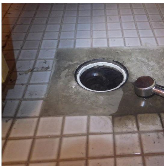
Kuvat 11 a ja b. Pesutilojen lattiakaivon vesilukko oli tutkimushetkellä kuiva ja pesutiloissa oli voimakas viemäriperäinen haju. Haju poistui kaivon hajulukon kastelun jälkeen. Saunan ja pesutilojen välisen seinän alaosan puuosissa havaittiin paikallisia kosteusvaurioita. Oikeanpuoleinen kuva on otettu saunan ja pesuhuoneen välisen oviaukon reunasta.
