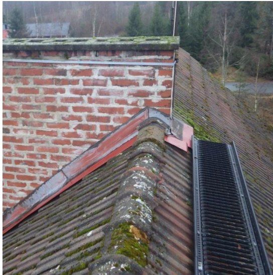
Kuvat 35 a ja b. Kattoturvatuotteet on osin uusittu. Vesikatteen läpivientien pellityksiä on korjailtu jälkikäteen. Pellitysten toteutus on vaihtelevaa (oikea kuva).
