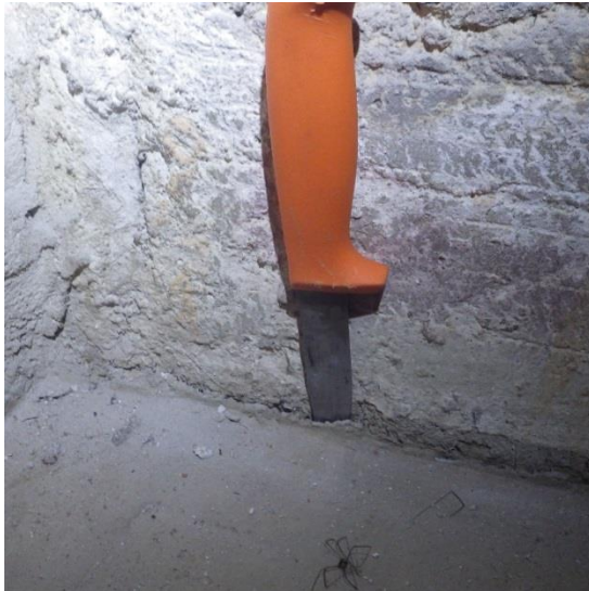
Kuvat 7a ja b. Kellarikerroksen lattia-seinäliitännissä havaittiin paikoitellen selkeitä rakoja. Raoista ei havaittu ilmavirtausta merkkisavun avulla.
