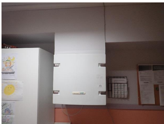
Kuva 43 a ja b. Yleiskuva työtilaan 106 sijoitetusta iv-koneesta Vallox Digit SE. Koneessa ei ole paikallaan siihen kuuluvia karkeasuodattimia.
