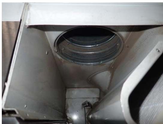
Kuva 48 a ja b. Kone on sisäosiltaan likaantunut, etenkin poistoilmapuolelta.
