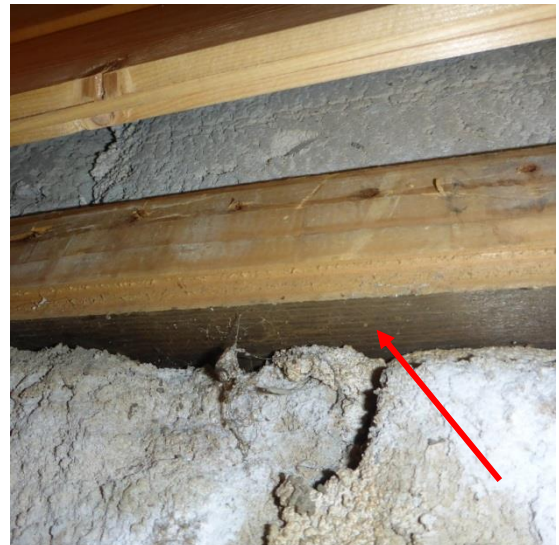
Kuvat 13a ja b. Saunaan tehtiin rakenneavaus RAK4 , jossa saunan ulkoseinästä ja saunan ja pesutilojen välisestä seinästä irrotettiin puupaneeleita. Paneelin alla maanvastaisessa seinässä havaittiin jonkin verran kalkkihärmää (vasen kuva). Paneloinnin puukoolauksia varten muuraussaumoihin on upotettu puulistat, joihin koolauspuut on kiinnitetty (oikea kuva punainen nuoli). Rakenneavauksen kohdalla puukoolauksessa ei havaittu vaurioita.
