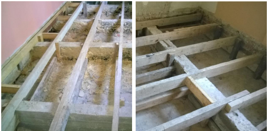
Kuvat 15a ja b. Tilaajan toimittamia valokuvia välipohjan korjauksista vuodelta 2014. Kuvat ovat 1. kerroksesta. Kuvissa näkyvät palkit ja pohjalaatta ovat betonirakenteisia. Välipohjatäytöksi on asennettu kevytsora ja kuvissa näkyvien korokepuiden päälle on asennettu havuvanerit, tasoitekerros ja muovimatto.
