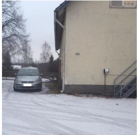
Kuvat 2a ja b. Maanpinta rakennuksen ympärillä on tasainen eikä rakennuspaikalla ole suuria korkeuseroja. Piha-alueen päällysteenä on sora tai nurmi. Rakennuksen vierustoilta ei ole sadevesikaivoja.
