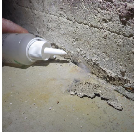
Kuvat 7a ja b. Kellarikerroksen lattia-seinäliitännissä havaittiin paikoitellen selkeitä rakoja. Raoista ei havaittu ilmavirtausta merkkisavun avulla.
