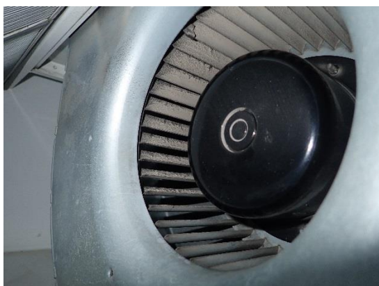
Kuva 54. Puhaltimet ovat pölyiset.
