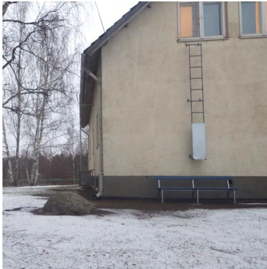
Kuvat 2a ja b. Maanpinta rakennuksen ympärillä on tasainen eikä rakennuspaikalla ole suuria korkeuseroja. Piha-alueen päällysteenä on sora tai nurmi. Rakennuksen vierustoilta ei ole sadevesikaivoja.
