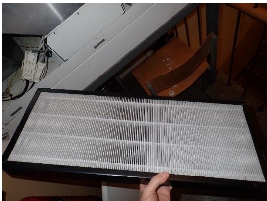
Kuva 52. Tuloilmasuodatin on melko puhdas, suodatusluokka on F7.
