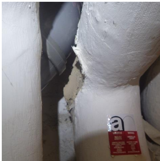
Kuva 42. Kellarikerroksessa on asbestieristeisiä putkia. Putket on merkitty pääosin kuvissa näkyvillä tarroilla. Osa putkieristeistä on rikkoontuneita ja asbestikuitujen kulkeutuminen sisäilmaan on mahdollista.
