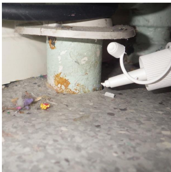
Kuvat 17a ja b. Alemmassa välipohjassa havaittiin epätiivitä välipohjan lävistäviä putkiläpivientejä. Osasta läpivienneistä havaittiin tutkimushetkellä selkeää ilmavirtausta yläpuoliseen huonetilaan päin.
