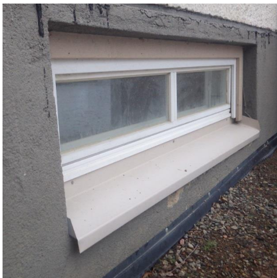
Kuvat 30a ja b. Molempien kerrosten ikkunat ja ikkunapellitykset on uusittu. Ikkunoiden vesitiiveydessä ei havaittu puutteita.
