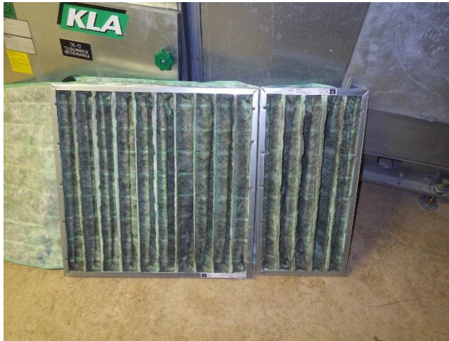
Kuva 63. Suodattimet ovat jonkin verran likaantuneet. Suodatusluokka on F7.
