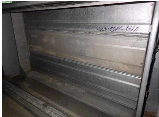
Kuva 54 a ja b. Raitisilmakammiossa on vähäisiä kosteusjälkiä. Raitisilmapelti sulkeutuu tiiviisti.
