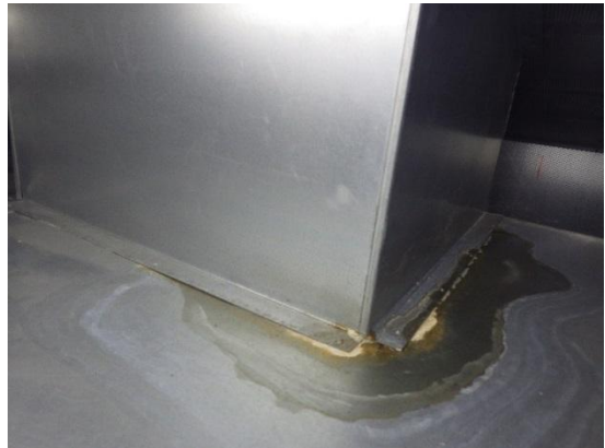
Kuva 67 a ja b. Raitisilmakammiossa sisällä ja kanavistossa ulkopuolella on kosteusjälkiä.
