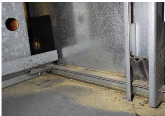
Kuva 71 a ja b. Lämmityspatteri on likainen.
