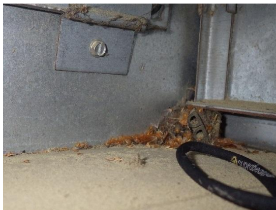
Kuva 62 a ja b. Koneessa on ennen suodatusosaa melko paljon likaa.
