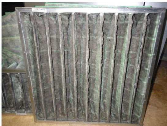
Kuva 56 a ja b. Sekä tulo- että poistoilmasuodattimien suodatusluokka on F7. Tuloilmasuodatin on selkeästi enemmän likaantunut kuin poistoilmasuodatin. Koneiden suodatinkehysten lukitukset olivat erittäin jäykät.
