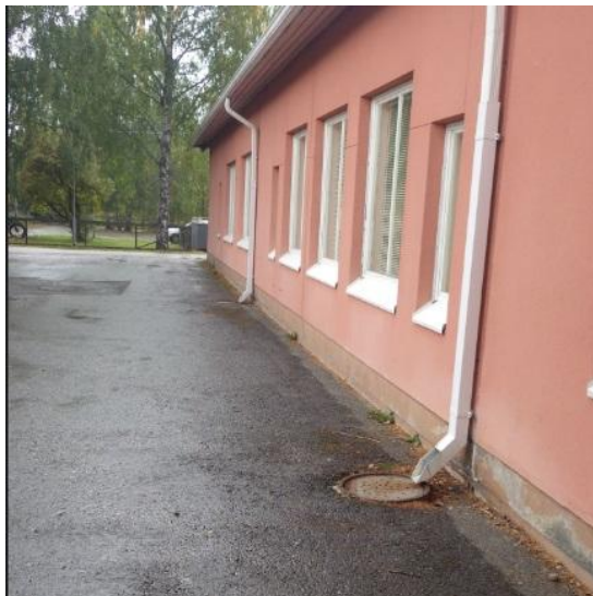
Kuvat 2 a, b ja c. Maanpinta seinän vierustoilla on pääosin tasainen eikä vietä rakennuksesta poispäin. Maanpinta rakennuksen eteläisivulla on paikoin hyvin lähellä ikkunan alareunaa (oikea alakuva). Erityisesti rakennuksen eteläisivulla sokkelin ja päällysteen välissä on noin 5...20 mm rako (pieni kuva).
