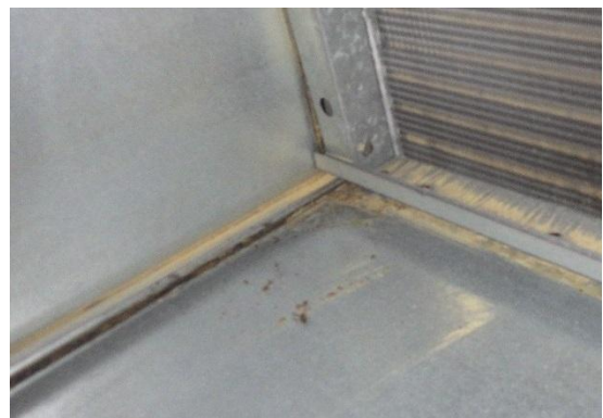
Kuva 70. Tuloilmasuodattimien suodatinkammiossa on kosteusjälkiä.
