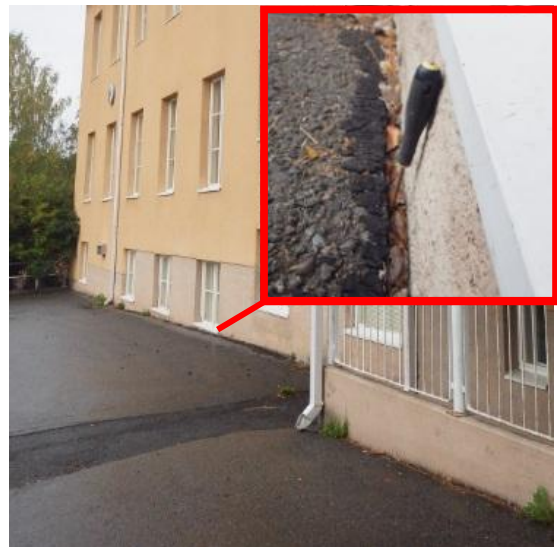
Kuvat 2 a, b ja c. Maanpinta seinän vierustoilla on pääosin tasainen eikä vietä rakennuksesta poispäin. Maanpinta rakennuksen eteläisivulla on paikoin hyvin lähellä ikkunan alareunaa (oikea alakuva). Erityisesti rakennuksen eteläisivulla sokkelin ja päällysteen välissä on noin 5...20 mm rako (pieni kuva).
