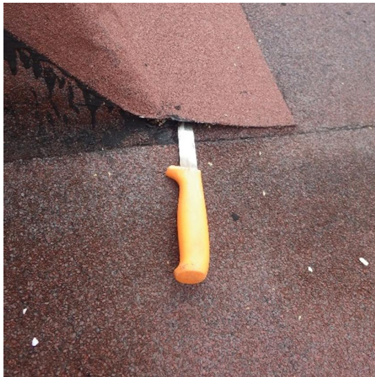
Kuva 50. Liikunta-/ruokalasiiven vesikaton bitumikermässä havaittiin paikallisia kohtia, joissa bitumikermi tartunta alustaansa on heikko ja vedellä on pääsy kermikerrosten väliin.
