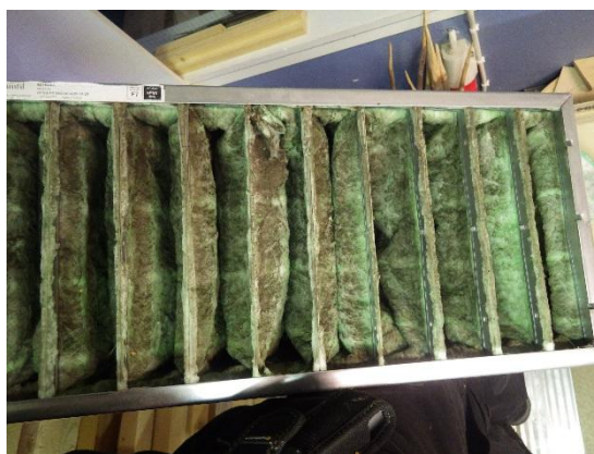
Kuva 77 a ja b. Suodatusluokka on F7. Suodattimet ovat jonkin verran likaantuneet.
