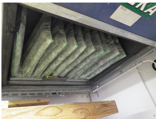
Kuva 77 a ja b. Suodatusluokka on F7. Suodattimet ovat jonkin verran likaantuneet.
