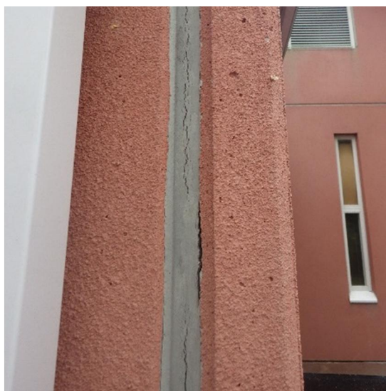
Kuvat 32 a ja b. Laajennusosalla on betonisandwich-elementtirakenteiset ulkoseinät. Liikuntasalin nurkassa yhdessä elementissä rauditus on paljastunut (ympyröity kuvan punaisella). Elementtisaumoissa havaittiin paikoitellen halkeamia (oikea kuva).
