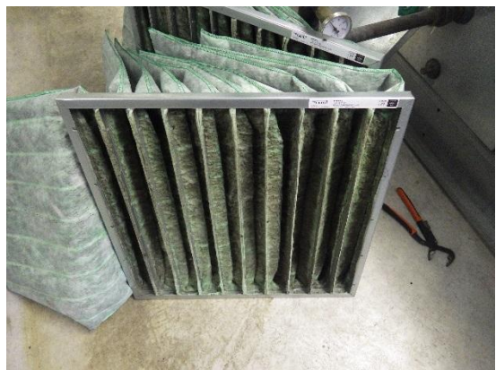
Kuva 69 a ja b. Tuloilmasuodattimien välissä ei ole tiivistettä, eikä suodatinkehikossa ole pintaa, johon suodattimen etureuna tiivistyisi suodattimien välisessä kohdassa.
