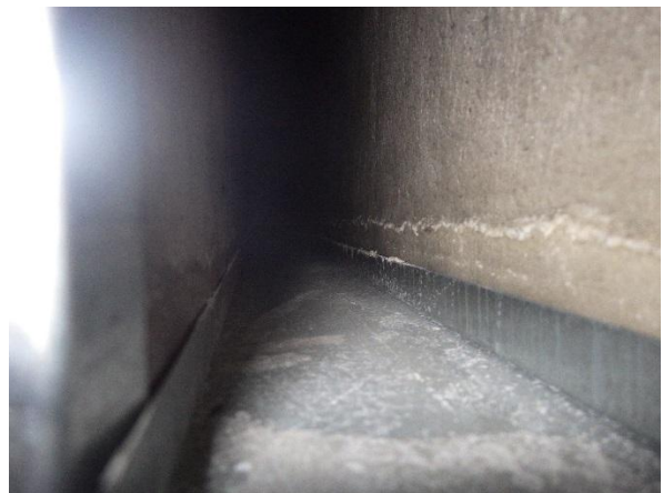
Kuva 58 a ja b. Äänenvaimentimien vaimenninpinnat on suojattu kuitukankaalla. Poistoilmapuolella näkyy äänenvaimentimessa kosteuden aiheuttamia jälkiä.
