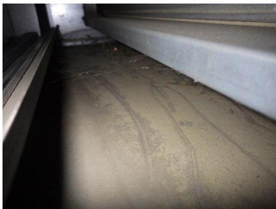
Kuva 62 a ja b. Koneessa on ennen suodatusosaa melko paljon likaa.
