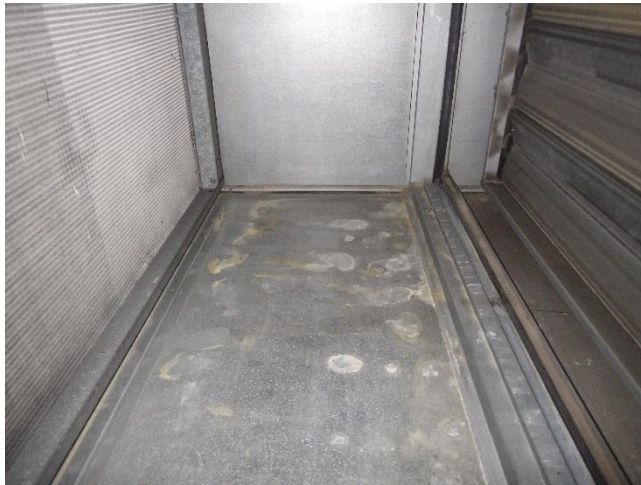
Kuva 70. Tuloilmasuodattimien suodatinkammiossa on kosteusjälkiä.
