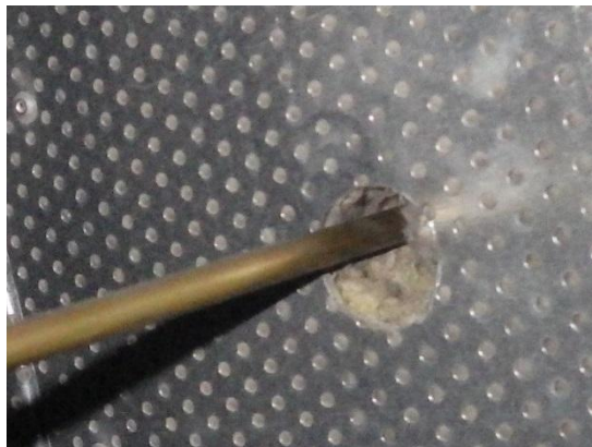
Kuva 73 a ja b. Poistoilmakammio on puhdas. Lämpömittarin läpivienti on tiivistämättä sisäpuolelta.
