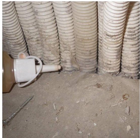
Kuva 10. Luokkasiiven laajennusosalla teknisen työn tiloissa (tilat 062...064) havaittiin epätiivaitä rakenneliittymiä (vasen kuva) ja epätiivaitä läpivientejä (oikea kuva). Tutkimushetkellä epätiivaitveyskohdista ei havaittu ilmapirtausta eikä poikkeavaa hajua.
