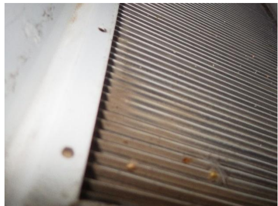
Kuva 83. Koneen karkeasuodattimet sijaitsevat ennen LTO-kennoa. Tuloilmassa on lisäksi hienosuodatin, joka sijaitsee ilmavirran suunnassa puhaltimen jälkeen.
