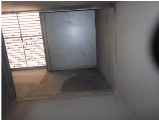
Kuva 54 a ja b. Raitisilmakammiossa on vähäisiä kosteusjälkiä. Raitisilmapelti sulkeutuu tiiviisti.
