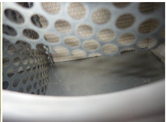
Kuva 90 a ja b. Teknisen työn luokan päätelaite avattuna. Vaimennuspinnat on suojattu lasikuitukankaalla.
