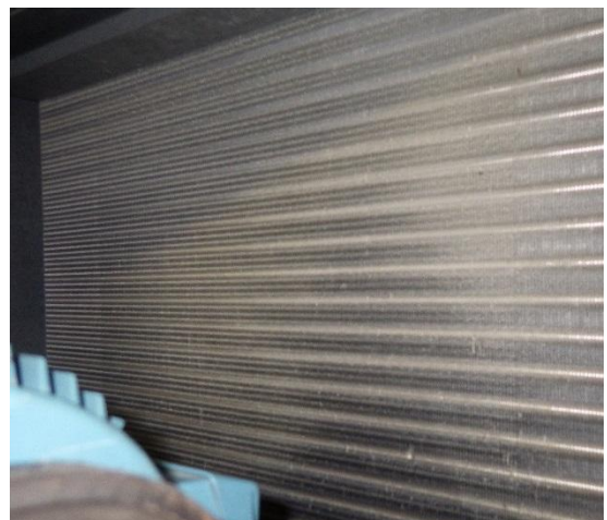
Kuva 63. Suodattimet ovat jonkin verran likaantuneet. Suodatusluokka on F7.
