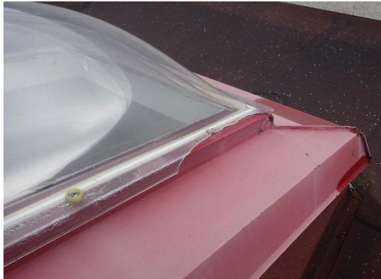
Kuva 49. Ruokalan ja aulan yläpuolella sijaitsevissa kattoikkunoissa havaittiin muutama halkeama. Muutoin ikkunat olivat hyväkuntoiset ja tiiviit.
