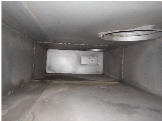
Kuva 67 a ja b. Raitisilmakammiossa sisällä ja kanavistossa ulkopuolella on kosteusjälkiä.
