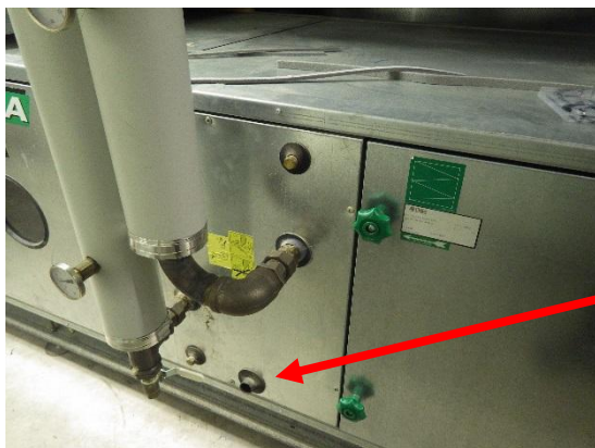
Kuva 74 a ja b. Putkiläpivienti on tulppaamatta ja siitä on koneen käydessä merkittävä ilmavirtaus iv-konehuoneesta poistoilmakoneen sisälle.
