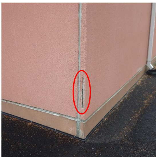
Kuvat 32 a ja b. Laajennusosalla on betonisandwich-elementtirakenteiset ulkoseinät. Liikuntasalin nurkassa yhdessä elementissä rauditus on paljastunut (ympyröity kuvan punaisella). Elementtisaumoissa havaittiin paikoitellen halkeamia (oikea kuva).
