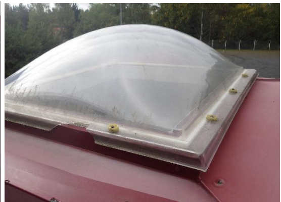
Kuva 49. Ruokalan ja aulan yläpuolella sijaitsevissa kattoikkunoissa havaittiin muutama halkeama. Muutoin ikkunat olivat hyväkuntoiset ja tiiviit.
