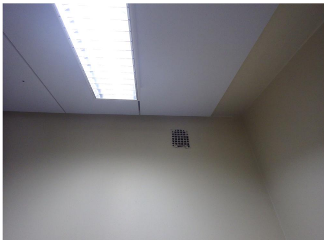
Kuva 91. Vanhoja painovoimaisen ilmanvaihdon venttiileitä on paikoin näkyvissä, esim. luukkasiiven porrashuoneessa.
