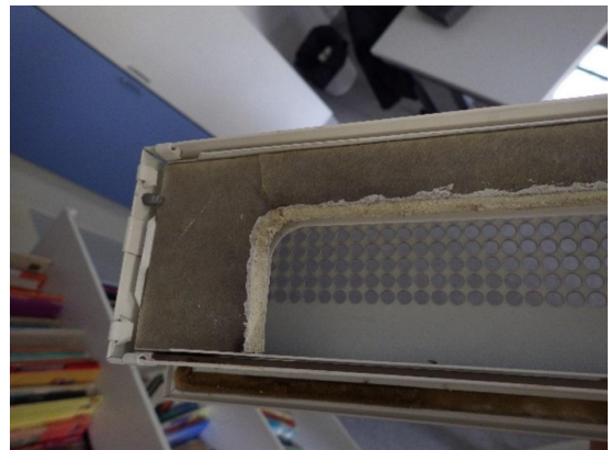
Kuva 89 a ja b. Tuloilman päätelaitteen villapintoja on näkyvissä. Reunapintoja on osin käsitelty maalilla.
