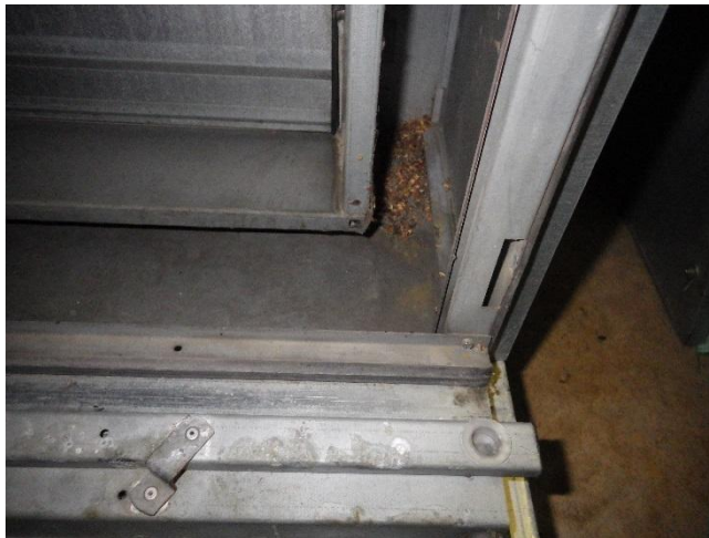
Kuva 55. Raitisilmapellin jälkeen, ennen suodatusosaa, on jonkun verran roskaa.
