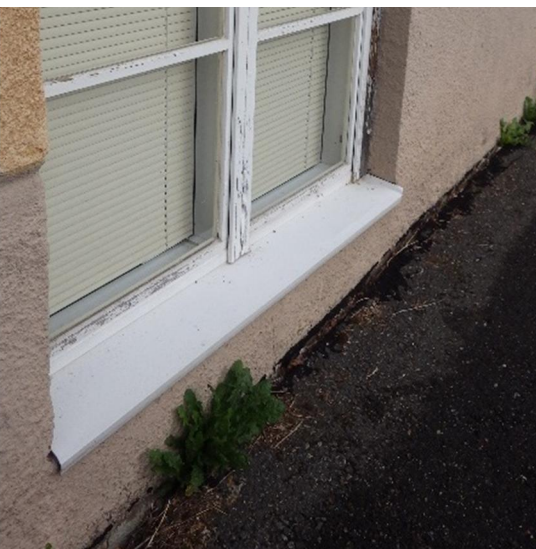
Kuvat 33 a ja b. Laajennusosan ikkunoiden pellitysten kallistus on riittävä (a). Alkuperäisen osan ikkunoiden pellitysten kallistus on hyvin loiva (b).
