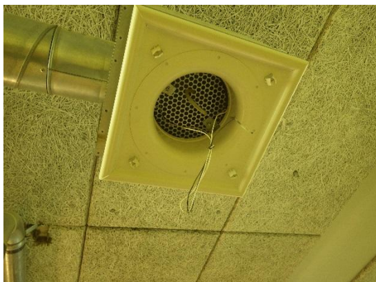
Kuva 90 a ja b. Teknisen työn luokan päätelaite avattuna. Vaimennuspinnat on suojattu lasikuitukankaalla.
