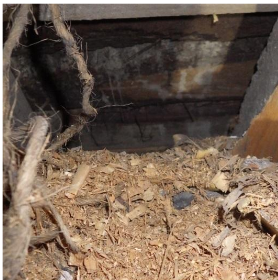
Kuva 27. IV-kotelointien yläpuolella on joitakin avonaisia läpivientejä, joista havaittiin orgaanista täyttömateriaalia (kutterinlastu) ja muottilaudoja, joissa havaittiin betonivalun aikana tarttunutta betonia.
