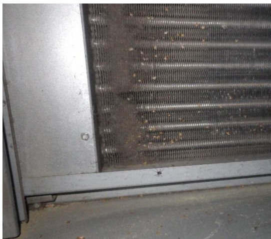
Kuva 64 a ja b. LTO-patteri on erittäin likainen.
