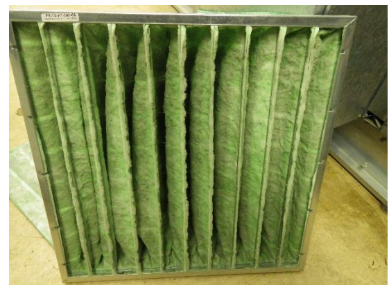
Kuva 56 a ja b. Sekä tulo- että poistoilmasuodattimien suodatusluokka on F7. Tuloilmasuodatin on selkeästi enemmän likaantunut kuin poistoilmasuodatin. Koneiden suodatinkehysten lukitukset olivat erittäin jäykät.
