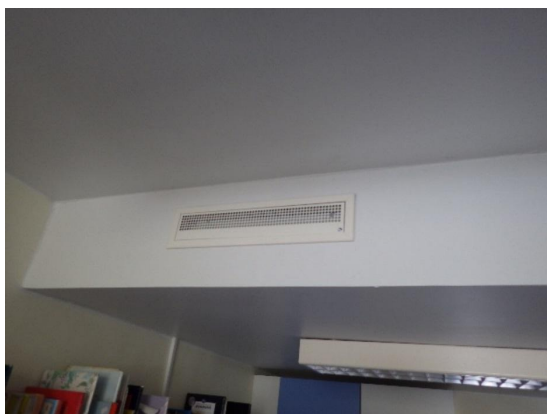
Kuva 87 a ja b. Luokkatilojen alkuperäinen tuloilman päätelaite. Päätelaitteet olivat sieltään paikoin likaisia.
