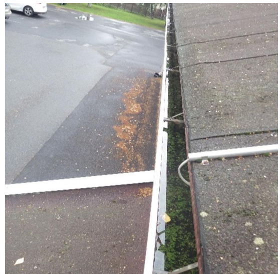
Kuva 45. Räystäskourut ja syöksytorvien yläpäävät olivat paikoin tukossa ja täynnä vettä.
