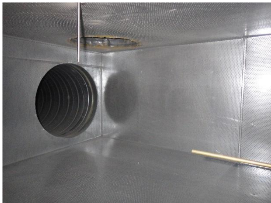
Kuva 73 a ja b. Poistoilmakammio on puhdas. Lämpömittarin läpivienti on tiivistämättä sisäpuolelta.
