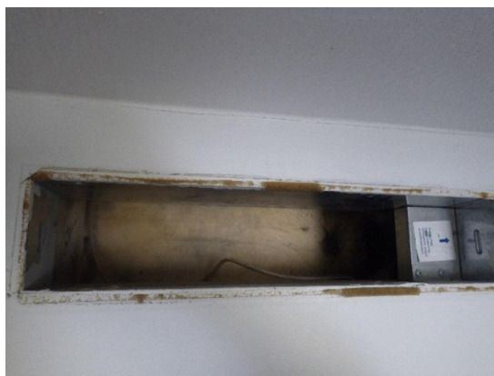
Kuva 87 a ja b. Luokkatilojen alkuperäinen tuloilman päätelaite. Päätelaitteet olivat sieltään paikoin likaisia.
