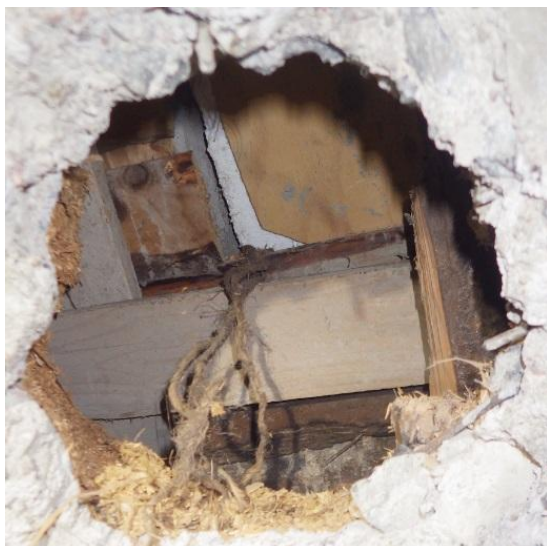
Kuva 27. IV-kotelointien yläpuolella on joitakin avonaisia läpivientejä, joista havaittiin orgaanista täyttömateriaalia (kutterinlastu) ja muottilaudoja, joissa havaittiin betonivalun aikana tarttunutta betonia.
