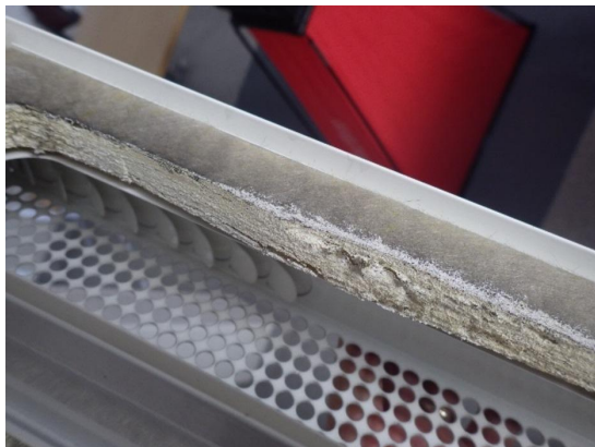
Kuva 89 a ja b. Tuloilman päätelaitteen villapintoja on näkyvissä. Reunapintoja on osin käsitelty maalilla.
