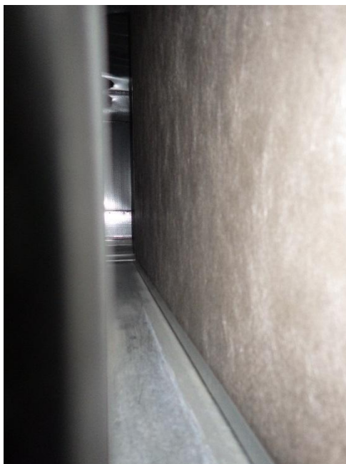
Kuva 58 a ja b. Äänenvaimentimien vaimenninpinnat on suojattu kuitukankaalla. Poistoilmapuolella näkyy äänenvaimentimessa kosteuden aiheuttamia jälkiä.
