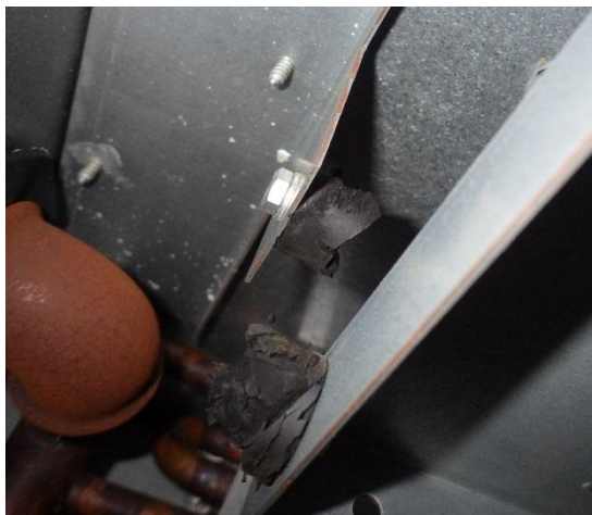
Kuva 80 a ja b. Kaksi puhaltimen yhteensä neljästä vaimennuskumista on katkennut ja puhallin roikkuu kahden vaimennuskumin varassa.
