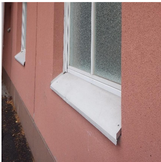
Kuvat 33 a ja b. Laajennusosan ikkunoiden pellitysten kallistus on riittävä (a). Alkuperäisen osan ikkunoiden pellitysten kallistus on hyvin loiva (b).
