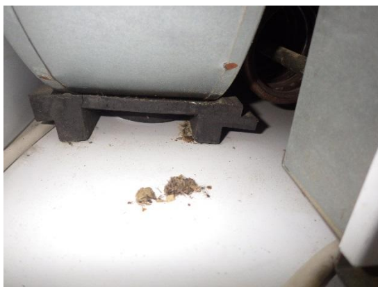
Kuva 85. Kone on sisäosiltaan hyvin likainen.
