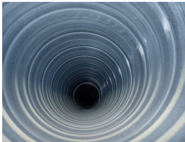
Kuva 46 Tuloilmakanavassa havaittavissa ohut pölykerros
