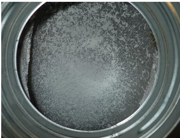
Kuva 41. Hallitason pukuhuoneiden tuloilmakanavana on käytetty välipohjan (betoni) onteloita
