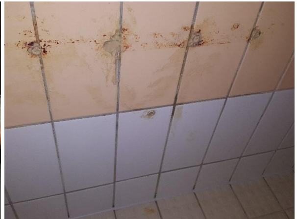
Kuva 23: Vanhojen kiinnitysten tiivistyksiä.
