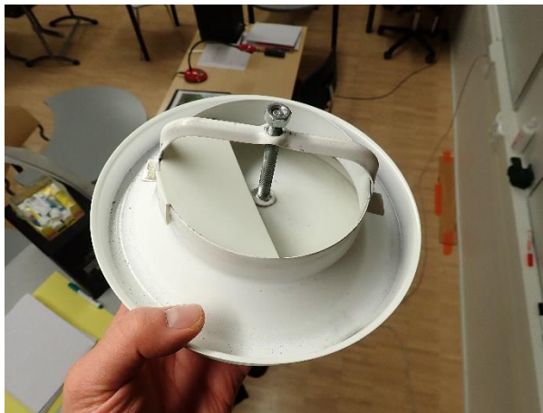
Kuva 48. Luokkatiloissa käytetyt tuloilman lautasventtiilit ovat varustettu suuntauslevyillä
