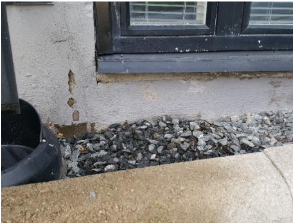
Kuva 21. Syöksyputkesta rännikaivoon tulevat vedet kastelevat viereistä sokkelirakennetta. Viereisen ikkunan vesipellin kiinnitys on puutteellinen.
