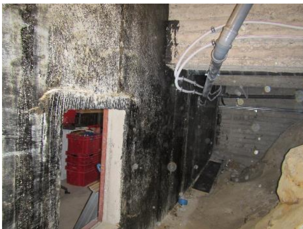
Kuva 9. Yksi seinistä päällystetty bitumilla.
