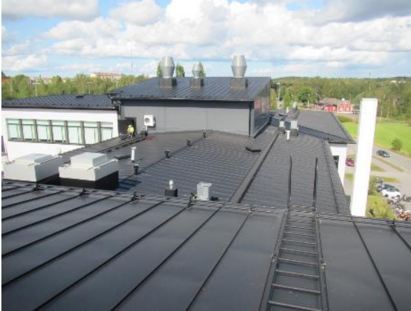
Kuva 19. Yleiskuva 70-luvun rakennuksen vesikatosta.
