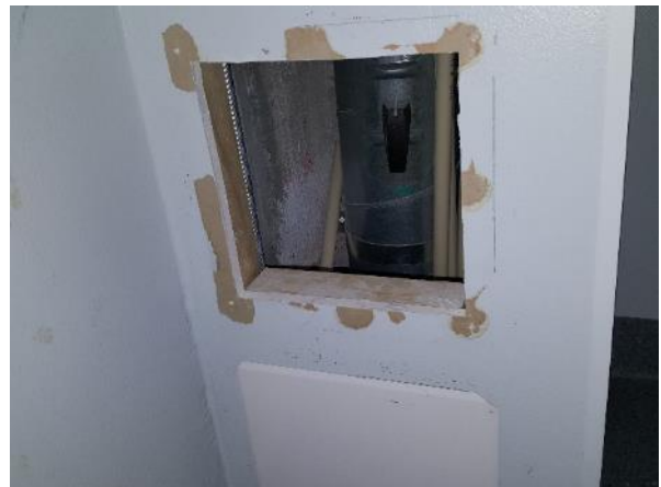
Kuva 32. Opetustilan 146 kotelon sisäpuolelta aistittavissa mikrobiperäistä hajua.
