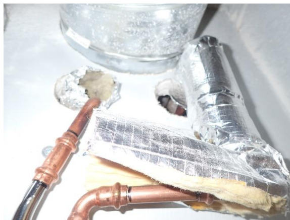
Kuva 74. Läpivientejä tilasta 215 katsottuna.
