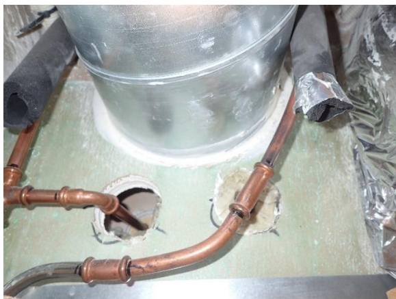
Kuva 73. Läpivientejä tilasta 217 katsottuna.
