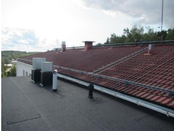
Kuva 13. Kiinteistön 50-luvun osalla on tiilikate.
