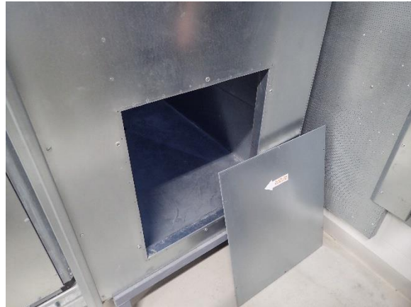
Kuva 47. Raitisilman alakammion tarkastusluukku.
