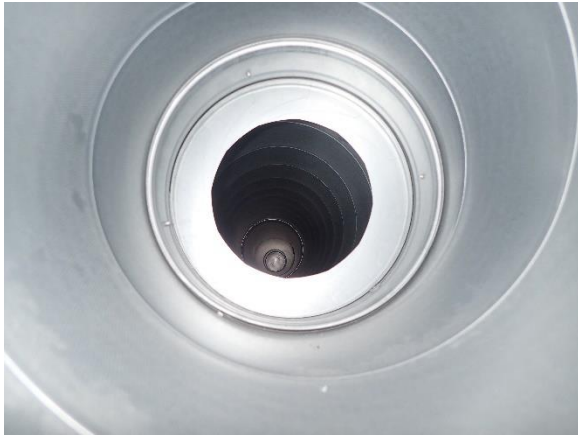
Kuva 64. Tuloilmakanava (tila 411), ei merkittävää pölykertymää.
