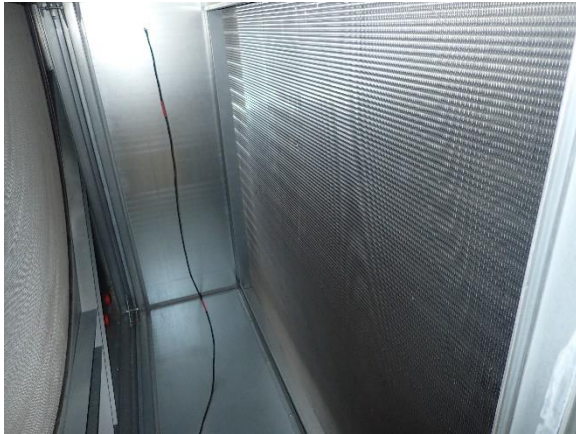
Kuva 60. Lämmityspatterin havaittiin olevan puhdas.
