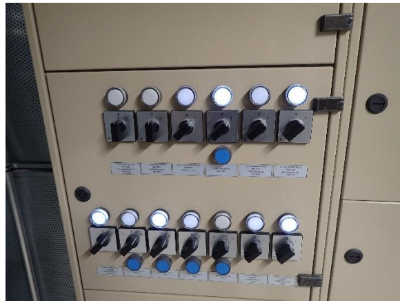
Kuva 53. Ilmanvaihtokoneiden ohjauskytkimiä.
