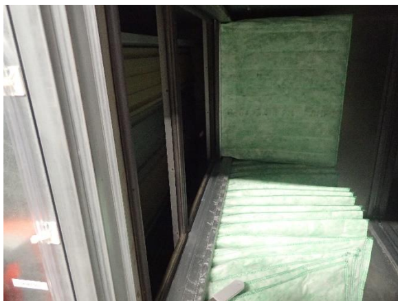
Kuva 58. Suodattimet ovat elokuussa uusitut.
