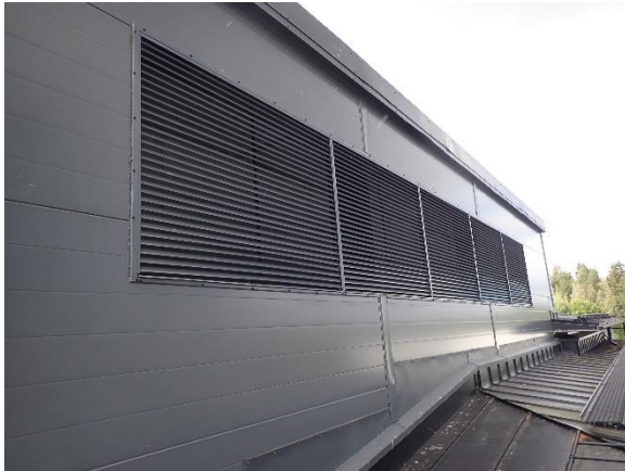
Kuva 46. TK02...05 raitisilmasäleiköt
