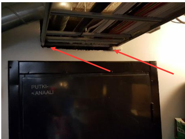
Kuva 34. Tilan 101.1 (siiv.var) ja putkikanaalin välisen väliseinän läpiviennit tiivistämättömiä.
