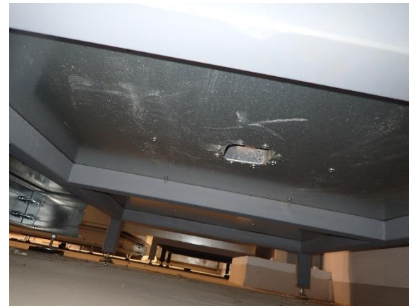
Kuva 49. Yleiskuva raitisilmakammion alaosan pohjasta. Viemäröntiä ei ole toteutettu putkittamalla, vaan vedet valuvat suoraan lattialle jonka kaadoista ei ole varmuutta.
