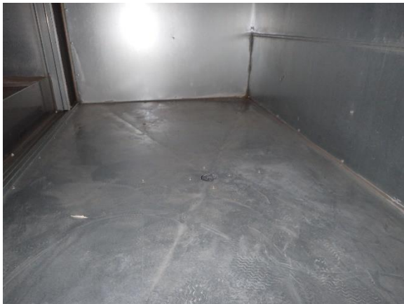
Kuva 48. Yleiskuva raitisilmakammion alaosasta. Havaittavissa pölyisyyttä, sekä viemäröntiliitin, johon ei ole liitytty putkittamalla.
