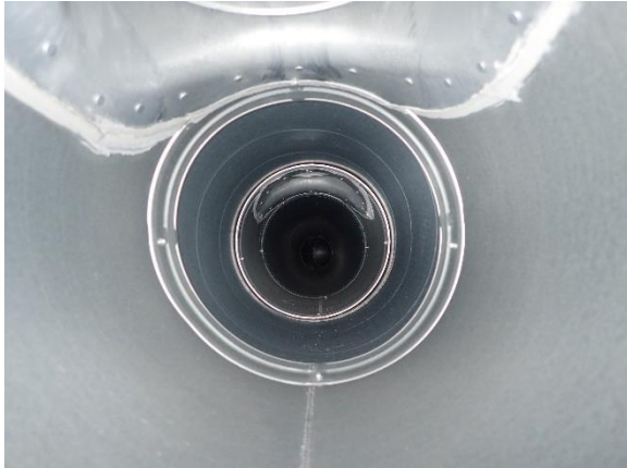
Kuva 62. Tuloilman kanava (tila 255), ei merkittävää pölykertymää.
