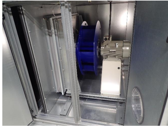
Kuva 51. Yleiskuva tuloilmanpuhaltimesta.
