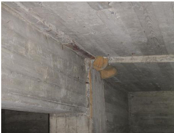
Kuva 11. Läpivienti tukittu eristevillalla.
