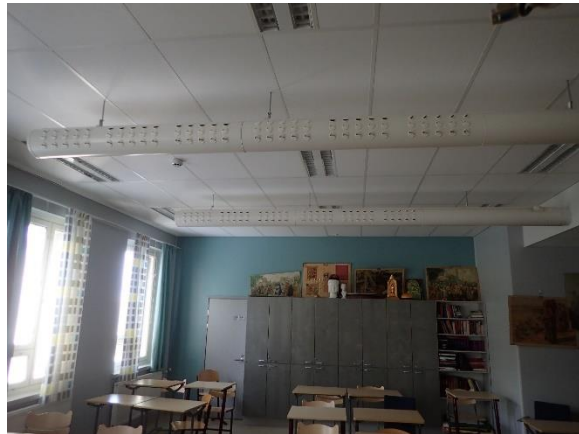
Kuva 70. Osassa luokkatiloja oli suutinkanavia.
