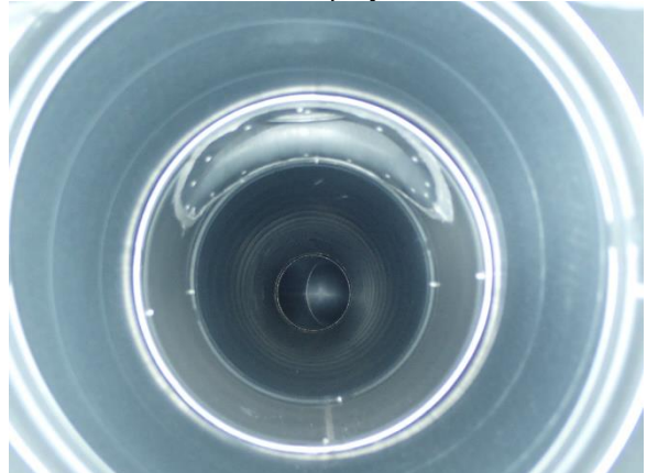
Kuva 63. Tarkennuskuva tuloilman kanavasta tilassa 255.
