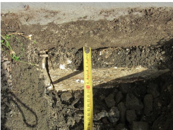
Kuva 5. 70-luvulla rakennetun sokkelin ulkopinnassa on paikoitellen lämmöneristeet.
