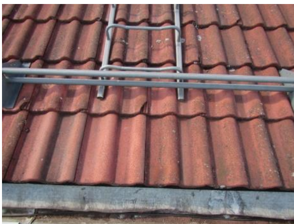
Kuva 17. Katteesta on lohkeillut palasia useasta kohtaa.
