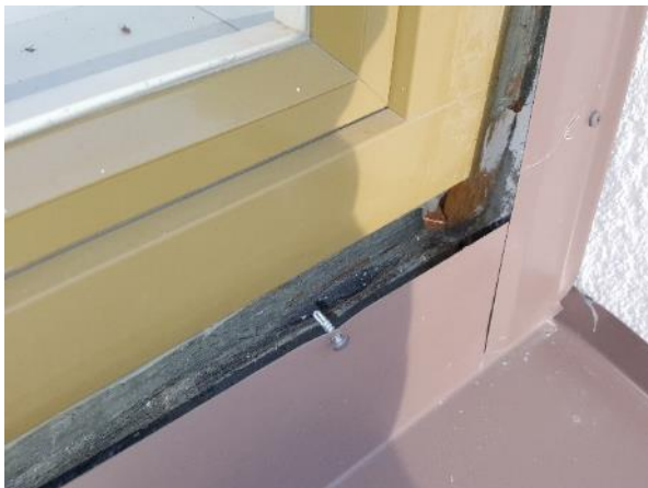
Kuva 23. 50 – luvun ikkunoiden vesipellitysten kiinnitykset ovat paikoitellen puutteelliset. Kuvassa havaittavissa alkuperäisiä harmaantuneita ikkunakarmeja.
