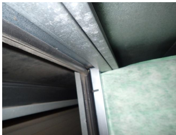
Kuva 59. Suodatinten tiivistepinnat ovat tiiviit ja puhtaat.
