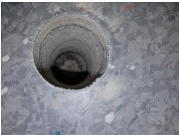
Kuva 36. 287 Opettajainhuone, betonilaattojen välissä oleva bitumisively.
