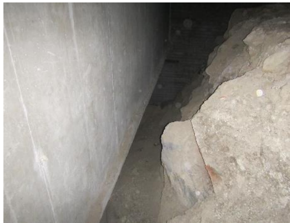
Kuva 12. Ryömintätallassa louhittua kalliota.
