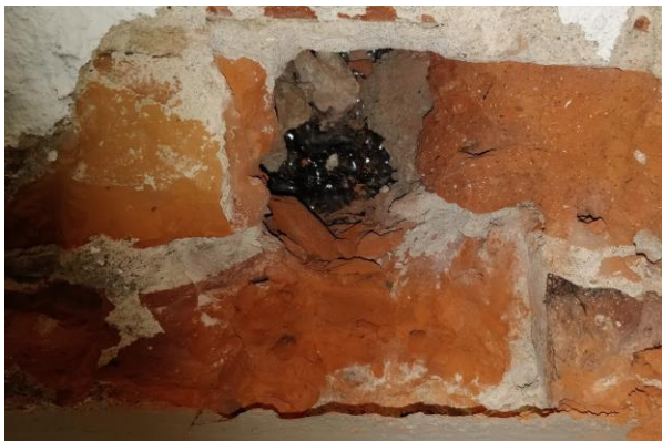
Kuva 2. Vanhan puolen kellarin maanvastaisen seinän bitumisively sisältää PAH-yhdisteitä.
