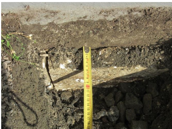
Kuva 5. 70-luvulla rakennetun sokkelin ulkopinnassa on paikoitellen lämmöneristeet.
