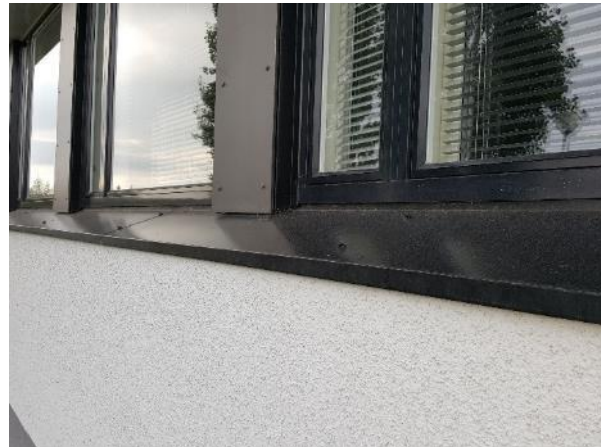
Kuva 22. Ikkunoiden vesipeltien kiinnitykset ovat paikoitellen hyvin toteutetut.
