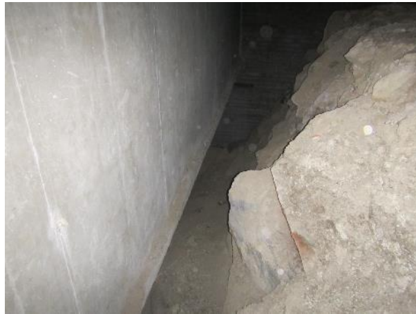
Kuva 12. Ryömintätilassa louhittua kalliota.
