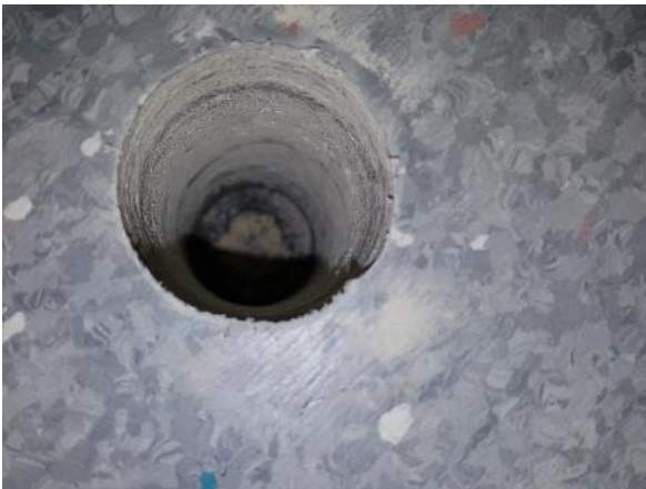
Kuva 36. 287 Opettajainhuone, betonilaattojen välissä oleva bitumisively.
