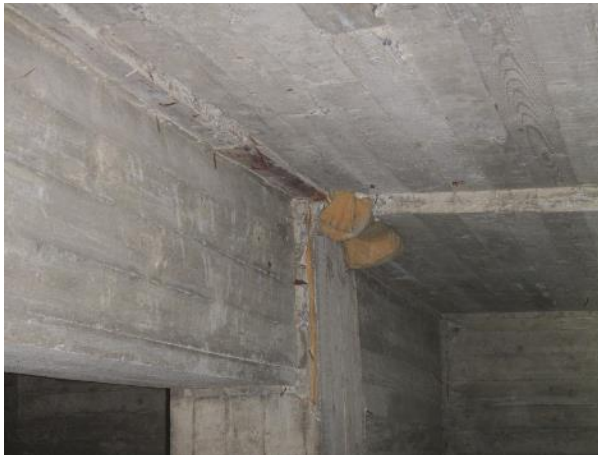
Kuva 11. Läpivienti tukittu eristevillalla.
