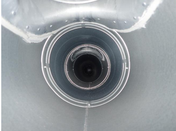
Kuva 62. Tuloilmakanava (tila 255), ei merkittävää pölykertymää.
