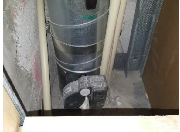
Kuva 41. Kuva hormin sisäpuolelta
