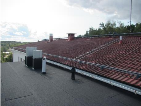
Kuva 13. Kiinteistön 50-luvun osalla on tiilikate.
