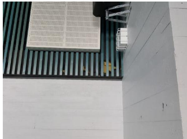
Kuva 35. Liikuntasalin puusäleikön takana näkyviä mineraalivillaeristeitä.
