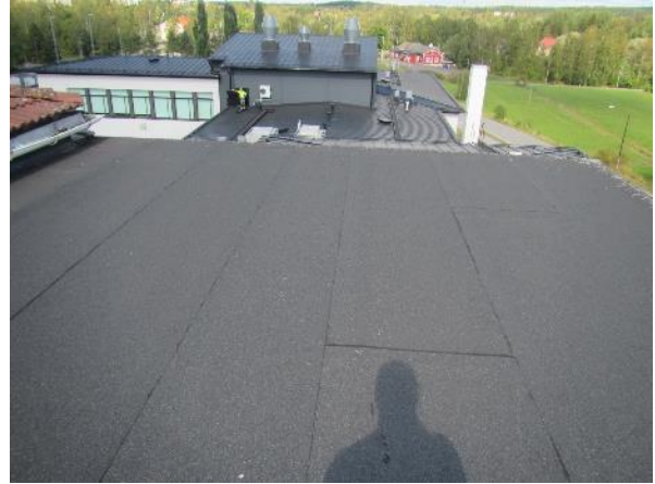
Kuva 20. 50-luvun osan viereisessä vesikatossa (IV-konehuone) on bitumihuopakate.
