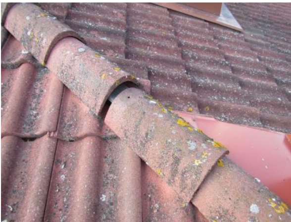
Kuva 15. Harjalimitys on epätiivis.
