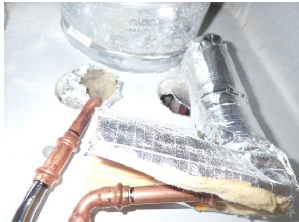
Kuva 74. Läpivientejä tilasta 215 katsottuna.
