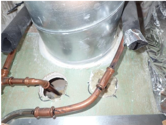
Kuva 73. Läpivientejä tilasta 217 katsottuna.
