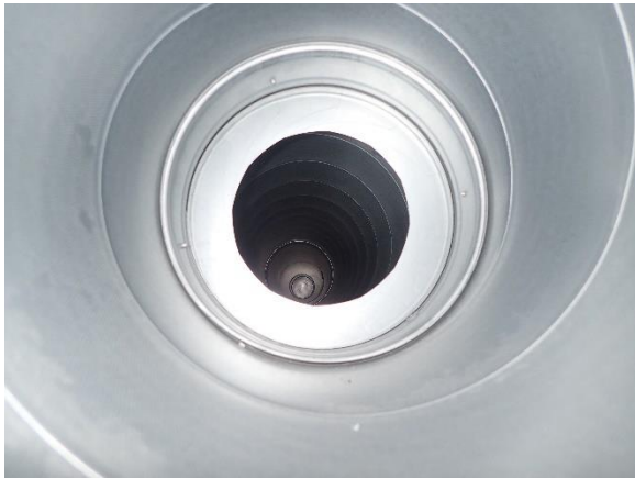
Kuva 64. Tuloilmakanava (tila 411), ei merkittävää pölykertymää.
