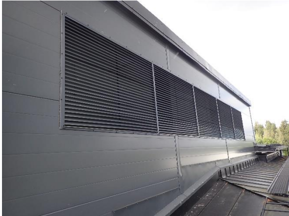
Kuva 46. TK02...05 raitisilmasäleiköt
