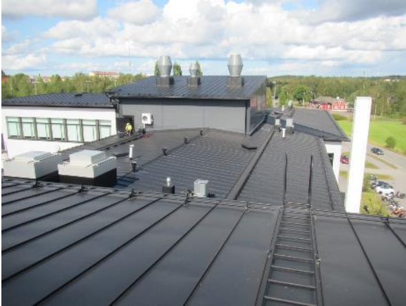
Kuva 19. Yleiskuva 70-luvun rakennuksen vesikatosta.
