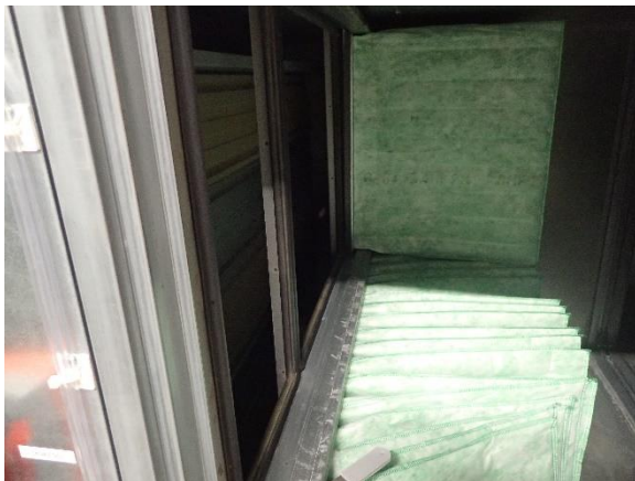
Kuva 58. Suodattimet ovat elokuussa uusitut.
