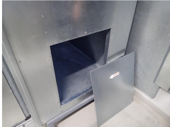
Kuva 47. Raitisilman alakammion tarkastusluukku.
