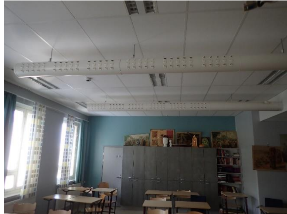
Kuva 70. Osassa luokkatiloja oli suutinkanavia.
