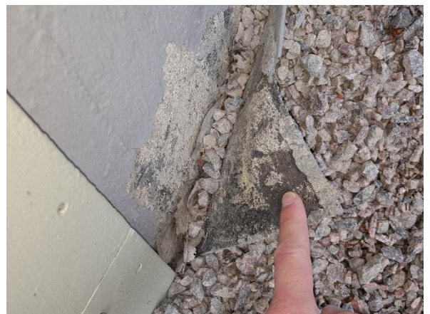
Kuva 6. 70-luvulla rakennetun sokkelin ulkopinnassa on vedeneristysmateriaalina bitumihuopa.
