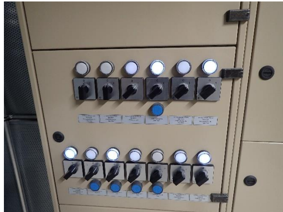
Kuva 53. Ilmanvaihtokoneiden ohjauskytkimiä.
