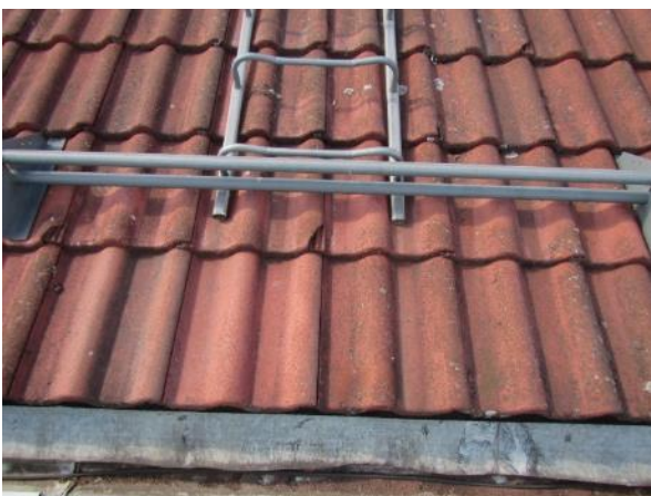
Kuva 17. Katteesta on lohkeillut palasia useasta kohtaa.
