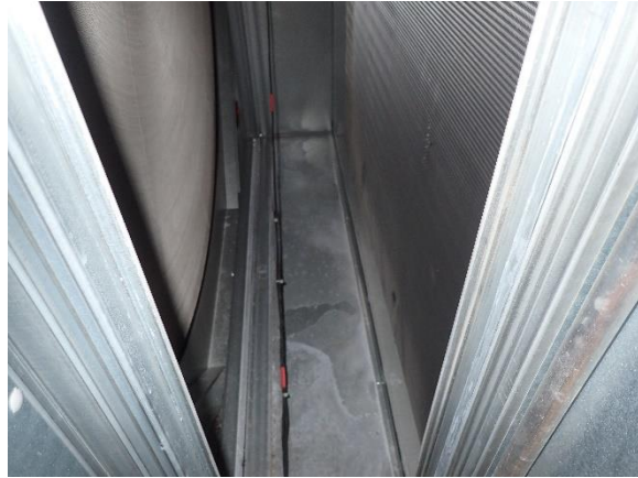
Kuva 61. LTO-kiekon ja lämmityspatterin pinnat olivat järjestäen puhtaat.
