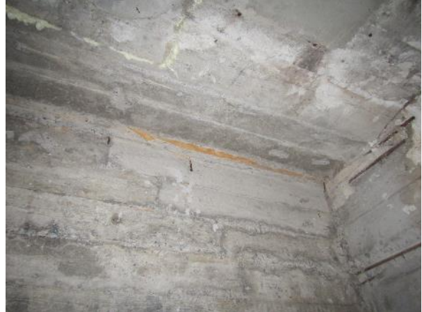
Kuva 8. Raudoitusteräket paikoitellen ruostuneet.
