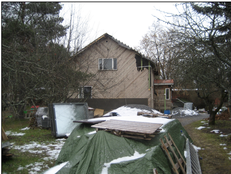
Ulkopuolelle lisätään puukuitulevyä. 80-luvun ikkunat vaihdetaan.
