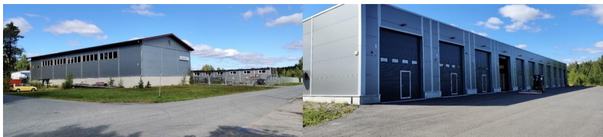
Kuva 5. Jokiniementien puolella olevat teollisuus- ja varastorakennus. (FCG Oy, 2022)
