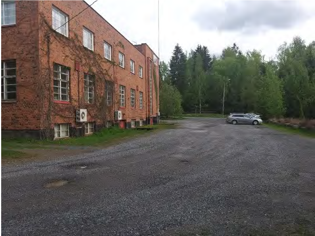
Kuva 1. Keilahallin länsipuolista aluetta 27.5.2022.
