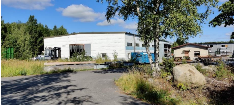
Kuva 7. Jokitien puolella oleva teollisuusrakennus ja taukotila (FCG Oy, 2022)
