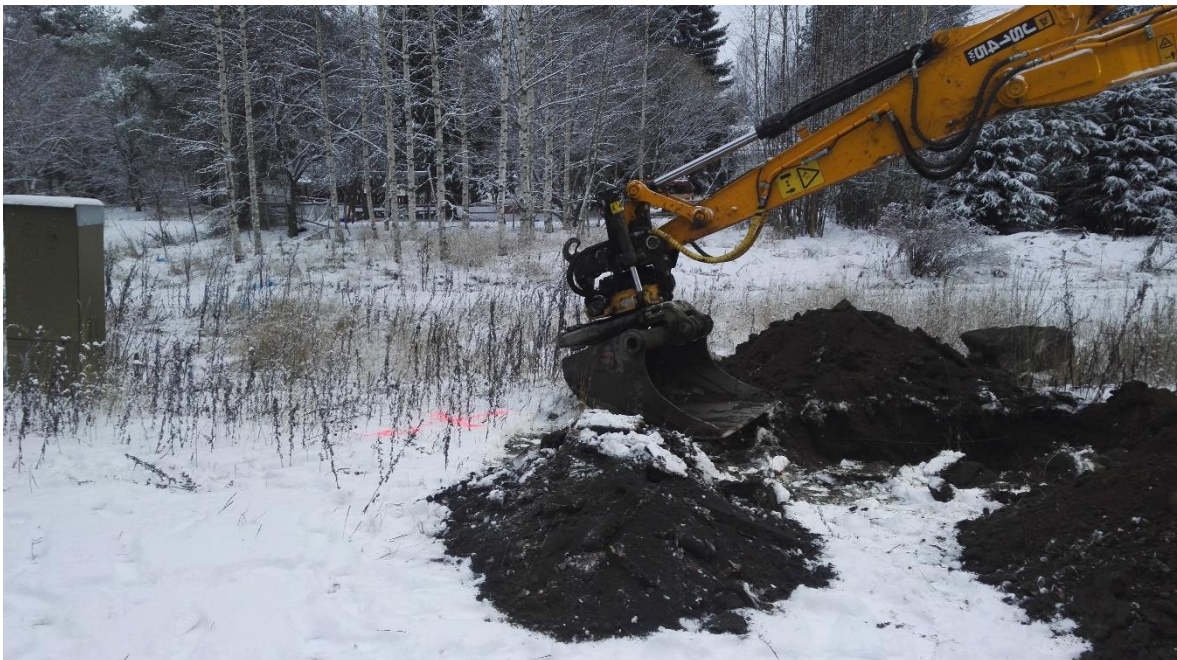
Kuva 2: Koekuoppa S2, koekuopassa kaapeli näkyvillä.
