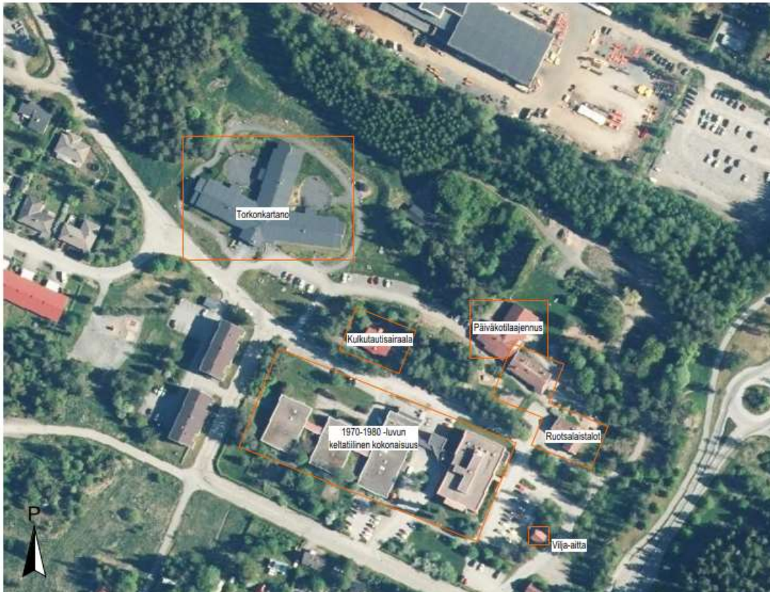
Toijalan vanhan terveysaseman alue
