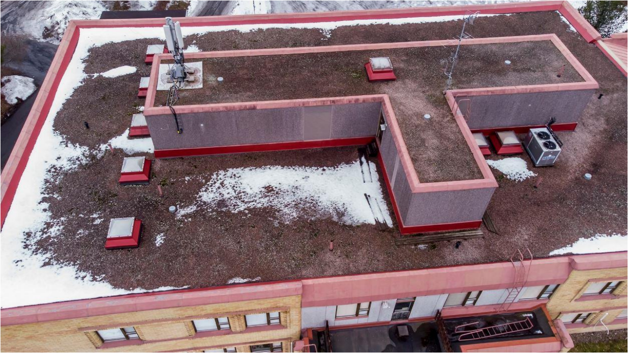
Kuva 5. Akaan toijalan Hakalehdon vanhainkodin kattorakenteita kuvattuna dronella 23.3.2023. Kuvassa näkyy ainakin rakennusten ilmastointiin käytettyjä rakenteita. Kuva © Harri Hedman.
