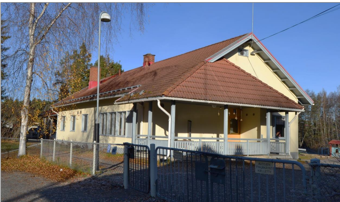
Kuva 38. Päiväkotirakennuksen alkuperäinen osa kaakosta kuvattuna.
