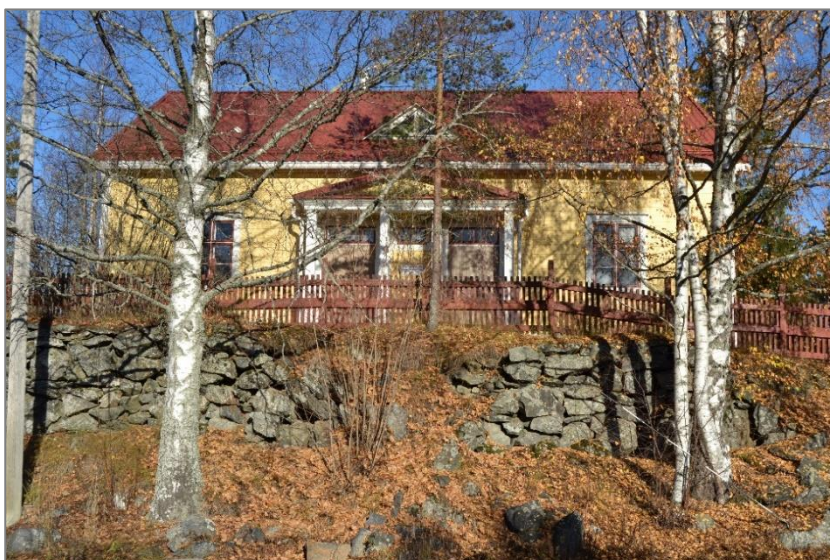
Kuva 44. Rakennuksen edustan rinne on pengerretty luonnonkivimuurilla.
