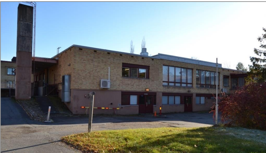
Kuva 13. Hakalehdon A-osa kuvattuna luoteesta. Pääkerroksen nauhaikkunoiden takana sijaitsevat ruokasali ja kuntosali.
