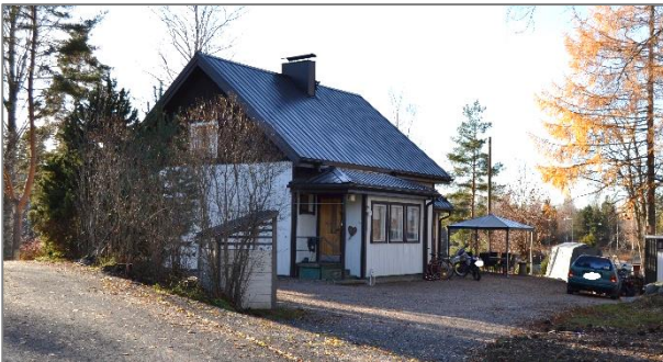
9 Loukontie 7, asuinrakennus kiinteistötunnus: 20-2-59-20 rakennustunnus: 101632125M rakennusvuosi (kiinteistörekisterin mukaan): 1900
