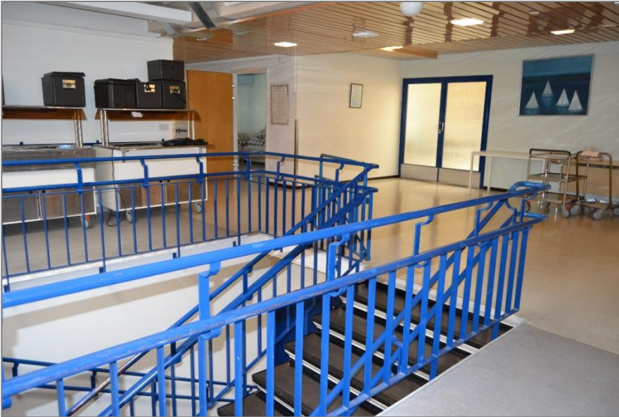
Kuva 26. A-osan keskusaulaa ja portaikko. Aulan lattioissa ja portaissa on käytetty muovimattoa ja vinyylilaattaa.
