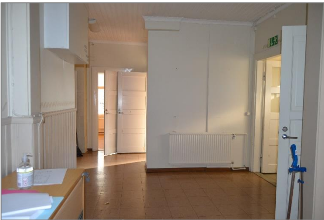
Kuva 48. Näkymä aulasta. Rakennuksen latioissa on käytetty pääosin vinyylilaattaa ja muovimattoja.
