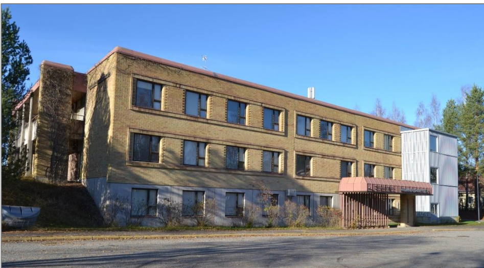
Kuva 7. Terveyskeskuksen itäpäätty parkkipaikalta kuvattuna. Tasakattoisessa, saumapellillä päällystetyssä hammashoitolan sisäänkäynnin katoksessa räystääslinja on aumattu ja alas laskeutuva katonlape muistuttaa hieman taitekattoa. Kuvan oikeassa reunassa näkyvä, profiilipellillä päällystetty hätäpoistumistie on tehty 2005.
