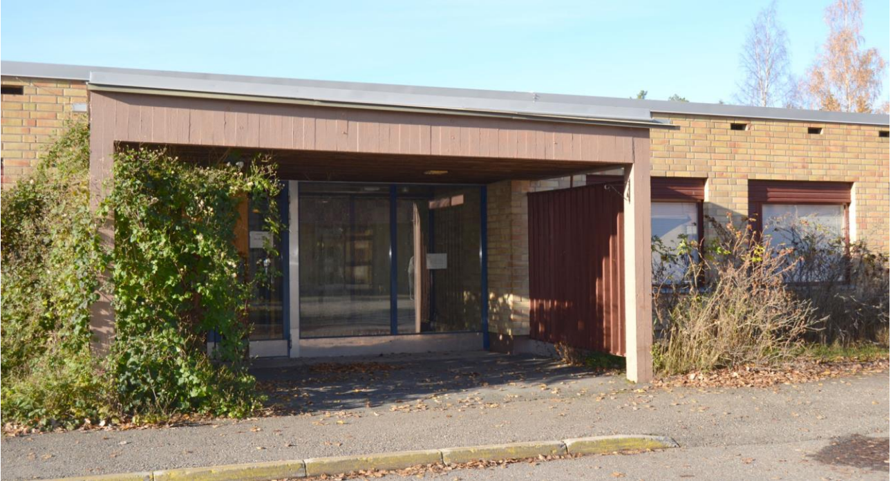
Kuva 17. Hakalehdon A-osan pääsisäänkäynti rakennuksen itäisivulla. Sisäänkäynnin edessä on betonivaluna toteutettu katos, jonka päädyissä on käytetty lankkusäleikköjä.
