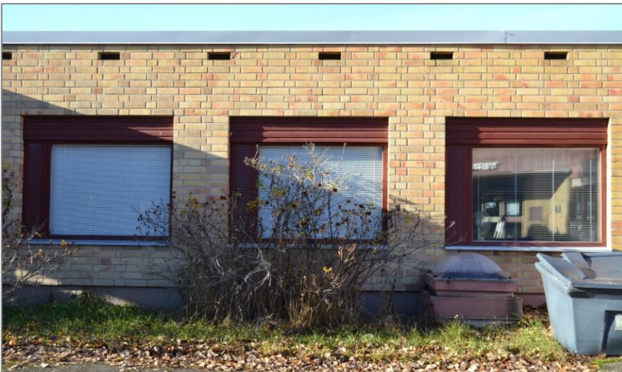
Kuva 14. A-osan julkisivua itään. Selkeälinjaisiin julkisivuihin luovat koristeellisuutta katonrajassa symmetrisesti sijaitsevat aukot muurauksessa. Ikkunoiden ympärillä on käytetty punaruskeaa vaakalaudoitusta. Oikeanpuoleisesta ikkunasta heijastuu terveyskeskuksen pääsisäänkäynti.
