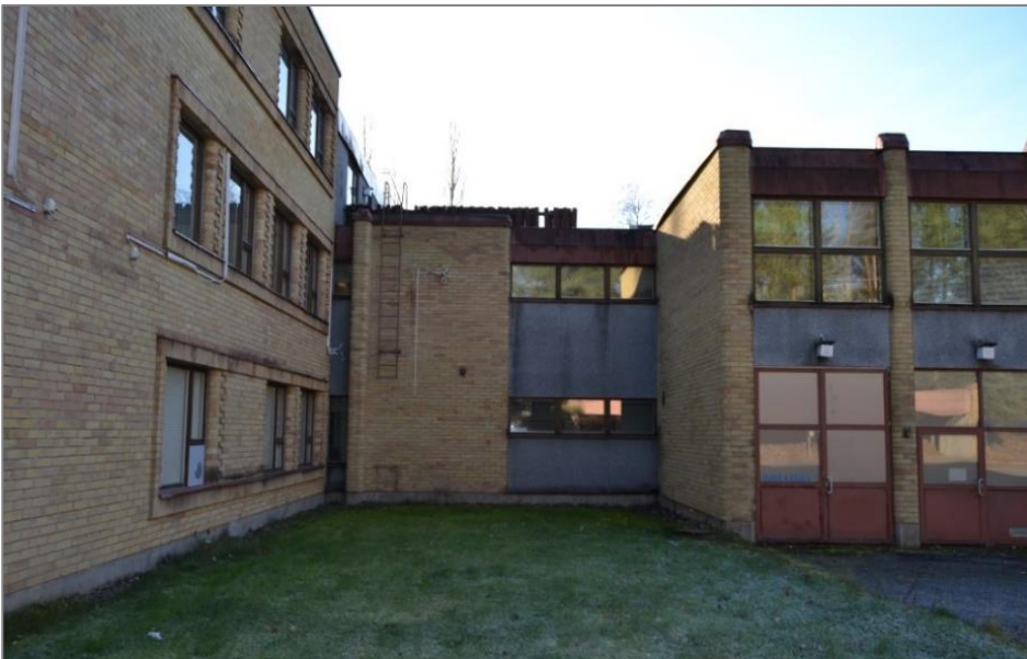
Kuva 11. Terveyskeskuksen ja Hakalehdon yhdistävä linkkiosa on pohjoispuolelta kaksikerroksinen. Alakerrassa on kuvassa oikealla näkyvät ambulanssitallit.
