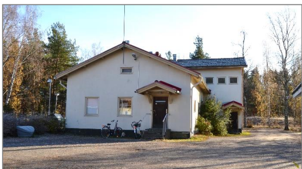
4a Entinen terveystalo rakennustunnus: 1008224481 rakennusvuosi: 1949
