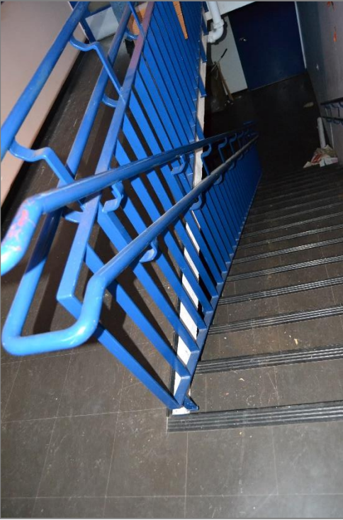
Kuva 22. C-osan kellariin johtava portaikko. Tilan lattiassa ja porrasaskelmissa on käytetty tummaa vinyylilaatta.
