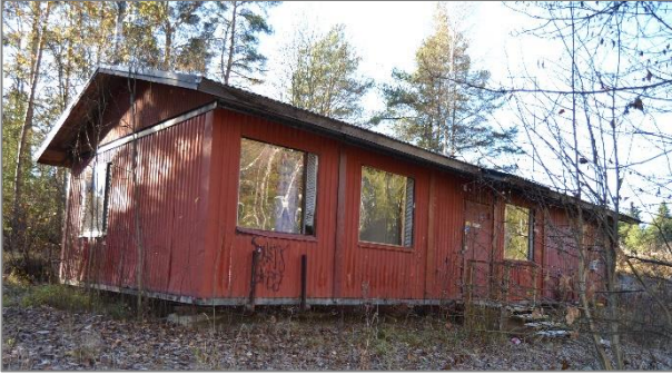
7 Toimistoparakki rakennustunnus puuttuu rakennusvuosi: 2004
