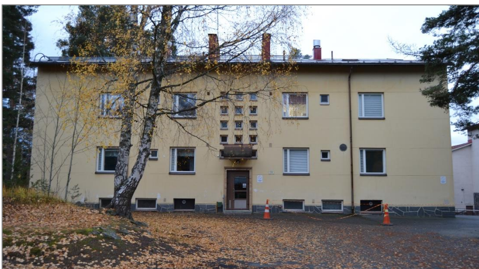
Kuva 66. Esikoulurakennuksen pääjulkisivu Mäntyseläntieltä kuvattuna.
