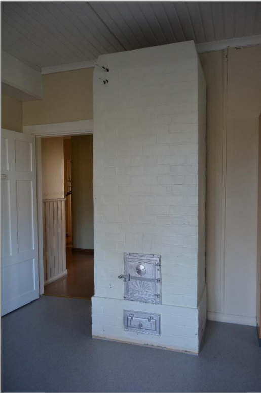
Kuva 50. Kahdessa huoneessa on säilynyt samanlaiset, tiilimuuratut tulisijat.
