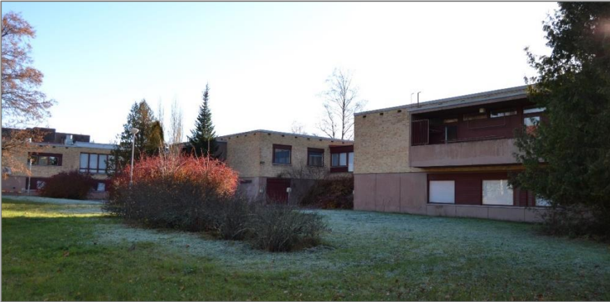
Kuva 16. Hakalehdon rakennuskokonaisuus ja piha-alueita kuvattuna luoteesta. Vasemmalla A-osa, keskellä B- ja oikealla C-osa.
