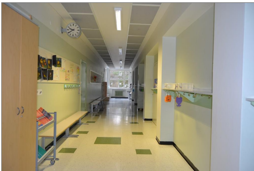
Kuva 60. Kuva toisen kerroksen käytävästä pohjoiseen päin. Käytävien lattioissa on vinyylilaatat, seinät ovat maalatut. Käytävien värit vaihtuu kerroksittain: kolmas kerros on beige, toinen kerros vihreä ja ensimmäinen sininen.
