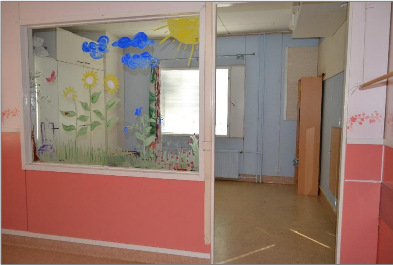
Kuva 37. Entisen terveystalon sisätilat on alakerrasta suurimmaksi osaksi muutettu, todennäköisesti 1980-luvulla päiväkodiksi muuttamisen yhteydessä. Lattioissa on muovimatot, seinät on pääosin levytetty ja maalattu. Katoissa on käytetty akustiikkalevyjä.
