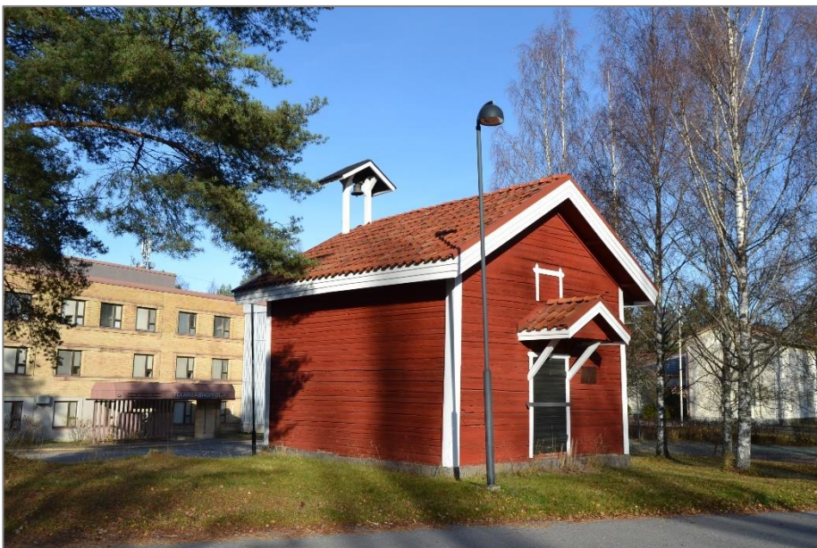
Kuva 29. Aitta kuvattuna kaakosta. Rakennus sijaitsee terveyskeskuksen asfaltoidun parkkipaikan reunalla. Taustalla vasemmalla näkyy terveysaseman hammashoitolan sisäänkäynti, oikealla Nahkialan päiväkodin rakennuksia.
