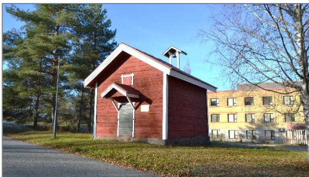
3 Iso-Rekolan aitta rakennustunnus puuttuu rakennusvuosi: 1900-luvun alku
