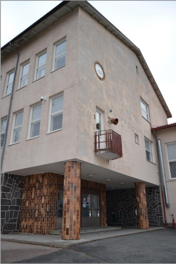
Kuva 55. Pääsisäänkäynti sijaitsee sisäänvedetyn katoksen suojissa ja on koristeltu klinkkerilaatoituksella.
