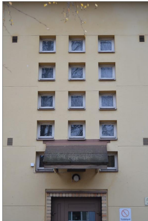
Kuva 2. Nahkialan esikoulun porrashuoneen ikkunat pääjulkisivussa.
