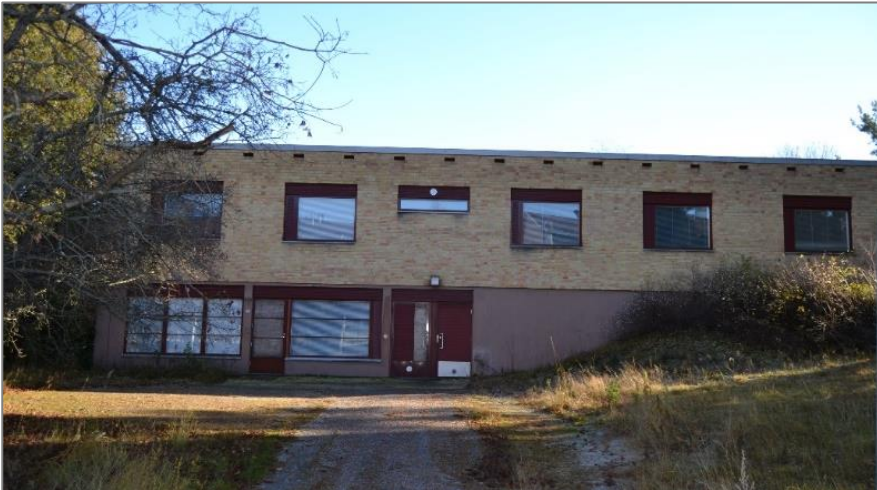
Kuva 15. C-osan julkisivua länteen. Hakalehdon rakennuksessa on sekä aukko- että nauhajulkisivuja.
