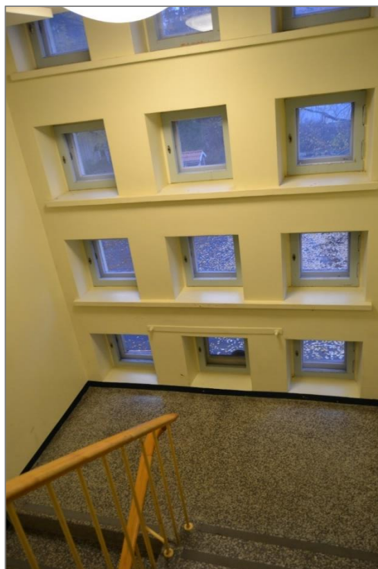
Kuva 69. Porraskäytävän mosaiikkibetonilattia, porraskaiteet ja ikkunat ovat alkuperäiset.
