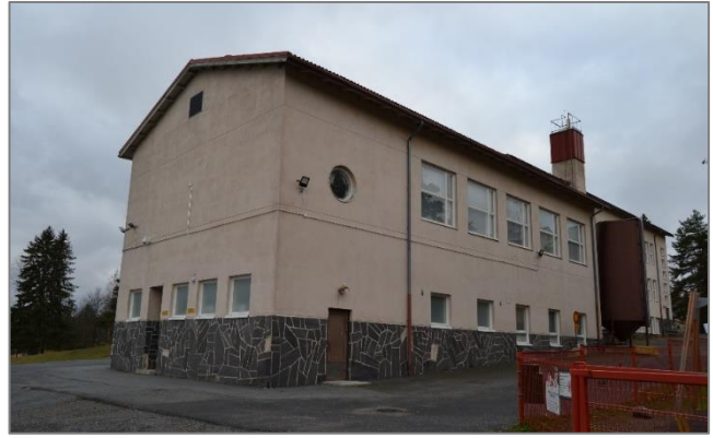
Kuva 57. Rakennuksen eteläpääty ja itäisivua.
