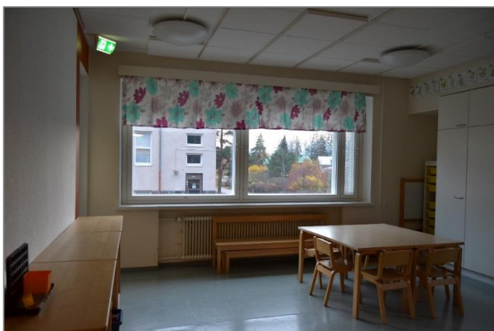
Kuva 70. Ensimmäisen kerroksen esikoulutila rakennuksen länsipäädystä.
