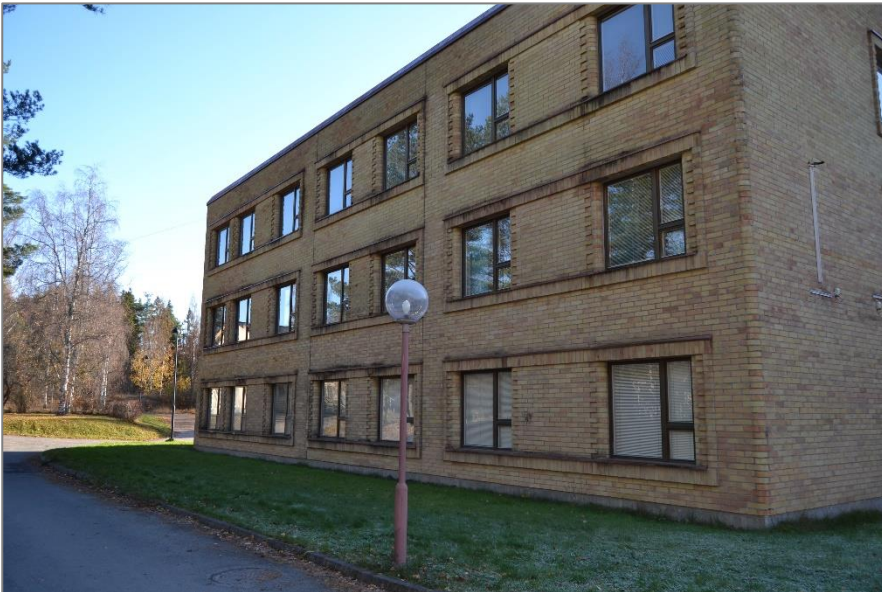
Kuva 8. Terveyskeskuksen pohjoisjulkisivua. Pyöristettyihin ikkunanreunoihin on toteutettu muuraukseen rustikointi. Ikkunarivejä kehystävät myös muuraukseen tehdyt, kohollaan olevat vaakalistat, jotka antavat aukkojulkisivulle myös nauhajulkisivun ilmettä. Terveyskeskuksen piha-alueen valaisinpylväät ovat ilmeisesti alkuperäisen pihasuunnitelman mukaiset.
