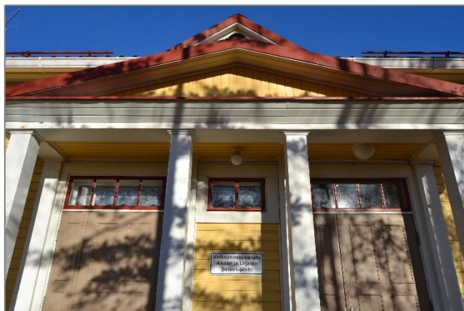
Kuva 42. Rakennuksen pääsisäänkäynti. Ovien välissä sijaitseva ikkuna on ollut alun perin kuusiruutuinen.
