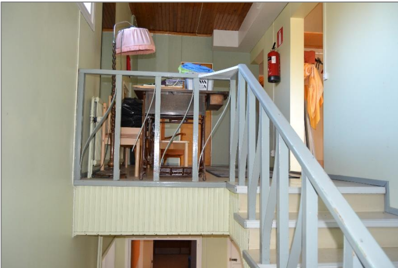
Kuva 36. Entisen terveystalon alkuperäisiä sisätilamateriaaleja, kuten puupanelointeja ja puuovia, on säilynyt lähinnä yläkerrassa ja portaikossa.
