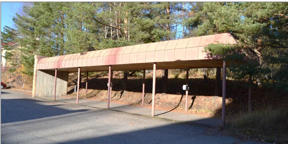
Kuva 10. Terveyskeskuksen pohjoispuolella on samaan aikaan rakennettu polkupyöräkatos, nykyinen autokatos. Katoksessa on käytetty samoja arkkitehtonisia elementtejä kuin terveyskeskuksessa: taitettua saumapeltikattoa, lautamuottipintaista betonia ja keltatiliimuurausta.
