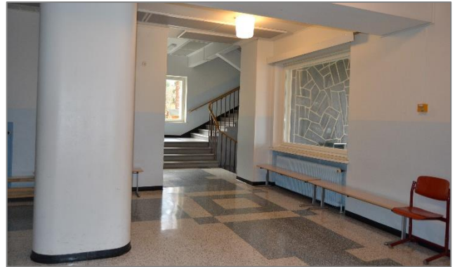
Kuva 56. Eteisaulasta on käynti A-portaikkoon. Aulan lattiat ovat mosaiikkibetonia.
