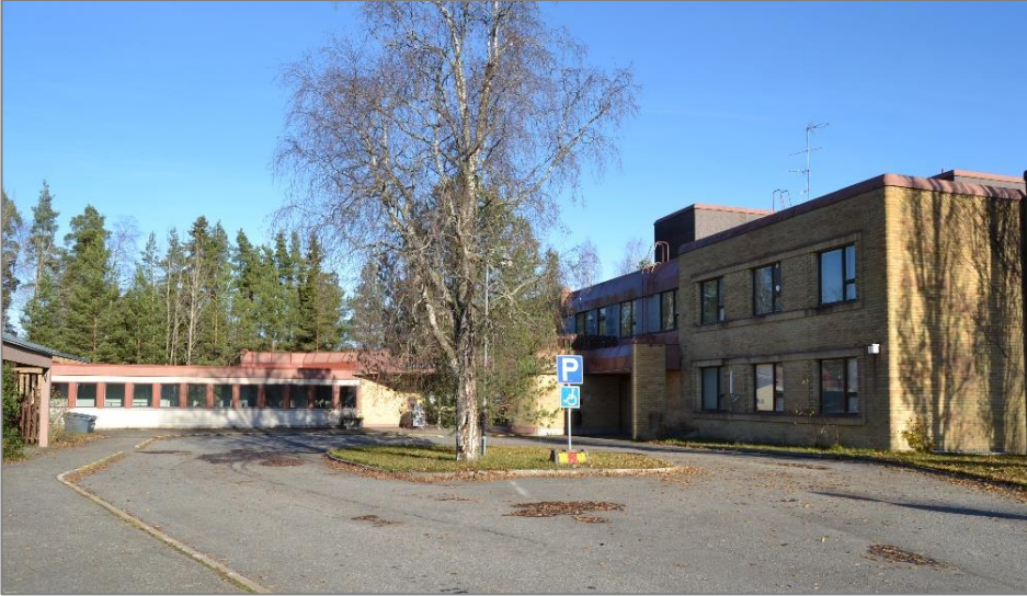
Kuva 12. Kuva terveyskeskuksen pääsisäänkäyntipihalta. Terveyskeskus on liitetty matalalla linkkiosalla vasemmalla sijaitsevaan Hakalehdon A-rakennusosaan. Linkkiosan käytävän ikkunat on muutettu alkuperäisistä.
