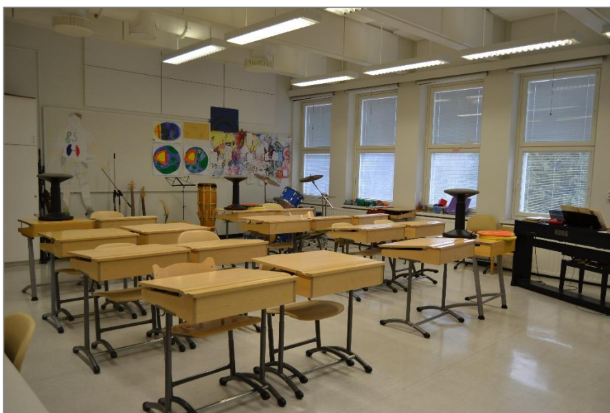
Kuva 61. Kuva ylimmän kerroksen luokkahuoneesta. Luokkatilat ovat kaikissa kerroksissa keskenään hyvin samanlaiset. Lattioissa on muovimatot, seinät ovat maalatut. Osassa luokista leveät ikkunapenkit on päällystetty vinyylilaatoilla.
