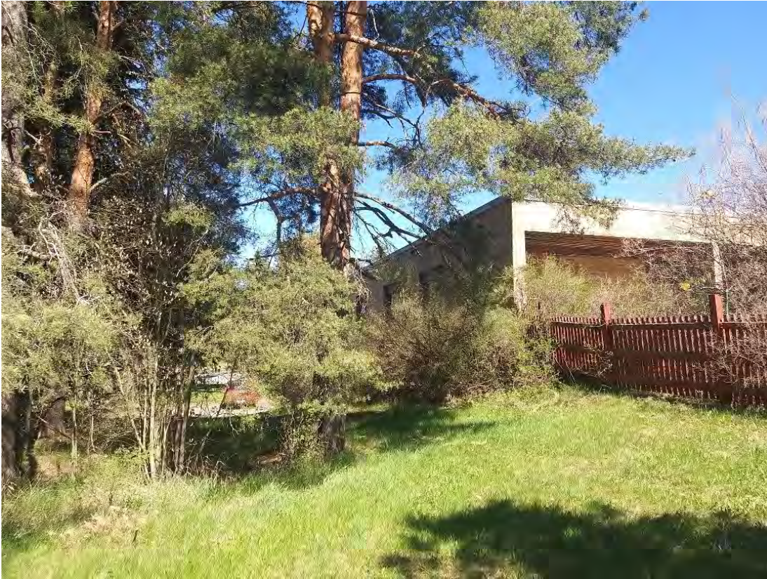
Kuva 1. Akaantie 4. terveysasema kaavakohde VE 1.
