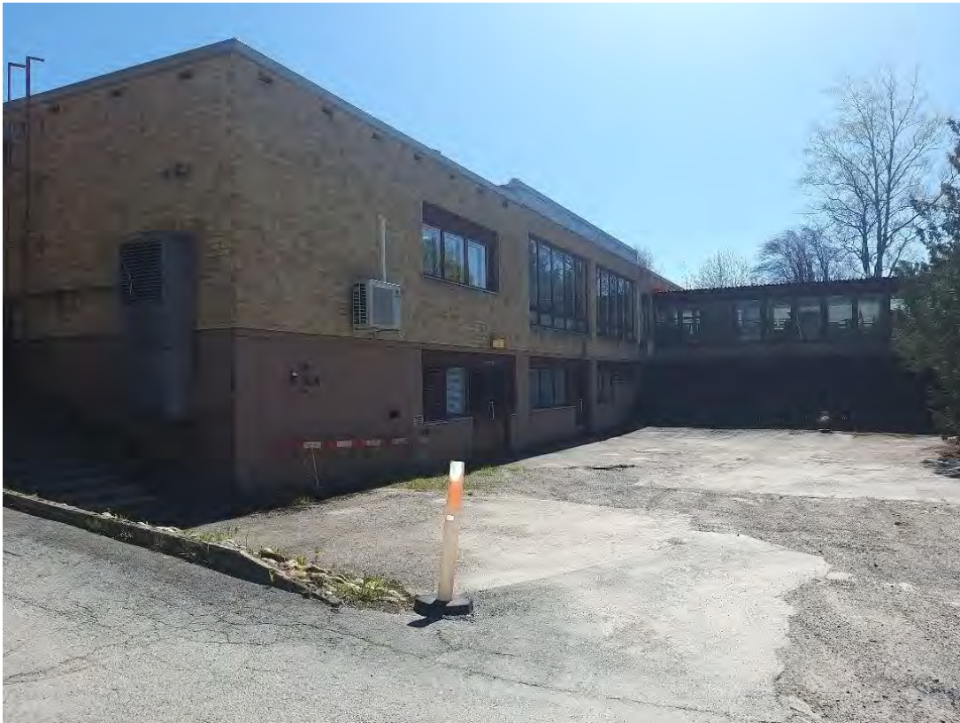
Kuva 2. Akaantie 4. terveysasema kaavakohde VE 1.
