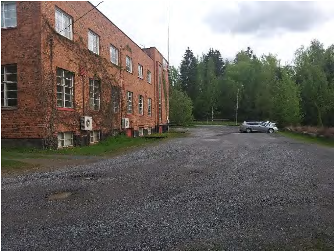
Kuva 1. Keilahallin länsipuolista aluetta 27.5.2022.
