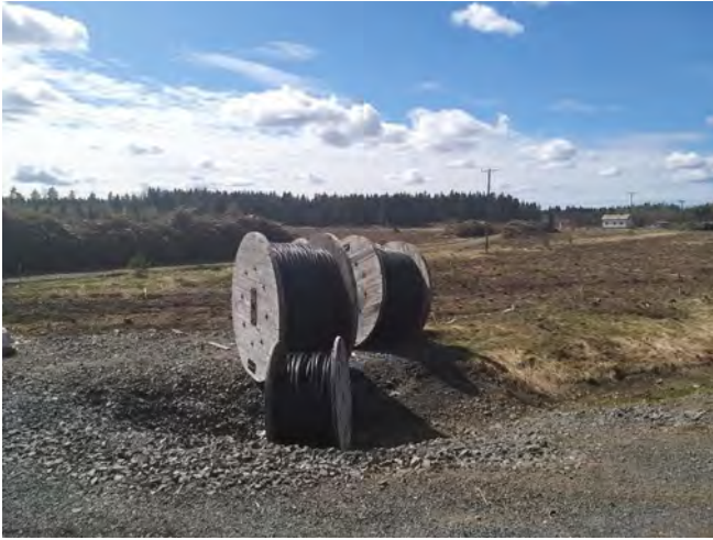
Kuva 4. Akaa Point. Alueen keskiosaa.
