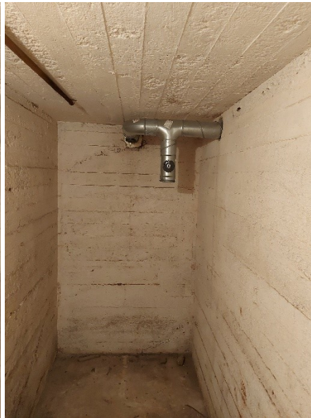
Kuvat 9 ja 10. Laitteen asennus kuvassa 9 oikeassa reunassa oleva kanava johtaa ryömintätilaan ja kuvassa 10 ulos johtava kanava oli teipattu ulkopuolelta kiinni.
