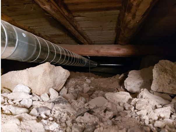
Kuvat 7 ja 8. Kellarissa oleva tuulettuvaan alapohjaan johtava aukko ja kosteuden poistoon tarkoitettu kuivauslaite
