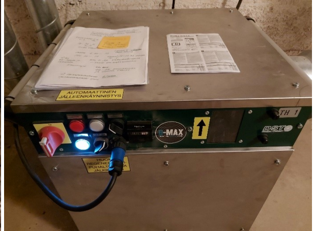
Kuvat 7 ja 8. Kellarissa oleva tuulettuvaan alapohjaan johtava aukko ja kosteuden poistoon tarkoitettu kuivauslaite
