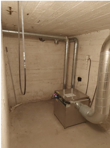
Kuvat 9 ja 10. Laitteen asennus kuvassa 9 oikeassa reunassa oleva kanava johtaa ryömintätilaan ja kuvassa 10 ulos johtava kanava oli teipattu ulkopuolelta kiinni.
