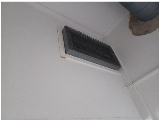
Kuvat 4-6. Keramiikkauunit ja ilmanvaihto huuvan sisällä. Kuvassa 6 tuloilmasäleikkö.
