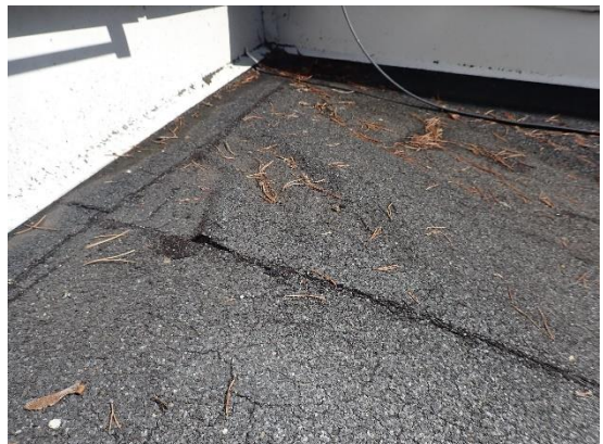
Kuvat 32 a ja b. Vedeneristeessä havaittiin paikoin rypyllä olevia sekä osittain alustastaan irti olevia kermejä.
