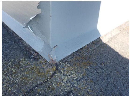
Kuvat 40 a...d. Katolla sijaitsevien IV-laitteiden ja savunpoistoluukkujen läpivienneissä ei havaittu puutteita, kermin nostot on suojattu pellityksellä. Kermin yläosan kiinnitystä ei päästy tarkastamaan.
