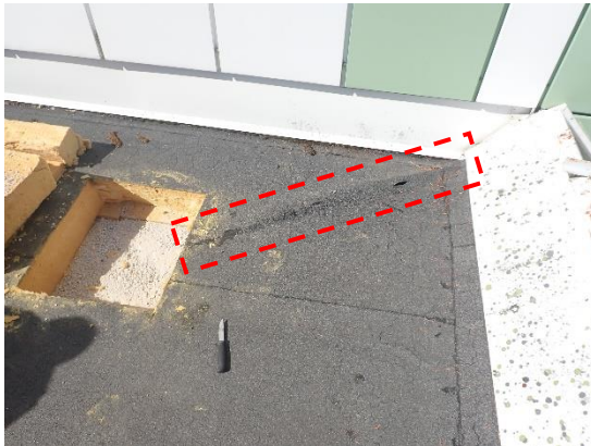
Kuvat 34 a ja b. Liikuntasalin varaston (1.krs) katolla avauksen RA10 vieressä havaittiin alustastaan irti oleva päällimmäinen kermi. Kermien väliin on kulkeutunut vettä. Irti oleva alue merkattu katkoviivalla (kuva a). Kermi on tutkimuksen yhteydessä viilletty auki ja paikattu, avauksen eristetilassa ei havaittu viitteitä vesivuodosta. Ulkoseinällä on epätiivis räystäään liittymä vuodon läheisyydessä (kuva b). Samassa paikassa havaittiin sisäpuolella tiiviysmittauksen yhteydessä yläpohjan ilmapuoto.
