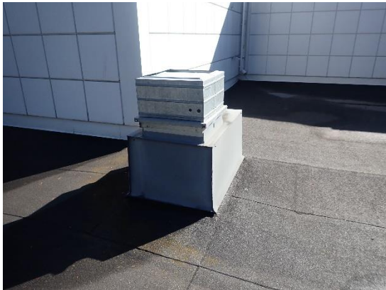
Kuvat 39 a ja b. Tuuletusviemärien läpiviennit on toteutettu kumitiivistein. Tiivisteiden ympärillä on heikkokuntoista halkeillutta bitumiliimaa.
