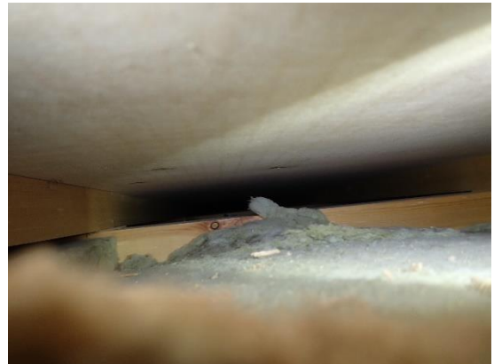
Kuvat 13 a ja b. Höyrynsulkumuovin nosto on taittunut villan alle, liikuntasalin joustolattiarakenne tuulettaa sisäilmaan avauksen kohdalla (kuva a). Kentän pinnan/koivuvanerinrunгон ja seinän välissä on ~40 mm rako. Ilmaväli on hieman ristiinkoolausta matalampi ~80 mm, koivuvanerin alapinnassa ei ole viitteitä kosteusrasituksesta (kuva b).
