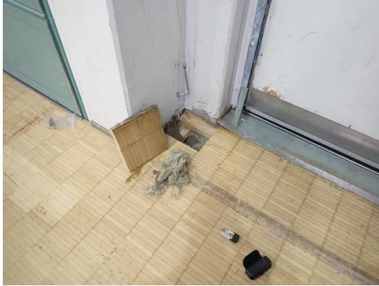
Kuvat 6 a...d. Yleiskuvia rakennusavauksesta RA1, avausta rajaa ulkoseinä. Avaus tehtiin ulko-oven läheisyyteen. Joustolattian tuuletusväli on ulkoseinän läheisyydessä täynnä todennäköisesti hyönteisten mukanaan tuomaa hiekkaa ja roskaa (kuva b). Avauksessa ei havaittu poikkeavaa hajua.
