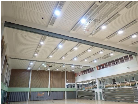
Kuvat 27 a ja b. Liikuntasalissa YP1 profiilipeltirakenteen alapuolella on liimapuupalkisto ja alaslaskettu kipsikatto (kuva a). Liimapuupalkit eivät olleet sisäpuolella näkyvillä eikä niiden kuntoa voitu tutkimuksen yhteydessä tarkastaa ilman laajoja purkutöitä. Muissa YP1 katoissa kantavana rakenteena on teräs-palkit eikä alapinnassa havaittu erillistä alaslaskua (kuva b).
