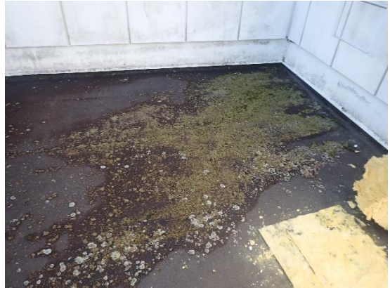
Kuvat 30 a ja b. Kermikaistojen välissä on havaittavissa saumapurseet. Yksittäisellä katolla havaittiin sammaloitumista ulkoseinän läheisyydessä.
