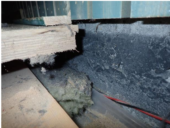
Kuvat 13 a ja b. Höyrynsulkumuovin nosto on taittunut villan alle, liikuntasalin joustolattiarakenne tuulettaa sisäilmaan avauksen kohdalla (kuva a). Kentän pinnan/koivuvanerinrunгон ja seinän välissä on ~40 mm rako. Ilmaväli on hieman ristiinkoolausta matalampi ~80 mm, koivuvanerin alapinnassa ei ole viitteitä kosteusrasituksesta (kuva b).
