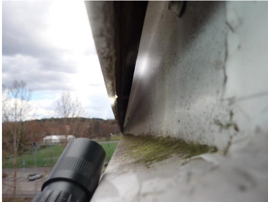
Kuvat 44 a ja b. Tuuletusraoissa on myrskypellit. Suojapellit on yletty riittävästi (60-70 mm) tuuletusraon alareunan alapuolelle.
