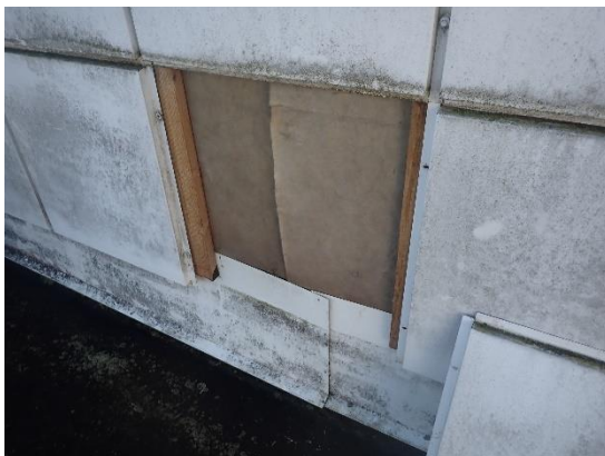
Kuvat 46 a ja b. Yhteyttä eristetilan ja ulkoilman välillä ei havaittu ulkoseinillä.
