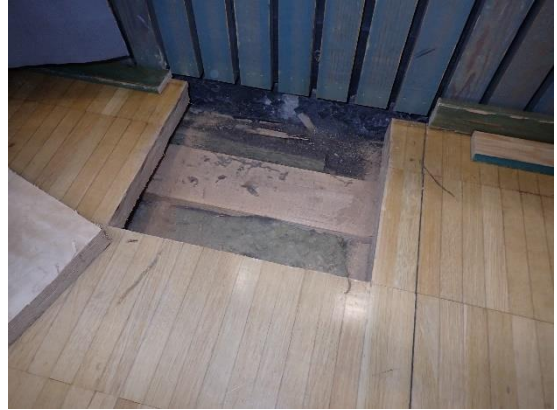
Kuvat 12 a ja b. Yleiskuvia rakenneavauksesta RA2, avausta rajaa väestönsuojan väliseinä. Avauksessa ei havaittu viitteitä kosteusrasituksesta tai poikkeavaa hajua.
