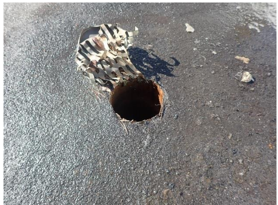
Kuvat 38 a ja b. Sisäänkäynnin ja pukuhuoneiden (2. krs) katoilla on vain yhdet kaivot, joten varaveidenpoistoa ei ole. Sisäänkäynnin katolla on muista kaivoista poikkeava roskasihti, joka on irronnut lähes kokonaan.
