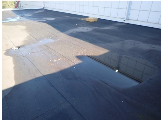
Kuvat 37 a ja b. Sisääntulotason (2. krs) katolla lammikoitumista syntyy kaatojen puutteiden seurauksena useassa paikassa. Lammikoiden syvyydet paikoin yli 20 mm. Ohjeistuksen (RIL 107) mukaan lammikon syvyys saa olla enintään 15 mm. Kallistukset kaivoihin ja ulosheittäjiin ovat aistinvaraisesti arvioiden muilla kattotasoilla riittävät, mutta vähäistä paikallista lammikoitumista havaittiin.
