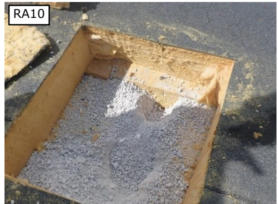
Kuvat 24 a...d. Yleiskuvia yläpohjarakenteeseen YP2 tehdyistä avauksista, avauksen numero on esitetty kuvan yläreunassa. Avauksista tehdyt havainnot vastasivat pitkälti toisiaan. Rakenneavauksessa RA8 kevytbetonimurskan seassa havaittiin yksittäinen rima, joka oli kuiva, kosteuspitoisuus 10 %. Rakenneavauksessa RA10 kevytbetonimurskakerros oli korvattu mineraalivillalla n. 1 m päässä liikuntasalin ulkoseinästä. Ontelolaataston päällä ei havaittu erillistä höyrynsulkukerrosta.
