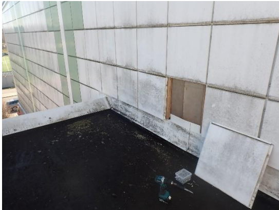
Kuvat 26 a ja b. Ulkoseinällä avauksessa RA12 ei havaittu katon eristetilän tuuletusta. Vedeneristekermi on kiinnitetty ulkoseinärakenteen tuulensuojana toimivaan ilmansulkupaperiin.
