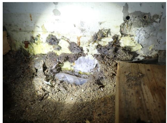
Kuvat 8 a ja b. Rakennusavauksen RA1 viereisen ulko-oven alaosan metalliosissa havaittiin korroosiovaurioita (kuva a). Pilarin ja seinän alaosassa tuuletusvälissä/jalkalistan taustalla havaittiin maalipinnan vaurioita ja kalkkihärmää (kuva b). Kuvassa b näkyy myös höyrynsulkumuovin osittainen nosto seinälle/pilarille.
