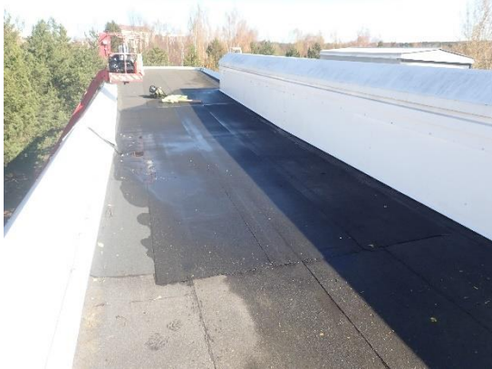
Kuvat 33 a ja b. Kattoja on osin paikattu lisäkermeillä.
