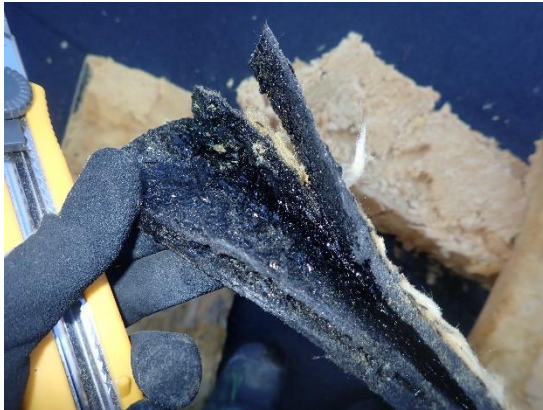
Kuvat 31 a ja b. Kermivedeneristys on aistinvaraisen pistokoeluontoisen tarkastelun perusteella melko lujaa ja joustavaa sekä kermiit ovat pääosin hyvin kiinni toisissaan. Yksittäisissä rakenneavausten yhteydessä tehdyissä tarkastuksissa kermiien kiinnitys oli osittain heikko.
