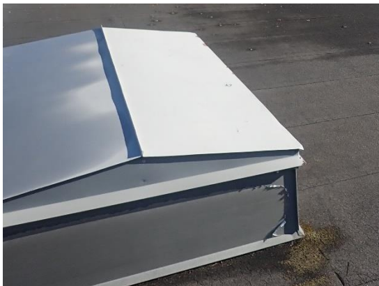
Kuvat 40 a...d. Katolla sijaitsevien IV-laitteiden ja savunpoistoluukkujen läpivienneissä ei havaittu puutteita, kermin nostot on suojattu pellityksellä. Kermin yläosan kiinnitystä ei päästy tarkastamaan.
