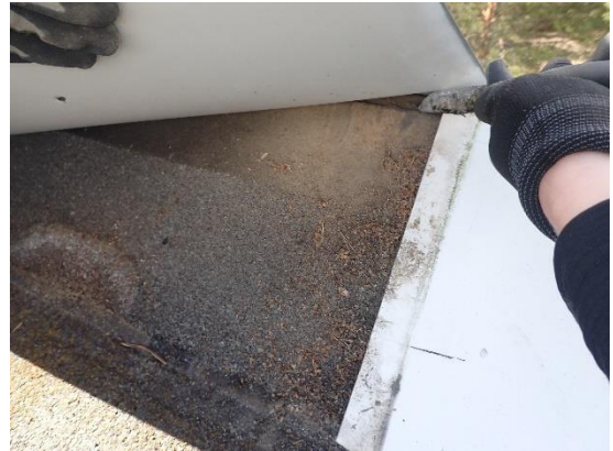
Kuvat 45 a ja b. Räystäät ovat puurakenteiset. Vedeneristekermi jatkuu räystäällä kulman yli.
