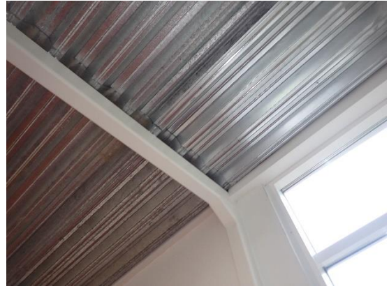
Kuvat 47 a ja b. Yläpohjan YP1 rakennetyyppi on riskialtis ja ilmatiiveyden voidaan arvioida olevan heikko. YP1 kantava profiilipeltirakenne on pellin jatkoksista sekä höyrynsulun liittymistä ympäröiviin rakenteisiin ilmatiiviysmittauksen mukaan epätiivis (kuva a). Merkittävimmät ilmavuodot tiiviysmittauksessa havaittiin 3. kerroksen seinän ja katon rajoissa (kuva b).
