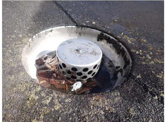
Kuvat 36 a ja b. Ylempien kattojen (pl. liikuntasali) vedet on ohjattu 2. krs katolle, jossa kaivoja on riittävästi (5 kpl), mutta kaadot ovat puutteelliset.
