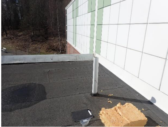
Kuvat 39 a ja b. Tuuletusviemärien läpiviennit on toteutettu kumitiivistein. Tiivisteiden ympärillä on heikkokuntoista halkeillutta bitumiliimaa.
