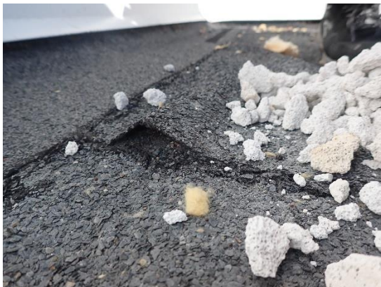
Kuvat 32 a ja b. Vedeneristeessä havaittiin paikoin rypyllä olevia sekä osittain alustastaan irti olevia kermejä.
