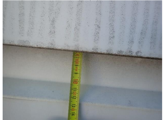
Kuvat 44 a ja b. Tuuletusraoissa on myrskypellit. Suojapellit on yletty riittävästi (60-70 mm) tuuletusraon alareunan alapuolelle.
