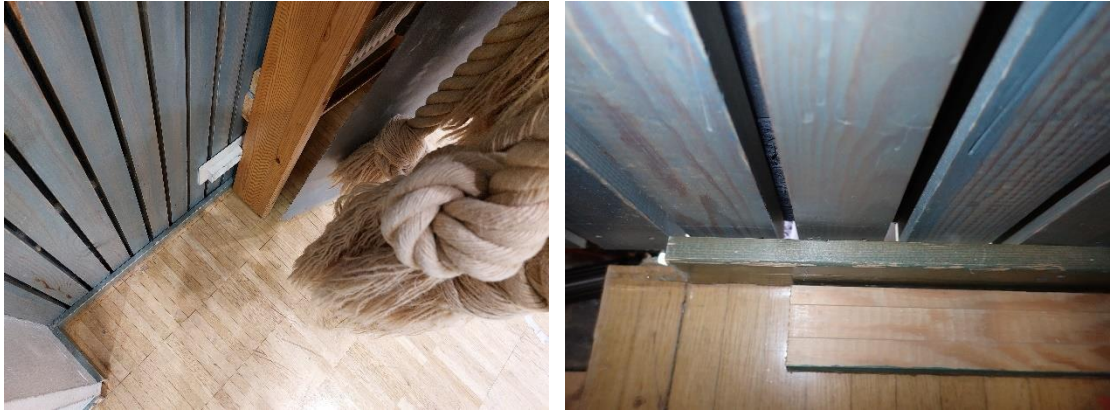
Kuvat 5 a ja b. Joustolattian tuuletusilma on johdettu sisäilmaan suunnitelmien mukaisesti kentän lyhyen sivujen jalkalistojen takaa, rimoituksen raoista.
