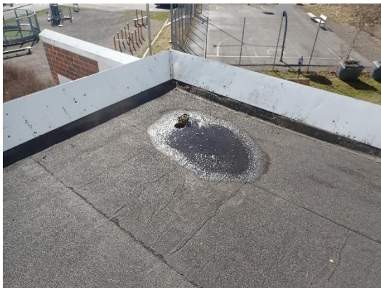
Kuvat 38 a ja b. Sisäänkäynnin ja pukuhuoneiden (2. krs) katoilla on vain yhdet kaivot, joten varaveidenpoistoa ei ole. Sisäänkäynnin katolla on muista kaivoista poikkeava roskasihti, joka on irronnut lähes kokonaan.
