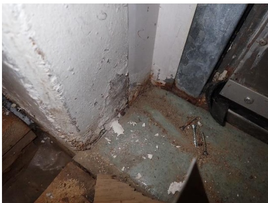
Kuvat 8 a ja b. Rakennusavauksen RA1 viereisen ulko-oven alaosan metalliosissa havaittiin korroosiovaurioita (kuva a). Pilarin ja seinän alaosassa tuuletusvälissä/jalkalistan taustalla havaittiin maalipinnan vaurioita ja kalkkihärmää (kuva b). Kuvassa b näkyy myös höyrynsulkumuovin osittainen nosto seinälle/pilarille.
