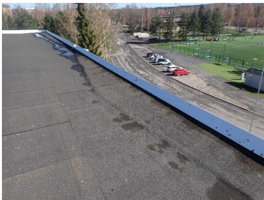
Kuvat 35 a ja b. Ylempien kattotasojen (YP1) vedet on ohjattu alemmille katoille (YP2). Liikuntasalin laajan (~1000 m 2 ) katon vedet on ohjattu kokonaisuudessaan syöksytorvilla liikuntasalin varaston (1. krs) katolla sijaitseviin kaivoihin, ulosheittäjiin on vastakaadot. Varaston katolla on 2 kaivoa ja molempien roskasidit olivat täynnä roskaa. Kaivojen määrä ja koko täyttää mitoituksen vähimmäisvaatimukset, Veden virtausmatka on liikuntasalin katolla liian pitkä, yli 20 metriä. Virtausmatka kaivoon saisi ohjeistuksen (RIL 107) mukaan olla enintään 15 m.
