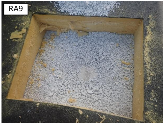
Kuvat 24 a...d. Yleiskuvia yläpohjarakenteeseen YP2 tehdyistä avauksista, avauksen numero on esitetty kuvan yläreunassa. Avauksista tehdyt havainnot vastasivat pitkälti toisiaan. Rakenneavauksessa RA8 kevytbetonimurskan seassa havaittiin yksittäinen rima, joka oli kuiva, kosteuspitoisuus 10 %. Rakenneavauksessa RA10 kevytbetonimurskakerros oli korvattu mineraalivillalla n. 1 m päässä liikuntasalin ulkoseinästä. Ontelolaataston päällä ei havaittu erillistä höyrynsulkukerrosta.
