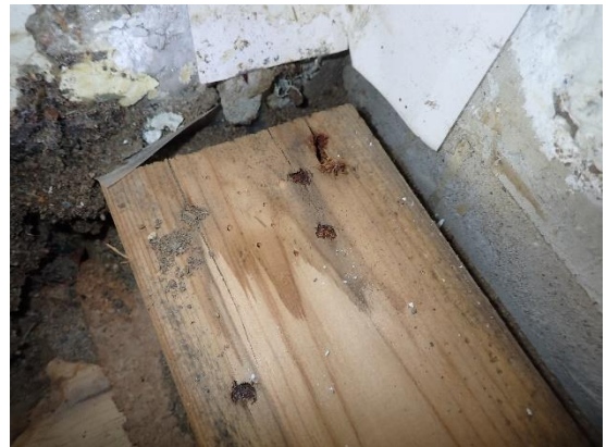
Kuvat 7 a ja b. Avauksessa havaittiin viitteitä kosteusrasituksesta. Vasemmalla (kuva a) lattian pintarakenteen koivuvanerin alapinta. Puuosat olivat avauksessa paikallisesti tummuneita ja metalliset kiinnikkeet korroosiovaurioituneita.
