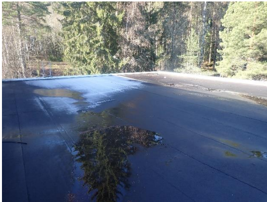
Kuvat 37 a ja b. Sisääntulotason (2. krs) katolla lammikoitumista syntyy kaatojen puutteiden seurauksena useassa paikassa. Lammikoiden syvyydet paikoin yli 20 mm. Ohjeistuksen (RIL 107) mukaan lammikon syvyys saa olla enintään 15 mm. Kallistukset kaivoihin ja ulosheittäjiin ovat aistinvaraisesti arvioiden muilla kattotasoilla riittävät, mutta vähäistä paikallista lammikoitumista havaittiin.
