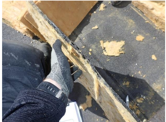
Kuvat 31 a ja b. Kermivedeneristys on aistinvaraisen pistokoeluontoisen tarkastelun perusteella melko lujaa ja joustavaa sekä kermiit ovat pääosin hyvin kiinni toisissaan. Yksittäisissä rakenneavausten yhteydessä tehdyissä tarkastuksissa kermiien kiinnitys oli osittain heikko.
