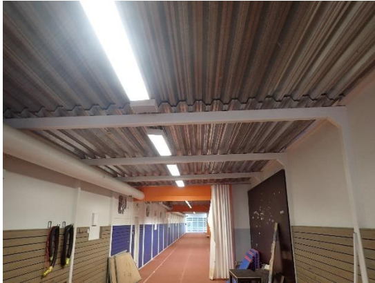
Kuvat 47 a ja b. Yläpohjan YP1 rakennetyyppi on riskialtis ja ilmatiiveyden voidaan arvioida olevan heikko. YP1 kantava profiilipeltirakenne on pellin jatkoksista sekä höyrynsulun liittymistä ympäröiviin rakenteisiin ilmatiiviysmittauksen mukaan epätiivis (kuva a). Merkittävimmät ilmavuodot tiiviysmittauksessa havaittiin 3. kerroksen seinän ja katon rajoissa (kuva b).
