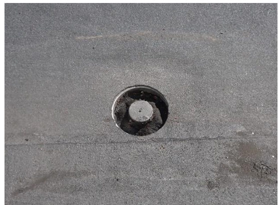
Kuvat 35 a ja b. Ylempien kattotasojen (YP1) vedet on ohjattu alemmille katoille (YP2). Liikuntasalin laajan (~1000 m 2 ) katon vedet on ohjattu kokonaisuudessaan syöksytorvilla liikuntasalin varaston (1. krs) katolla sijaitseviin kaivoihin, ulosheittäjiin on vastakaadot. Varaston katolla on 2 kaivoa ja molempien roskasidit olivat täynnä roskaa. Kaivojen määrä ja koko täyttää mitoituksen vähimmäisvaatimukset, Veden virtausmatka on liikuntasalin katolla liian pitkä, yli 20 metriä. Virtausmatka kaivoon saisi ohjeistuksen (RIL 107) mukaan olla enintään 15 m.
