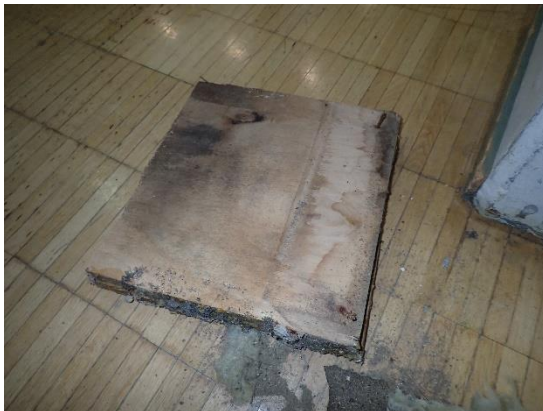
Kuvat 7 a ja b. Avauksessa havaittiin viitteitä kosteusrasituksesta. Vasemmalla (kuva a) lattian pintarakenteen koivuvanerin alapinta. Puuosat olivat avauksessa paikallisesti tummuneita ja metalliset kiinnikkeet korroosiovaurioituneita.
