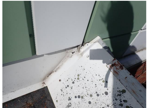
Kuvat 34 a ja b. Liikuntasalin varaston (1.krs) katolla avauksen RA10 vieressä havaittiin alustastaan irti oleva päällimmäinen kermi. Kermien väliin on kulkeutunut vettä. Irti oleva alue merkattu katkoviivalla (kuva a). Kermi on tutkimuksen yhteydessä viilletty auki ja paikattu, avauksen eristetilassa ei havaittu viitteitä vesivuodosta. Ulkoseinällä on epätiivis räystäään liittymä vuodon läheisyydessä (kuva b). Samassa paikassa havaittiin sisäpuolella tiiviysmittauksen yhteydessä yläpohjan ilmapuoto.
