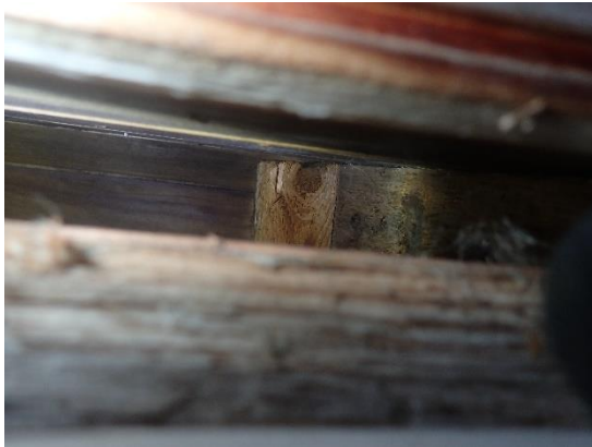
Kuvat 45 a ja b. Räystäät ovat puurakenteiset. Vedeneristekermi jatkuu räystäällä kulman yli.
