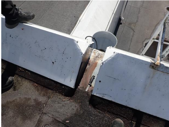
Kuvat 36 a ja b. Ylempien kattojen (pl. liikuntasali) vedet on ohjattu 2. krs katolle, jossa kaivoja on riittävästi (5 kpl), mutta kaadot ovat puutteelliset.
