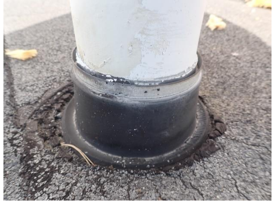
Kuvat 39 a ja b. Tuuletusviemärien läpiviennit on toteutettu kumitiivistein. Tiivisteiden ympärillä on heikkokuntoista halkeillutta bitumiliimaa.
