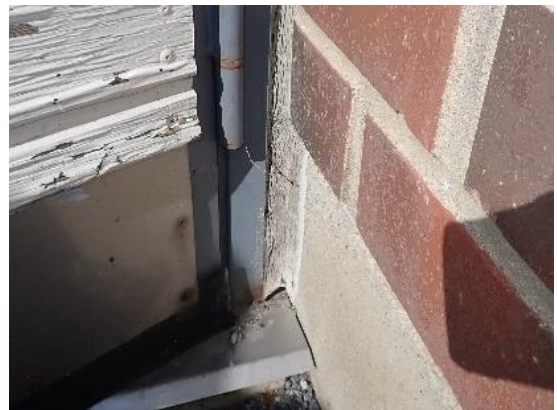
Kuvat 11 a ja b. Ulkona asfalttipinnan kallistukset ovat osittain kohti rakenneavauksen RA1 viereistä ulko-ovea ja ulkoseinää. Lisäksi ulko-oven saumaus on kulunut ja epätiivis, oven ja kynnyksen liittymät ovat myös alaosastaan epätiivit.
