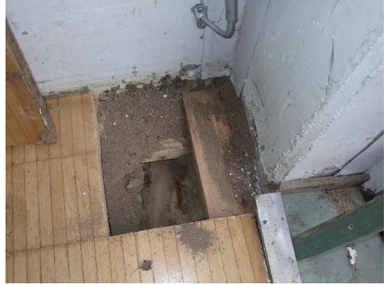
Kuvat 6 a...d. Yleiskuvia rakennusavauksesta RA1, avausta rajaa ulkoseinä. Avaus tehtiin ulko-oven läheisyyteen. Joustolattian tuuletusväli on ulkoseinän läheisyydessä täynnä todennäköisesti hyönteisten mukanaan tuomaa hiekkaa ja roskaa (kuva b). Avauksessa ei havaittu poikkeavaa hajua.
