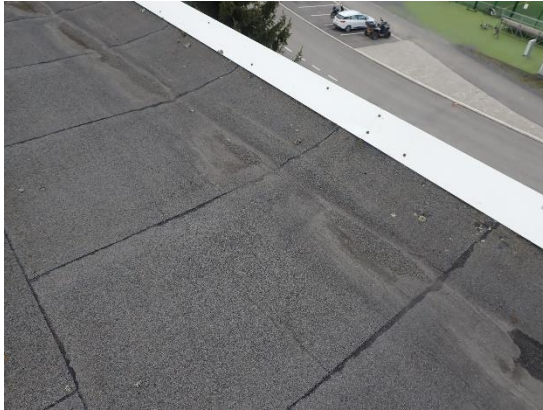
Kuvat 30 a ja b. Kermikaistojen välissä on havaittavissa saumapurseet. Yksittäisellä katolla havaittiin sammaloitumista ulkoseinän läheisyydessä.
