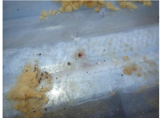
Kuvat 23 a ja b. Rakenneavauksessa RA4 havaittiin vedeneristeen kiinnike, joka oli alaosastaan ruostunut ja katkennut. Muissa avauksissa ei havaittu kiinnikkeitä, mikä viittaa siihen, että katossa ei todennäköisesti ole riittävää tai ohjeiden mukaista määrää kiinnikkeitä.
