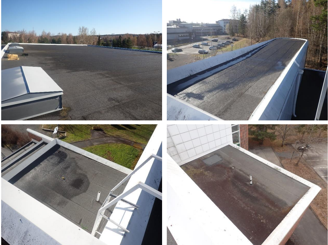
Kuvat 28 a...d. Yleiskuvia kattotasoista.
