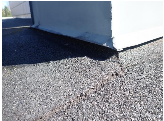
Kuvat 39 a ja b. Tuuletusviemärien läpiviennit on toteutettu kumitiivistein. Tiivisteiden ympärillä on heikkokuntoista halkeillutta bitumiliimaa.
