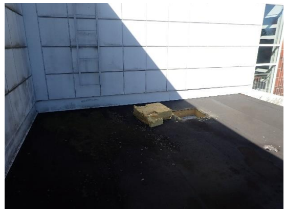
Kuvat 46 a ja b. Yhteyttä eristetilan ja ulkoilman välillä ei havaittu ulkoseinillä.
