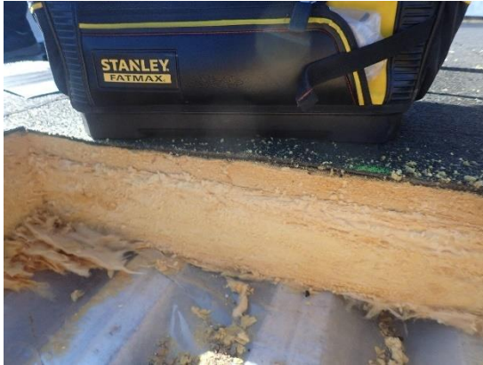
Kuvat 25 a ja b. Rakenneavauksissa ei havaittu erillistä tuuletusuritutusta mineraalivillaeristeissä. Eristeet olivat avauksissa aistinvaraisesti arvioiden kaikissa avauksissa kuivia eikä niissä havaittu viitteitä kosteusrasituksesta tai ilmavuodoista. Kuvassa b rakenneavauksesta purettu eristeet käännettynä ylösalaisin.
