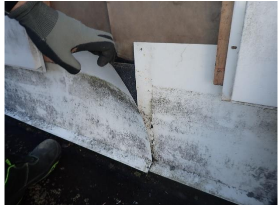
Kuvat 26 a ja b. Ulkoseinällä avauksessa RA12 ei havaittu katon eristetilän tuuletusta. Vedeneristekermi on kiinnitetty ulkoseinärakenteen tuulensuojana toimivaan ilmansulkupaperiin.
