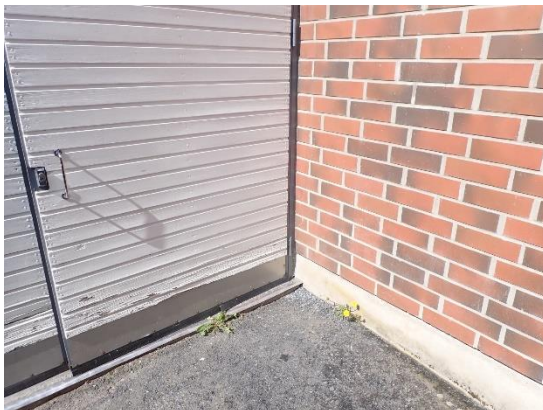
Kuvat 11 a ja b. Ulkona asfalttipinnan kallistukset ovat osittain kohti rakenneavauksen RA1 viereistä ulko-ovea ja ulkoseinää. Lisäksi ulko-oven saumaus on kulunut ja epätiivis, oven ja kynnyksen liittymät ovat myös alaosastaan epätiivit.
