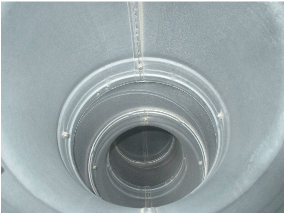
Sama kanava puhdistuksen jälkeen
