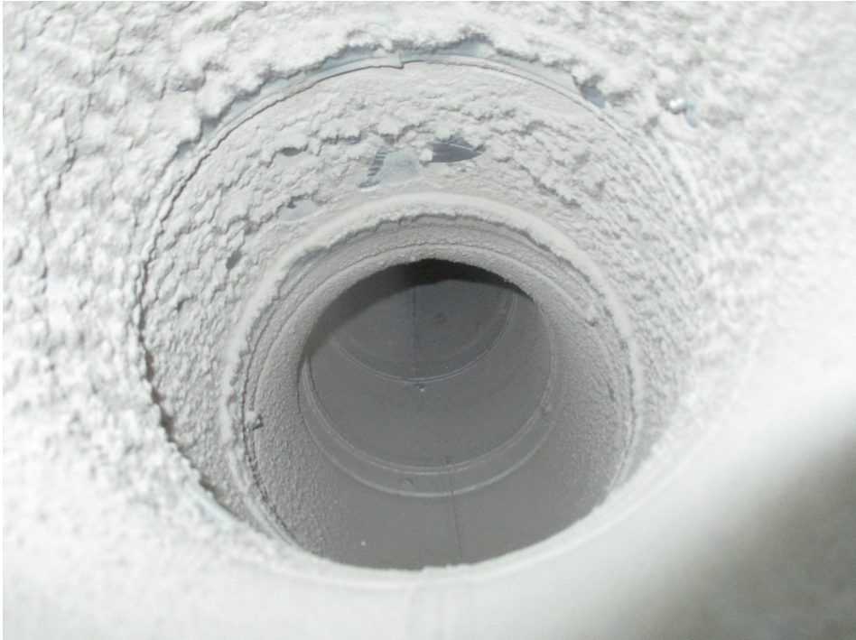
Poistoilmakanavaa (uusi puoli) ennen puhdistusta
