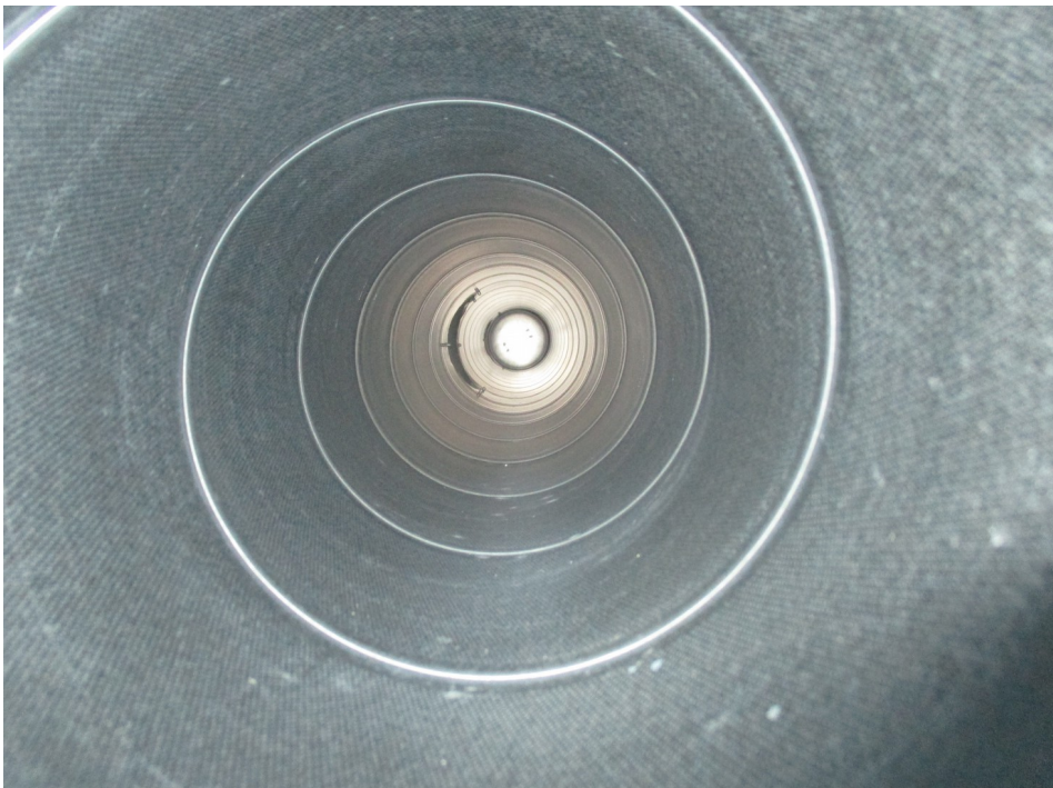
Sama kanava puhdistuksen jälkeen
