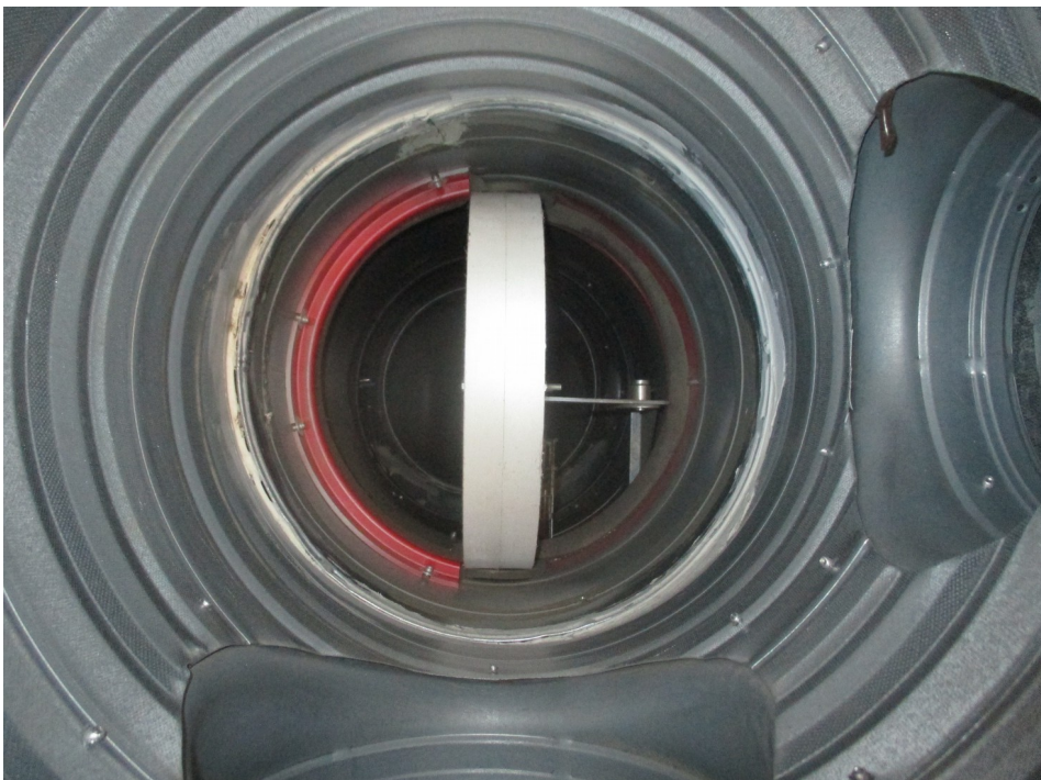
Sama kanava puhdistuksen jälkeen
