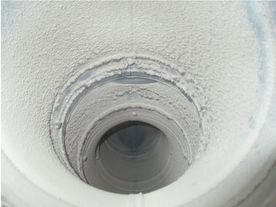
Poistoilmakanavaa (uusi puoli) ennen puhdistusta
