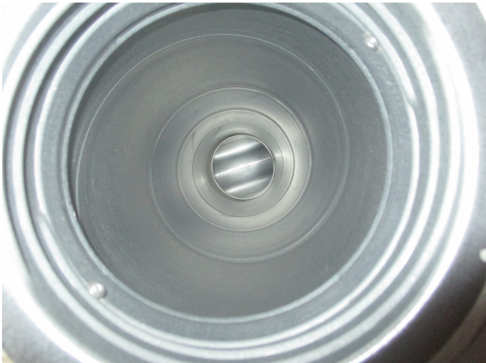
Sama kanava puhdistuksen jälkeen
