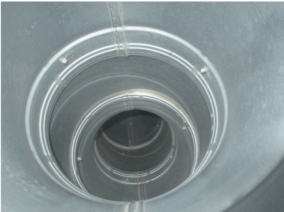
Sama kanava puhdistuksen jälkeen
