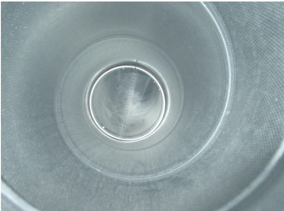
Sama kanava puhdistuksen jälkeen
