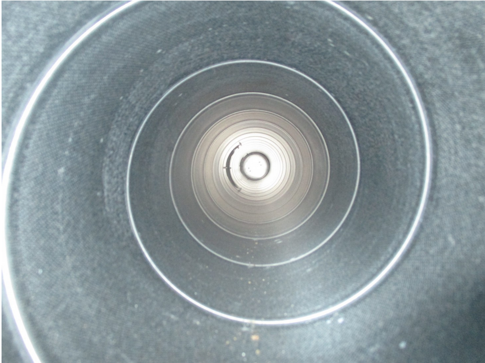
Tuloilmakanavaa (tyhjä rakennus) ennen puhdistusta
