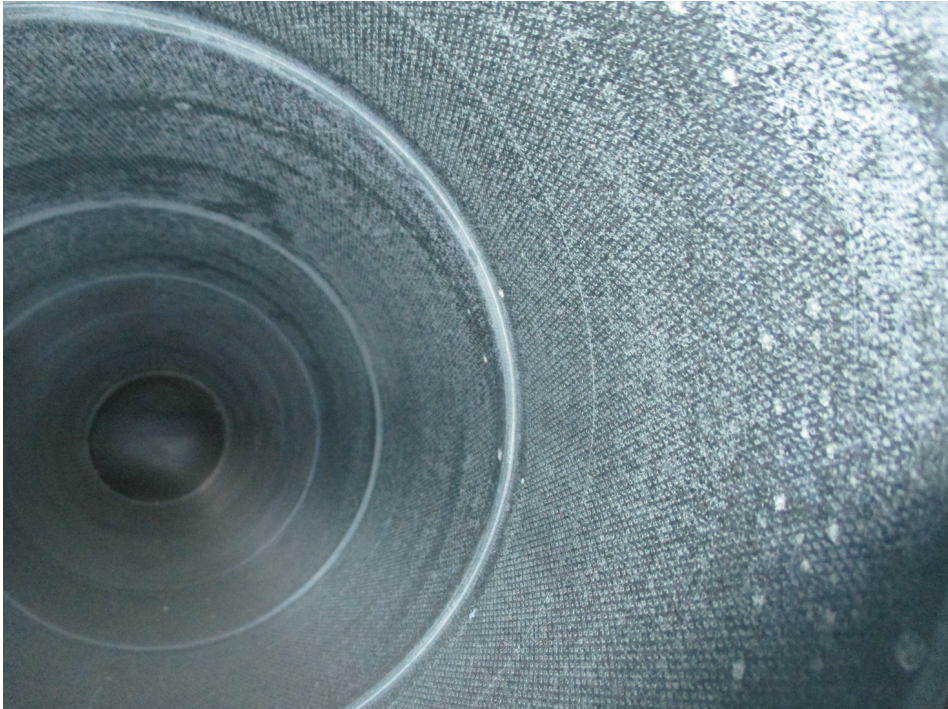
Tuloilmakanavaa (tyhjä rakennus) ennen puhdistusta
