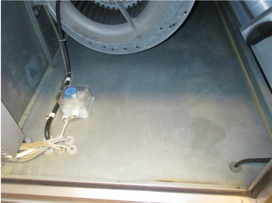
Iv konetta (uusi puoli) ennen puhdistusta
