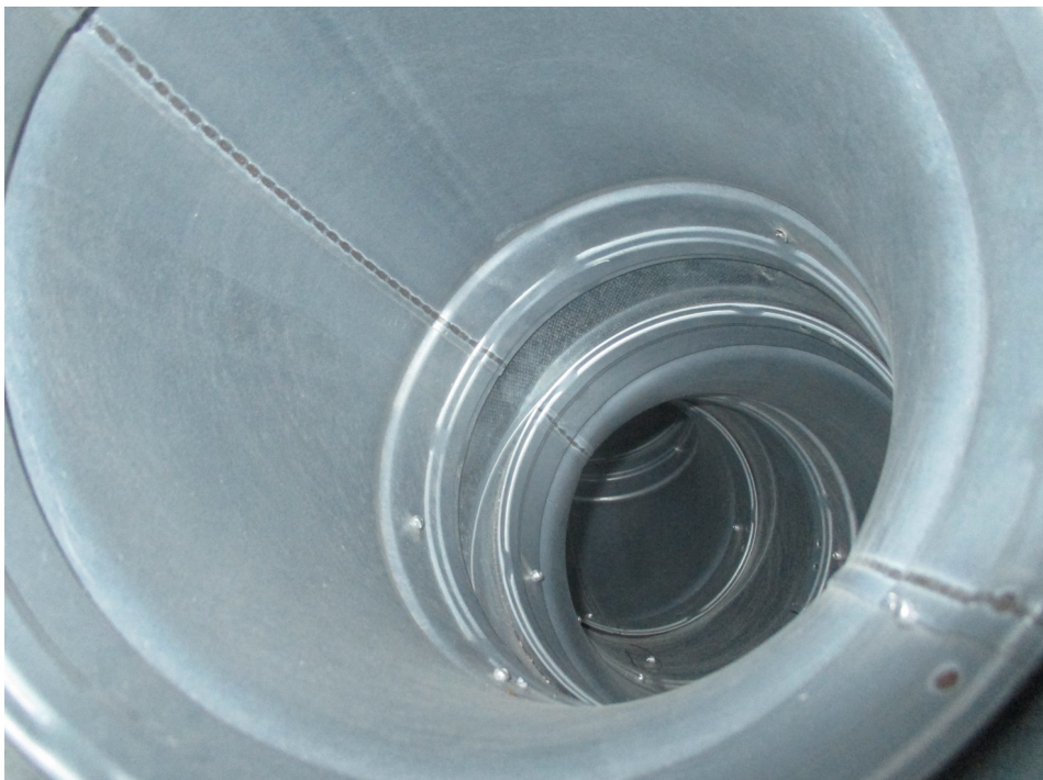
Sama kanava puhdistuksen jälkeen
