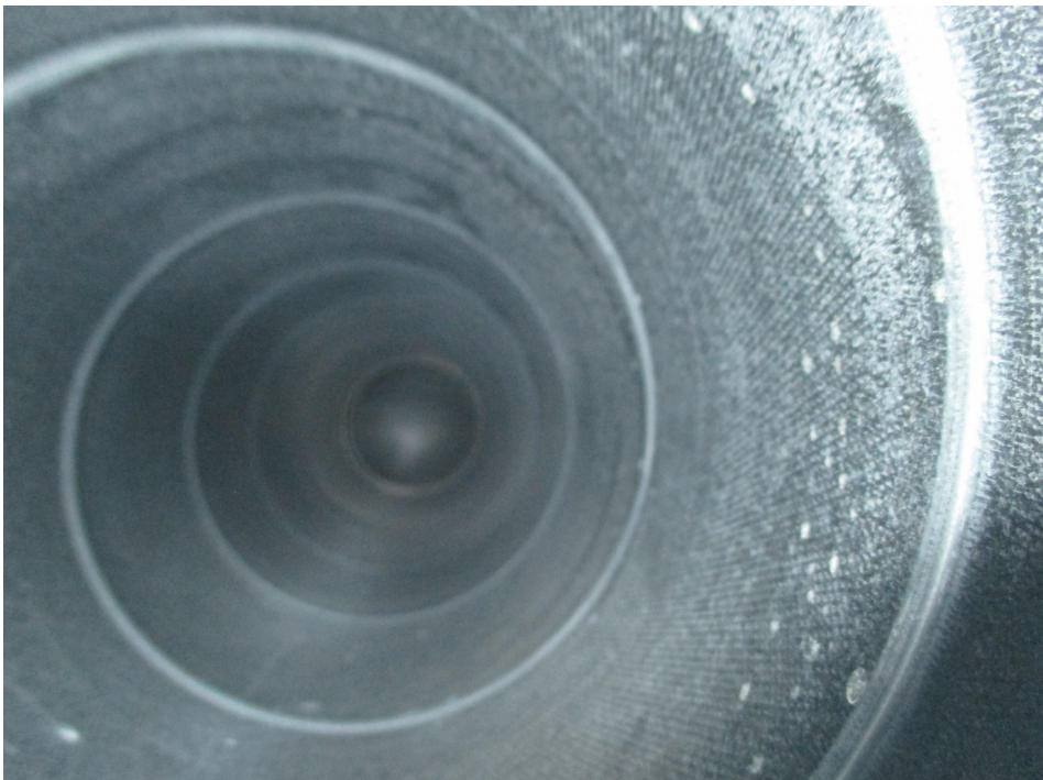
Sama kanava puhdistuksen jälkeen
