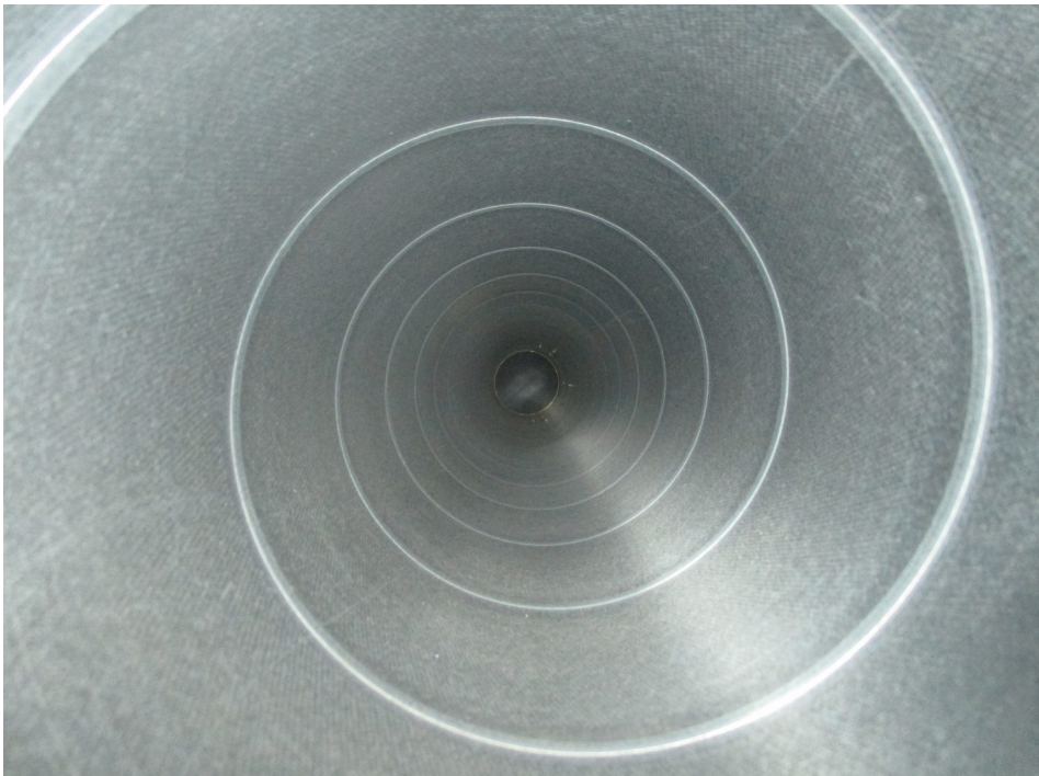
Sama kanava puhdistuksen jälkeen
