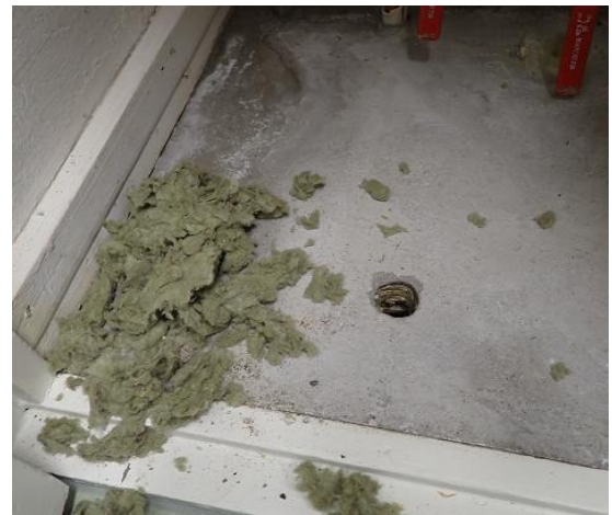
Kuvat 4 a ja b. Rakenneavaus toimiston 212 komeron välipohjaan. Puulattian päällä on ohut tasoitekerros. Täyttönä oleva mineraalivilla oli aistinvaraisesti tarkasteluna osin kosteaa. Porareistä havaittiin lievästi mikrobiperäinen/tunkkainen haju.
