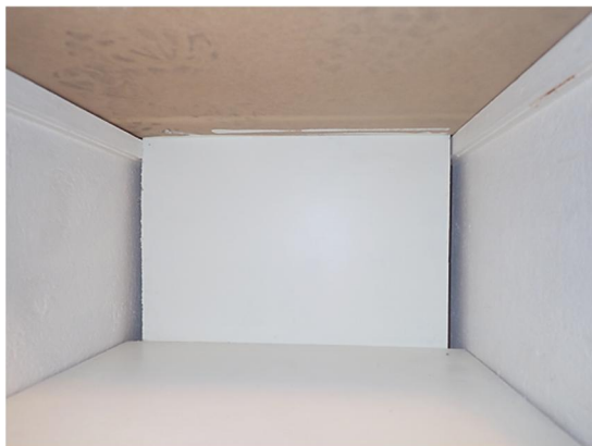
Kuvat 9 a ja b. Toimiston 112 komeron taustaseinä on levytetty. Putket kulkevat levytyksen takana. Tarkastelluilta osin seinässä ei havaittu kosteusjälkiä.
