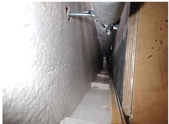
Kuvat 9 a ja b. Toimiston 112 komeron taustaseinä on levytetty. Putket kulkevat levytyksen takana. Tarkastelluilta osin seinässä ei havaittu kosteusjälkiä.
