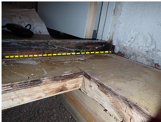
Kuvat 8 a ja b. Toimiston 112 komeron kynnyks on tummunut. Piikkimittarilla tarkasteltuna puun kosteus on normaali (n. 13 p %).
