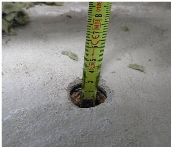
Kuvat 4 a ja b. Rakenneavaus toimiston 212 komeron välipohjaan. Puulattian päällä on ohut tasoitekerros. Täyttönä oleva mineraalivilla oli aistinvaraisesti tarkasteluna osin kosteaa. Porareistä havaittiin lievästi mikrobiperäinen/tunkkainen haju.
