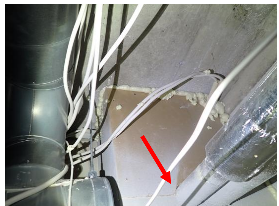
Kuva 7 a...b. Kotitalousluokan varastotila 204, jonka levyrakenteinen hormi on lähtötietojen mukaan uusittu. Hormin liitos välipohjan alapintaan on tiivistetty uretaanivaahdolla. Putkiläpivientejä hormiin ei ole aistinvaraisen tarkastelun perusteella tiivistetty. Tilassa ei havaittu poikkeavia hajuja.
