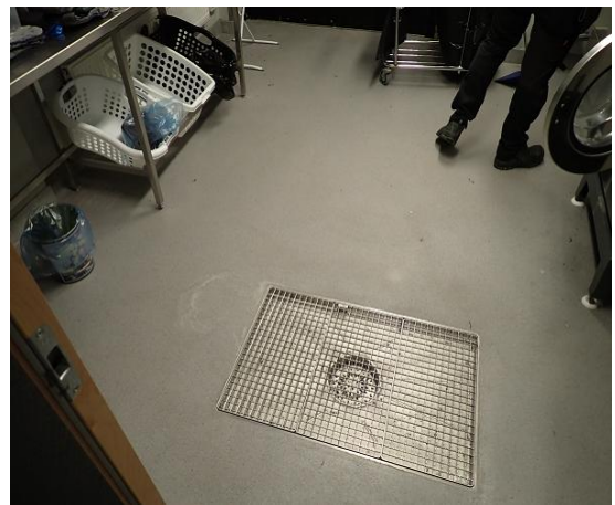
Kuva 6 a...d. Yleiskuvia tutkittujen tilojen korjauksista. Alapohjan ja ulkoseinien, välipohjan ja ulkoseinien sekä ikkunoiden ja ulkoseinien välisiä rakenneliittymiä on tiivistetty Ardex-tuotteilla. Siivouskeskuksen 102 alapohjarakenne on lähtötietojen mukaan uusittu (kuva d).
