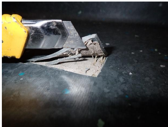
Kuva 13. V1, 67 % RH. Ei poikkeavaa hajua, maton tartunta hyvä. Kiinnitysliimassa ei poikkeavuuksia.
