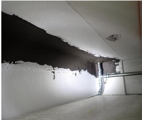
Kuva 6 a...d. Yleiskuvia tutkittujen tilojen korjauksista. Alapohjan ja ulkoseinien, välipohjan ja ulkoseinien sekä ikkunoiden ja ulkoseinien välisiä rakenneliittymiä on tiivistetty Ardex-tuotteilla. Siivouskeskuksen 102 alapohjarakenne on lähtötietojen mukaan uusittu (kuva d).
