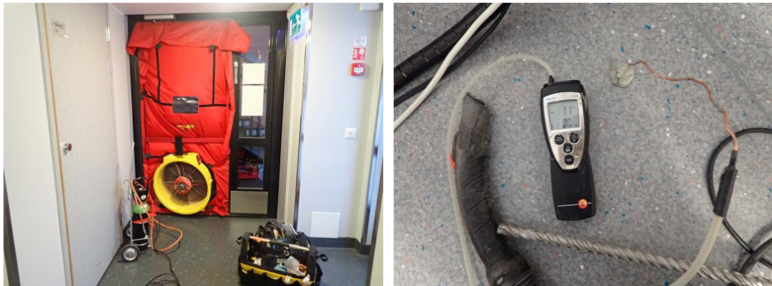
Kuva 16 a...b. Yleiskuvat tutkimusjärjestelyistä. Tilat alipaineistettiin merkkiainetutkimuksia varten n. 10 Pa alipaineeseen tutkittavaan rakenteeseen nähden.
