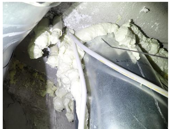
Kuva 8 a...d. Korjausten kohteena ollut levyrakenteinen hormi erityisopetuksen tilassa 146. Hormissa olevien kanava- ja sähköjohtojen läpiviennit ala- ja välipohjaan on tiivistetty polyuretaanivaahdolla. Aistinvaraisessa tarkastelussa hormissa ei havaittu puutteita tai poikkeavia hajuja.
