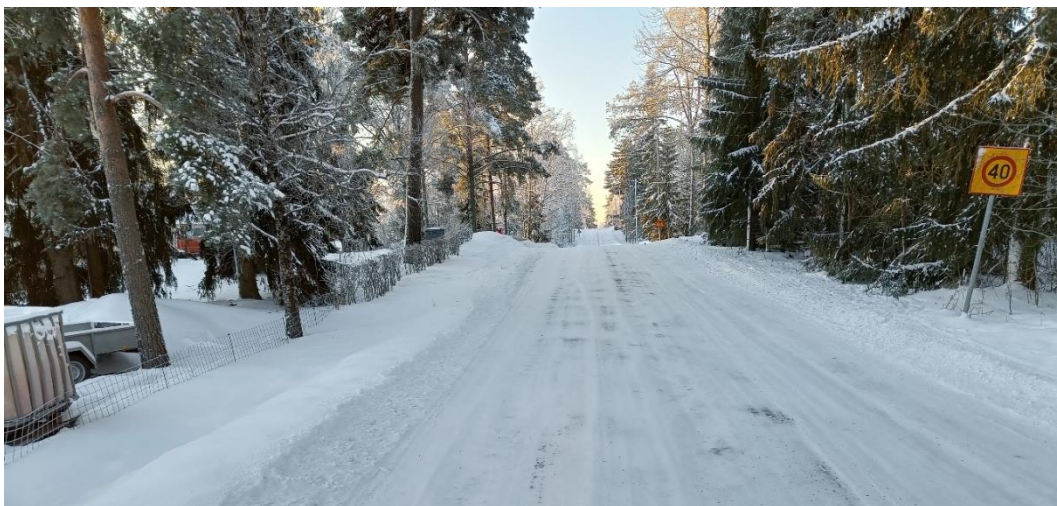
Kuva 5 Näkymä kaava-alueen pohjoisnurkalta lounaaseen Turuntietä pitkin. Kuva: FCG Oy, 2024
