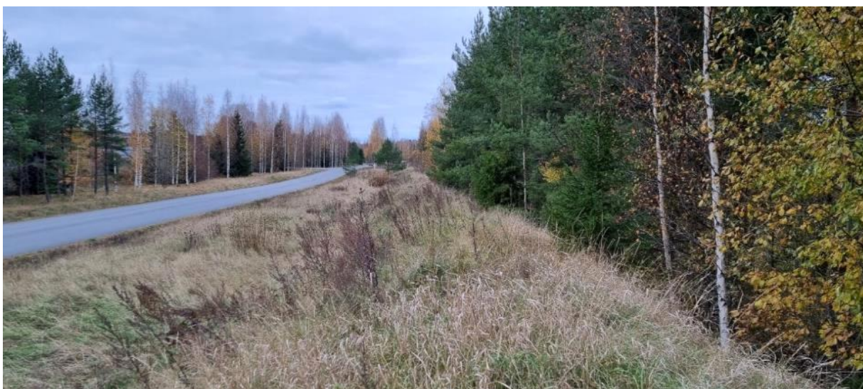
Kuva 3. Tojantien pohjoispuolella on moderni maapenger. Länteen.
