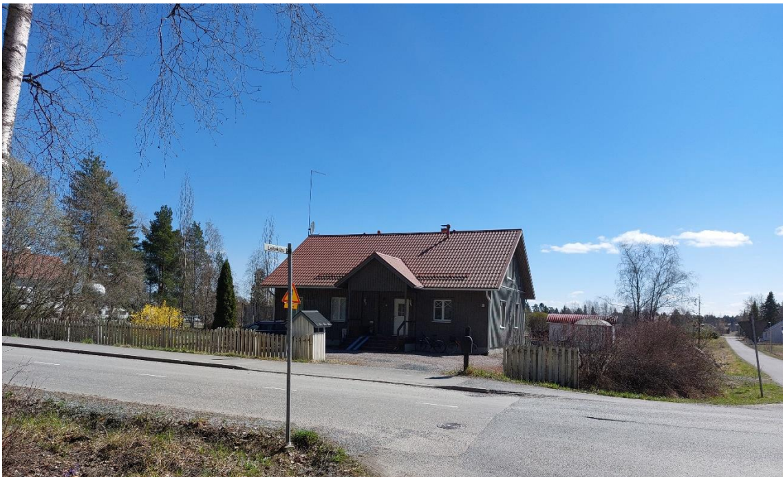
Kuva 8. Kaava-alueen pohjoispuolella sijaitseva asuinrakennus (Akaan kaupunki, 2024)
