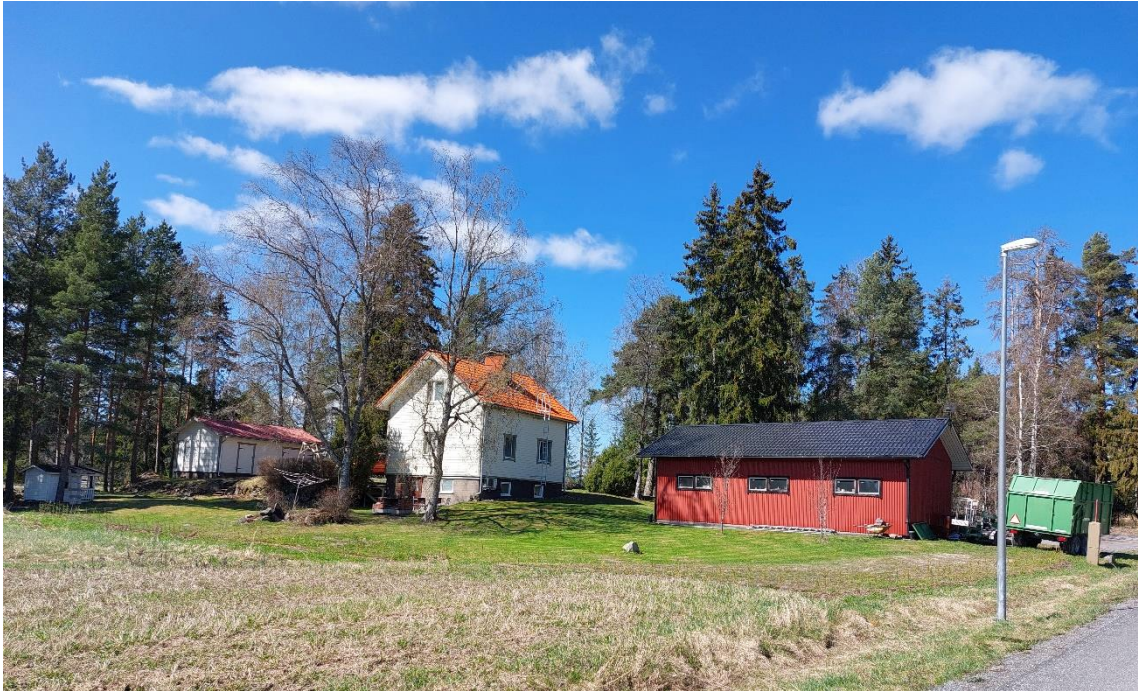
Kuva 7. Turuntien ja Laitakadun risteyksessä sijaitseva rakennettu AO-tontti kuvattuna kaakosta. (Akaan kaupunki, 2024)
