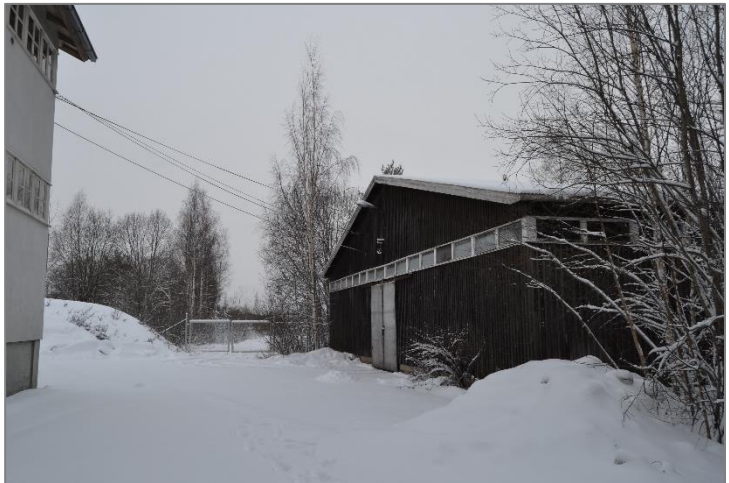
Kuva 9. Rakennuksen eteläpäätty. Kuvan vasemmassa reunassa näkyy entisen Chymoksen tehtaan länsipäättyä.
