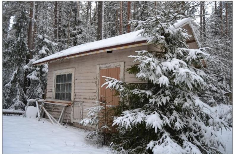
Kuva 70. Rakennus kuvattuna kaakkoiskulmalta.
