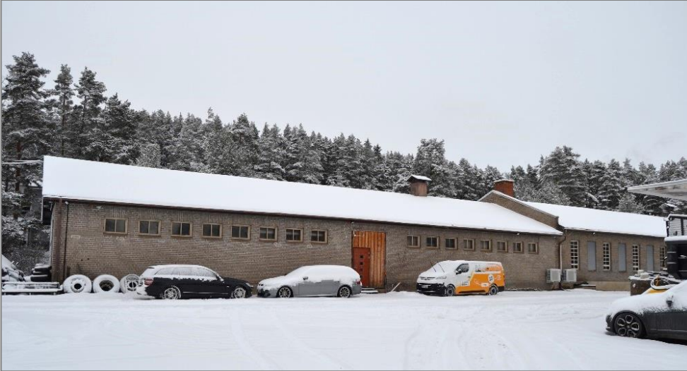
Kuva 31. Varastorakennuksen alkuperäinen osa kuvattuna etelästä. Rakennuksen keskellä oleva ovi on muutettu.
