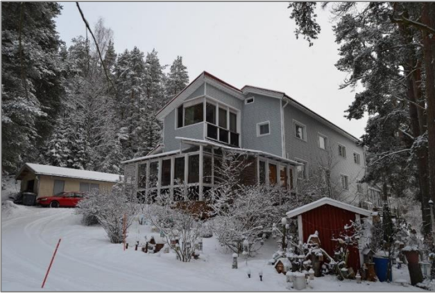
Kuva 58. Läntisemmän asuinrakennuksen (rakennus nro 8) länsipäädyn laajennus vuodelta 2006.
