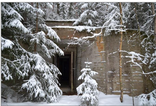
Kuva 50. Entisen ruokalan vieressä sijaitsee rinteeseen muurattu, betoninen kellari.
