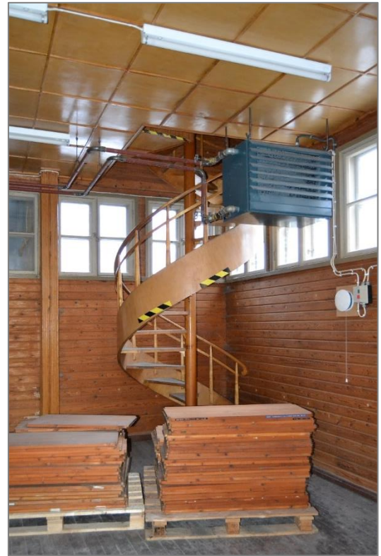
Kuva 21. Puiset kierreportaat sijaitsevat rakennuksen länsipäädystä keskimmäisen ja ylimmän kerroksen välillä.
