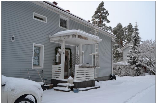
Kuva 56. Itäisemmän asuinrakennuksen (nro 9), ns. kakkostalon, pohjoissivu.
