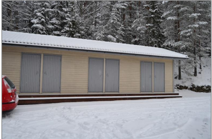
Kuva 54. Piharakennus kuvattuna eteläsivulta.
