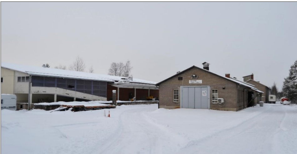
Kuva 4. Teollisuusaluetta kuvattuna koillisesta. Vasemmalla Postin entinen keskusvarasto, oikealla Chymoksen varastorakennus.
