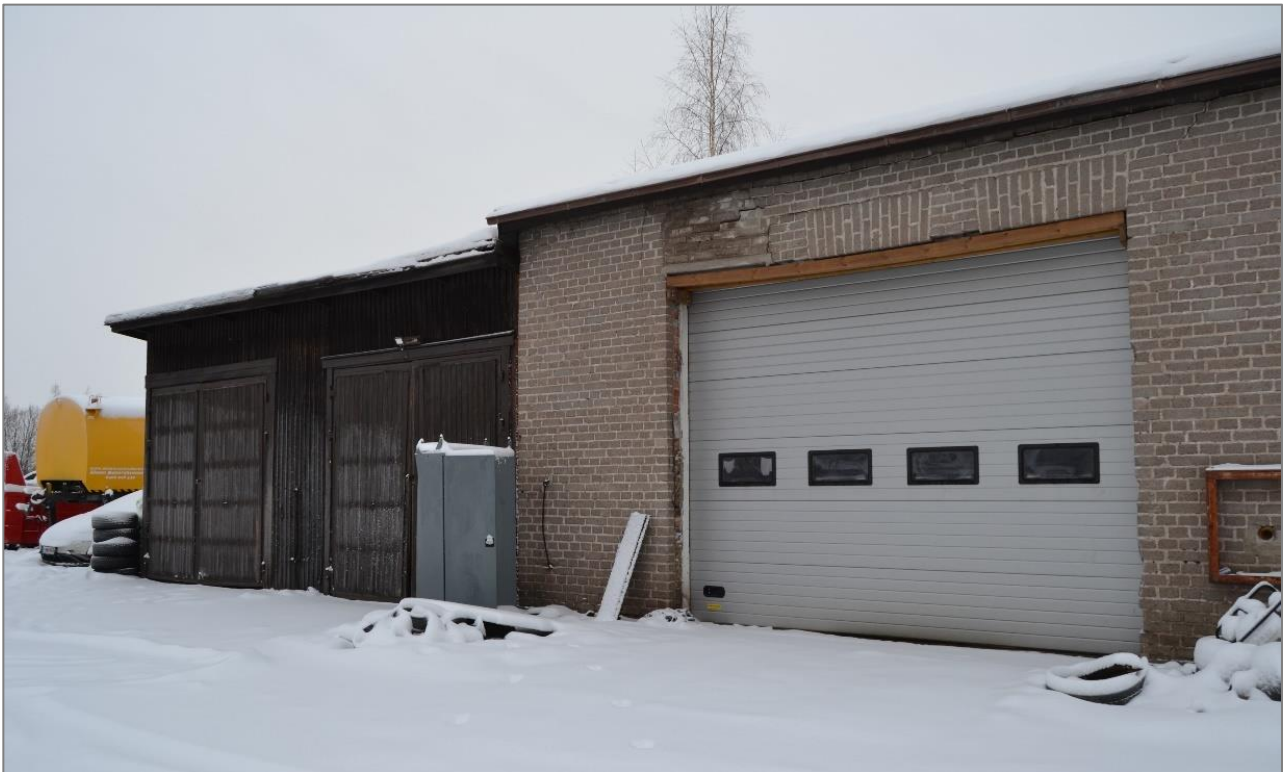
Kuva 25. Kattilahuoneen eteläsivun alkuperäisten ikkunoiden paikalla on nyt nosto-ovi. Ikkuna-aukkojen yläpuoliset tiilikuvioinnit näkyvät vielä julkisivussa. Vasemmalla oleva puinen halli on rakennettu Postin omistajakaudella, ilmakuvatarkastelun perusteella vuoden 1956 jälkeen.
