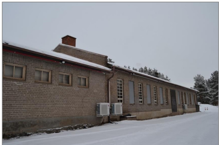
Kuva 28. Rakennuksen eteläisivua alkuperäisen rakennusosan (vasemmalla) ja laajennuksen liitoskohdasta.
