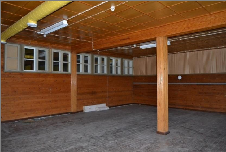
Kuva 20. Kuva yläkerrasta rakennuksen länsipäädystä, entisen karamellipakkaamon tiloista. Ensimmäisen ja toisen laajennusosan raja näkyy sisätiloissa seinän ikkunarivistössä.
