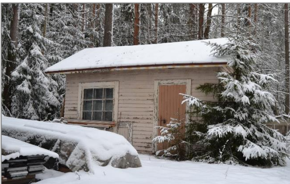
Rakennus 11: piharakennus kiinteistötunnus 20-2-39-25 rakennustunnus ei tunnusta rakennusaika 1940–1950-luku
