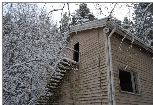
Kuva 49. Rakennuksessa on lappeiltaan epäsymmetrinen harjakatto.
