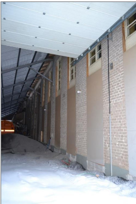
Kuva 14. (ylhäällä) Eteläsivun katoksen alla olevista ikkunoista alimmat on peitetty levyillä.
