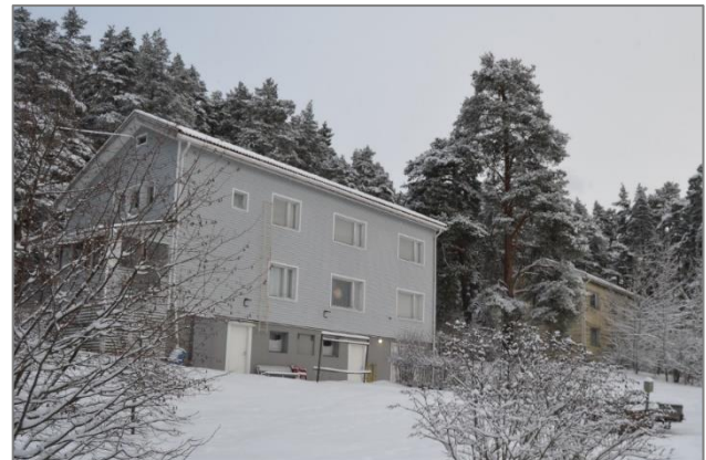
Kuva 60. Kakkostalo, nro 9, kuvattuna pihan puolelta eteläisivulta. Eteläjulkisivu on säilynyt rakentamisaikaisessa asussaan (vertailukuva Kauria 2019, s. 14).
