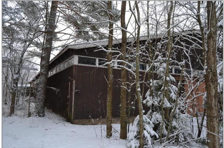
Kuva 8. Varastorakennus kuvattu koilliskulmalta.
