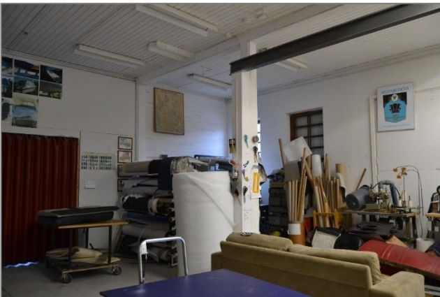
Kuva 35. Kuva varastorakennuksen laajennusosasta, nykyisestä Akaan verhoonon liiketilasta. Tilat ovat Postin aikaisessa asussaan. Seinät ovat suurimmaksi osaksi maalattuja kiviseiniä, katossa on valkeaksi maalattu lautapanelointi.
