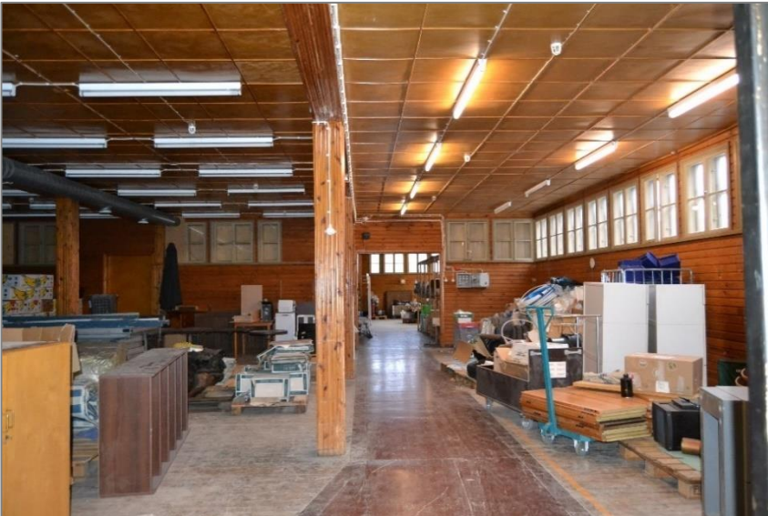
Kuva 16. Kuva on otettu tiilisen rakennusosan ja ensimmäisen laajennusosan rajalta länteen päin keskikerroksesta (1. maanpäällinen kerros). Lähes kaikissa keski- ja yläkerroksen katoissa on alkuperäinen puupanelointi ohuine listoituksineen.
