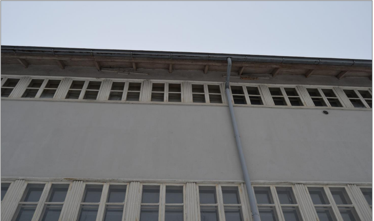
Kuva 81. Tehdasrakennuksen laajennusosan pohjoissivua.
