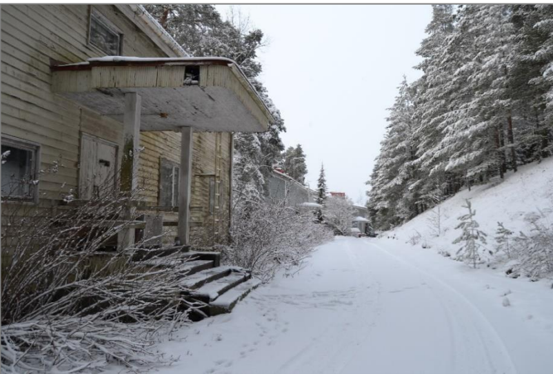
Kuva 65. Pääsisäänkäynnin yllä on pylväiden kannattelema, reunasta pystypaneloitu ja kulmistaan pyöristetty lippakatos. Kuvassuunta länteen.
