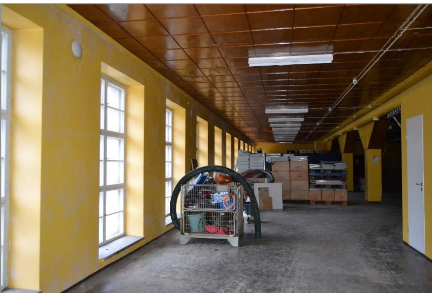
Kuva 18. Kuva tehtaan vanhimman osan yläkerrasta. Ulkoseinän ikkunarivistö on rakennuksen pohjoissivulla.
