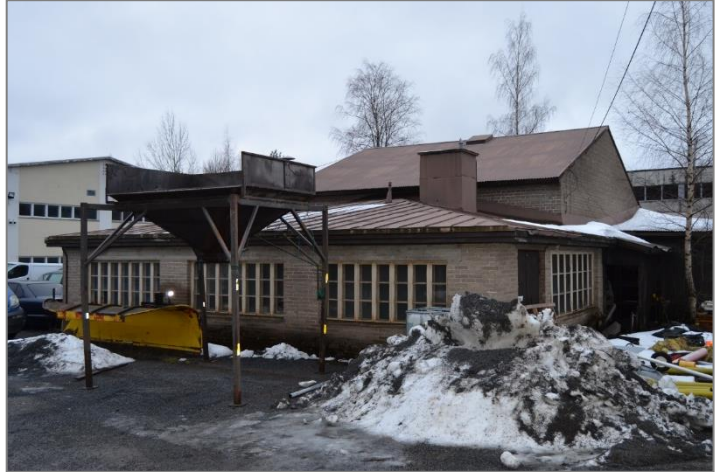
Kuva 23. Rakennus kuvattuna luoteiskulmalta. Edessä näkyvä, aumakattoinen osa on korjaamo.
