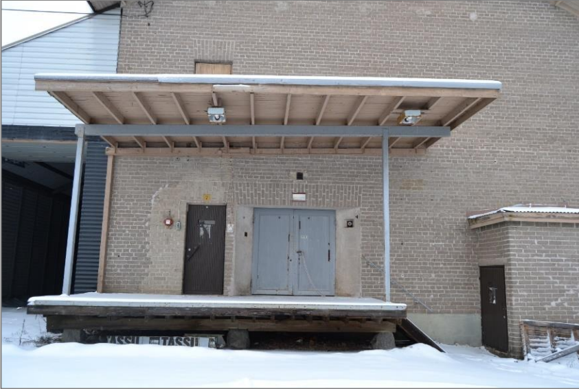
Kuva 17. Itäpäädyn lippa on rakennettu Postin omistajakaudella. Pariovista on käynti tavarahissiin. Tiilisen rakennusosan ikkuna- ja oviaukkojen yläpuolelle on tehty koristemuurausta tiilien suuntaa vaihtamalla.
