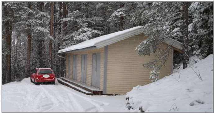
Kuva 53. Rakennus kuvattuna itäpäädyssä.
