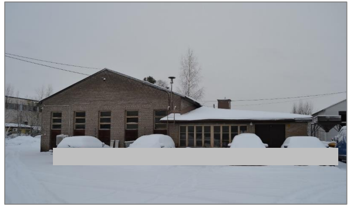
Kuva 22. Rakennus kuvattu itäpuolelta. Korkeampi, harjakattoinen rakennusosa on kattilahuone.
