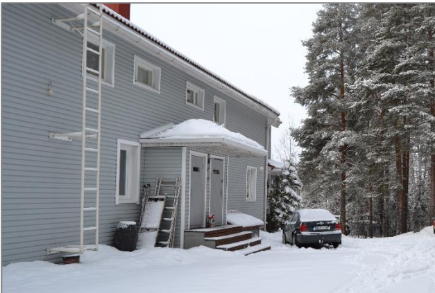
Kuva 55. Asuinrakennuksen (nro 8) pohjoissivu.
