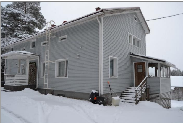
Kuva 61. Rakennus nro 9, ns. kakkostaloon, länsipääty ja pohjoissivua. Päädyn kuisti on rakennettu joskus 1980-luvun alun jälkeen.
