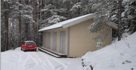
Rakennus 7: piharakennus kiinteistötunnus 20-2-39-25 rakennustunnus ei tunnusta rakennusaika 1980-luku
