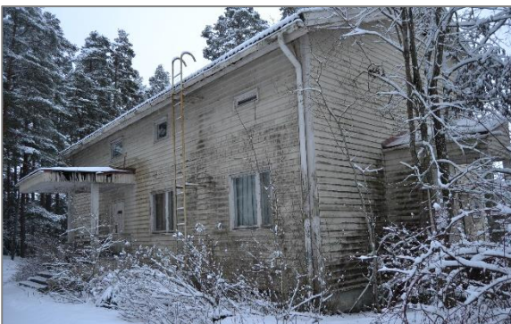
Rakennus 10: entinen konttorirakennus kiinteistötunnus 20-2-39-25 rakennustunnus 1008223540 rakennusaika 1945
