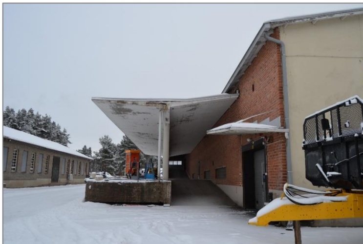
Kuva 36. Rakennuksen pohjoissivulla on ylöspäin taittuva betonikatos. Ajoluiskan vieressä seinässä on lasitiili-ikkunoita.
