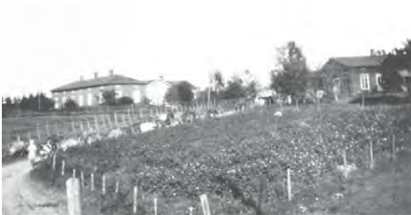
Kuva 51 Taipaleen Hinkan rakennuksia. Etuvasemmalla 1850-luvulla rakennettu päärakennus ja taaemmalla 1896 rakennettu päärakennus. Oikealla Taikinän talon pääty. VV, Viljo Tuomisen kokoelma
