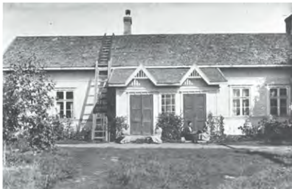
Kuva 9 Uotilan tilan asuinrakennus. Rakennettu 1891. Kuva n. vuodelta 1930. VV, Valokuvaamo Näkki
